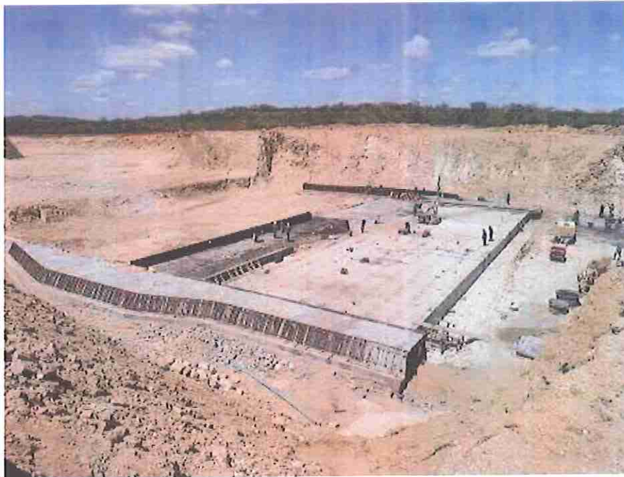
Foto-01 – Laje de dissipação do sangradouro – vista geral.
