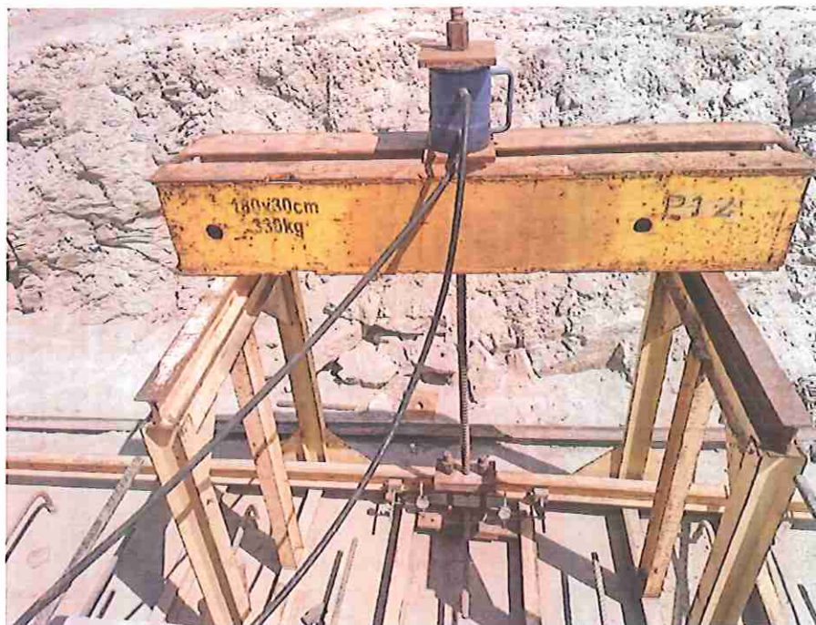
Foto-04 – Sistema de reação e sistema de medição da prova de carga.
