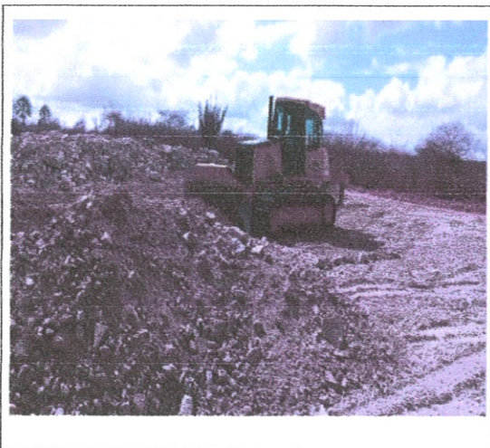
FOTO 05 – Espalhamento em bota-fora dos materiais provenientes das escavações obrigatórias do Vertedouro.
