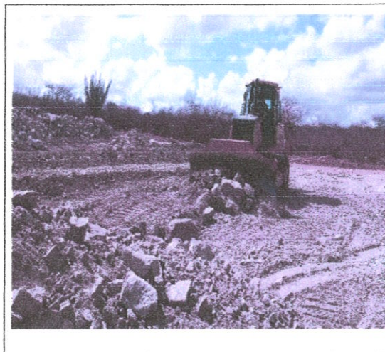
FOTO 06 – Espalhamento em bota-fora dos materiais provenientes das escavações obrigatórias do Vertedouro.
