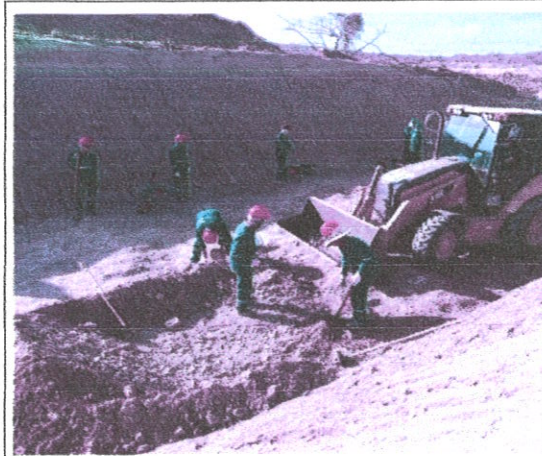
FOTO 02 – Tratamento da fundação em rocha com utilização de limpeza manual e mecânica, estaca 23.
