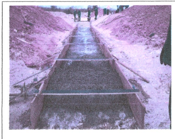
FOTO 08 – Concreto de regularização da galeria da tomada d'água, est 27+10;
