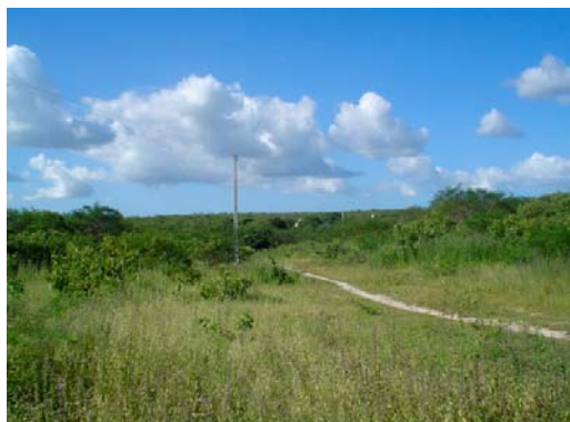
Foto 05/13 – Trechos da rede elétrica de baixa tensão que será submersa, devendo ser alvo de relocação.
