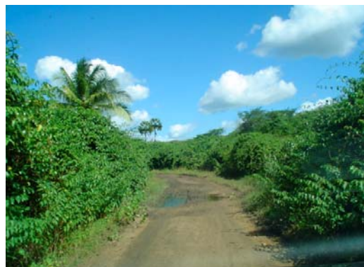
Foto 06/13 – Estrada carroçável que intercepta a área da bacia hidráulica do açude, a qual terá trechos submersos pela formação do lago. Em substituição será construída pela SRH uma estrada contornando a área do futuro reservatório.
