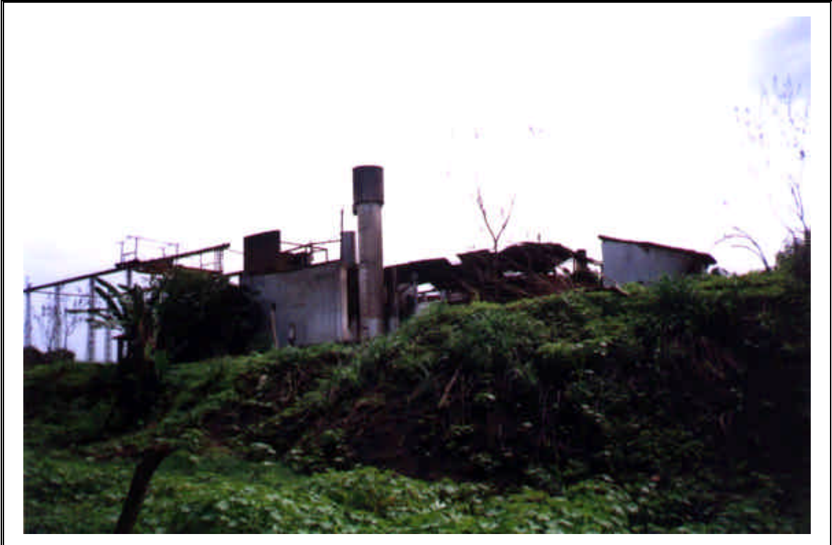
FOTO 15 – O MAIOR EXEMPLO DO NÍVEL DE ABANDONO DA ÁREA SÃO AS INSTALAÇÕES DA ANTIGA FÁBRICA DE AGUARDENTE DANDIZ. NA FOTO SE OBSERVA AS ANTIGAS INSTALAÇÕES DA INDÚSTRIA.
