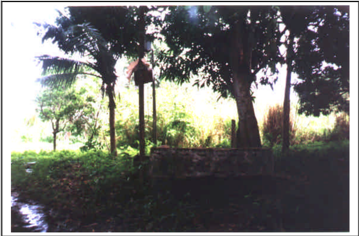
FOTO 10 – UMA DAS FORMAS DE OBTENÇÃO D'ÁGUA NA ÁREA EM APREÇO É A PARTIR DE POÇOS ESCAVADOS NAS REGIÕES CONTÍGUAS A DRENAGEM. NESTA FOTO, NAS MARGENS DO RIACHO DA TANGUEIRA SE OBSERVA UM POÇO QUE PERMITE A CAPTAÇÃO D'ÁGUA A UMA PROFUNDIDADE MÉDIA DE 4 (QUATRO) METROS.
