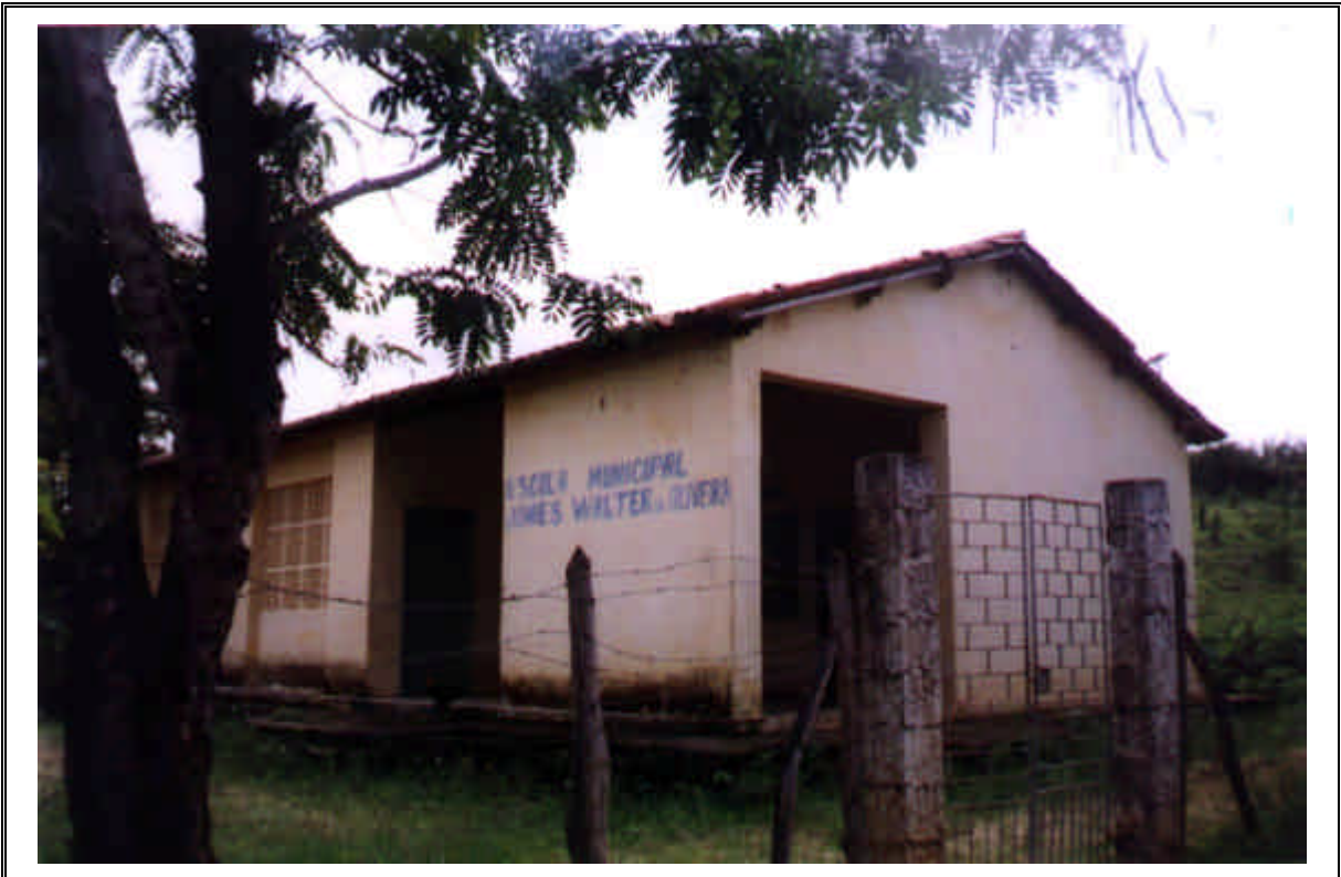
FOTO 14 – ALÉM DAS INÚMERAS RESIDÊNCIAS DESOCUPADAS, A ESCOLA DE ENSINO BÁSICO LOCALIZADA NO INTERIOR DA BACIA TAMBÉM ENCONTRA-SE FECHADA. DEVIDO A ESTA SITUAÇÃO, AS CRIANÇAS EM IDADE ESCOLAR TÊM QUE SE DESLOCAR ATÉ A LOCALIDADE DE TABATINGA, CERCA DE 1 KM DE DISTÂNCIA.
