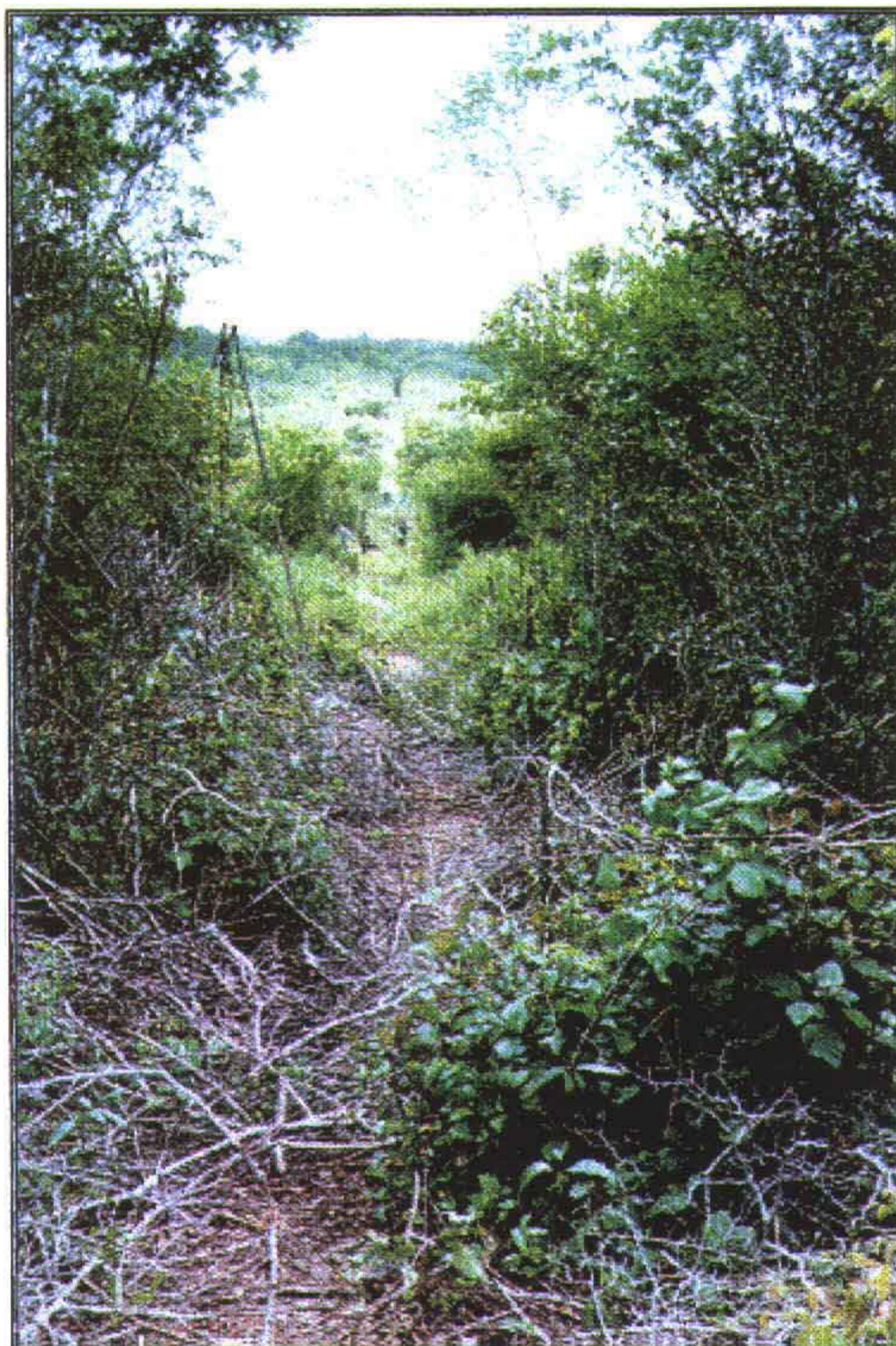
Visão geral da picada aberta no eixo da barragem do Rio Malcozinhado.
