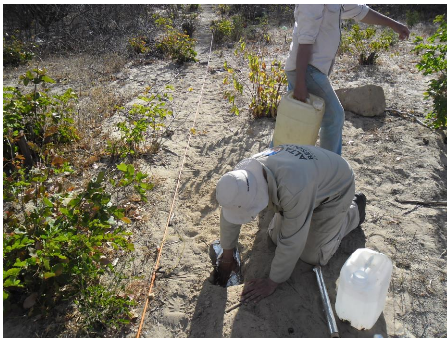
Figura 3.7 - Instalação do eletrodo de "Papel alumínio" visando melhorar o acoplamento galvânico com o solo.
