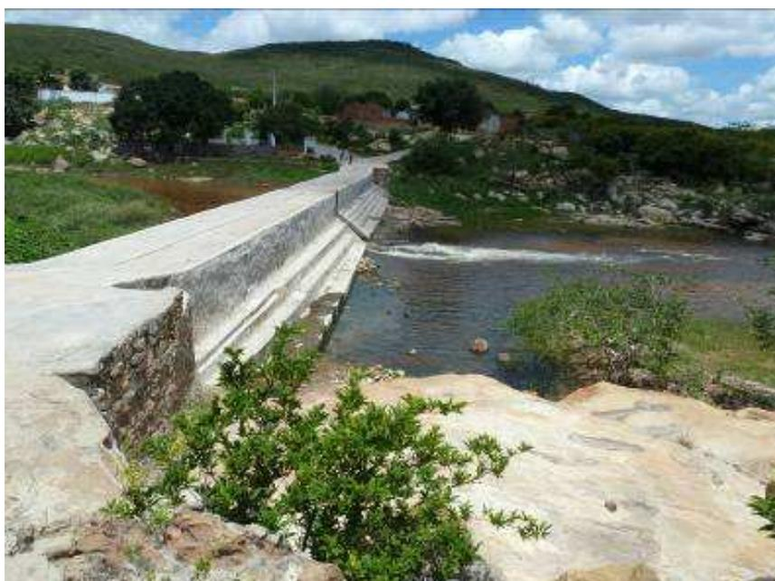
**Foto 3.21: Passagem molhada em Barra do Sotero (Coord. UTM 9.519.870 E 283.688). Esta barreira, reformada recentemente, já foi galgada por ocasião de uma enchente, durante cerca de uma semana.**
