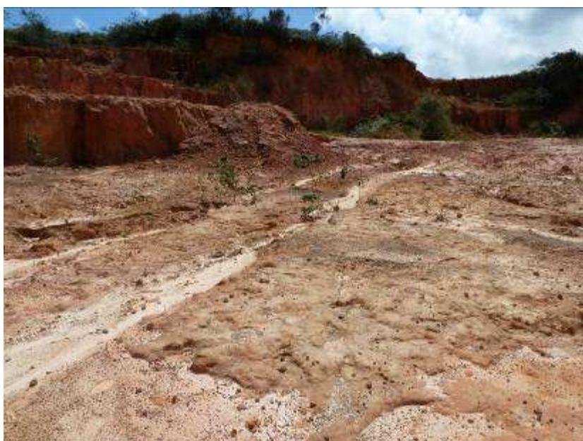
**Foto 3.42: Cava de areia em exploração, à margem da rodovia que liga Carnaubal a Inhuçu. A espessura da areia (não coesiva) alcança cinco a seis metros e é capeada por horizonte de solo laterítico concrecionado ( Coord. UTM N 9.543.135 E 287.362).**
