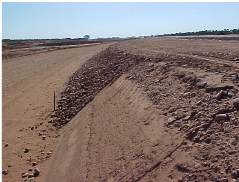
Foto 4.6: Proteção de Taludes com Material Inerte
