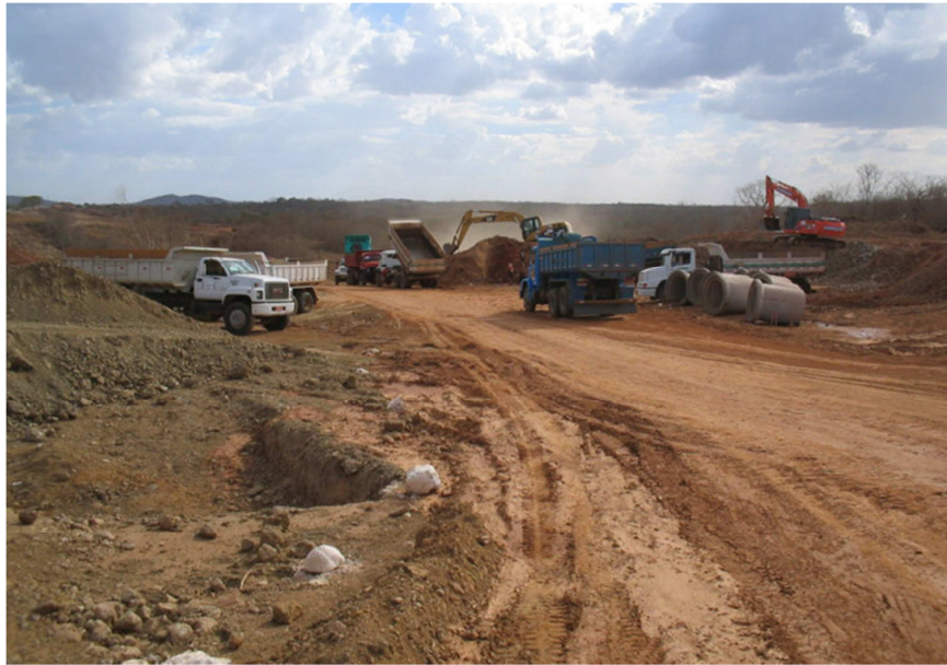
Foto 4.4: Escavação de Material e Transporte
