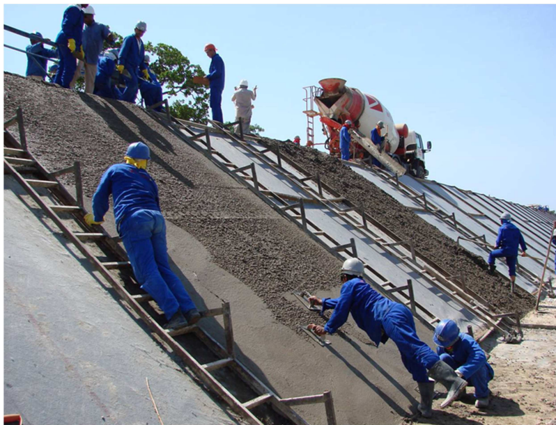
Foto 4.9: Concreto de Revestimento do Canal
