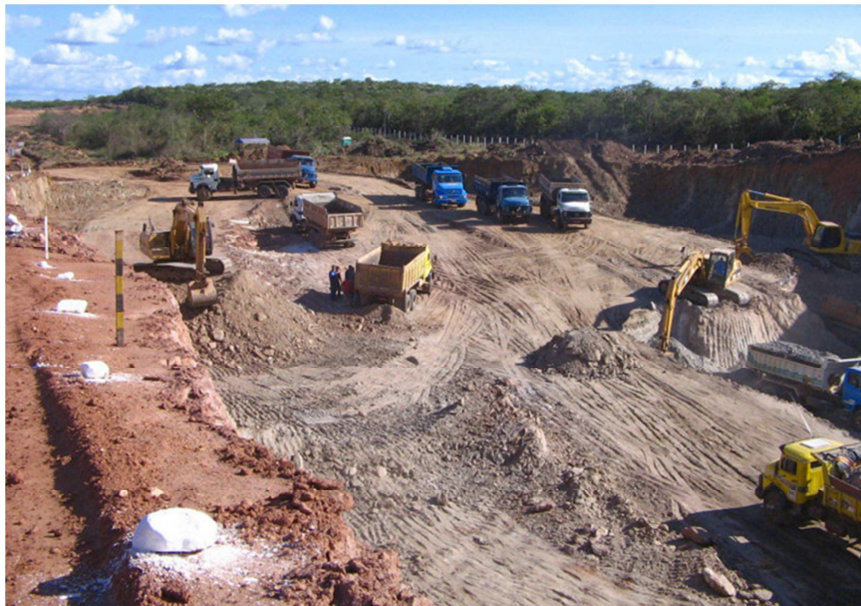
Foto 4.3: Escavação de Material e Transporte
