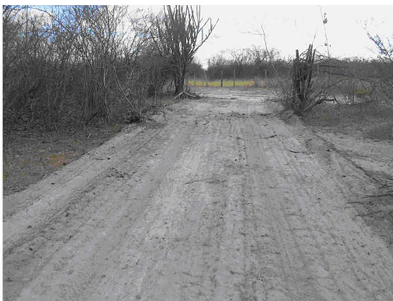
Foto 4.1: Estrada de Acesso a serem Construídas
