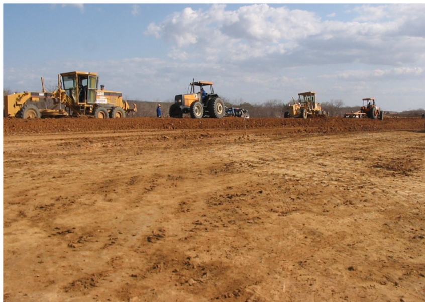
Foto 4.5: Compactação, Espalhamento de Aterro
