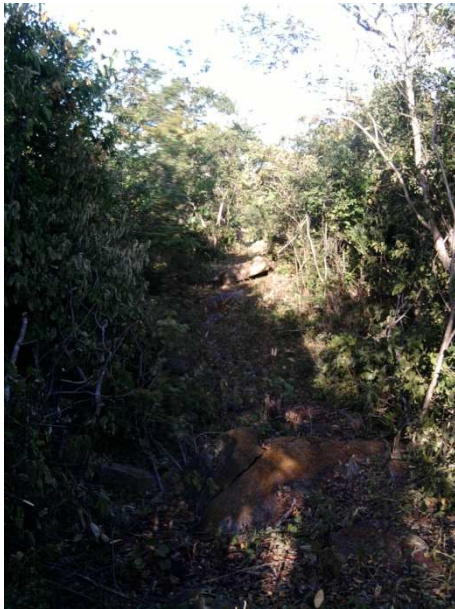
89 - LEVANTAMENTO DOS FUROS NO EIXO DO CANAL
