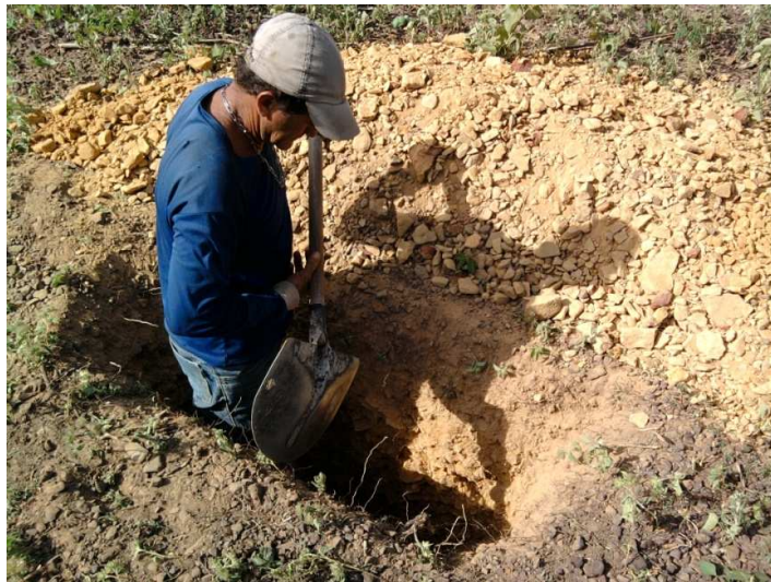
87 - FURO 19 DA JAZIDA 01 PARA O CANAL DE CROATÁ
