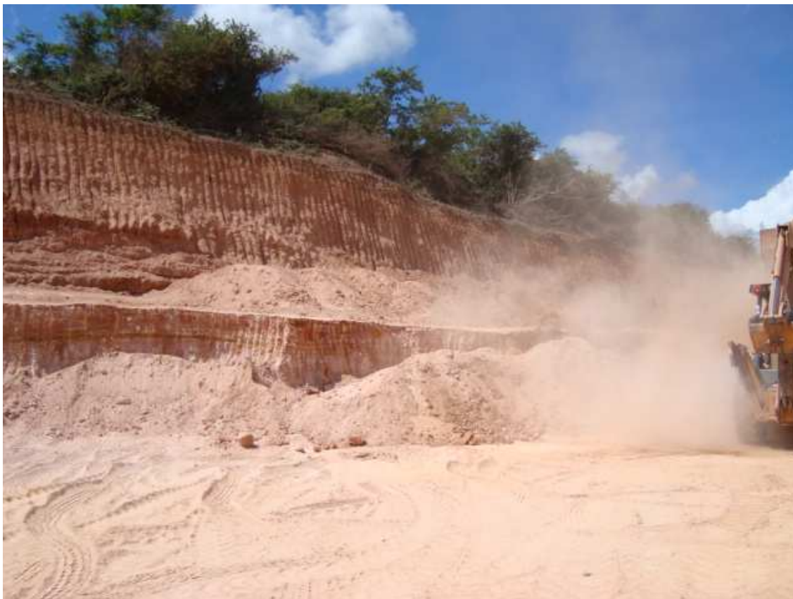
Foto 15 – Jazida de terra para execução de aterro hidráulico. (13/05/2010)
