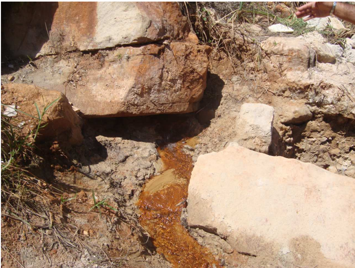
Foto 68 – Revência próxima aos medidores de vazão 10 e 11. (17/08/2010)
