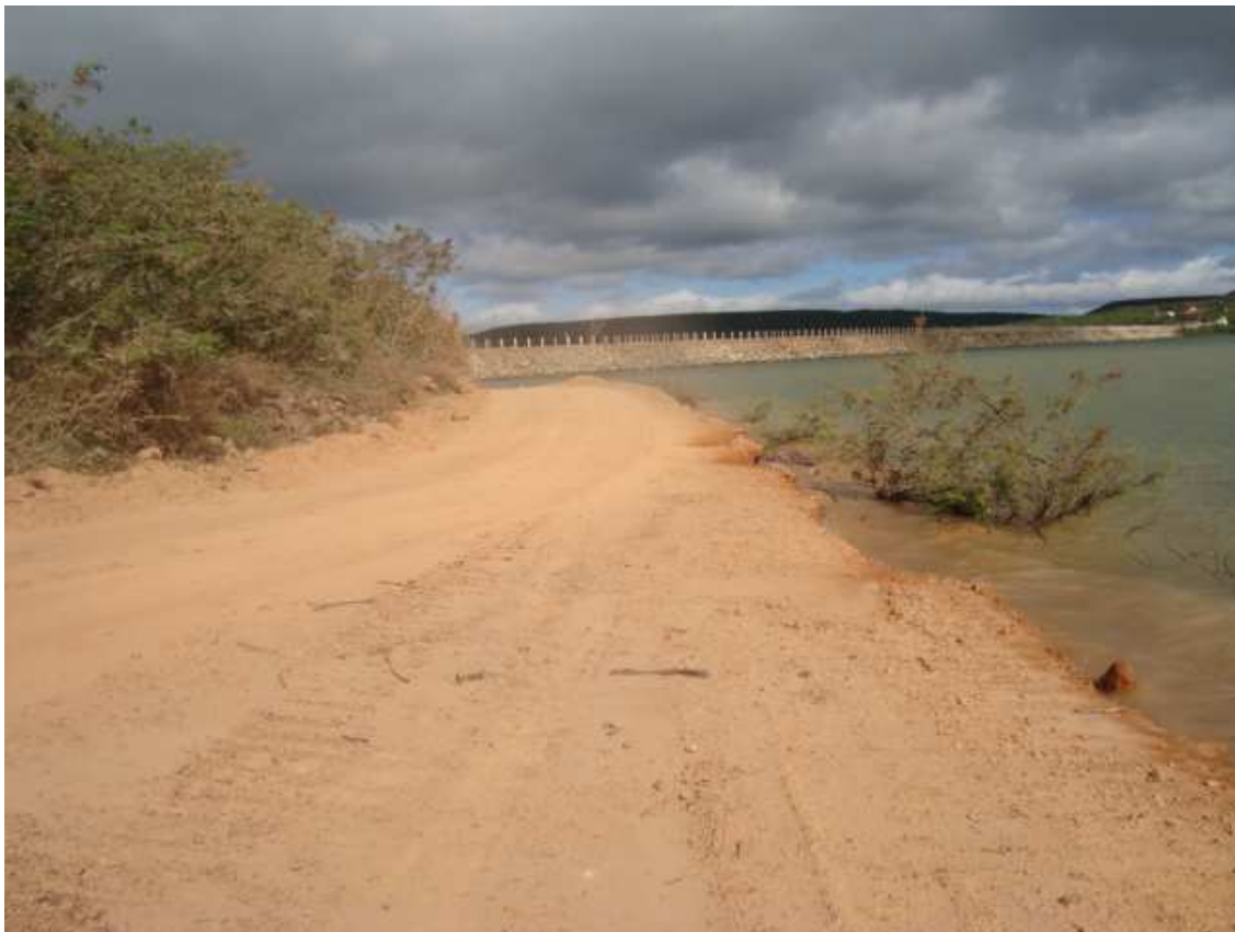
Foto 14 – Vista do barramento a partir do aterro hidráulico. (13/05/2010)
