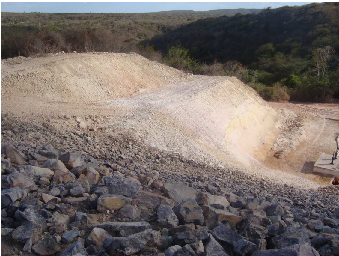
Foto 83 – Taludamento da ombreira esquerda da Tomada D'água. (15/09/2010)
