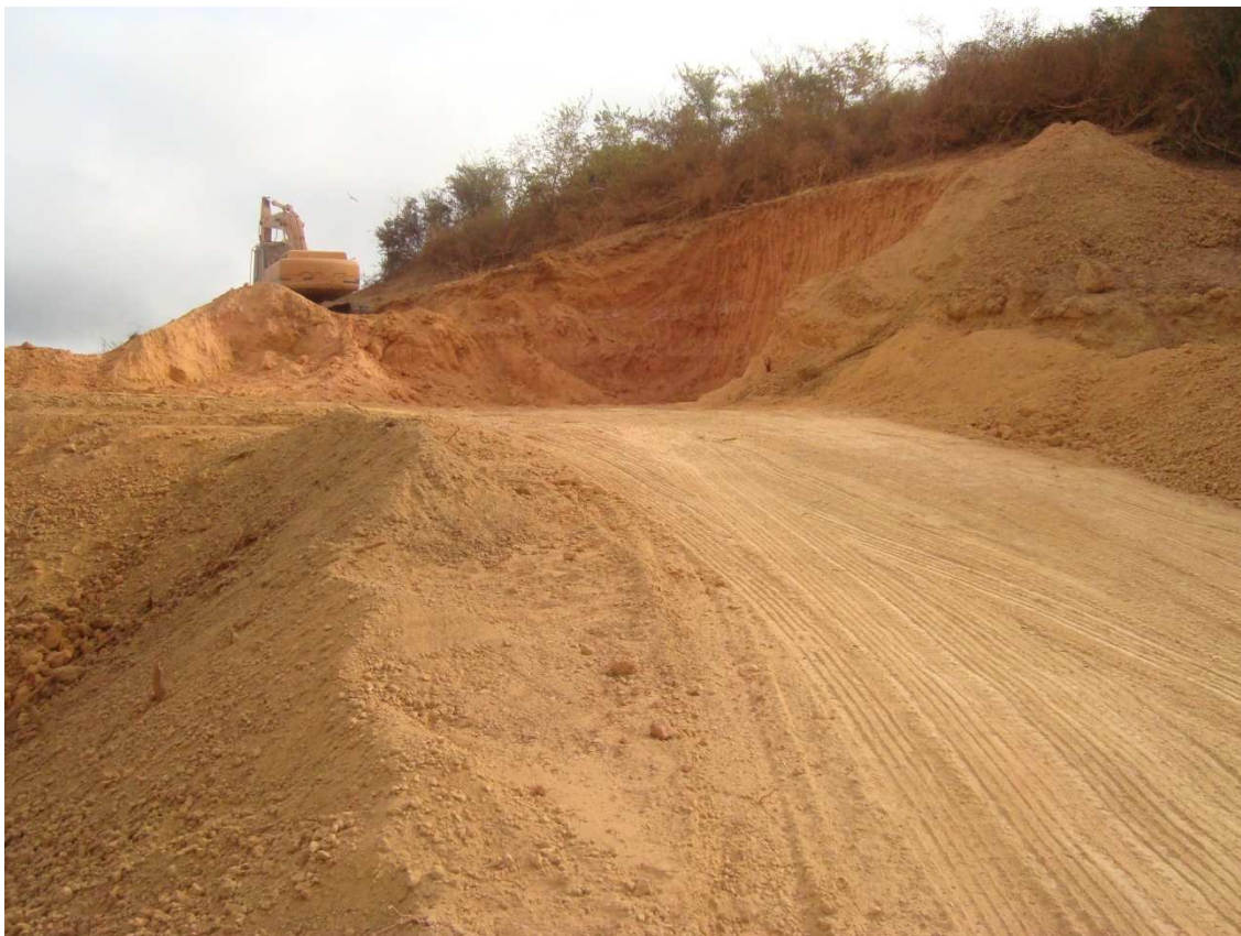
Foto 7 – Jazida de terra para execução do aterro hidráulico. (08/04/2010)
