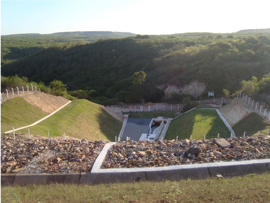
Foto 113 – Vista geral da Tomada D'água após intervenções. (22/12/2010)
