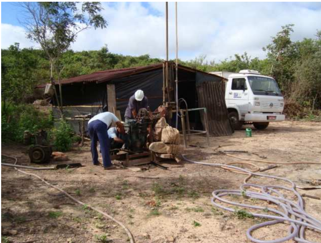
Foto 17 – Execução de Sondagem rotativa na ombreira esquerda. (13/05/2010)
