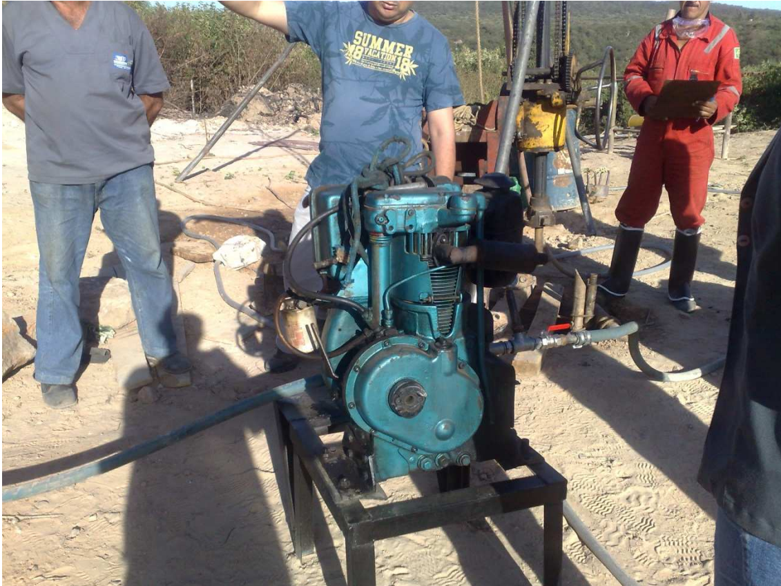
Foto 29 – Moto-bomba, para injeção de asfalto nos furos de sondagem. (19/06/2010)
