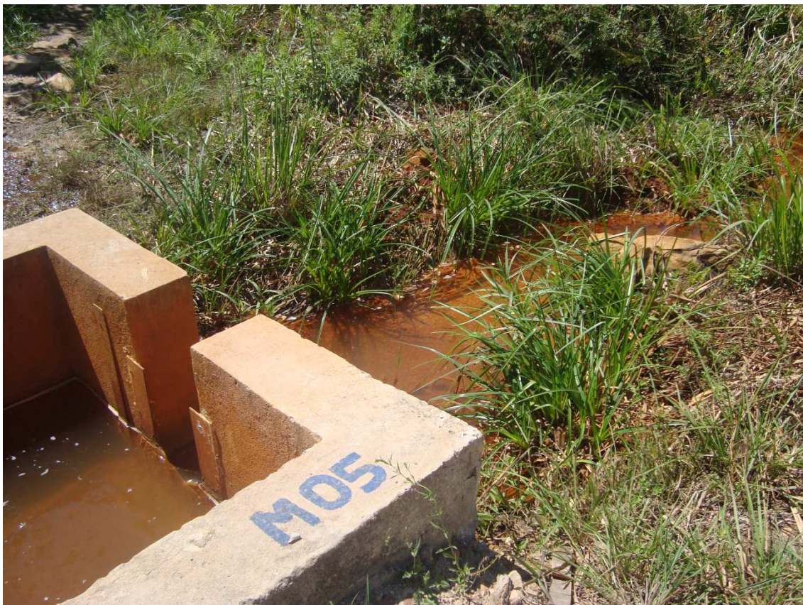
Foto 73 – Medidor de Vazão 05. (17/08/2010)
