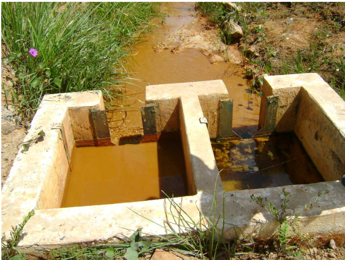
Foto 41 – Medidores de Vazão 06 e 07 logo após a injeção de asfalto. (24/06/2010)
