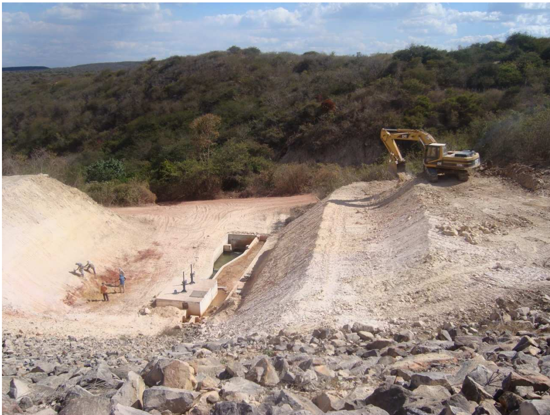
Foto 74 – Taludamento da ombreira direita da Tomada D'água. (02/09/2010)
