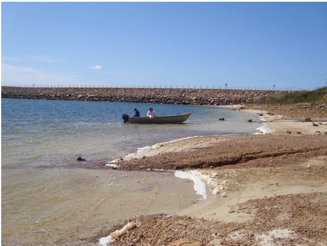
Foto 103 – Execução de batimetria no açude. (02/12/2010)
