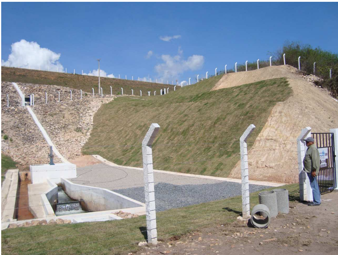
Foto 111 – Grama colocada para proteção do talude esquerdo. (22/12/2010)
