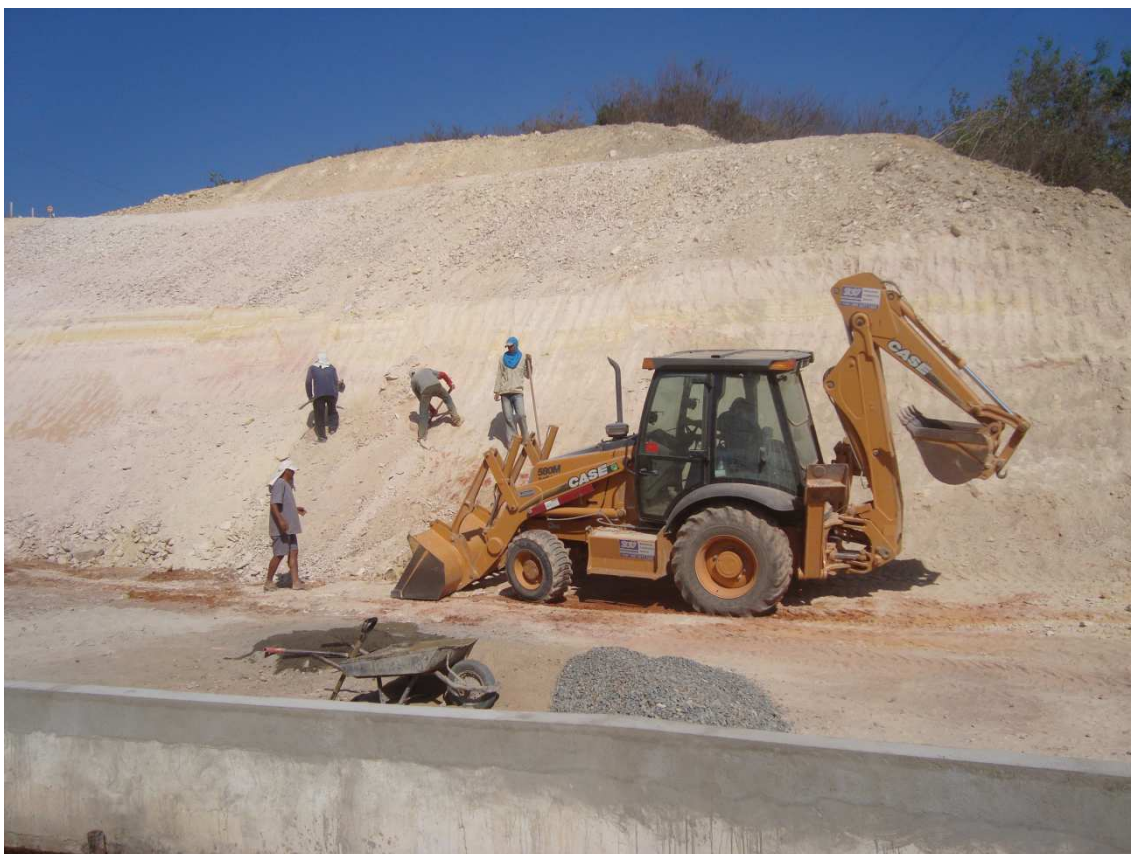
Foto 93 – Taludamento da ombreira esquerda da Tomada D'água. (06/10/2010)
