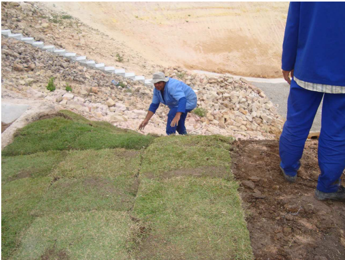
Foto 110 – Colocação de grama para proteção dos taludes. (02/12/2010)
