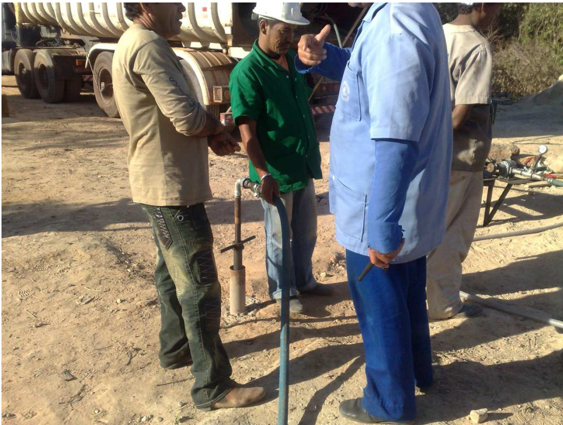
Foto 30 – Mangueira acoplada para injeção de asfalto nos furos. (19/06/2010)
