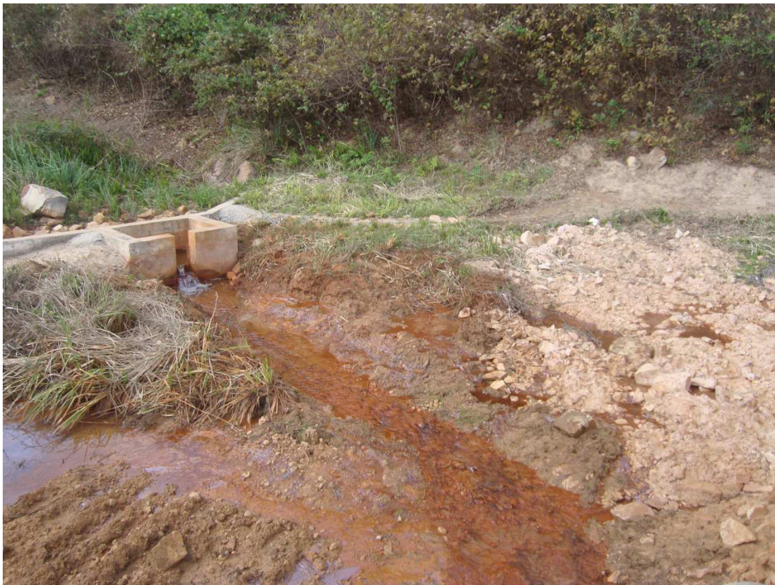
Foto 94 – Área a jusante do Medidor de Vazão 05. (28/10/2010)
