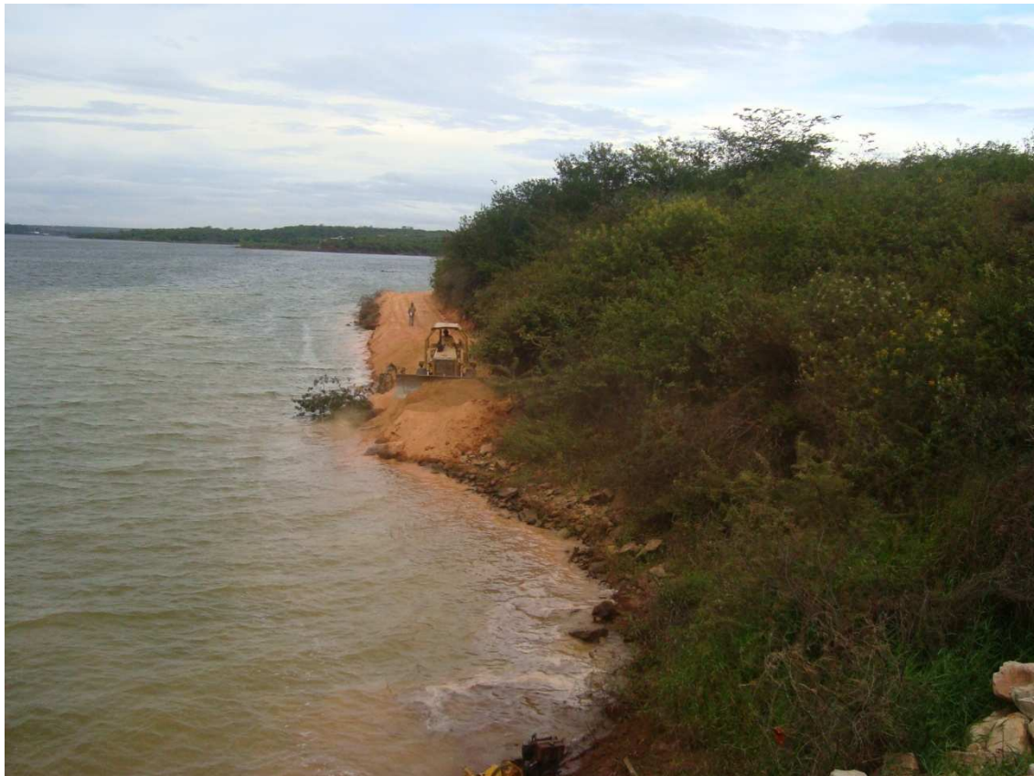
Foto 6 – Início da execução de aterro hidráulico na ombreira esquerda. (08/04/2010)
