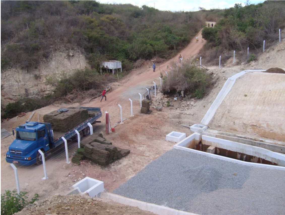
Foto 107 – Carregamento de grama para proteção dos taludes. (02/12/2010)
