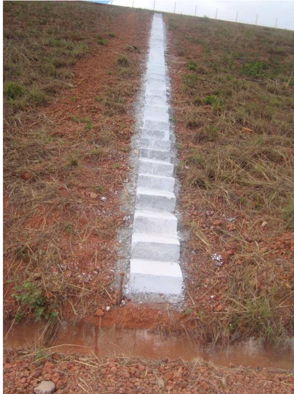
Foto 81 – Escada de acesso no talude jusante. (02/09/2010)
