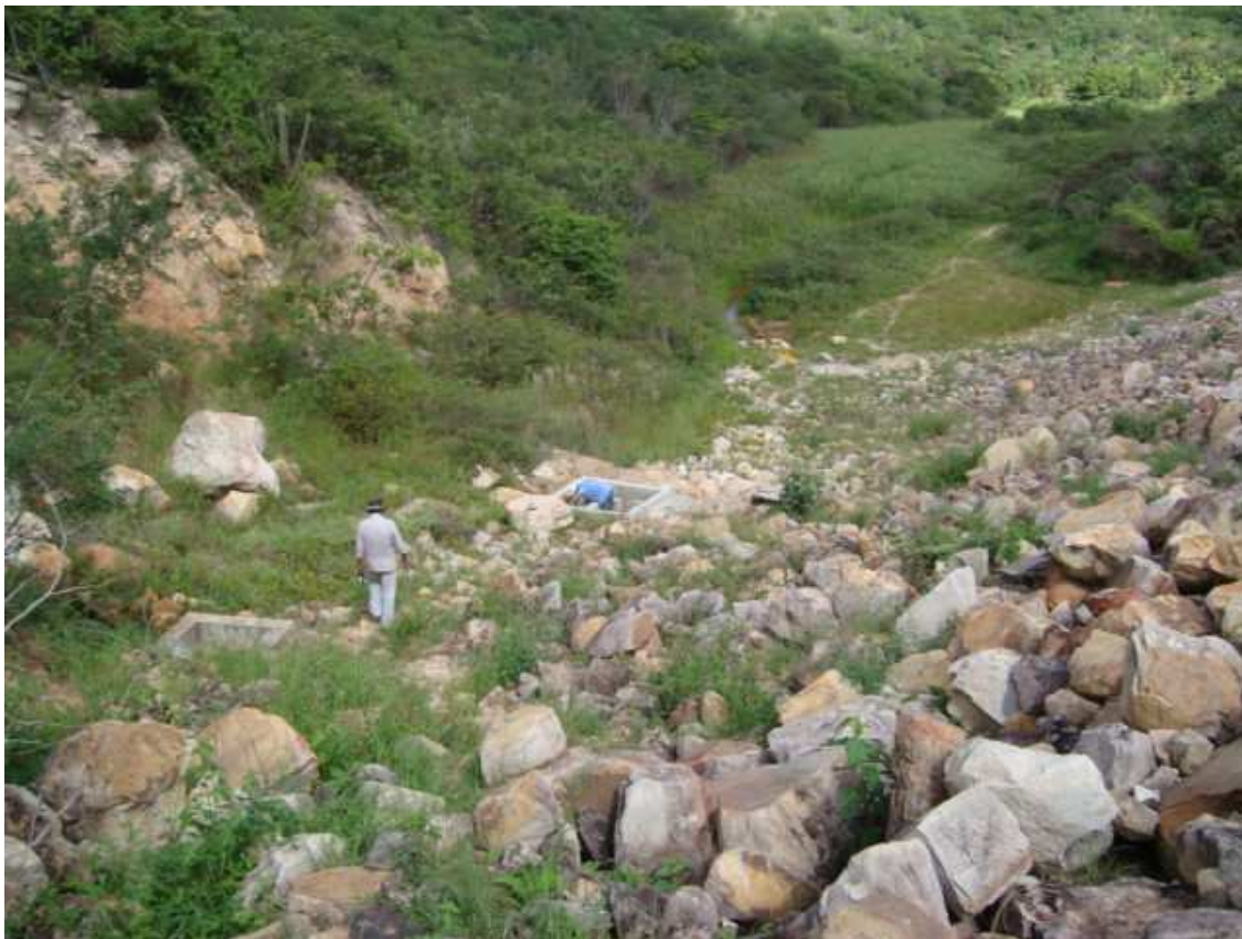
Foto 18 – Construção dos medidores de vazão 10 e 11. (13/05/2010)
