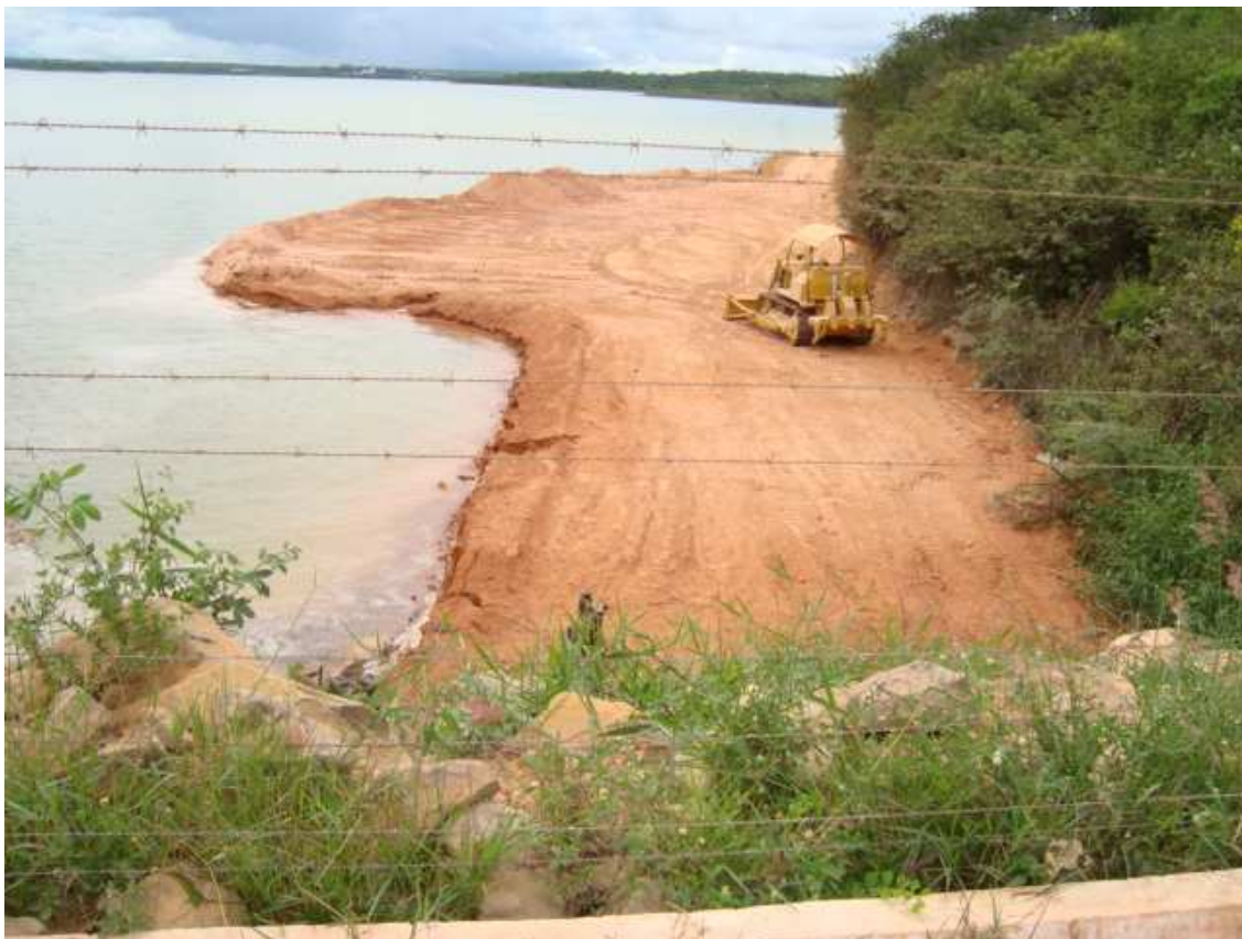
Foto 11 – Aterro hidráulico na ombreira esquerda. (06/05/2010)
