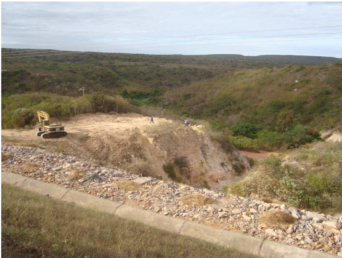
Foto 60 – Taludamento da ombreira esquerda da Tomada D'água. (05/08/2010)
