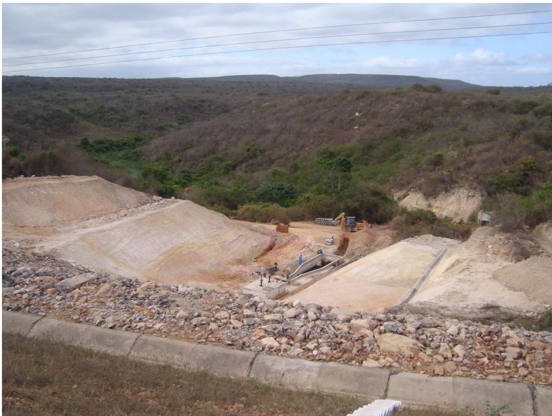
Foto 101 – Taludamento das ombreias e reforma na Tomada D'água. (28/10/2010)
