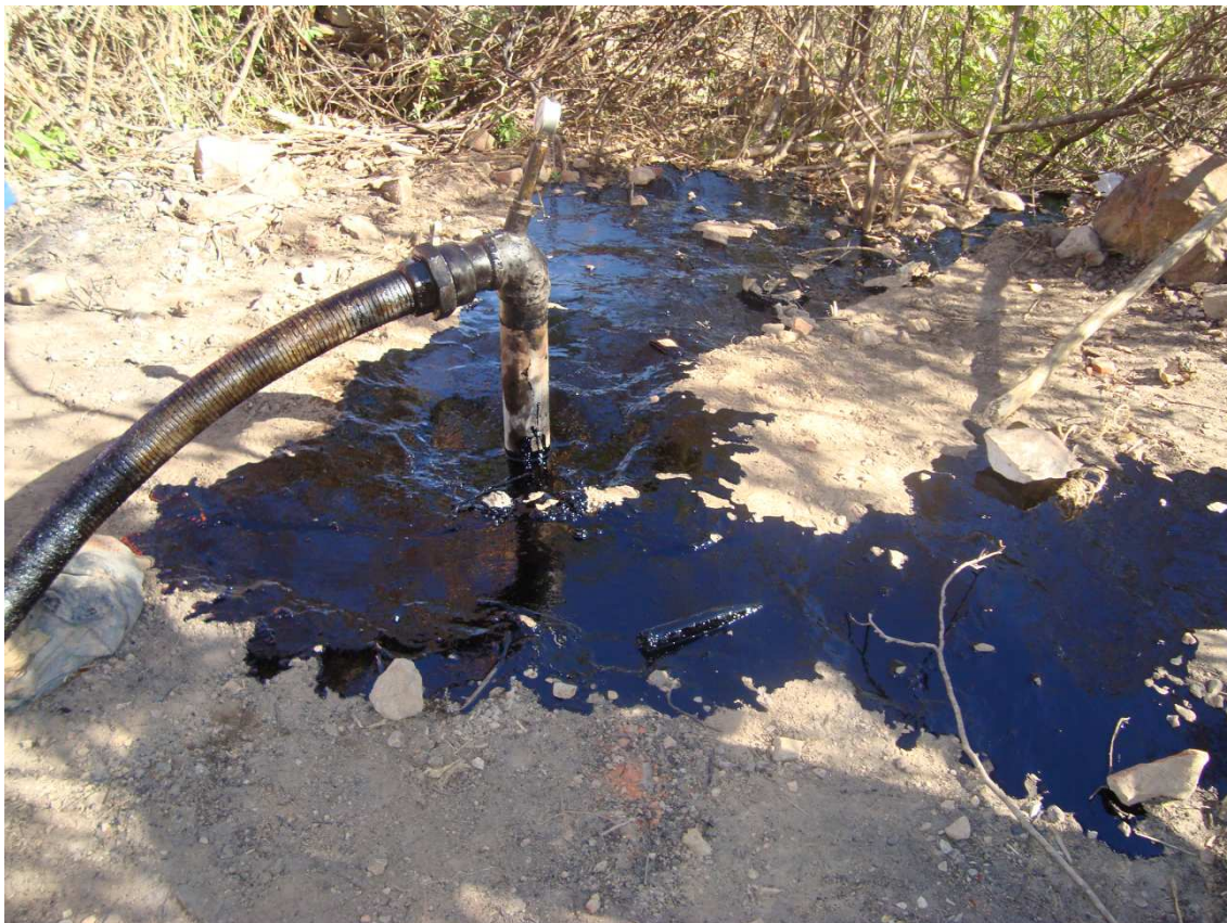
Foto 58 – Furo de sondagem, após injeção de asfalto. (30/07/2010)
