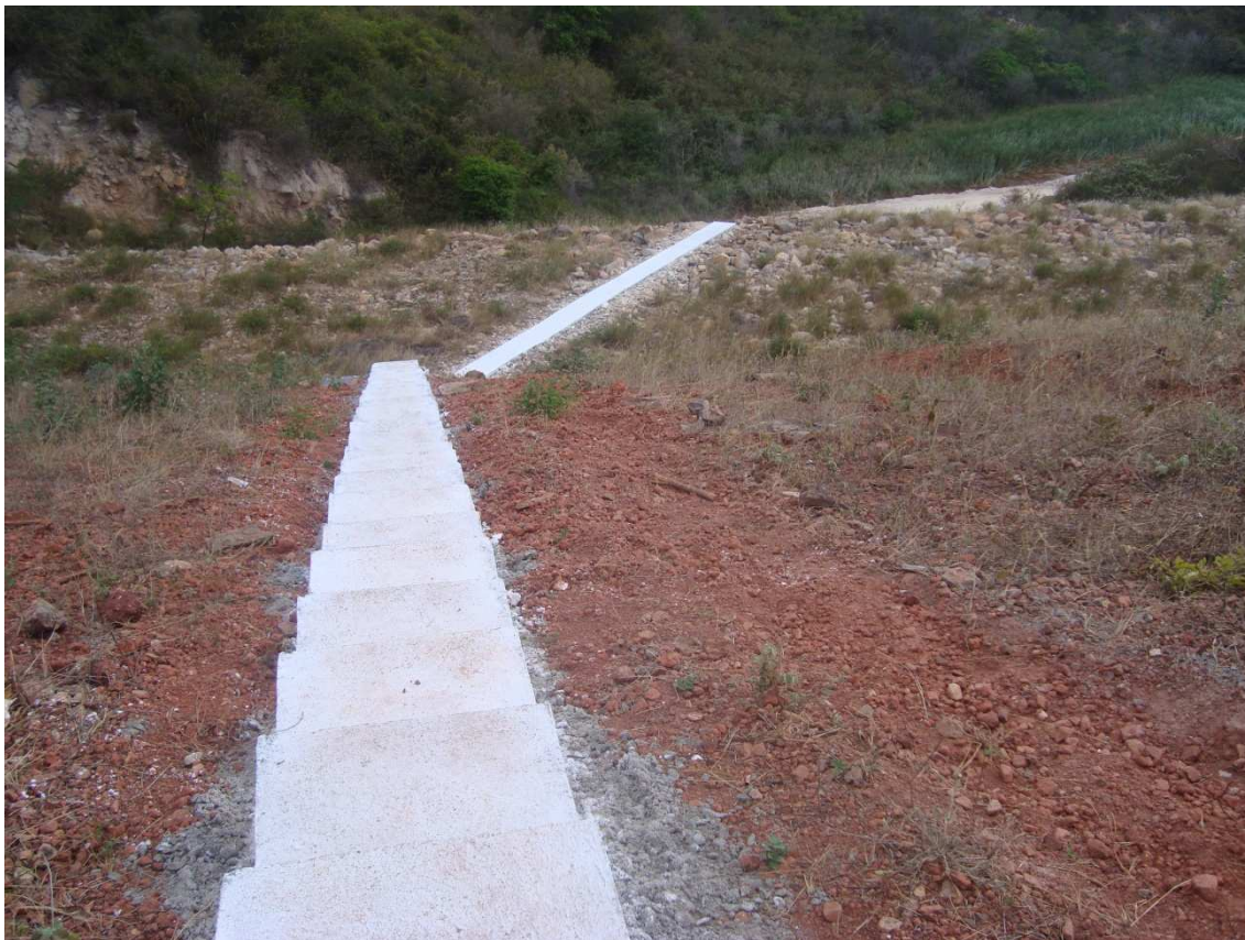
Foto 80 – Escada de acesso no talude jusante. (02/09/2010)
