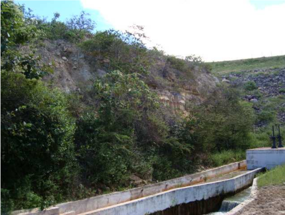
Foto 23 – Ombreira direita da Tomada D'água. (27/05/2010)
