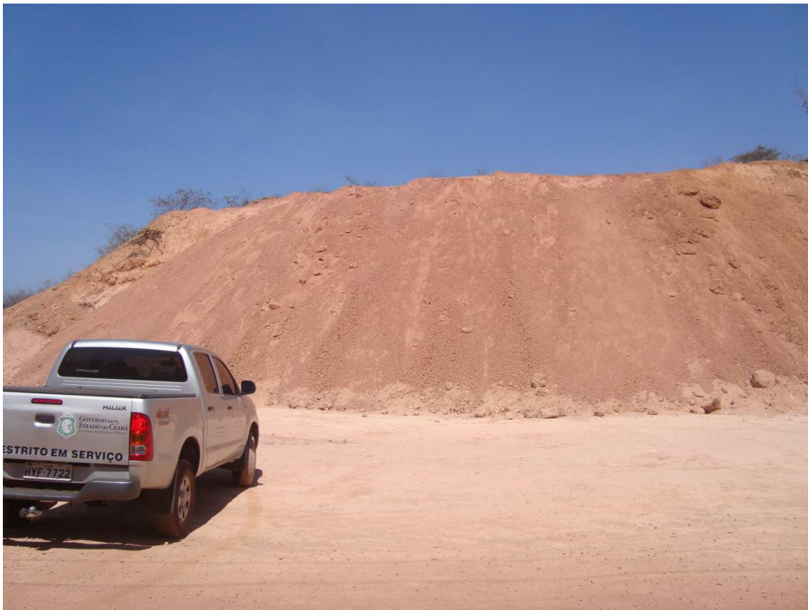
Foto 86 – Taludamento da parede da jazida de terra. (29/09/2010)
