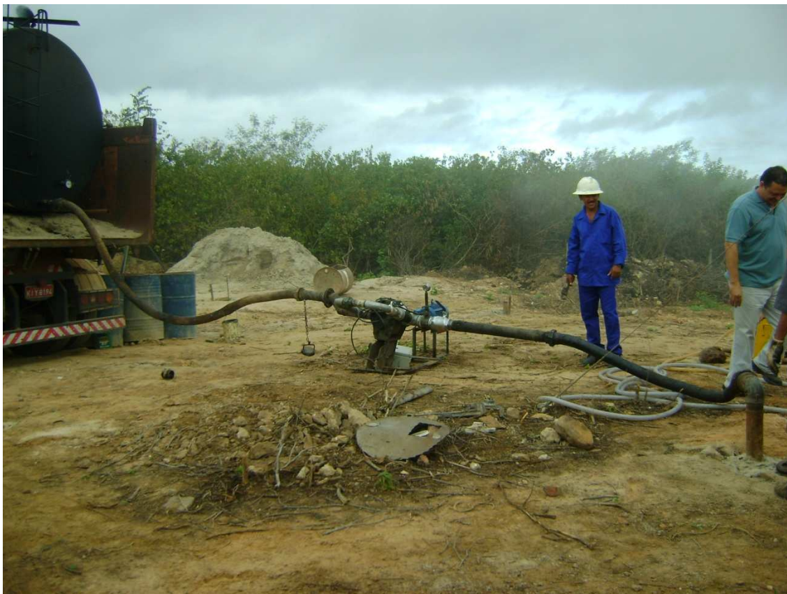
Foto 37 – Injeção de asfalto em furo de sondagem. (24/06/2010)
