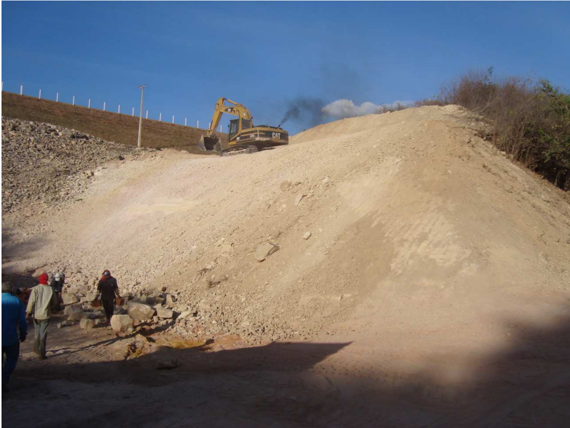
Foto 91 – Taludamento da ombreira esquerda da Tomada D'água. (29/09/2010)
