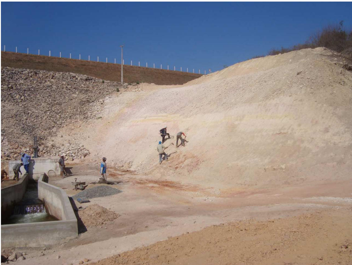
Foto 92 – Taludamento da ombreira esquerda da Tomada D'água. (06/10/2010)
