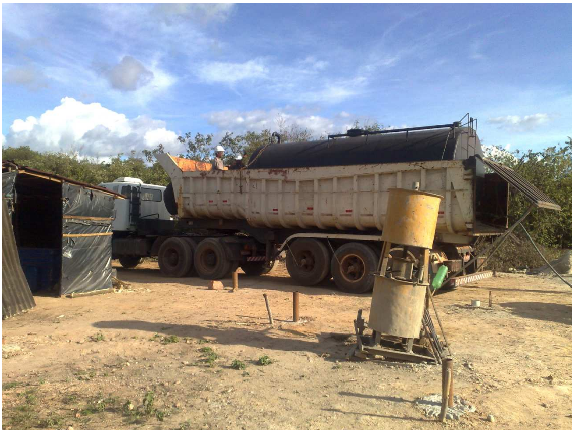
Foto 28 – Caldeira, para injeção de asfalto nos furos de sondagem. (19/06/2010)
