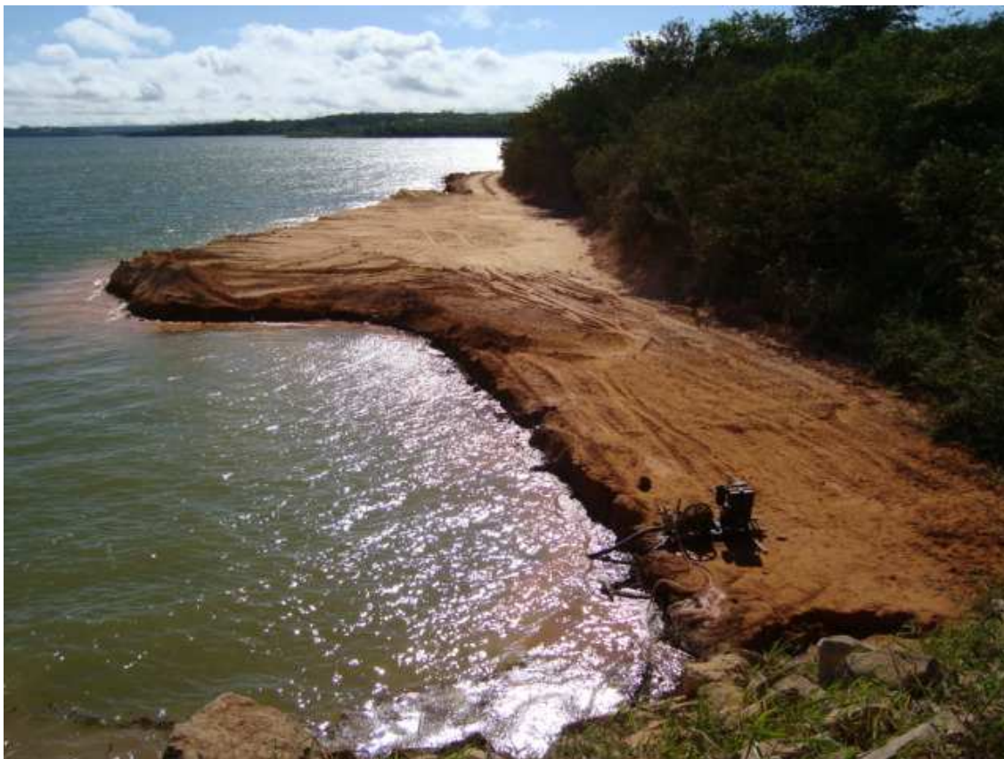
Foto 21 – Aterro hidráulico na ombreira esquerda. (27/05/2010)
