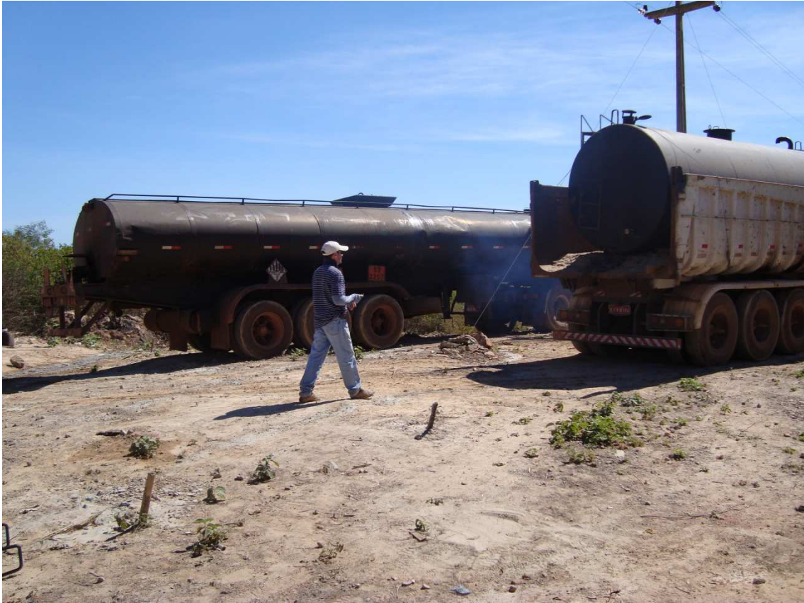
Foto 55 – Caldeiras, para injeção de asfalto nos furos de sondagem. (30/07/2010)
