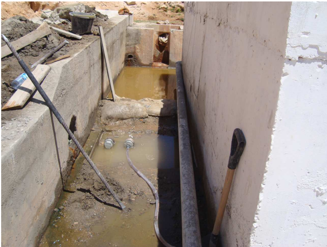
Foto 106 – Reforma da estrutura da Tomada D'água. (02/12/2010)
