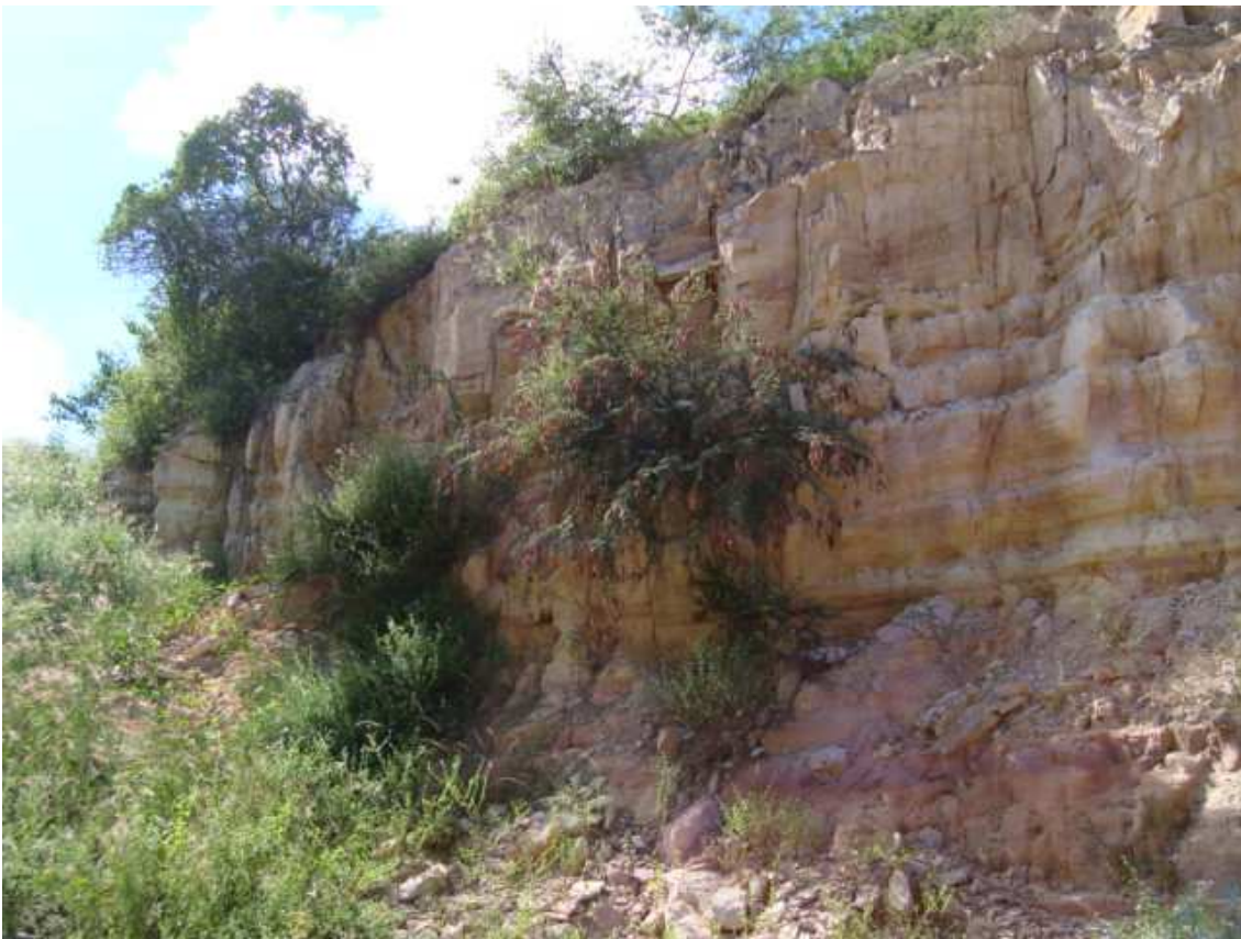
Foto 24 – Ombreira direita da Tomada D'água. (27/05/2010)
