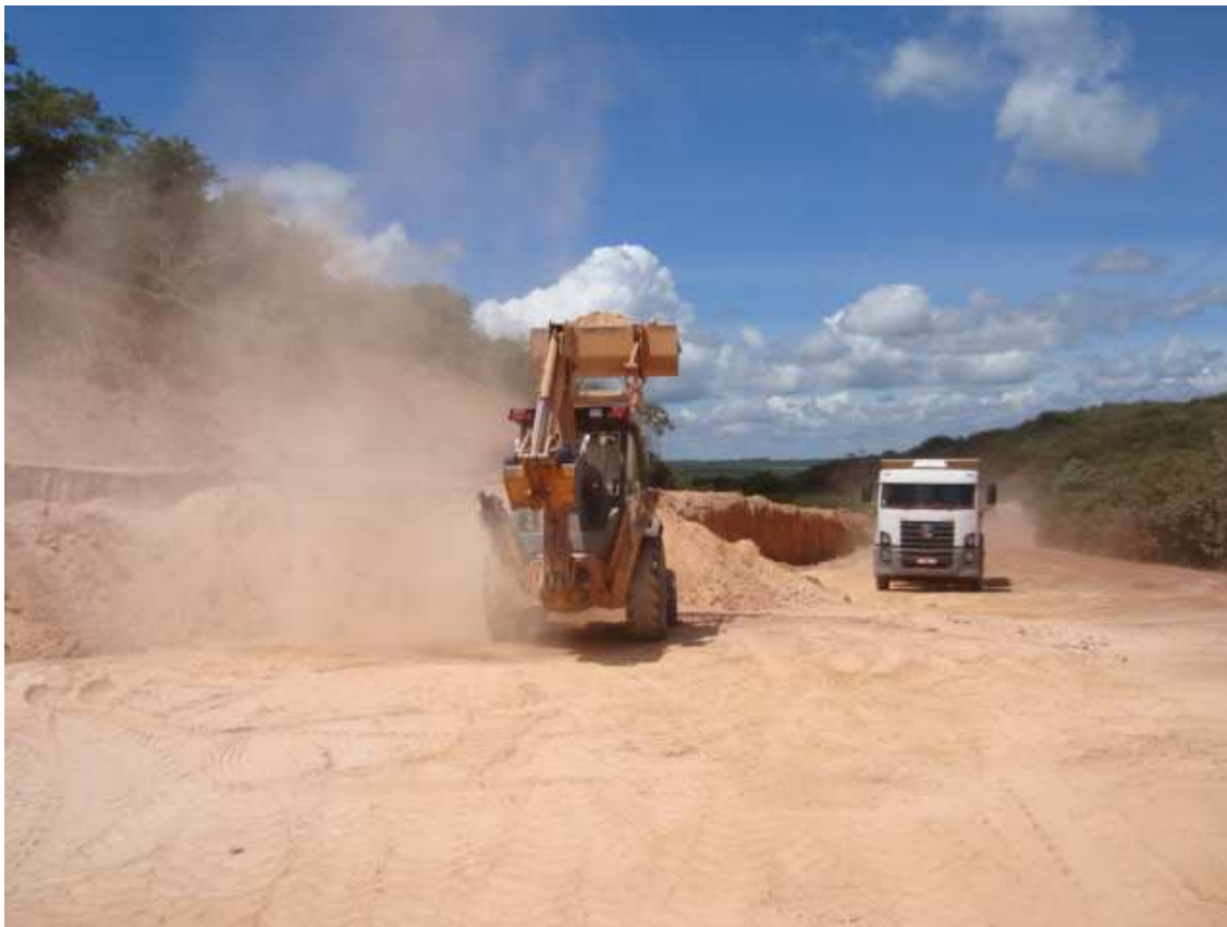
Foto 16 – Material sendo retirado e transportado da jazida. (13/05/2010)
