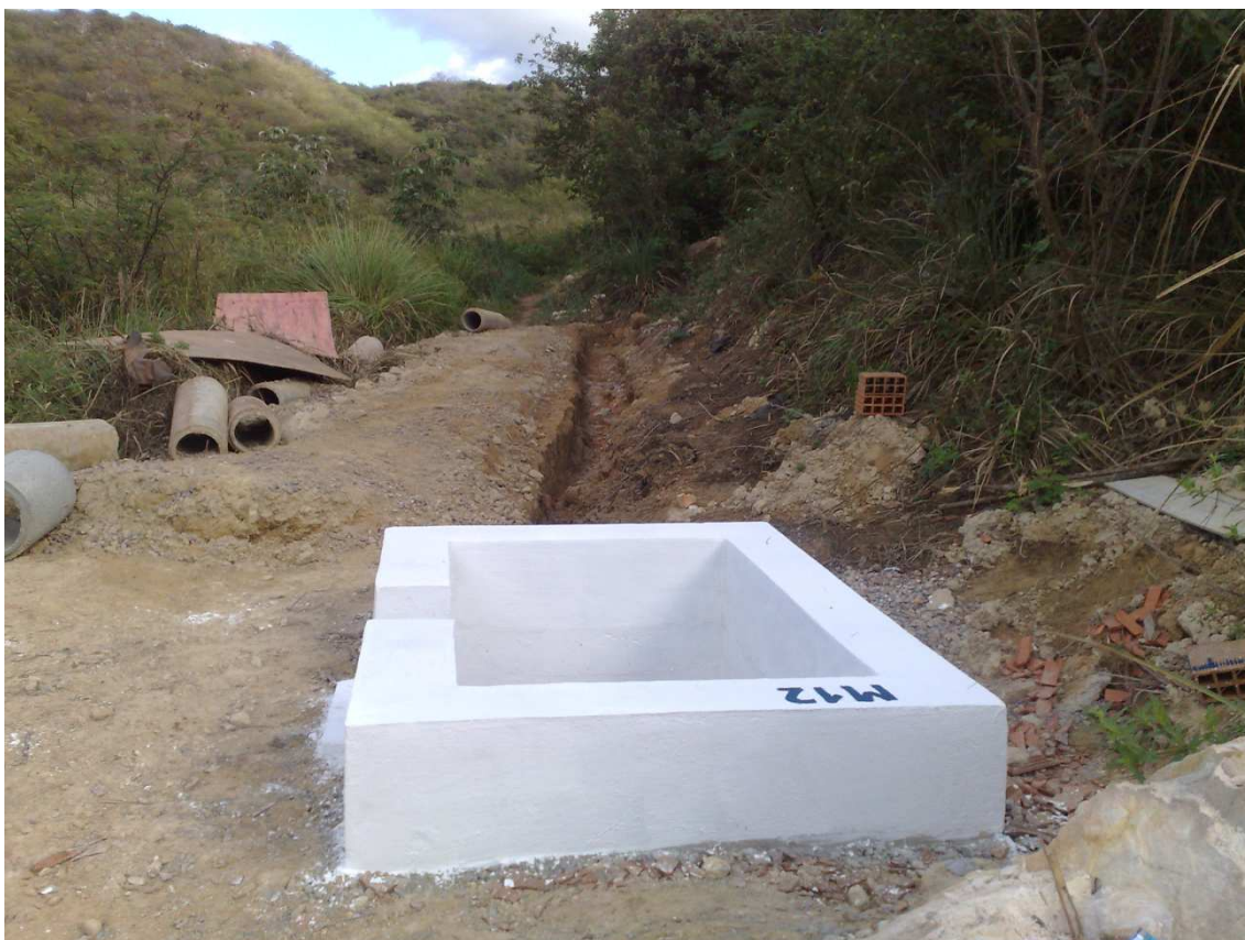
Foto 49 – Medidor de vazão 12, e vala para colocação do dreno. (22/07/2010)
