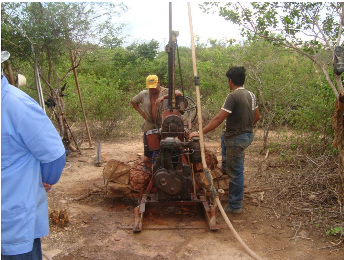
Foto 9 – Execução de Sondagem Rotativa na ombreira esquerda. (08/04/2010)
