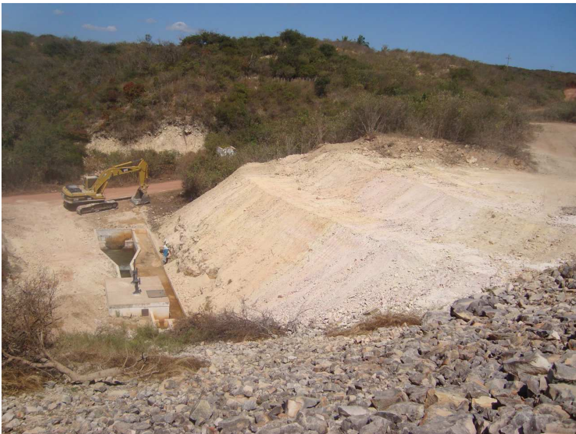
Foto 67 – Taludamento das ombreiras da Tomada D'água. (17/08/2010)
