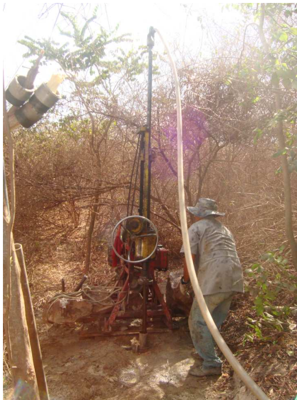
Foto 82 – Sondagem na ombreira da barragem próxima ao canal do sangradouro. (15/09/2010)
