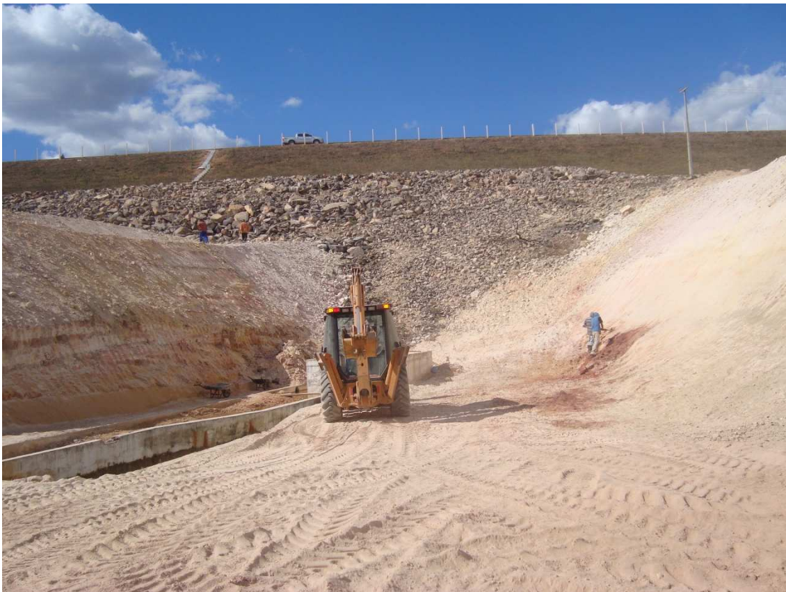
Foto 76 – Regularização do terreno na zona da Tomada D'água. (02/09/2010)
