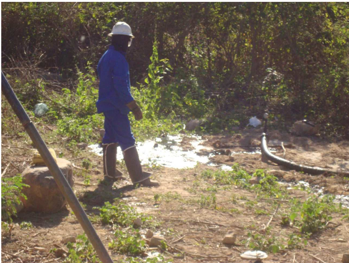
Foto 59 – Injeção de asfalto em furo de sondagem. (30/07/2010)
