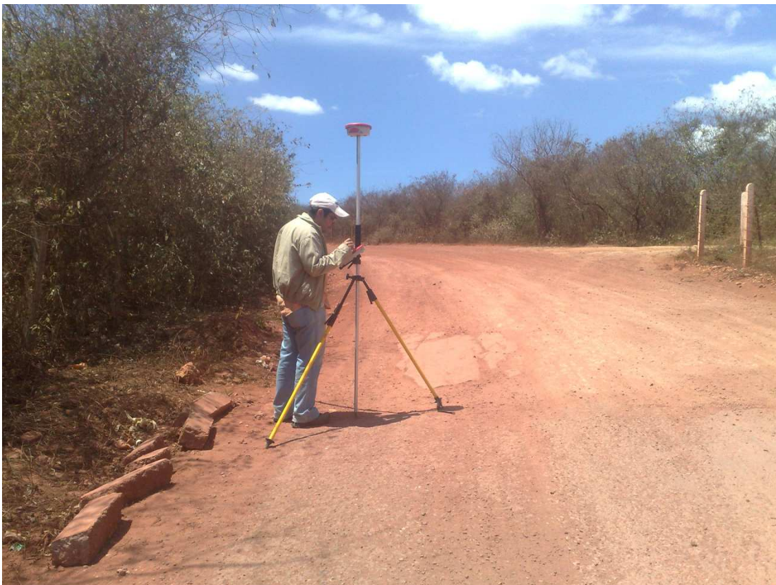
Foto 63 – Levantamento geodésico no coroamento. (17/08/2010)
