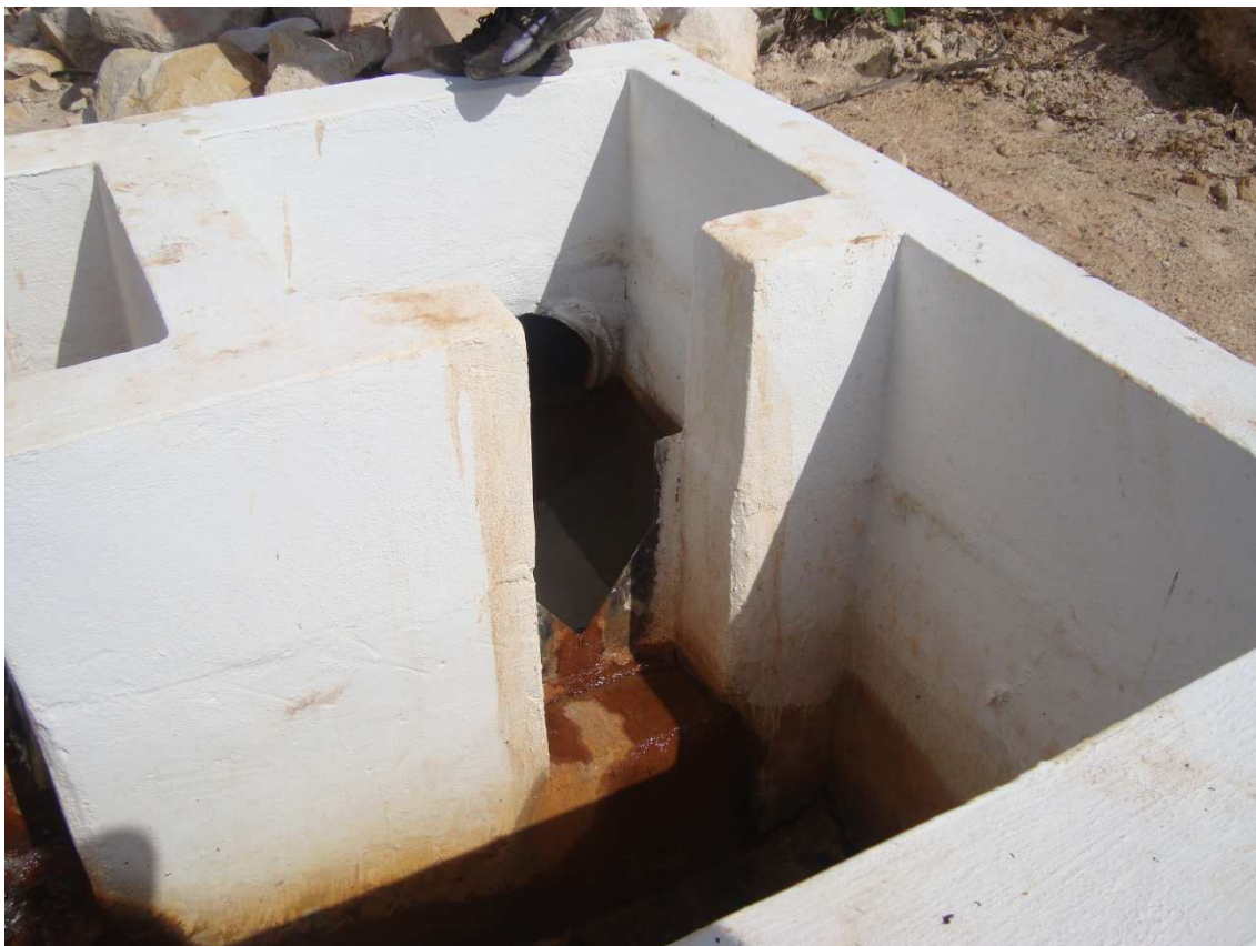
Foto 99 – Medidor de Vazão 11. (28/10/2010)
