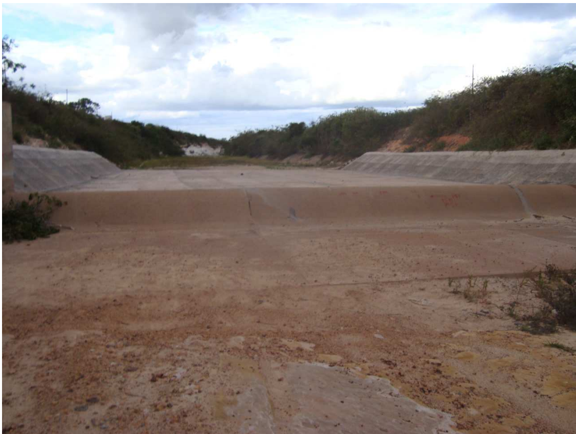
Foto 45 – Laje recém-construída à montante do Perfil Creager. (08/07/2010)
