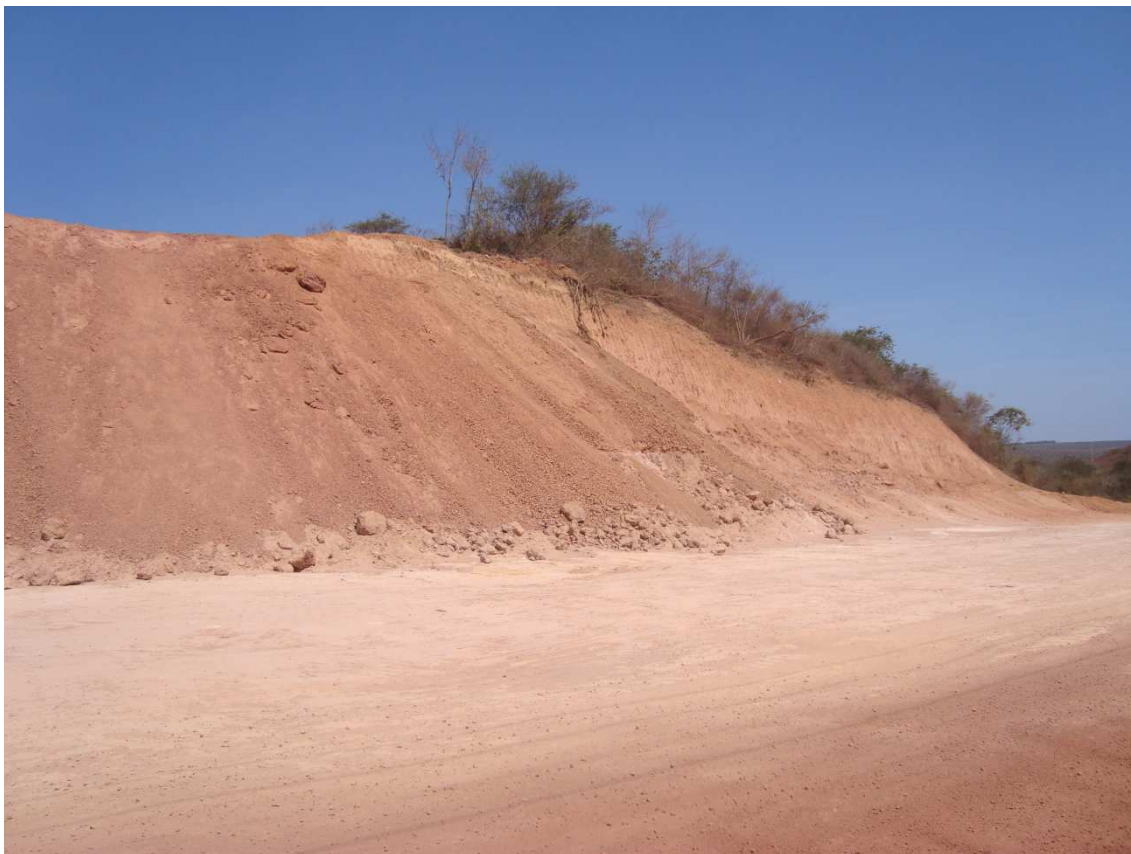
Foto 87 – Taludamento da parede da jazida de terra. (29/09/2010)
