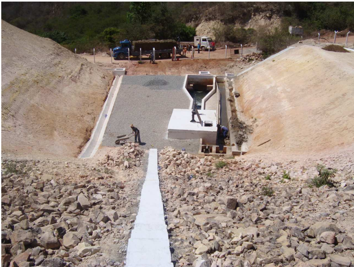
Foto 104 – Colocação de brita no entorno da Tomada D'água. (02/12/2010)
