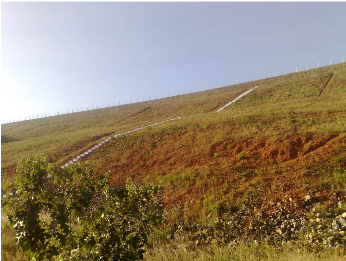
Foto 62 – Escada de acesso no talude de jusante. (05/08/2010)
