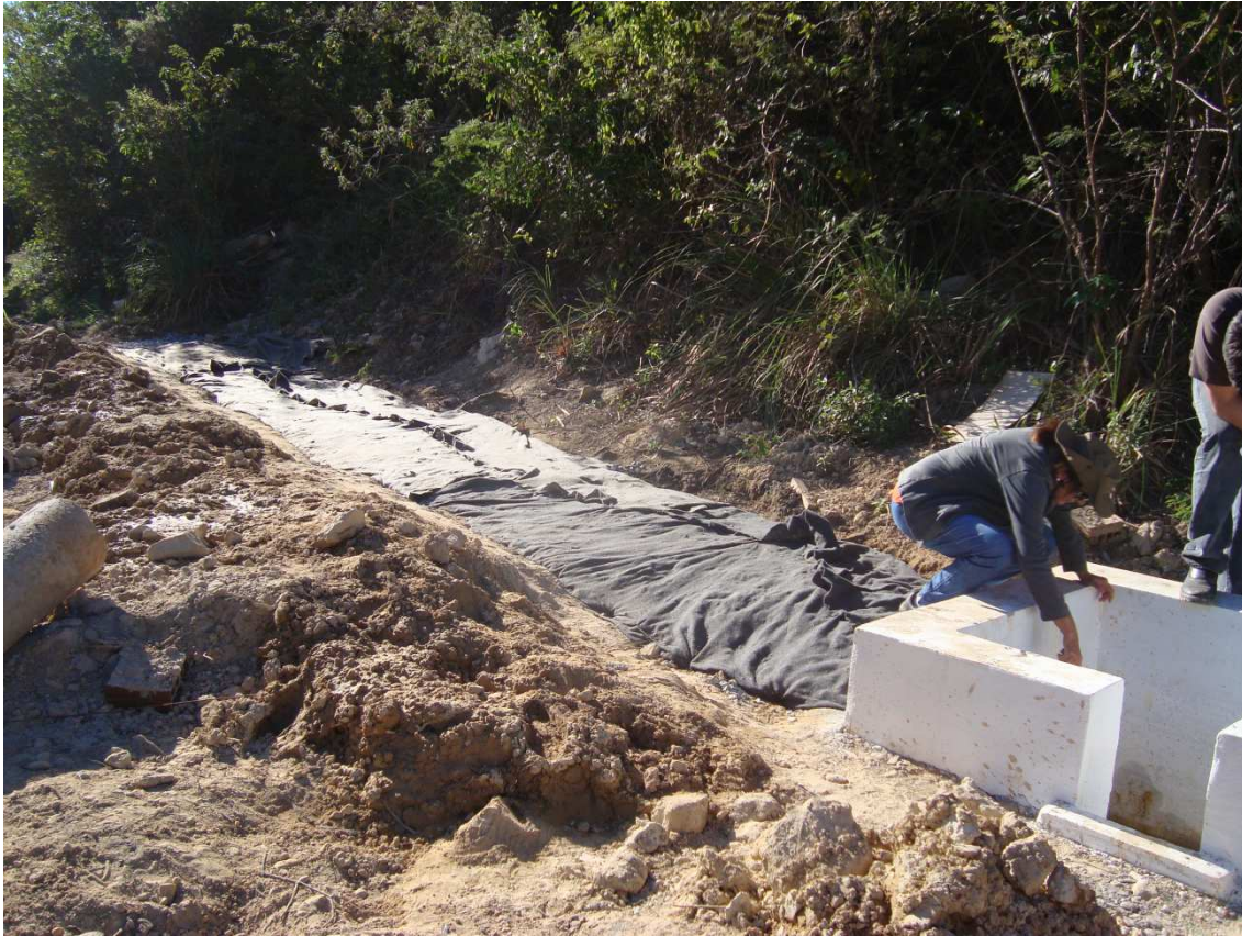
Foto 51 – Dreno coletor, com proteção de manta geotêxtil. (30/07/2010)
