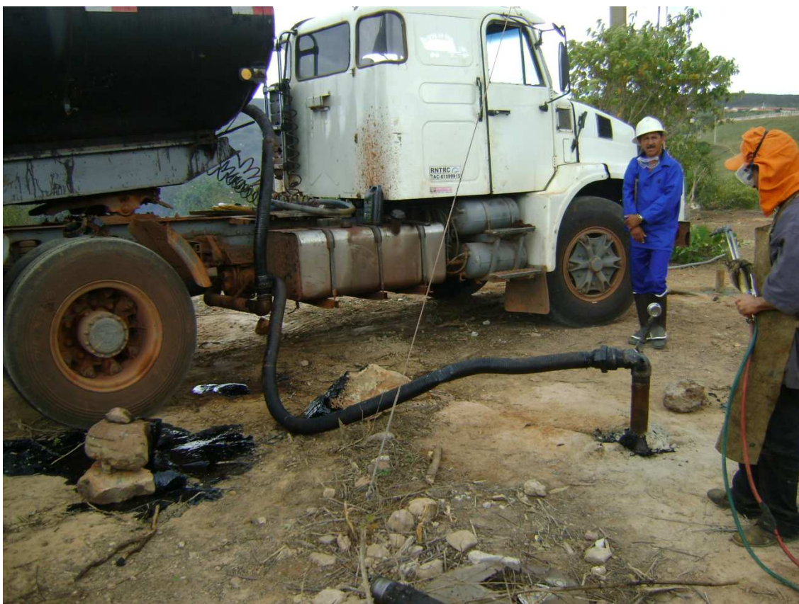
Foto 38 – Injeção de asfalto em furo de sondagem. (24/06/2010)
