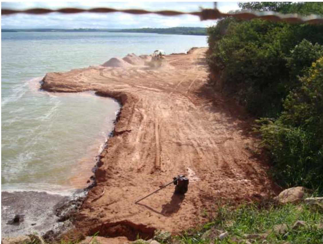
Foto 13 – Aterro hidráulico na ombreira esquerda. (13/05/2010)-
