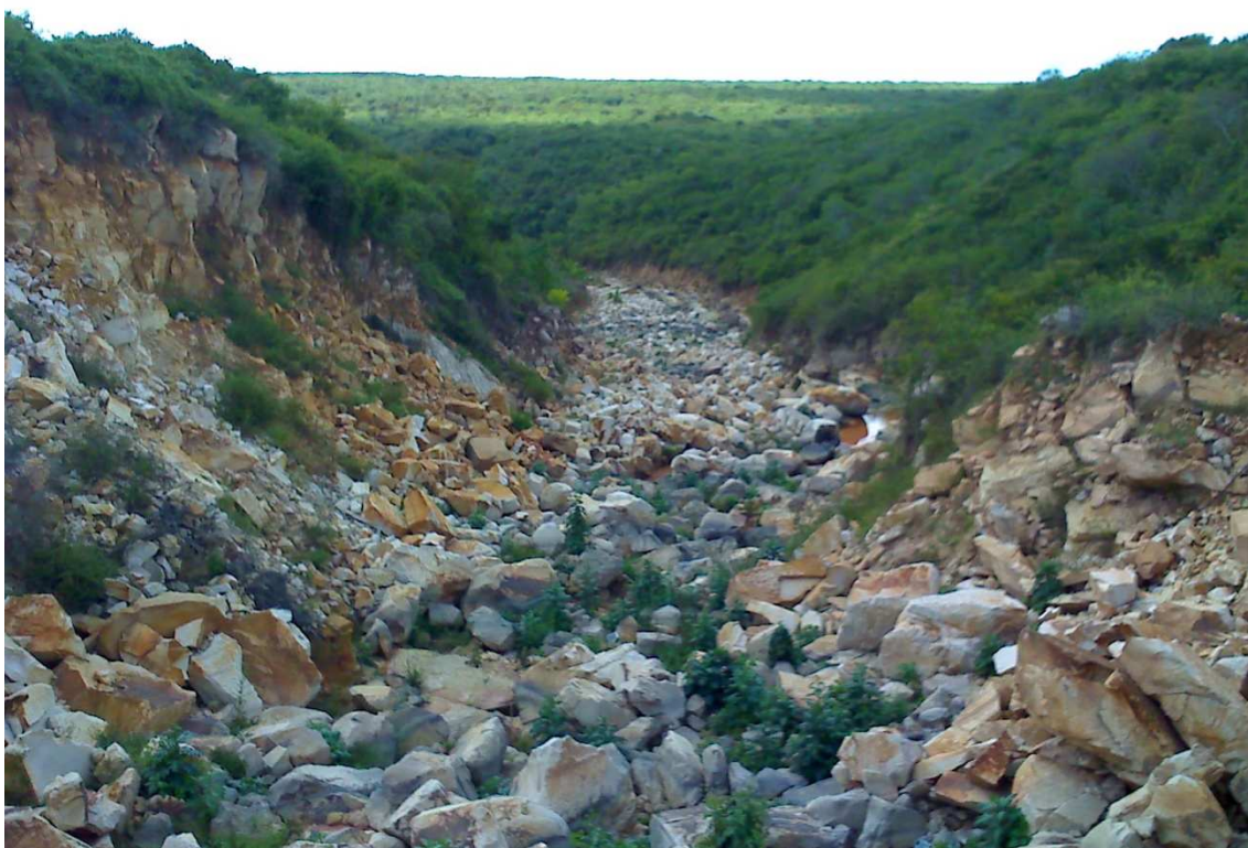
Foto 5 – Vista do Canal de Restituição do sangradouro. (25/03/2010)
