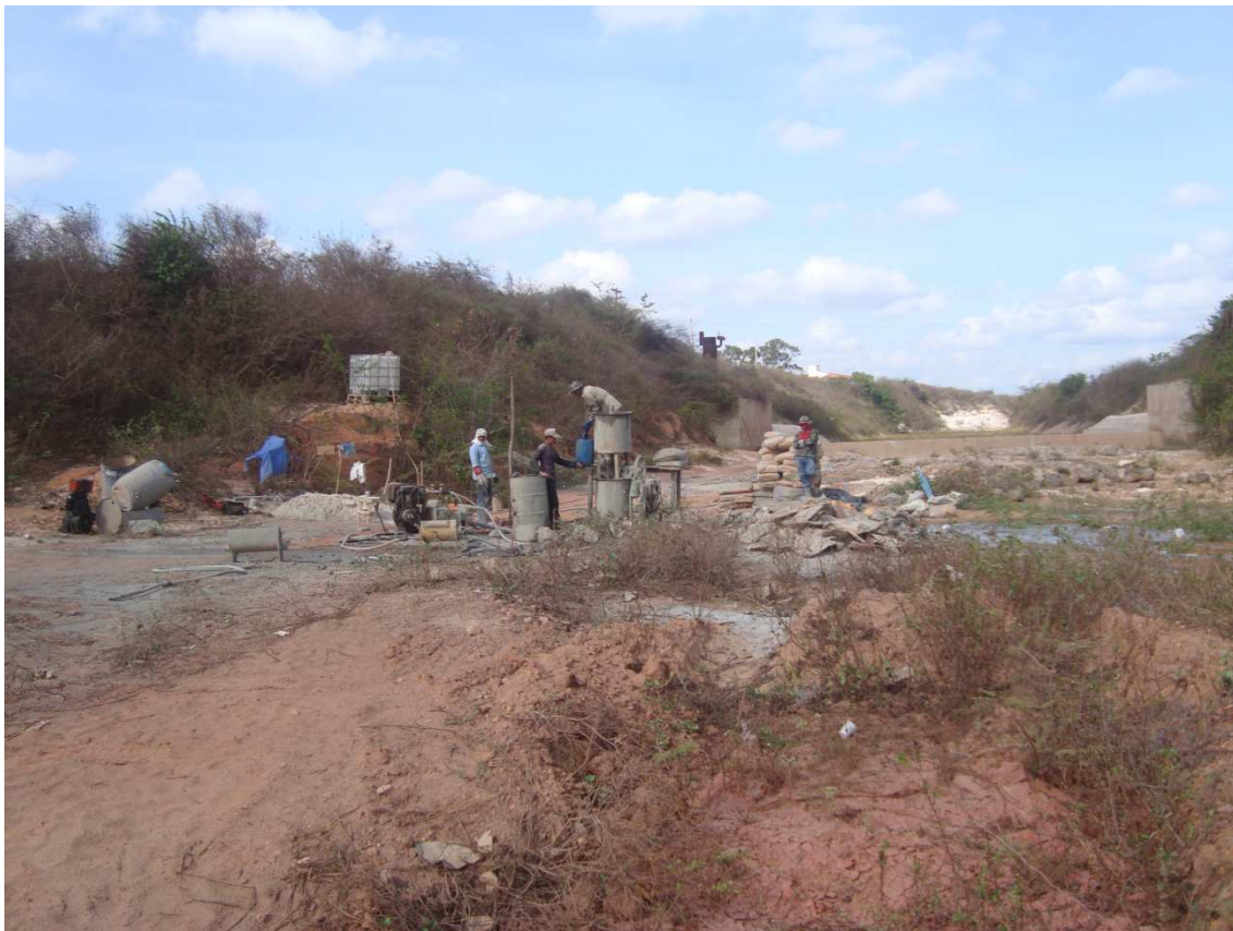
Foto 100 – Injeção de cimento nos furos de sondagem do sangradouro. (28/10/2010)
