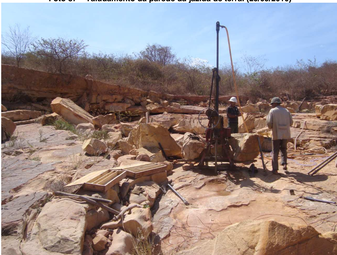
Foto 88 – Execução de sondagem rotativa no canal de restituição no sangradouro . (29/09/2010)
