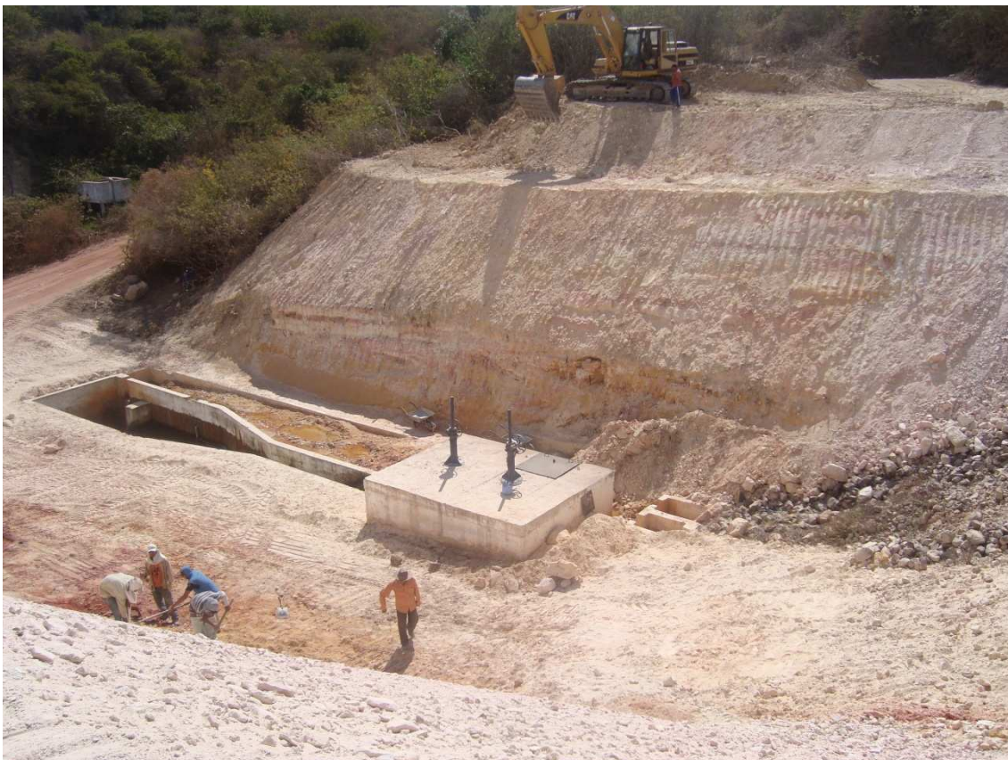
Foto 75 – Taludamento da ombreira direita da Tomada D'água. (02/09/2010)
