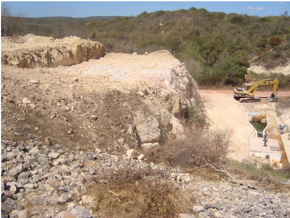
Foto 66 – Taludamento das ombreiras da Tomada D'água. (17/08/2010)
