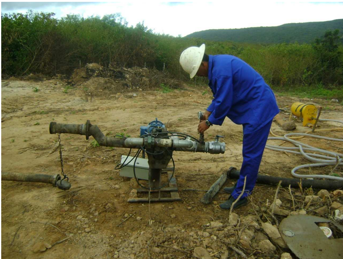
Foto 35 – Moto-bomba, para injeção de asfalto nos furos de sondagem. (24/06/2010)
