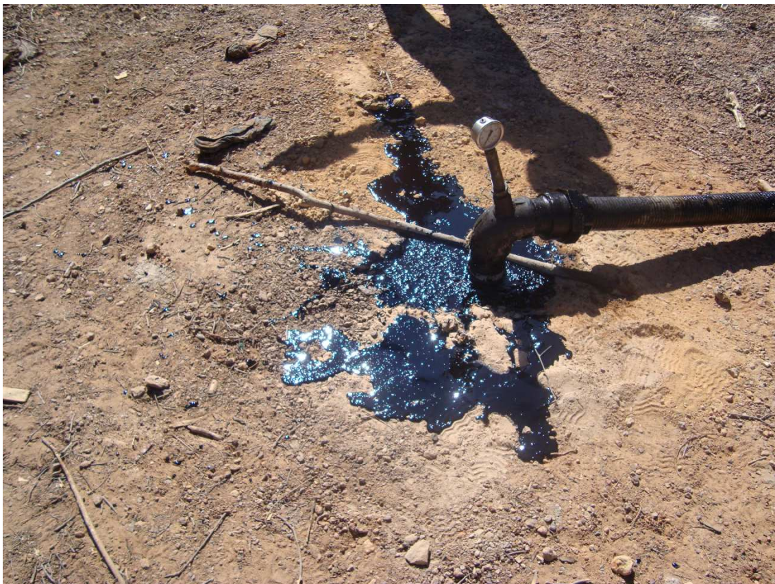
Foto 57 – Furo de sondagem, após injeção de asfalto. (30/07/2010)
