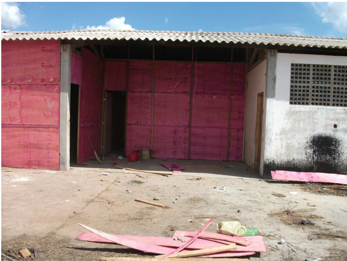
Foto 3 – Construção de depósito para armazenamento de material. (03/2010)
