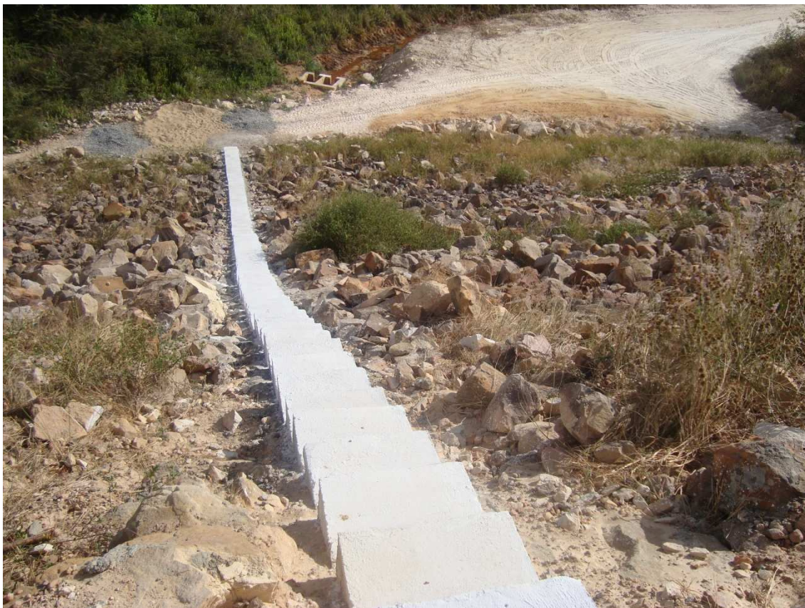
Foto 79 – Escada de acesso no talude jusante. (02/09/2010)
