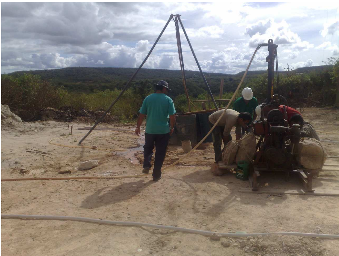
Foto 27 – Execução de Sondagem Rotativa na ombreira esquerda. (19/06/2010)
