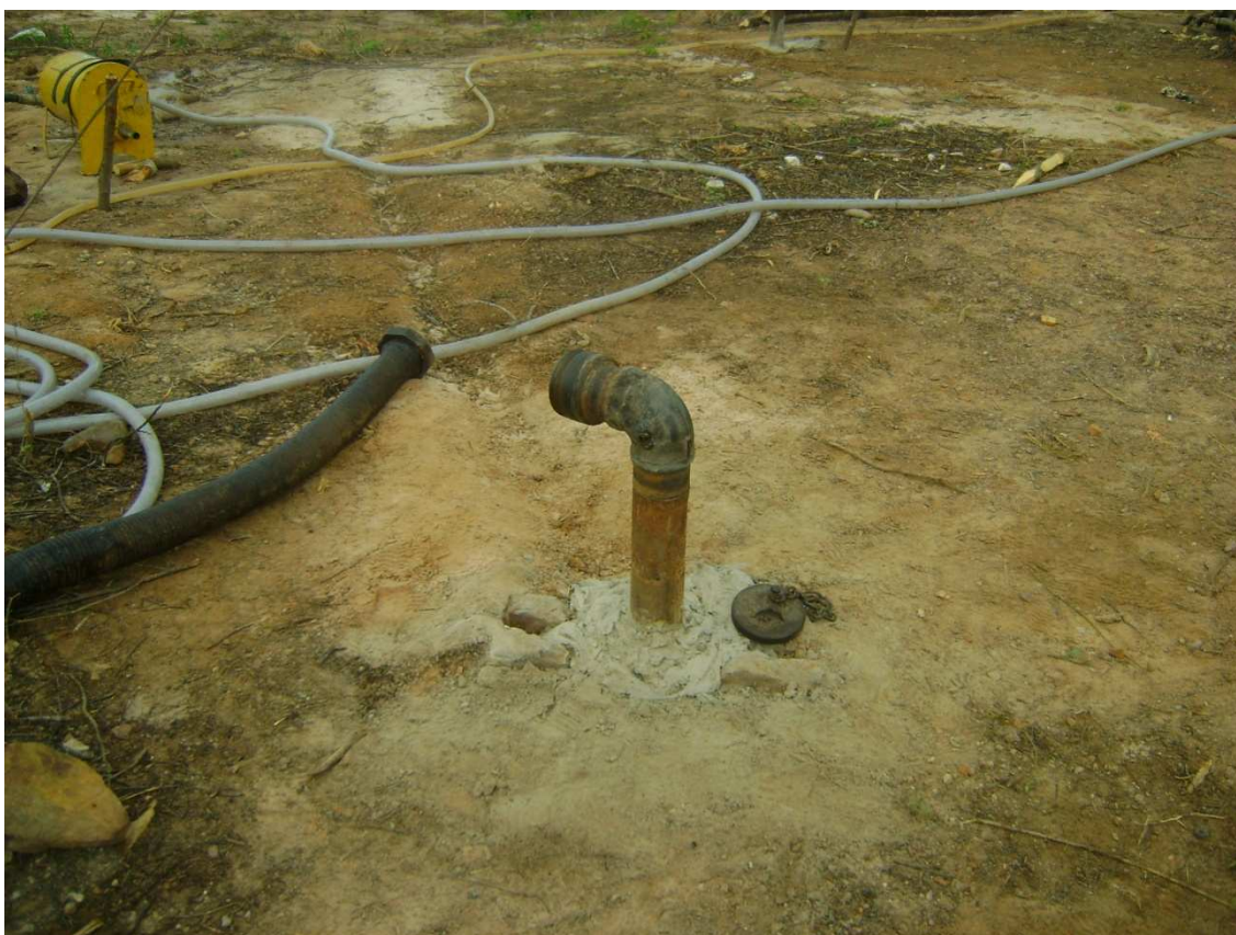
Foto 34 – Engate da mangueira para injeção de asfalto nos furos. (24/06/2010)
