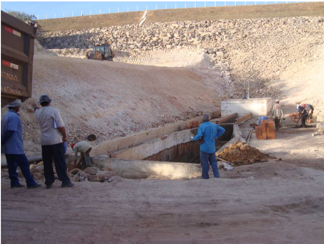
Foto 90 – Reforma na estrutura da Tomada D'água. (29/09/2010)
