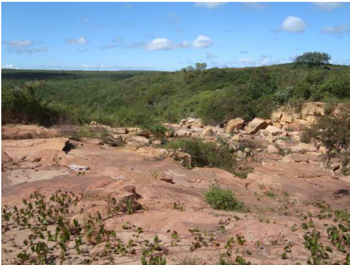
Foto 25 – Vista do sangradouro, à jusante da passagem molhada. (27/05/2010)
