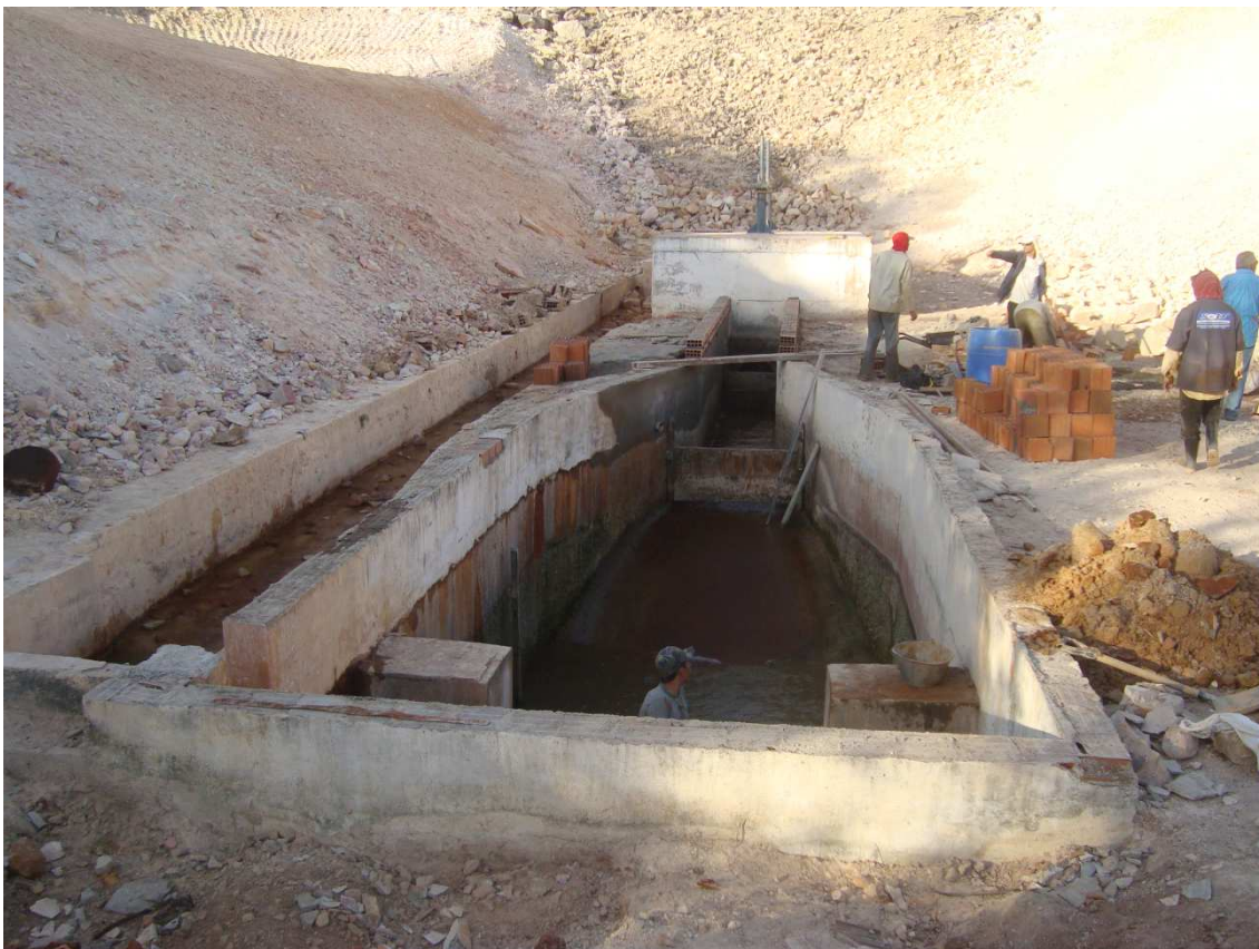
Foto 89 – Reforma na estrutura da Tomada D'água. (29/09/2010)
