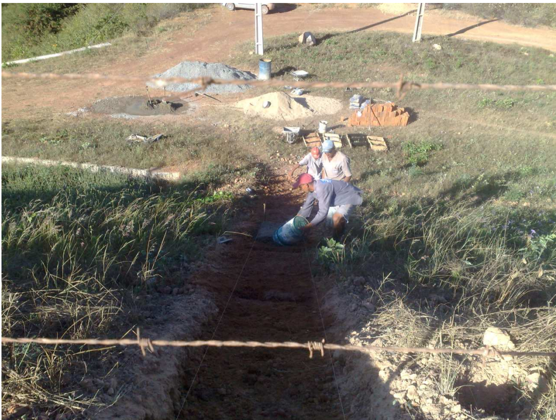
Foto 47 – Construção de escada de acesso no talude jusante. (22/07/2010)
