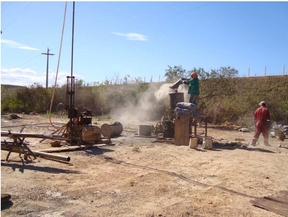
Foto 50 – Injeção de cimento em furo de sondagem. (30/07/2010)
