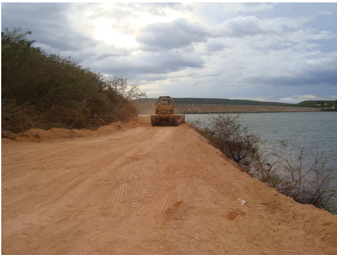
Foto 8 – Vista do barramento a partir do aterro hidráulico. (08/04/2010)
