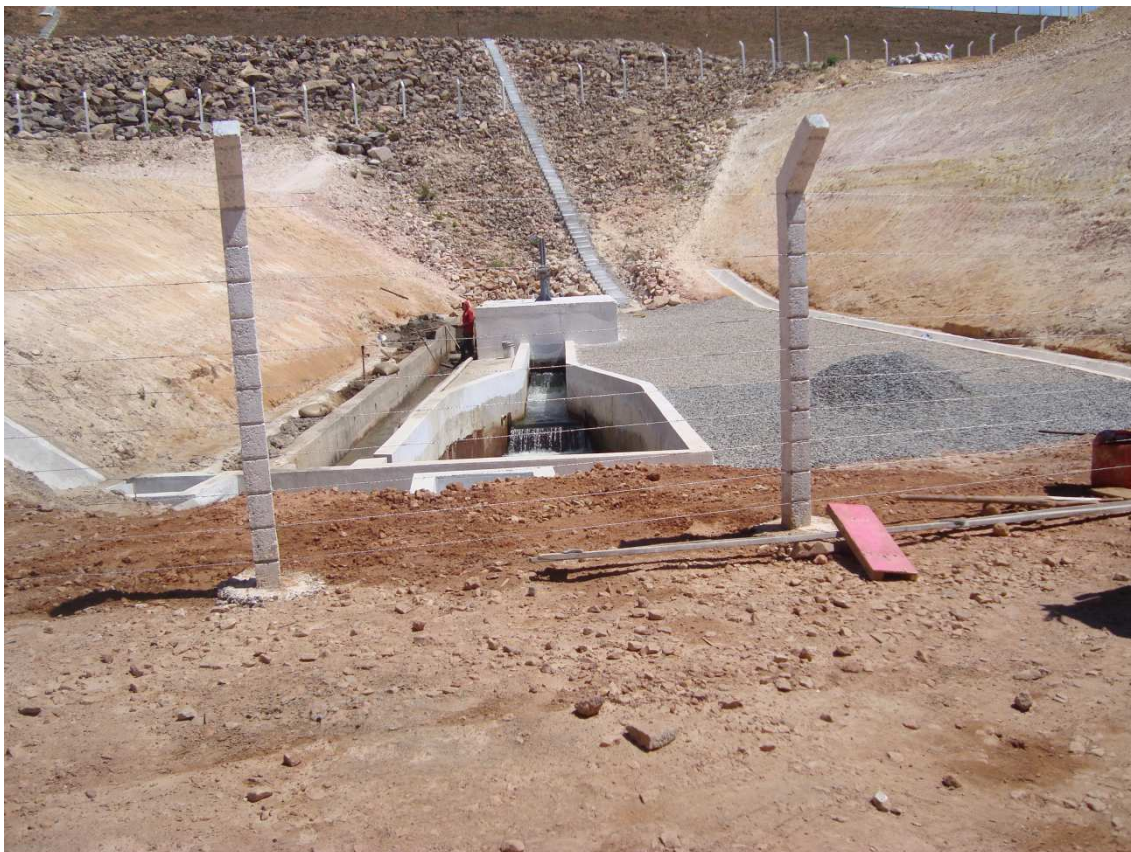
Foto 105 – Cerca de proteção colocada na região da Tomada D'água. (02/12/2010)
