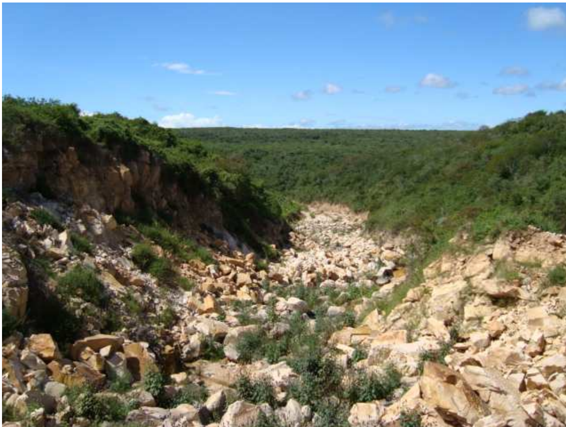
Foto 26 – Vista Geral do Canal de Restituição do Sangradouro. (27/05/2010)
