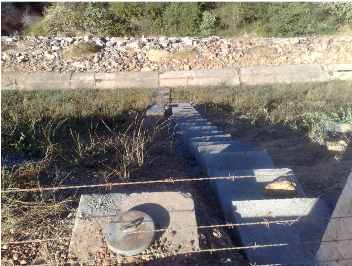
Foto 48 – Escada de acesso no talude jusante. (22/07/2010)
