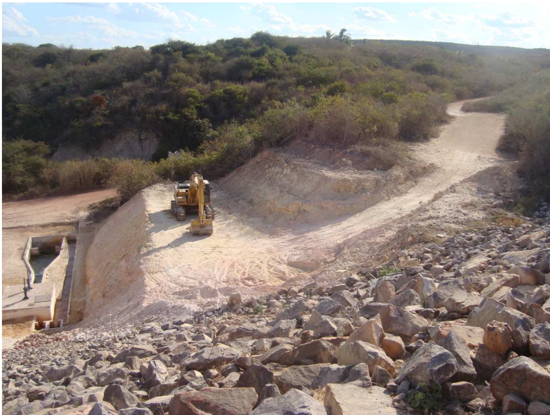
Foto 84 – Taludamento da ombreira direita da Tomada D'água. (15/09/2010)
