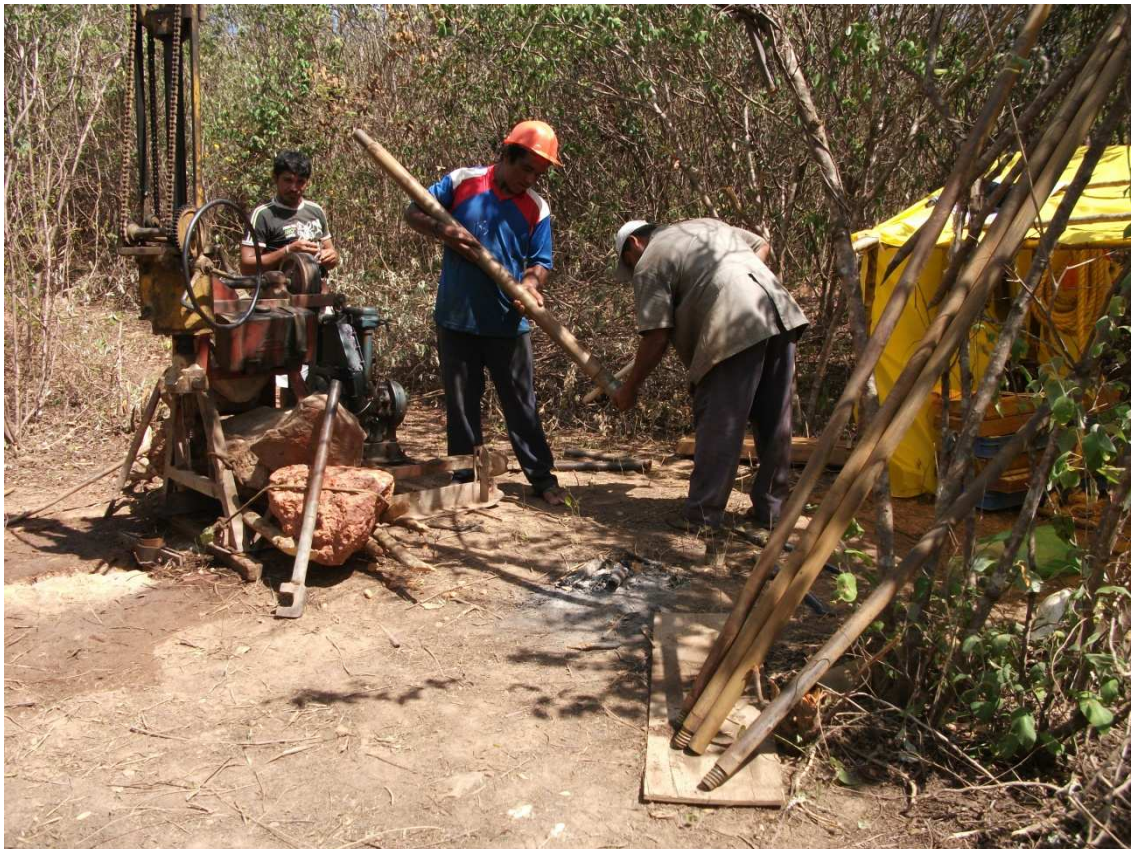
Foto 2 – Montagem de equipamento para execução e sondagem rotativa. (03/2010)
