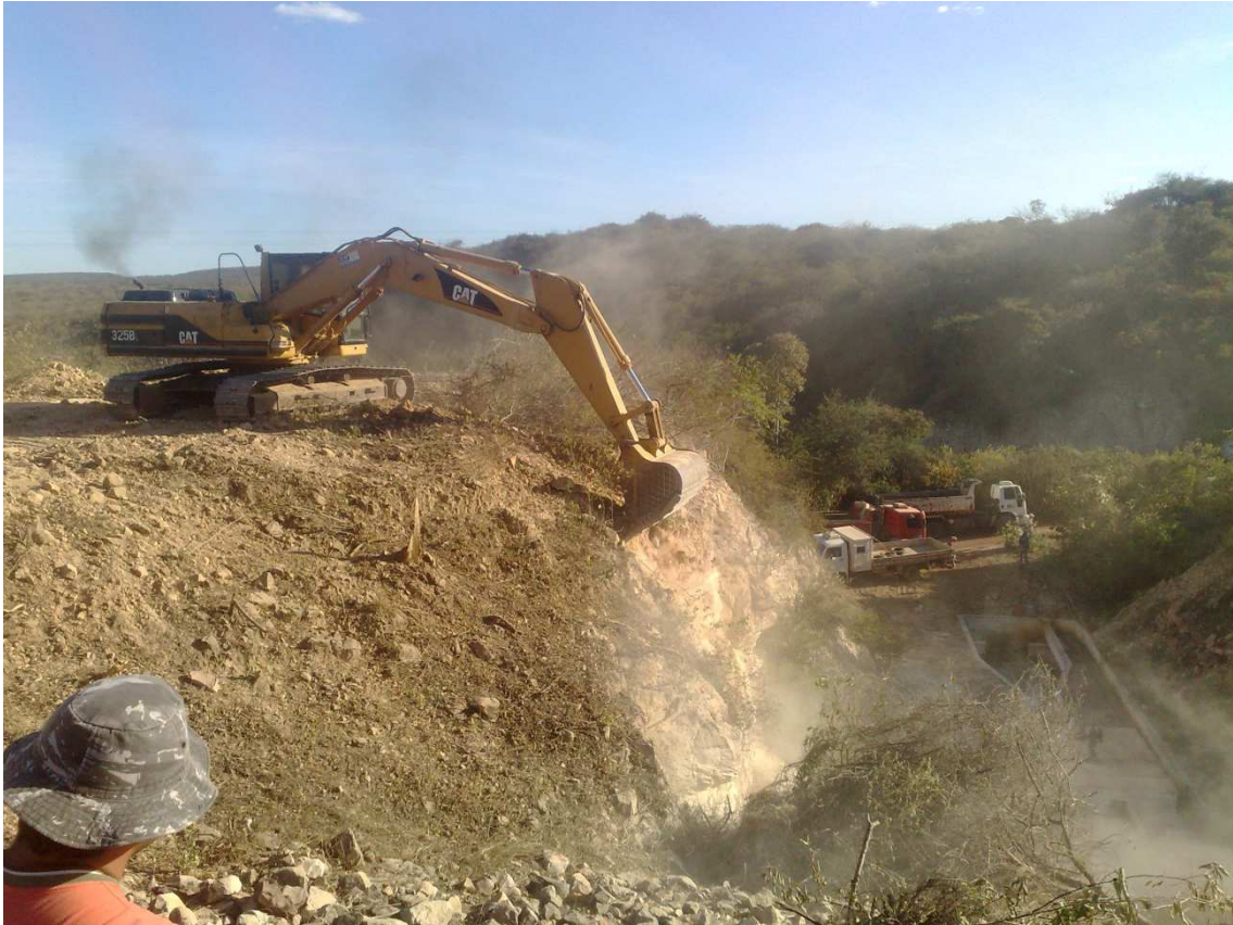
Foto 61 – Taludamento da ombreira esquerda da Tomada D'água. (05/08/2010)
