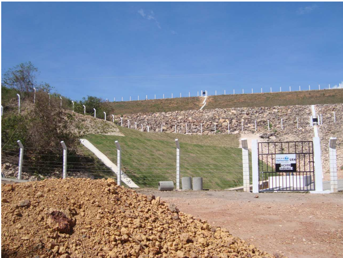
Foto 112 – Grama colocada para proteção do talude direito. (22/12/2010)
