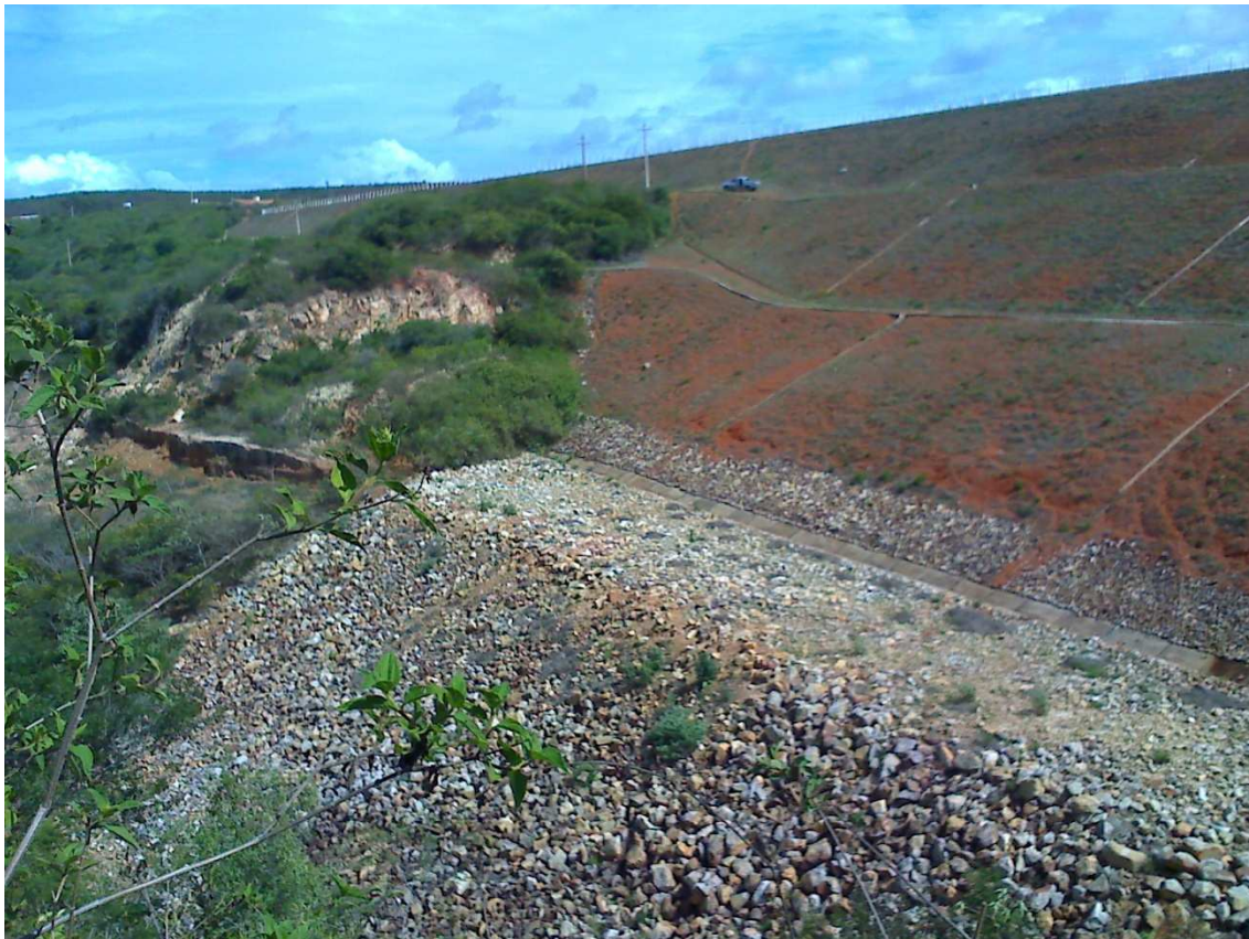
Foto 4 – Vista geral do barramento a partir da ombreira esquerda. (25/03/2010)
