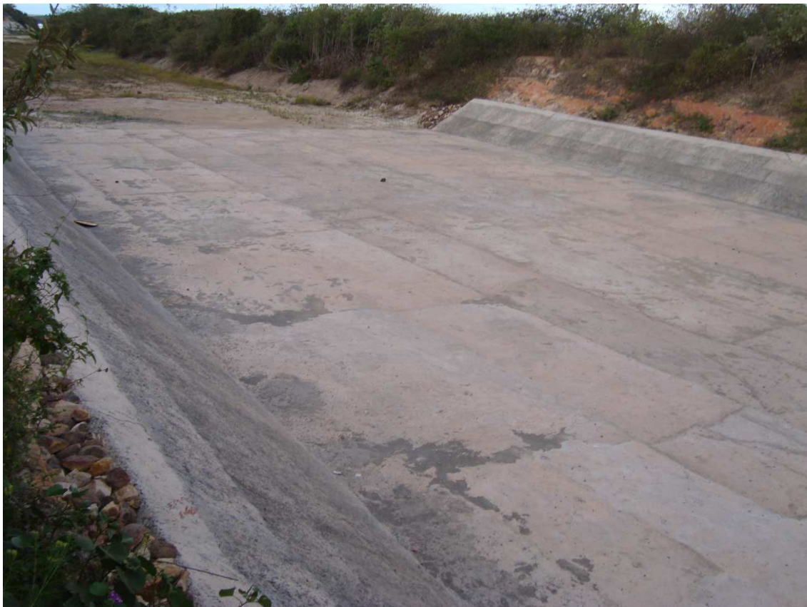
Foto 46 – Laje recém-construída à montante do Perfil Creager. (08/07/2010)
