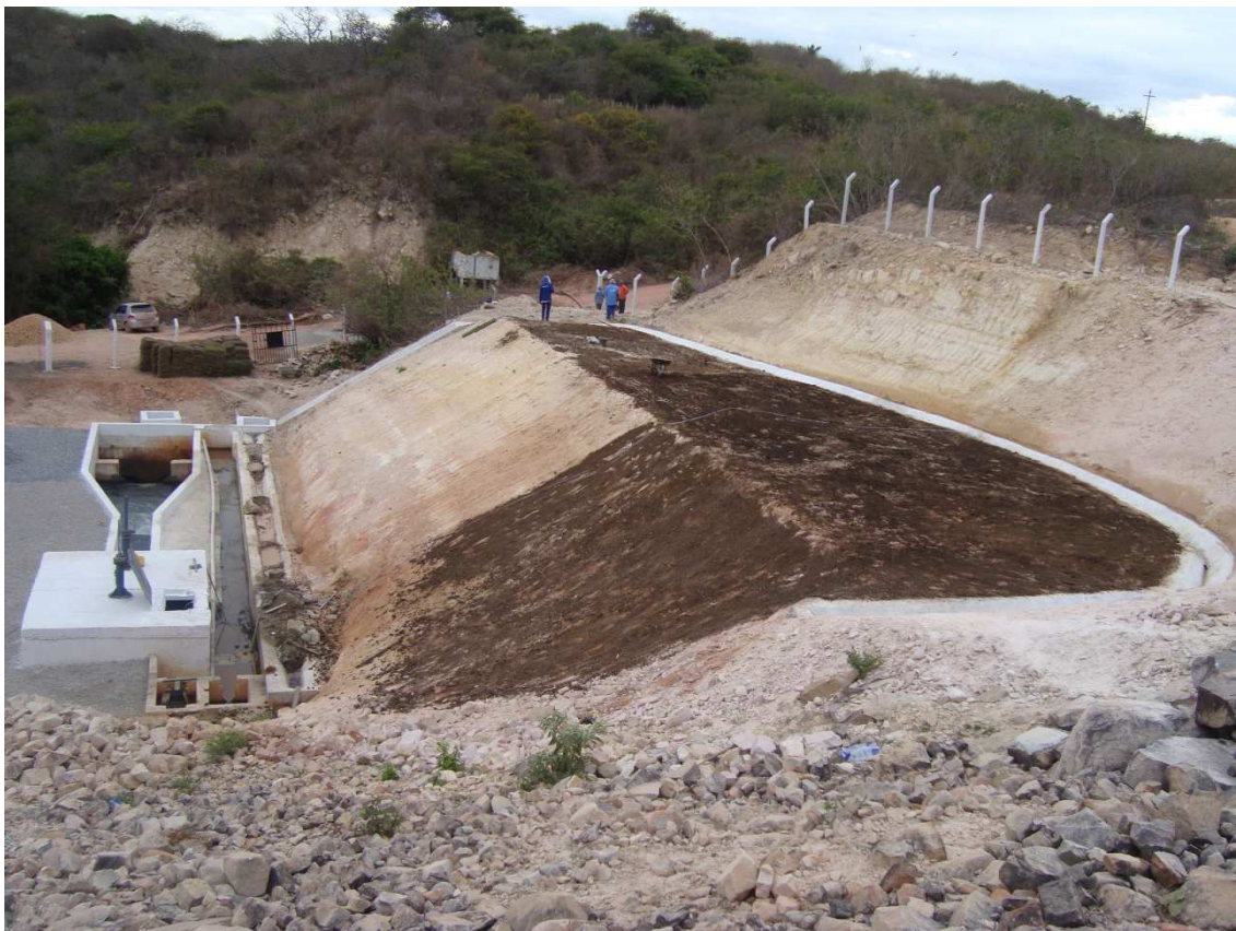
Foto 109 – Preparação do terreno para colocação de grama. (02/12/2010)
