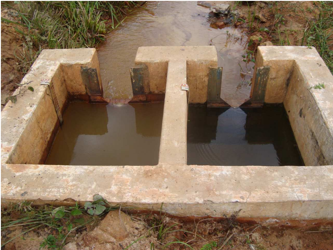
Foto 42 – Medidores de Vazão 06 e 07 dias após a injeção de asfalto. (08/07/2010)
