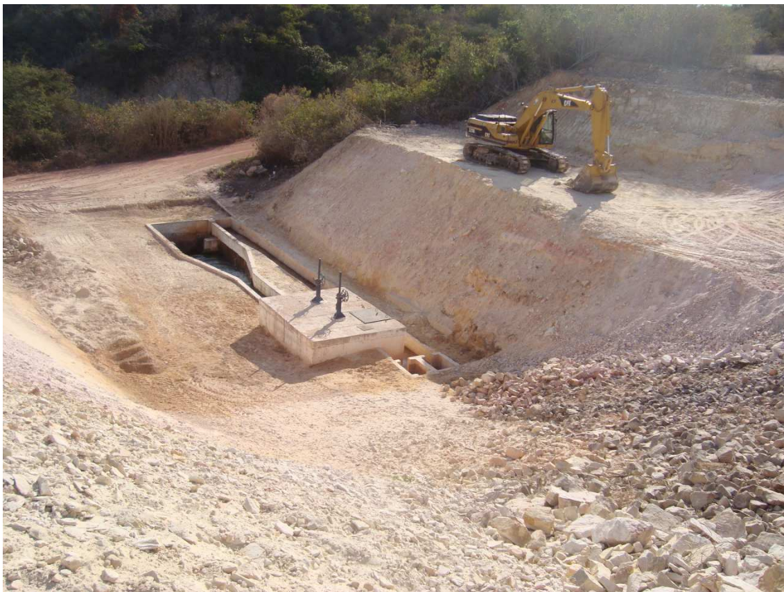
Foto 85 – Taludamento da ombreira direita da Tomada D'água. (02/09/2010)
