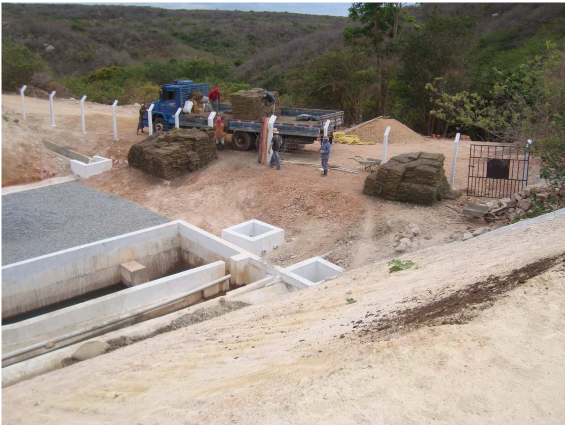
Foto 108 – Carregamento de grama para proteção dos taludes. (02/12/2010)
