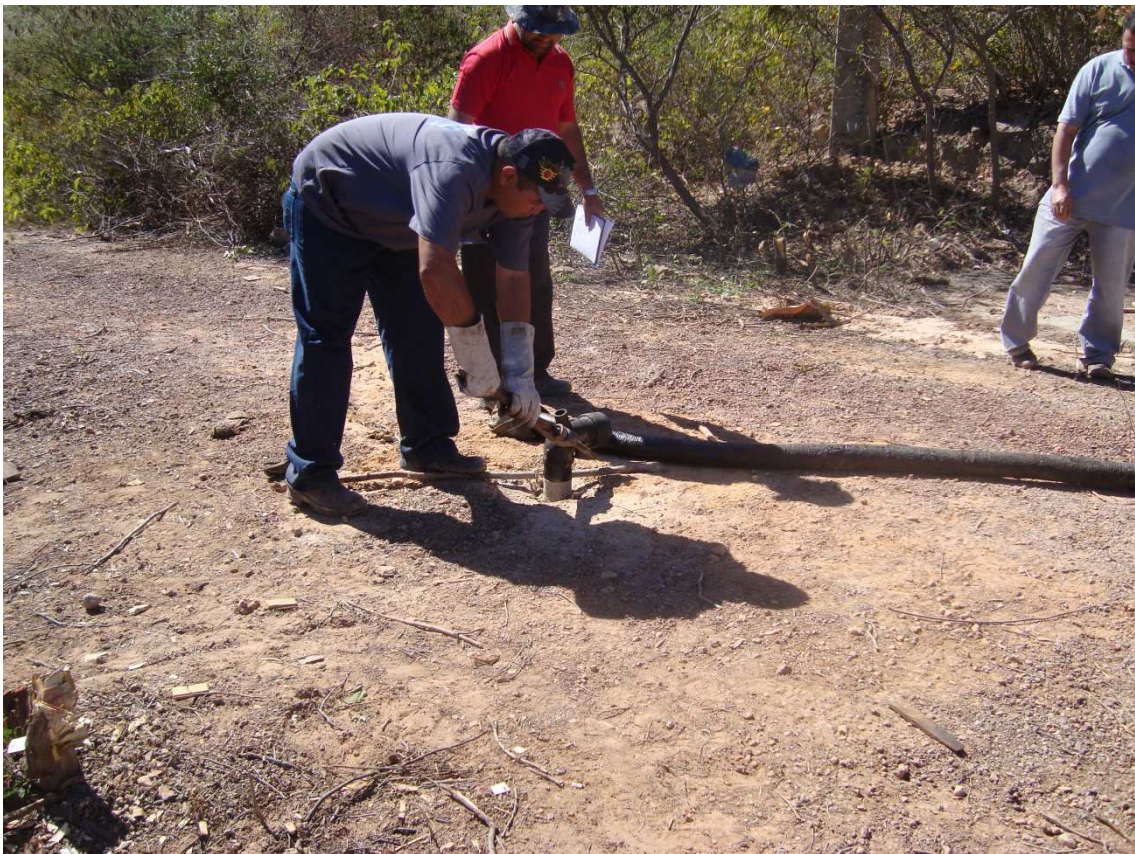
Foto 56 – Engate da mangueira, para injeção de asfalto nos furos. (30/07/2010)
