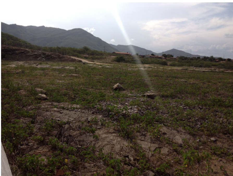
Foto 2 - Vista da calha do vertedouro à jusante (canal de restituição), (02/02/2015).
