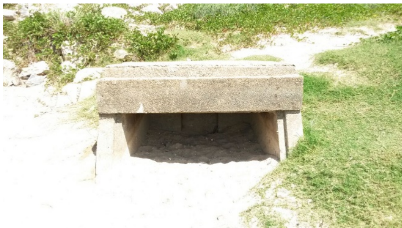
Foto 8 - Tomada d'água (montante).
