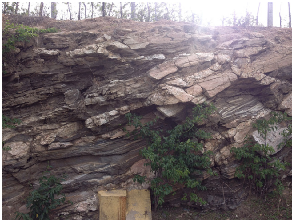
Foto 4 - Vista do encontro do vertedouro com a parede do maciço (02/02/2015).
