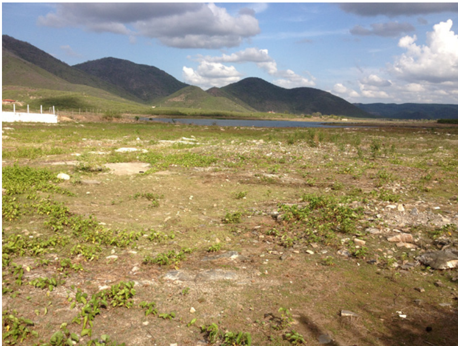
Foto 3 - Vista da calha do vertedouro à montante (canal de aproximação), (02/02/2015).
