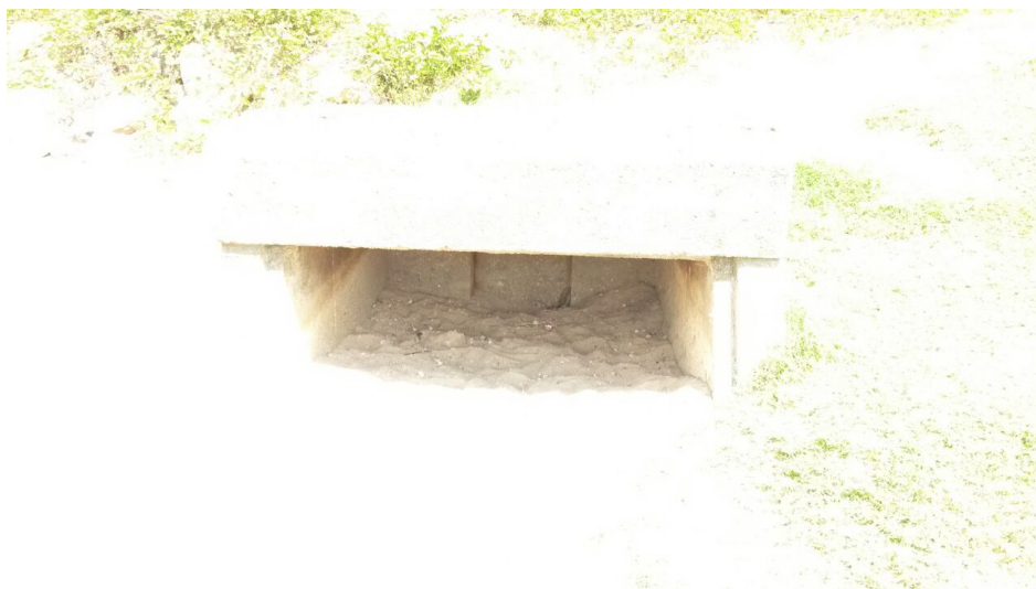
Foto 20 – Aspecto atual da Infraestrutura implantada (Sangradouro).
