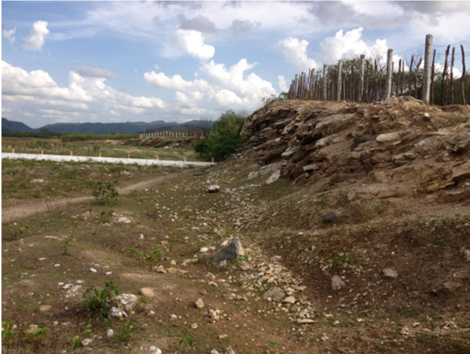
Foto 5 - Vista de jusante do encontro do vertedouro com a parede do maciço (02/02/2015).
