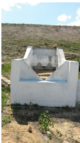
Foto 9 - Tomada d'água (jusante).
