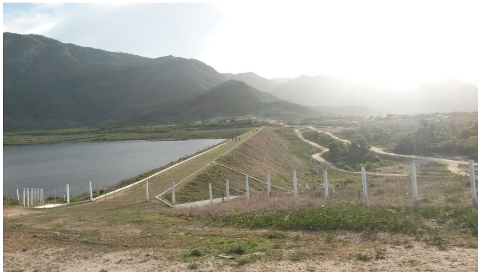
Foto 17 – Vista geral da Barragem de Itapebussu.
