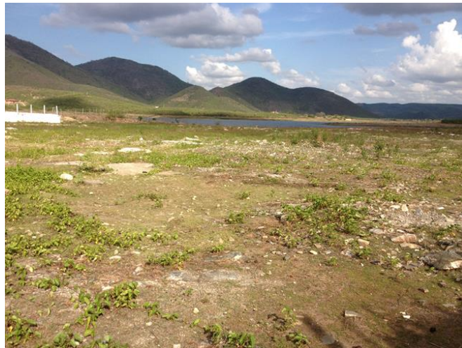
Figura 4 – Vista da calha do vertedouro à montante (canal de aproximação) em 02/02/2015.
