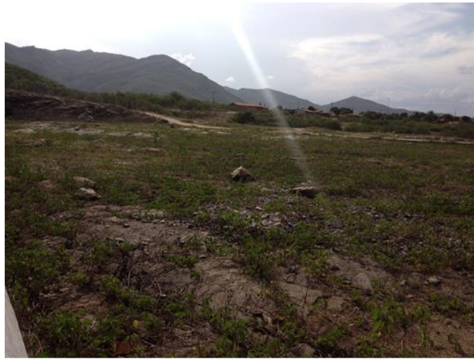
Figura 3 – Vista da calha do vertedouro à jusante (canal de restituição) em 02/02/2015.
