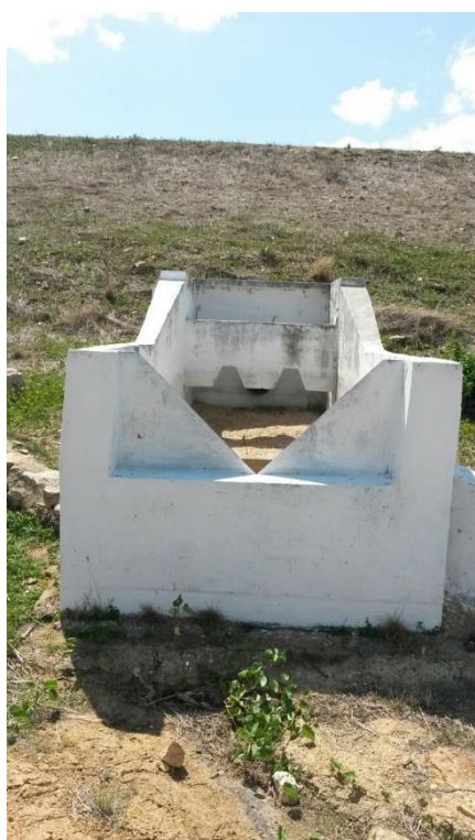
Figura 7 – Tomada d'água (jusante)
