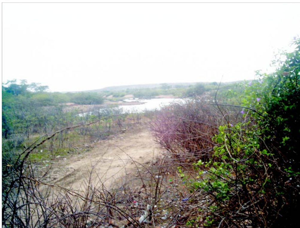
Lagoas marginais e berçários a montante da barragem
