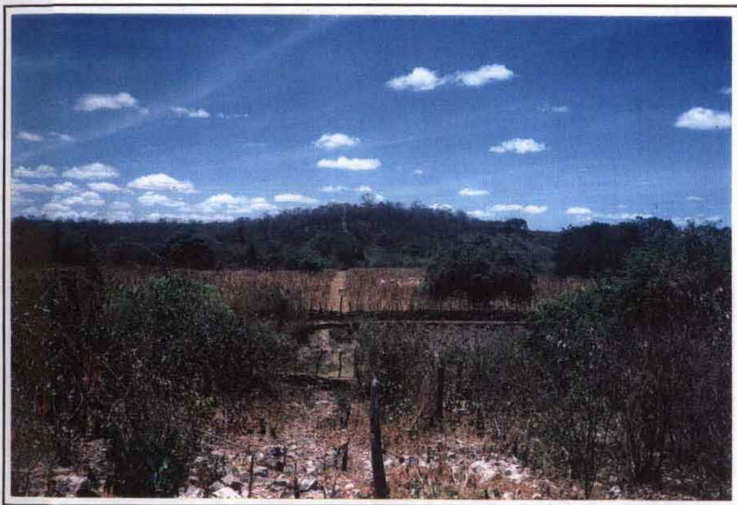
FOTO 8 - Vista da ombreira direita (foto tirada da ombreira esquerda).
