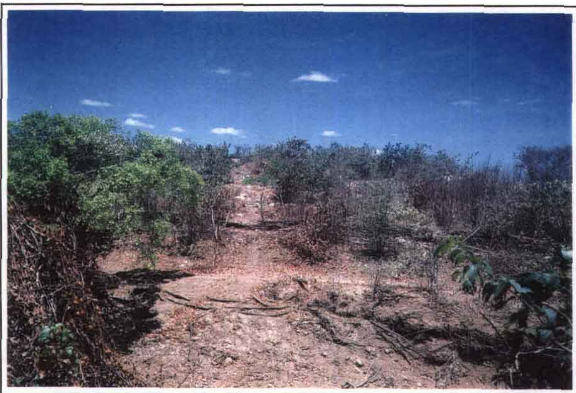
FOTO 5 - Detalhe da ombreira esquerda.
