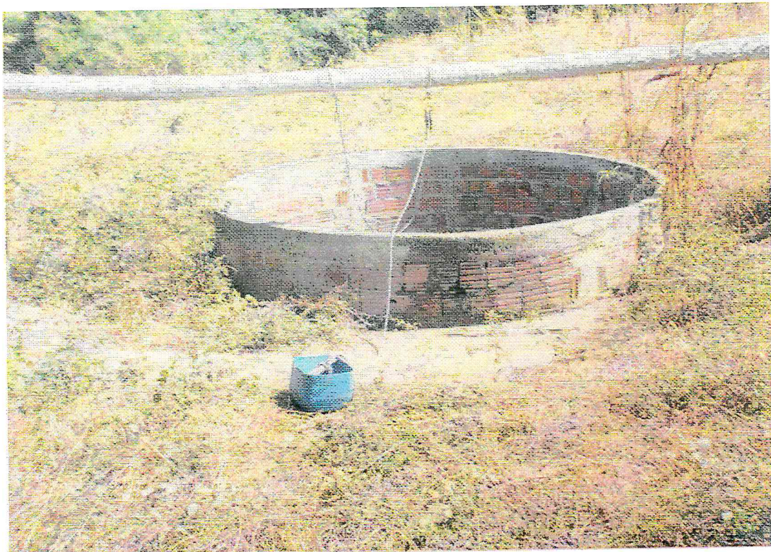
FOTO N° 06 – Vista da cacimba situado a cerca de 400m a montante do eixo, na zona aluvionar da calha do rio, onde observa-se a ocorrência de rocha alterada com 6,00m de profundidade.
