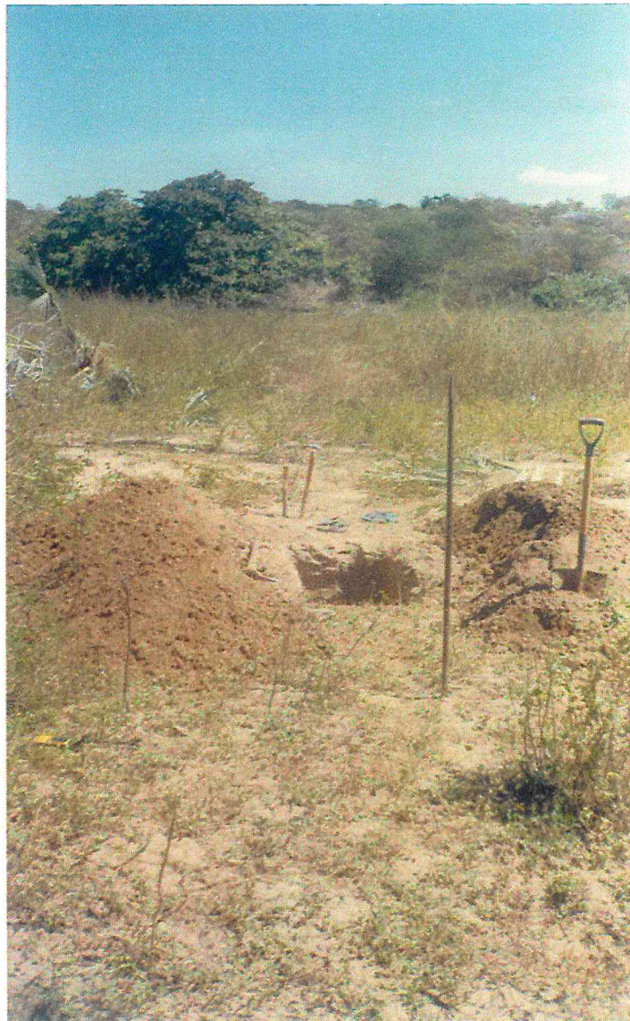
FOTO N° 01 – Foto do poço da sondagem SPP-04, realizada na zona aluvionar da calha do rio, onde com 3,10 alcançou-se o lençol freático.
