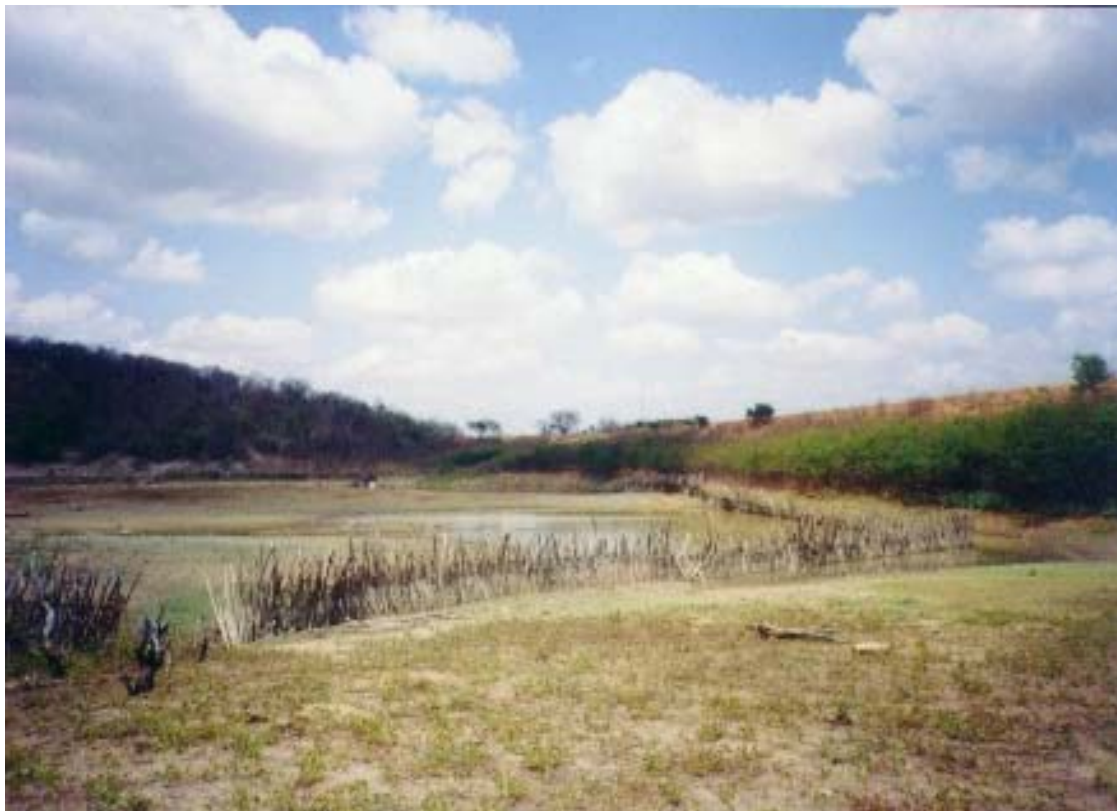
FOTO 08 - Açude público da prefeitura (Boa Água – Morada Nova) (Açude quase seco / E. B. Flutuante - Reservatório Apoiado)
