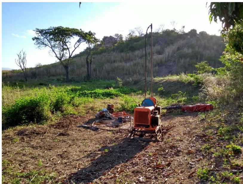
Figura 2.26 - Cobertura Sedimentar no Eixo, formada por solos de Alteração das Ardósias
