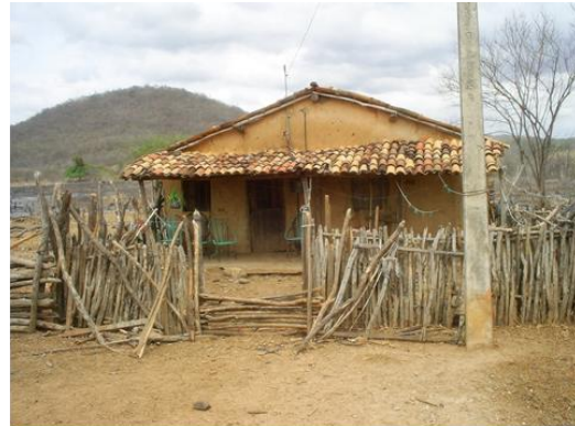
Foto 12 - Rede elétrica de baixa tensão que atende os imóveis da área da bacia hidráulica do futuro reservatório (E-303.021; N-9.579.283).
