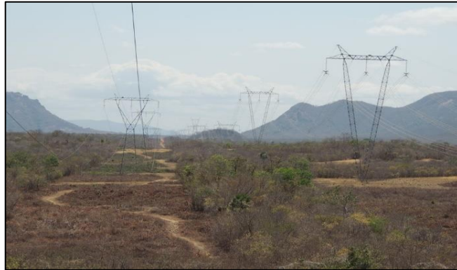
Foto 13 - Linhas de alta tensão da CHESF que interceptam a bacia hidráulica do futuro reservatório em seu trecho mais a montante (E-301.661; N-9.576.553).
