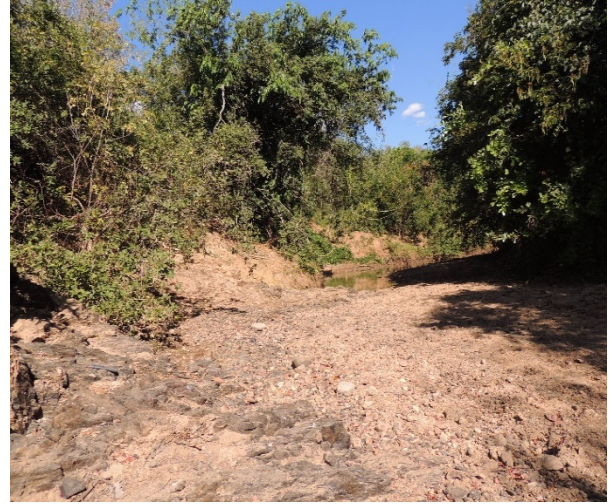
Foto 4.5.25 - Pt. 07- Afloramento de ardósia na margem direita – foto na direção de jusante para montante (E=302.284; N=9.581.842).
