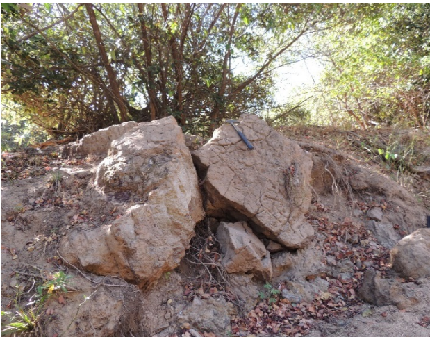
Foto 4.5.26 - Pt. 09- Na margem esquerda, blocos deslocados de siltio/argilito, apresentando estruturas de contração (gretas) (E=302.283; N=9.581.771).
