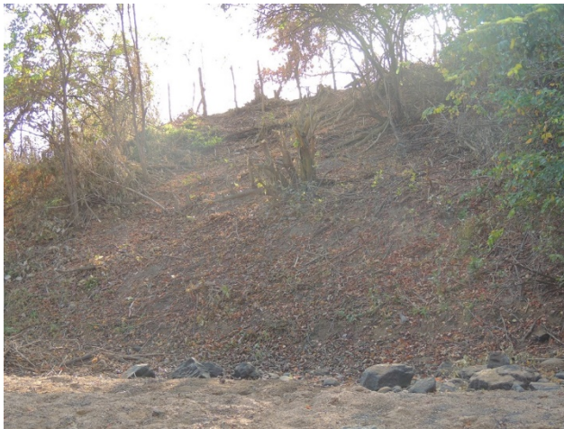
Foto 4.5.18 - Pt. 03- Margem direita na interseção com eixo 1 (Est.16+0,00) barranco, com 6,0m de altura, formado por colúvios (E=301.992; N=9.581.992).
