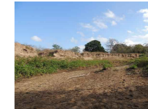
Pt. 04 - Barrancas na margem esquerda com 8m de altura e na margem direita suave inclinação.
