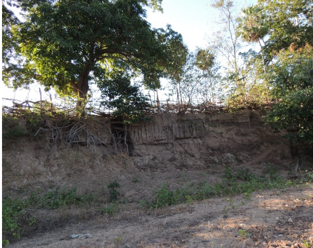
Foto 4.5.36 - Pt. 16-Vista para montante, na margem esquerda, barranca com cerca de 3,0m de altura (E=302.349; N=9.581.299).
