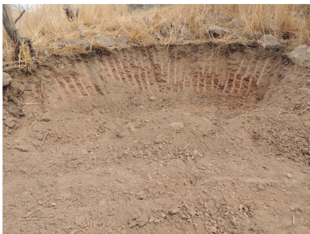
Foto 4.5.41 – Tálus sobreposto ao solo de alteração de ardósia - Est.29+00 (E=302.204; N=9.582.275).
