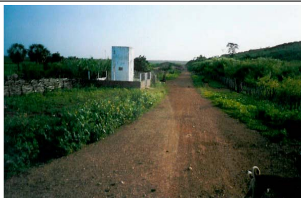
Foto 04/10 – Caixa d'água do chafariz existente nas margens da estrada Jardim/Açude Angicos na comunidade de Santana.
