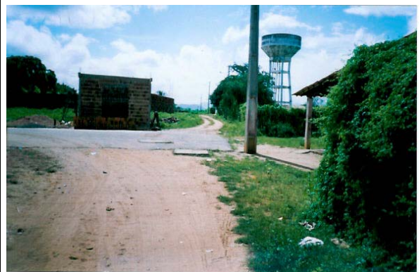
Foto 10/10 – Trecho final do traçado do sistema adutor, vendo-se em segundo plano o reservatório elevado existente que será integrado ao empreendimento.
