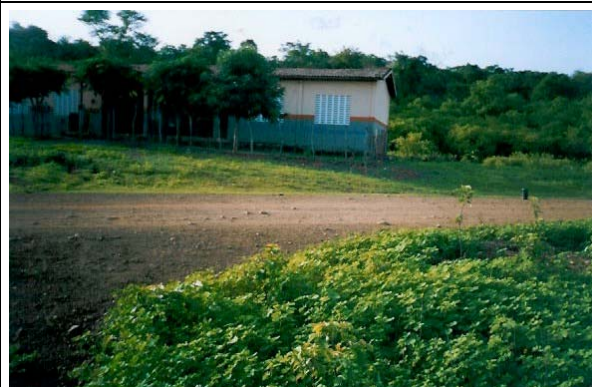
Foto 03/10 – Grupo escolar existente na área lindeira da estrada Jardim/Açude Angicos, em cuja faixa de domínio se desenvolve o traçado do sistema adutor.
