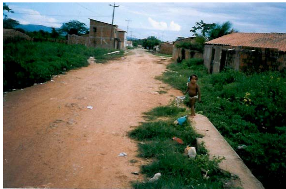
Foto 07/10 – Trecho em que o traçado do sistema adutor se desenvolve por ruas em leito natural na cidade de Frecheirinha. Observa-se o início do adensamento de habitações nas áreas lindeiras.
