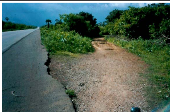
Foto 06/10 – Final do trecho em que a adutora se desenvolve na faixa de domínio da estrada vicinal que permite o acesso a localidade de Salgado. Vê-se a esquerda da foto o início do trecho que se desenvolve ao longo da BR-222.
