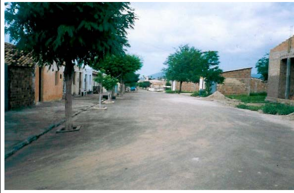
Foto 08/10 – Trecho onde o traçado do sistema adutor é feito ao longo de ruas pavimentadas da cidade de Frecheirinha.
