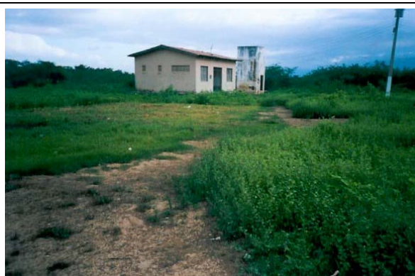
Foto 02/10 – Observa-se, em segundo plano, o posto de saúde e a caixa d'água do chafariz do povoado de Sítio Jardim.
