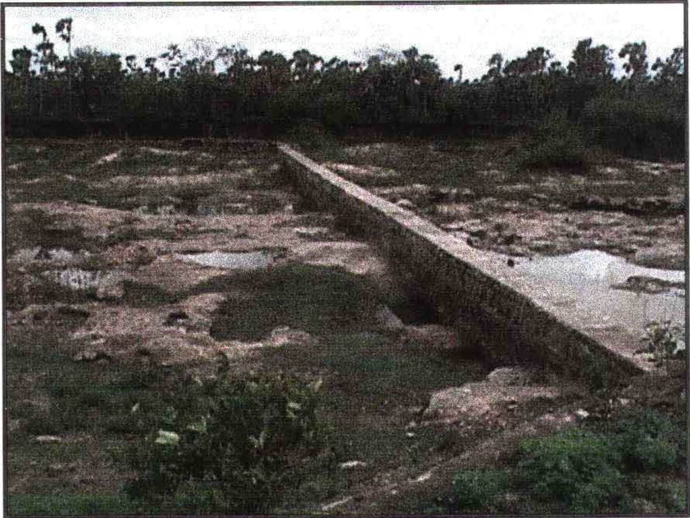
Foto nº 05: Barramento de alvenaria, situada a aprox. 200m a montante do eixo do projeto.
