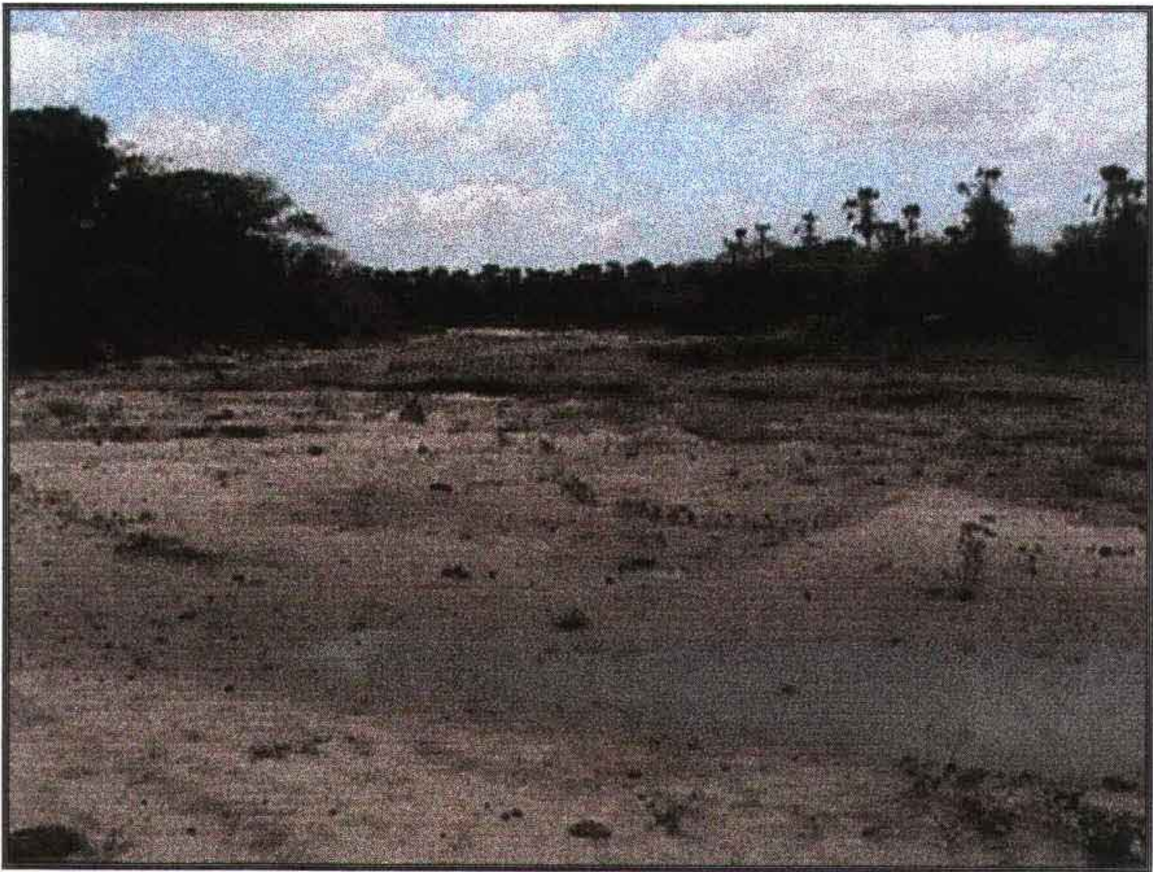
Foto nº 04: Leito do rio para jusante do eixo.
