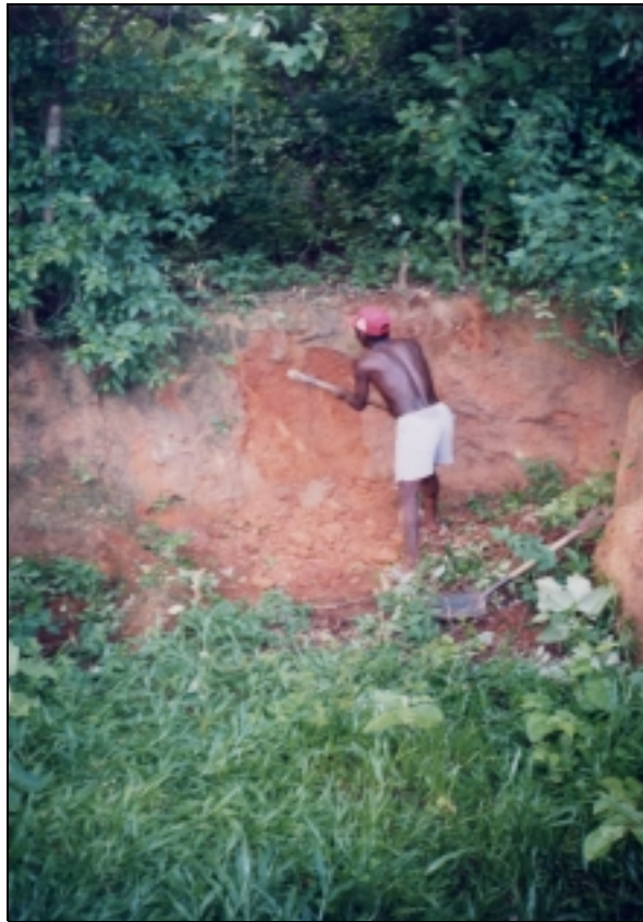
Foto 09/11 – Área da jazida de material terroso J-02, indicada como reserva, devido a sua distância do eixo barrável.
