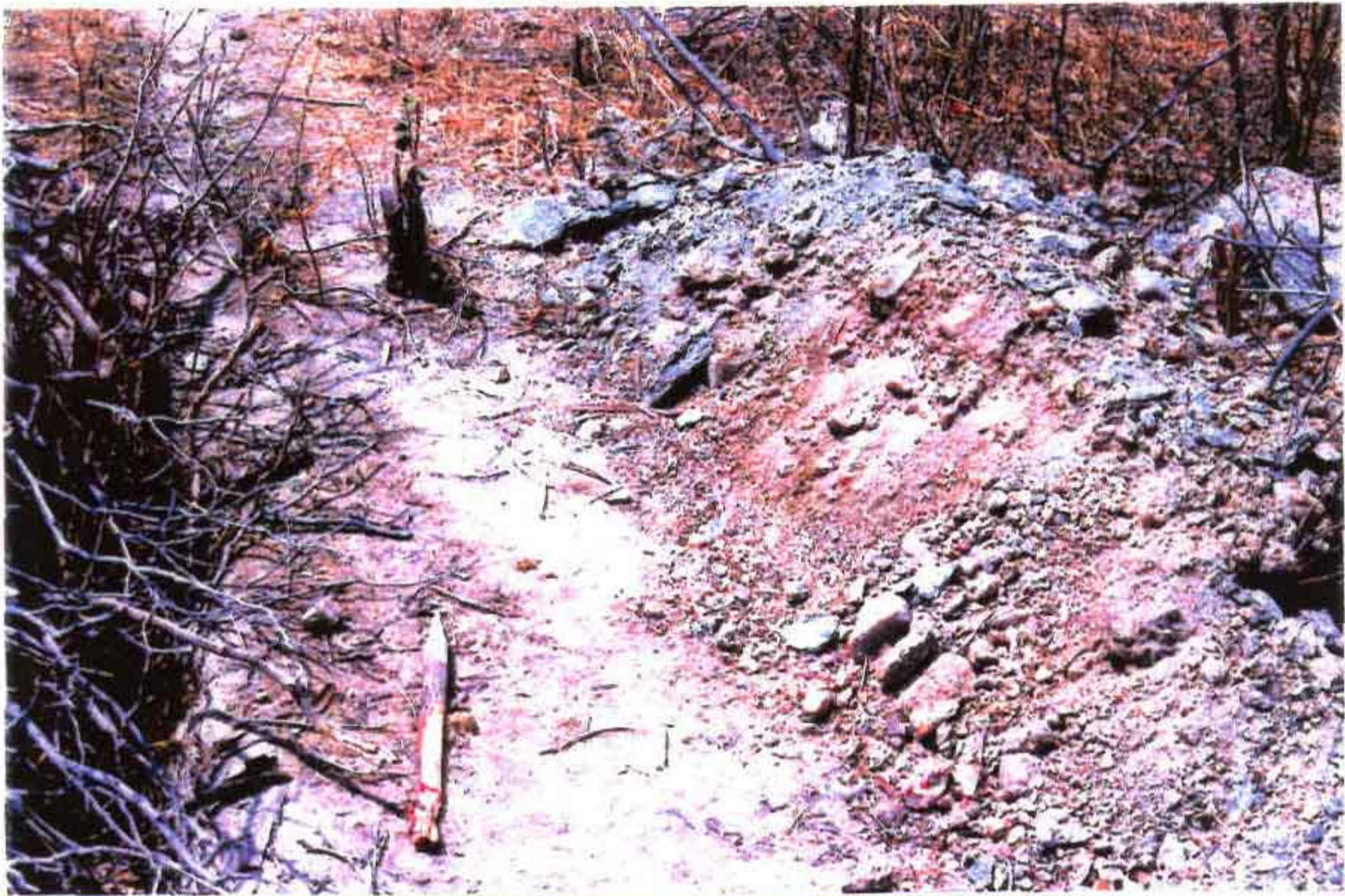
Material retirado de poço SSP, piquete 3 (Observa-se pequenos blocos de gnaiss alterado)
