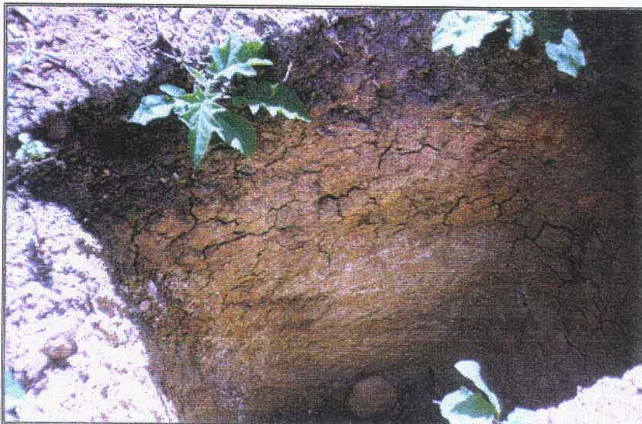
FOTO 6 - Poço escavado no eixo topográfico do barramento, onde é observado um solo argiloso, pouco moldável de relativa atividade, com níveis arenosos, de coloração amarelo amarronzado com textura média a fina - Grupo Barreiras
