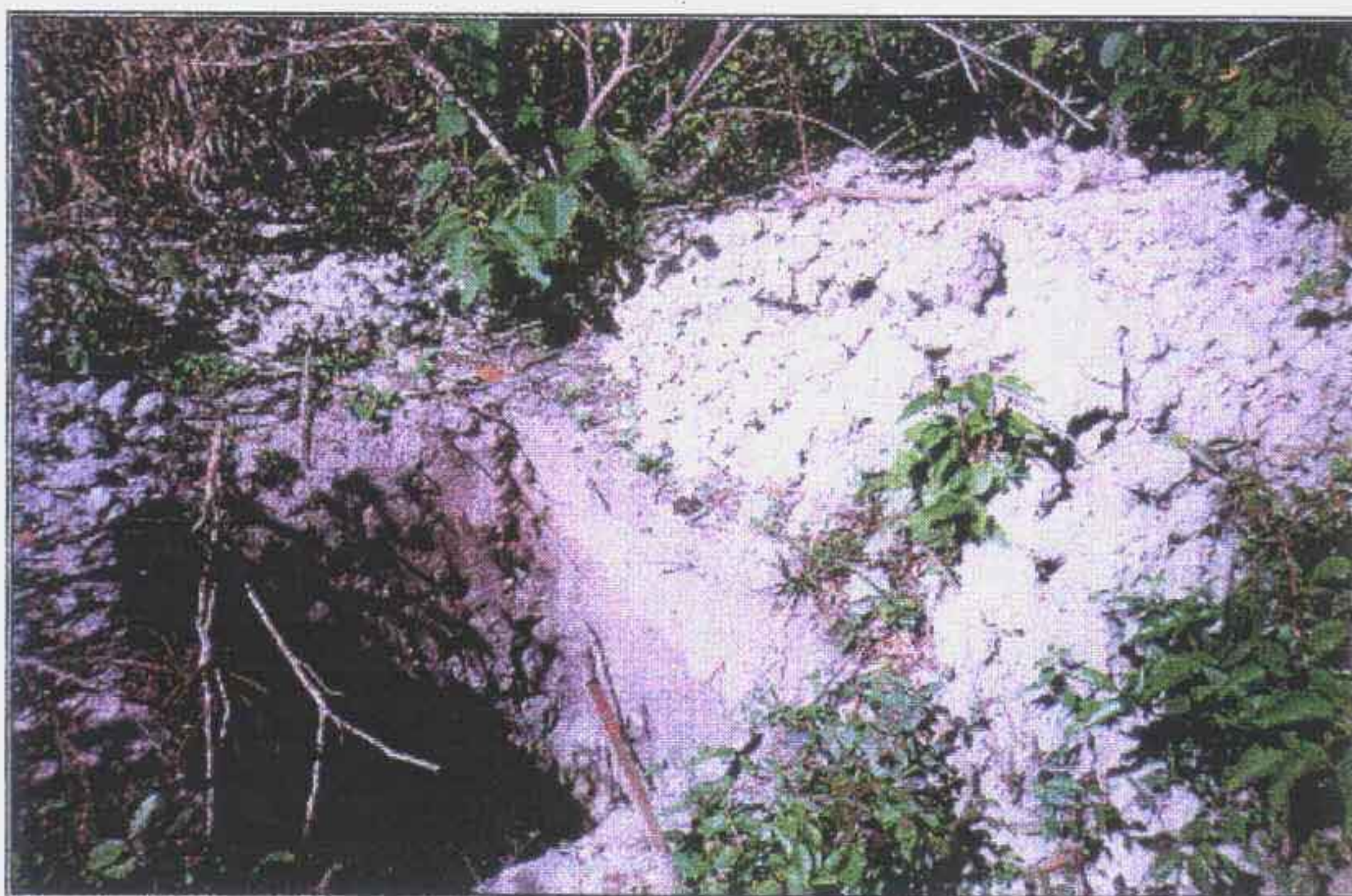
FOTO 5 - Poço escavado no trecho do eixo topográfico do barramento, onde observa-se uma cobertura de solo areno-argiloso de coloração branco e acinzentado, textura fina a média - Grupo Barreiras.
