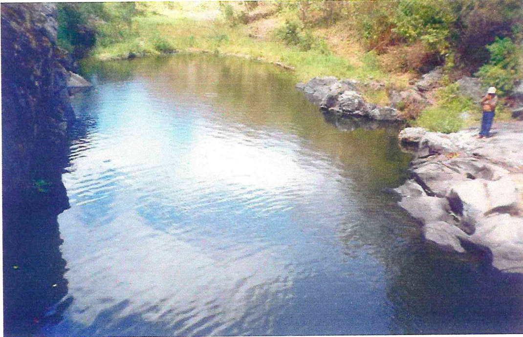
FOTO Nº 18 – LEITO DO RIACHO / BARRAGEM EXISTENTE P/ JUSANTE
