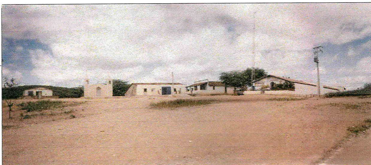
Foto 06/12 – Vista parcial do povoado de Bom Sucesso, o qual será beneficiado com abastecimento d'água regularizado.
