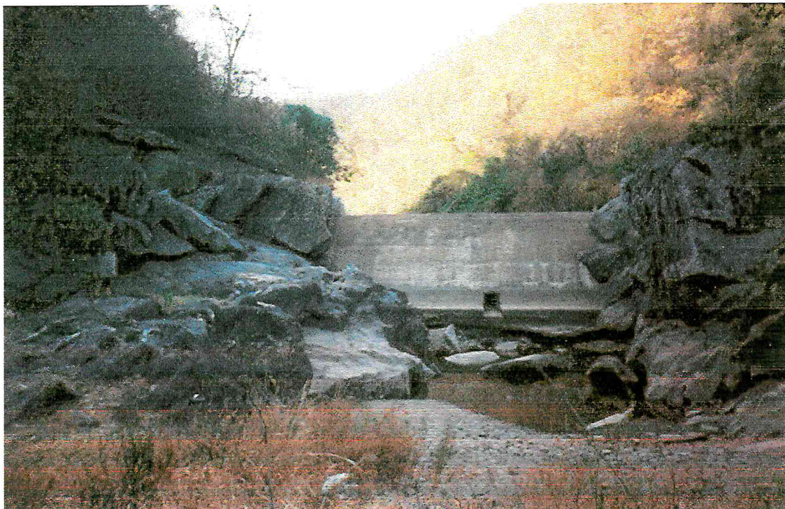
Foto 03/12 – Vista da barragem vertedoura que barra o riacho Jardim na área do empreendimento.
