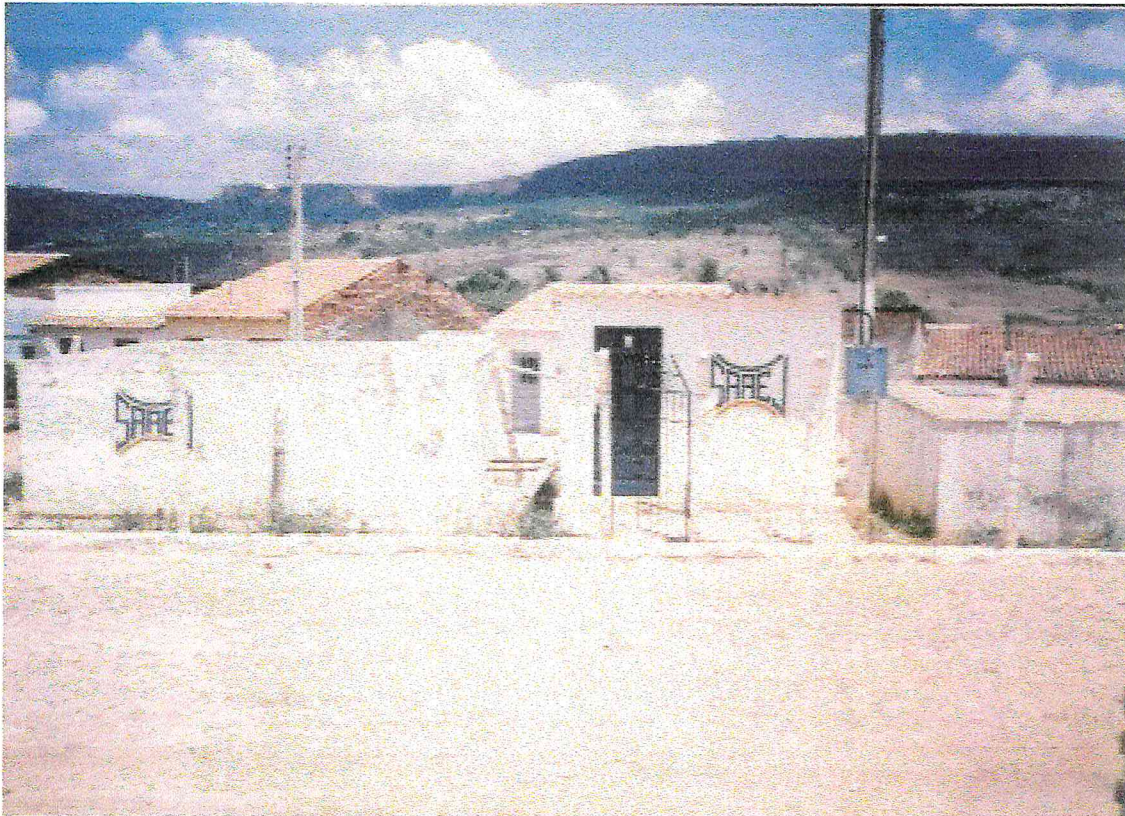
FOTO 09 – Estação elevatória do sistema de distribuição d'água de Jardim
