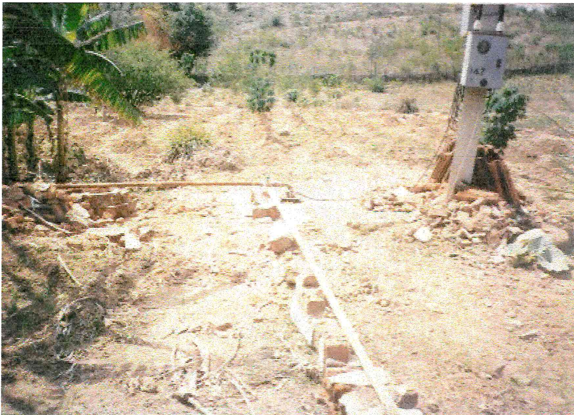
FOTO 12 – Poço Tubular de Bom Sucesso
