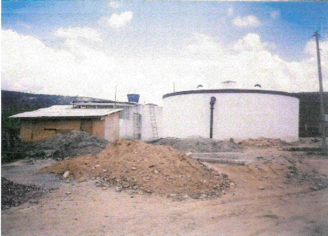
FOTO 05 – Reservatórios Apoiados de Jardim
