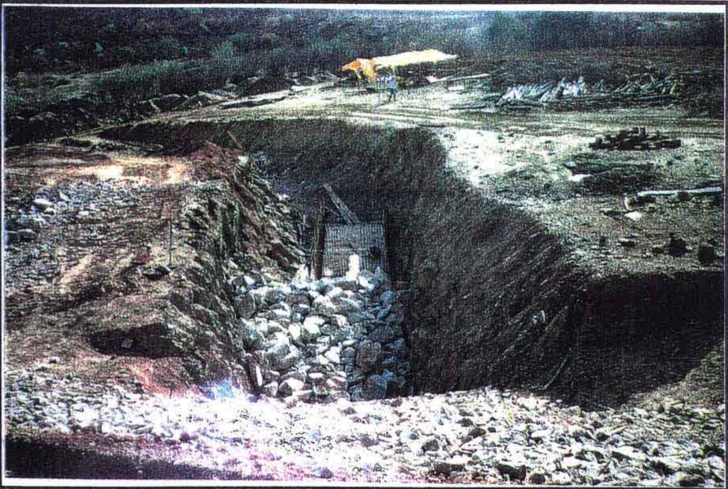
FOTO 04 - TOMADA D' ÁGUA: ENROCAMENTO DO TALUDE DE JUSANTE
