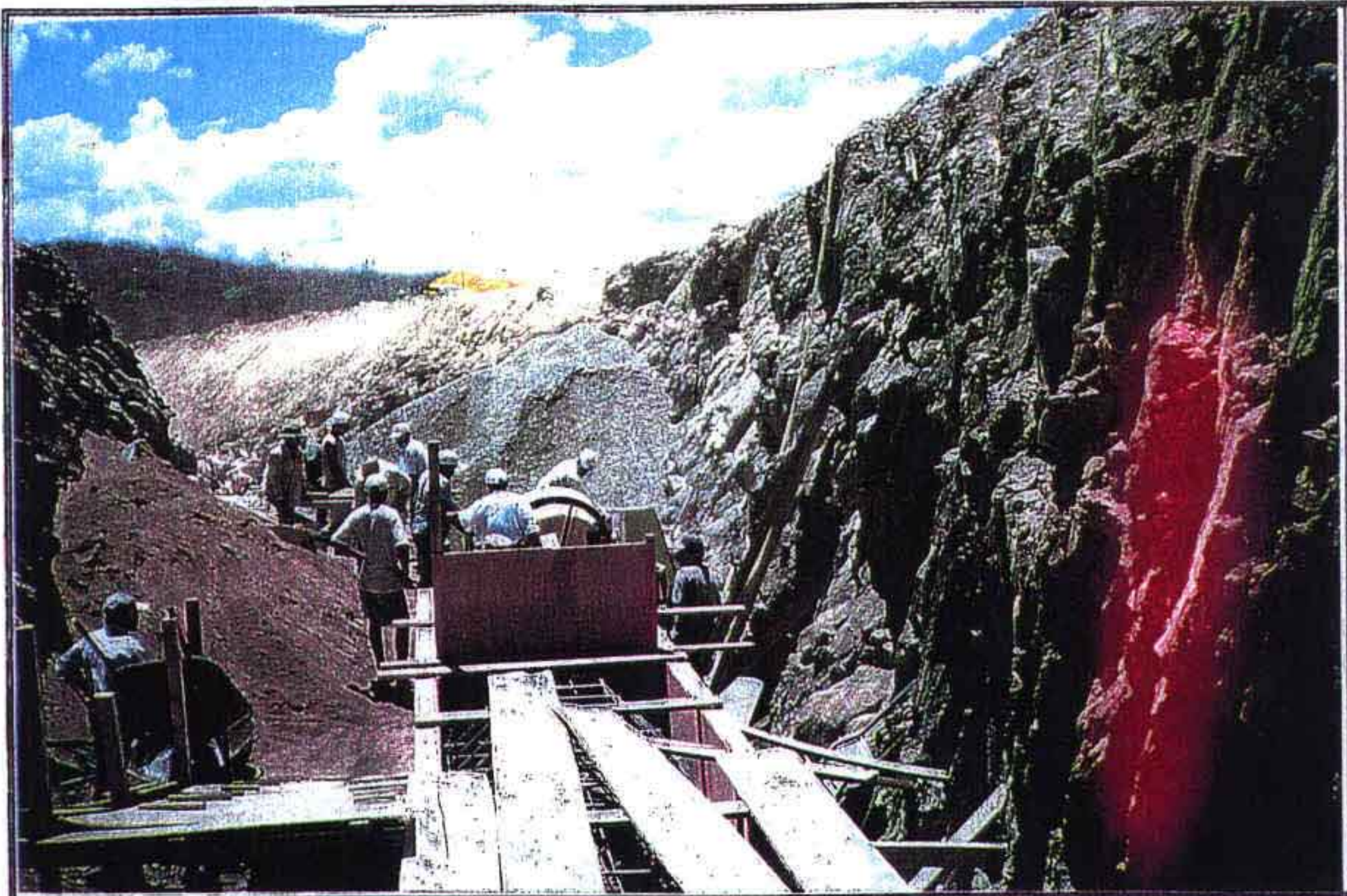
000009 - TOMADA D'ÁGUA: INÍCIO DE CONCRETAGEM DO ENVELOPAMENTO
