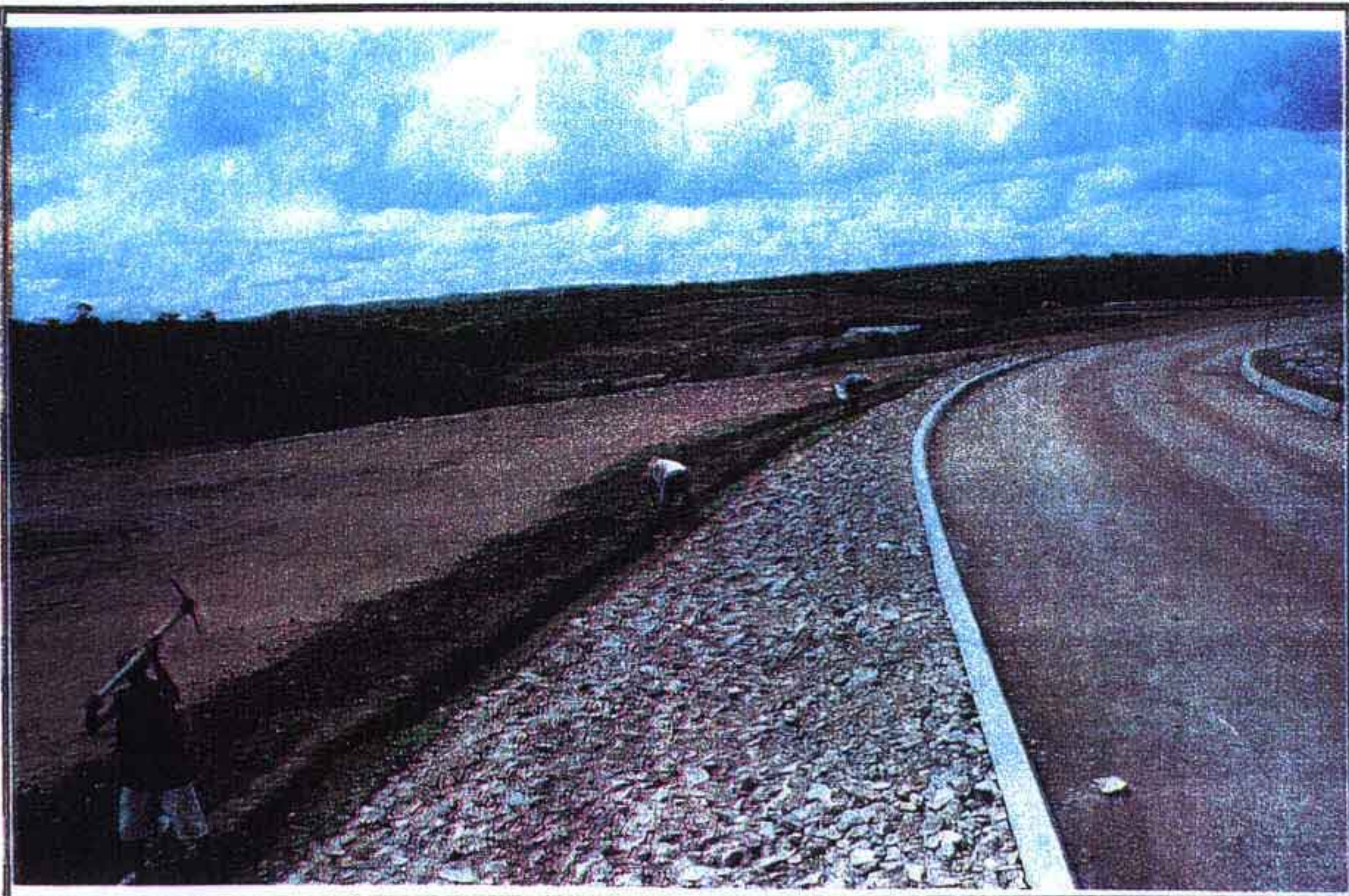
ESCAVAÇÃO DA CALHA DE PROTEÇÃO
