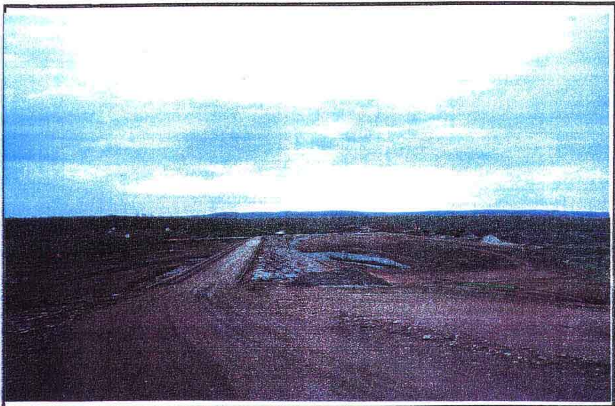
VISTA GERAL DA BARRAGEM
