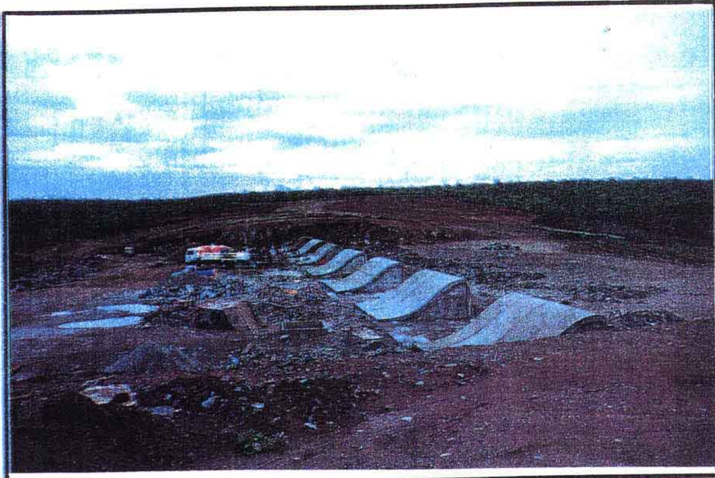
PERFIL CREAGER: VISTA GERAL DA SEQUENCIA DE CONCRETAGEM JUSANTE
