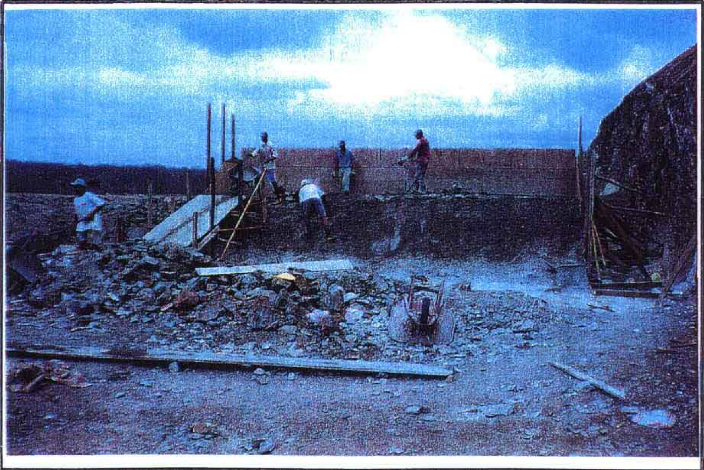
FIG. 01 - SANGRADOURO - PERFIL CREAGER EXECUÇÃO DO CONCRETO CICLÓPICO
