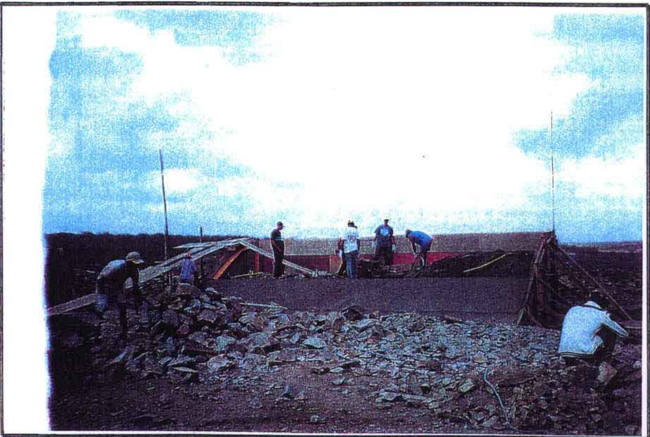
FIG. 02 - SANGRADOURO - PERFIL CREAGER EXECUÇÃO DO CONCRETO CICLÓPICO E CONCRETO SIMPLES DE ACABAMENTO
