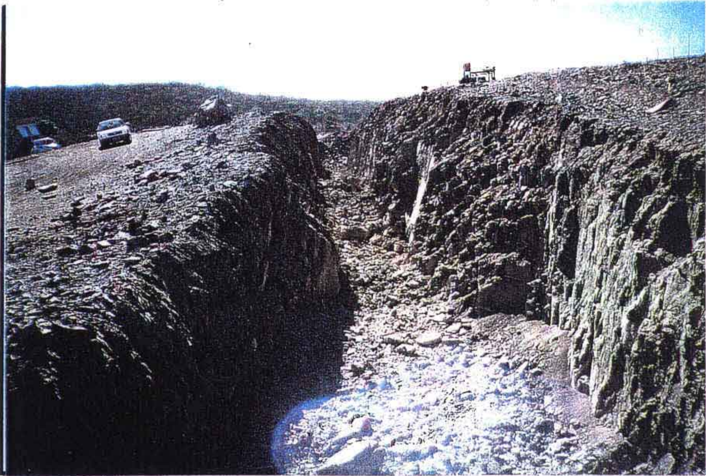
TOMADA D'AGUA - LIMPEZA DA VALA
