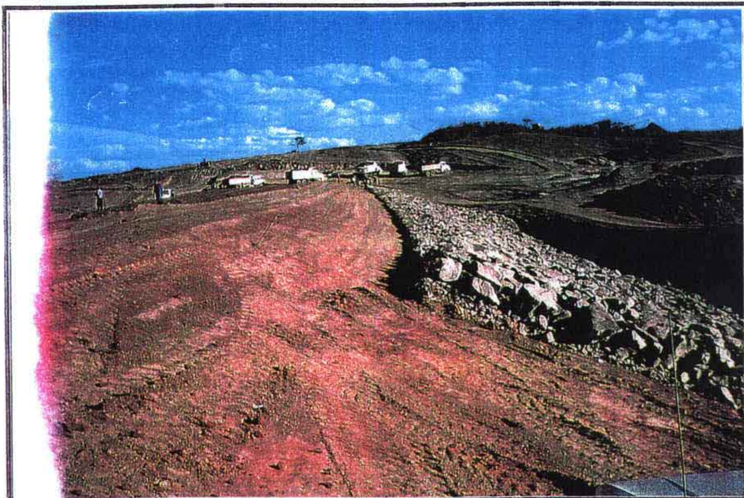
PREPARO DO TALUDE E EXECUÇÃO DO RIP- RAP.
