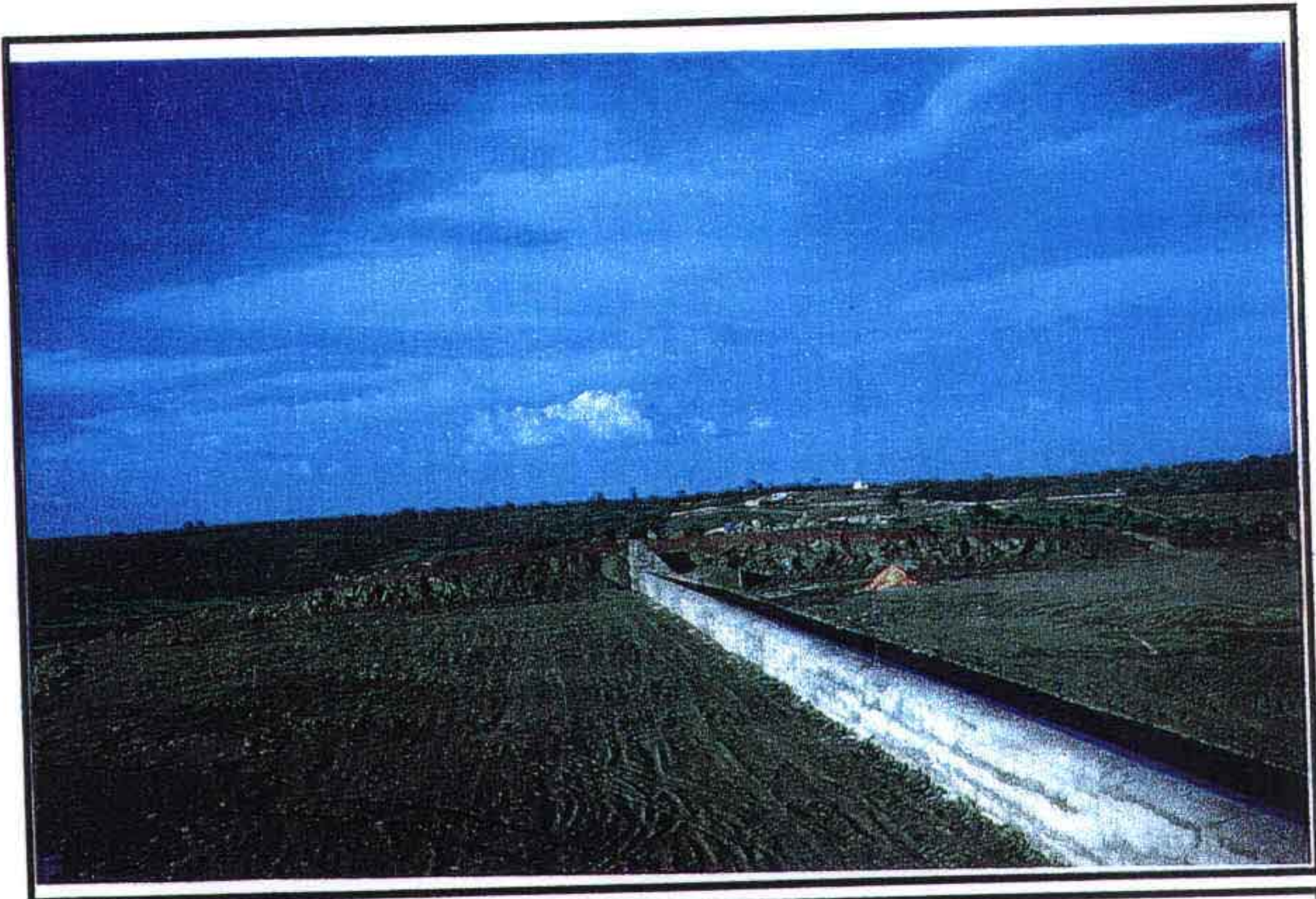
SANGRADOURO – PERFIL CREAGER CONCLUÍDO
