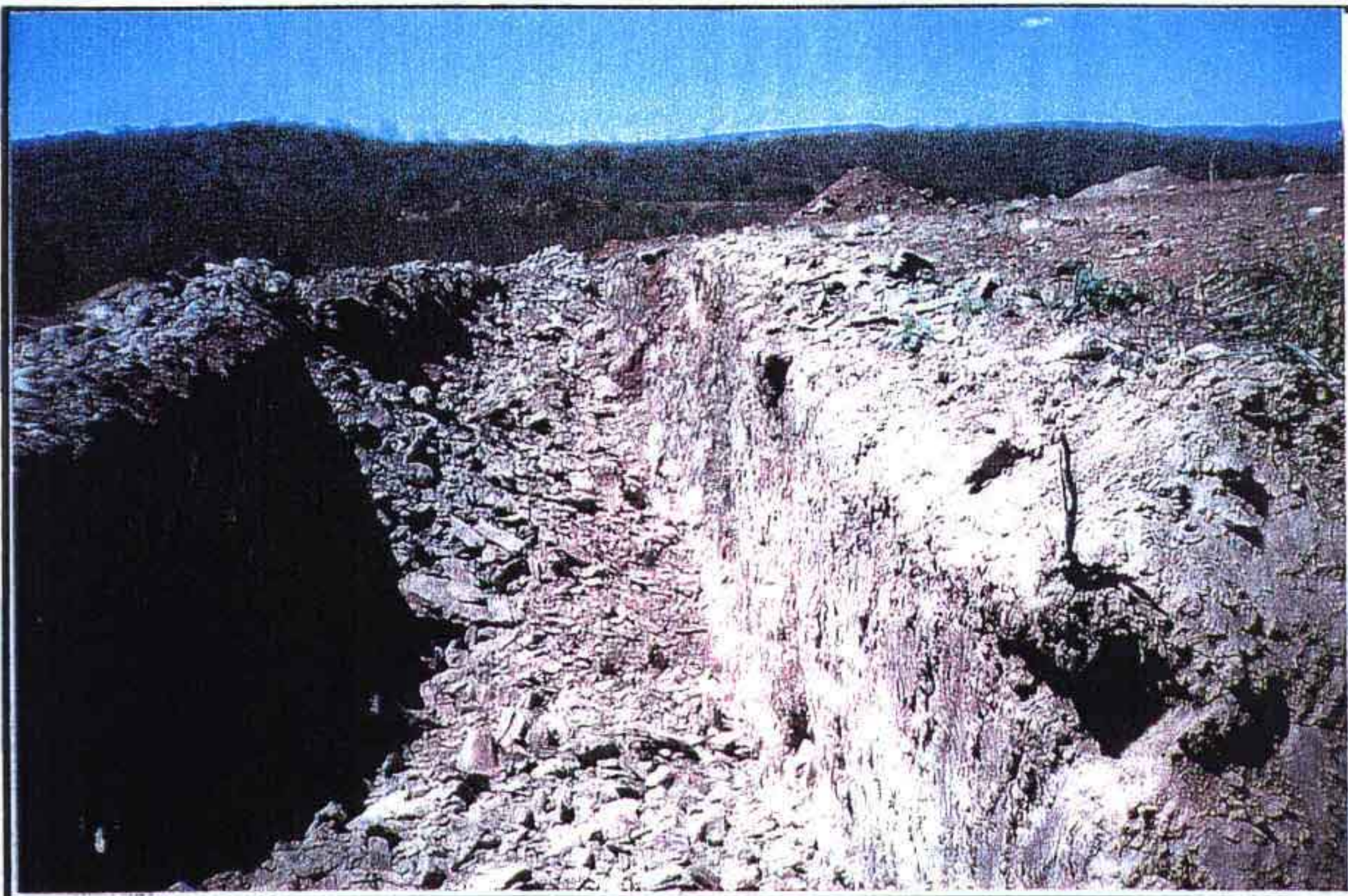
TOMADA D'AGUA - VALA APÓS 2ª DETONAÇÃO
