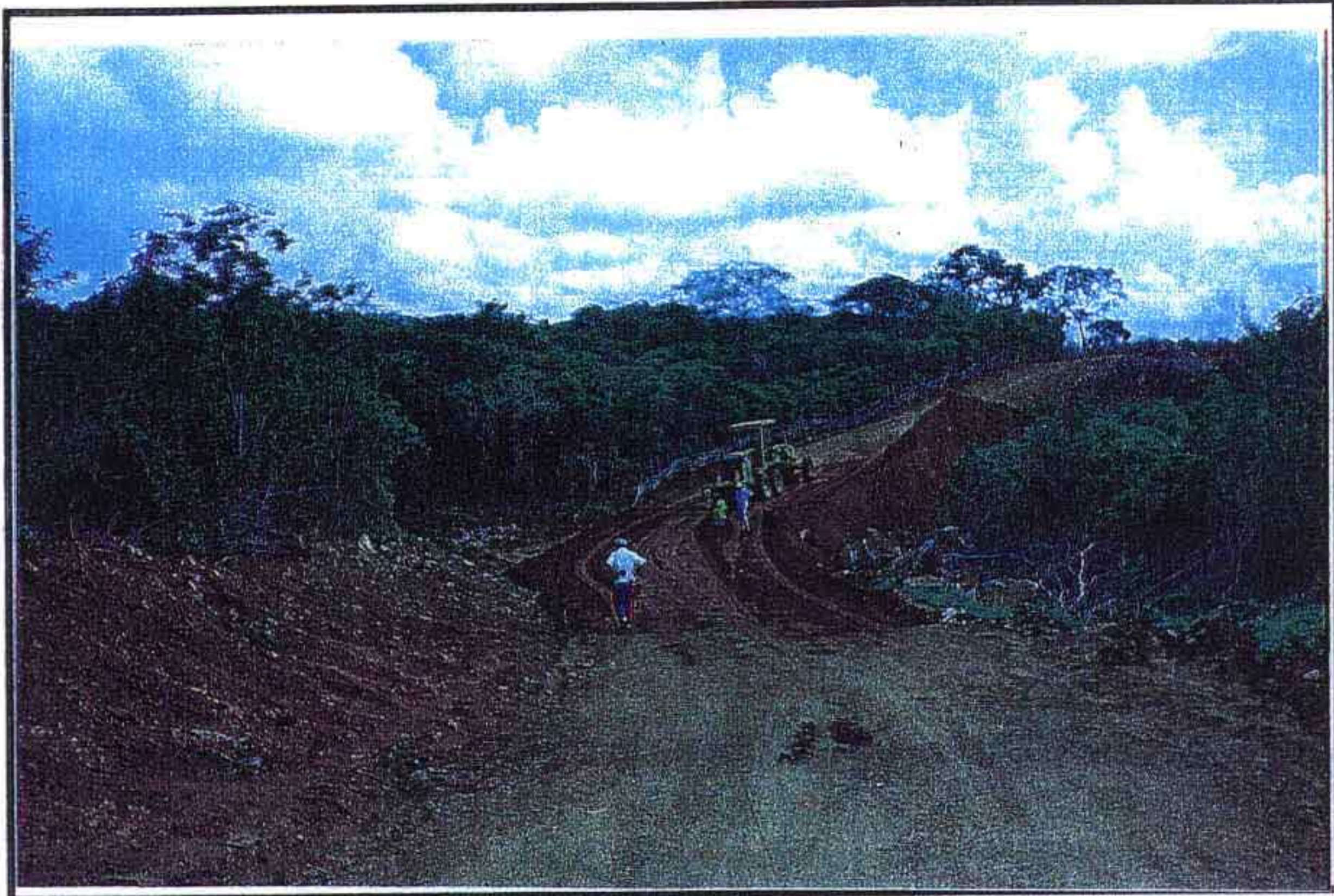
ESTRADA DE CONTORNO: ATERRO DE BUEIRO
