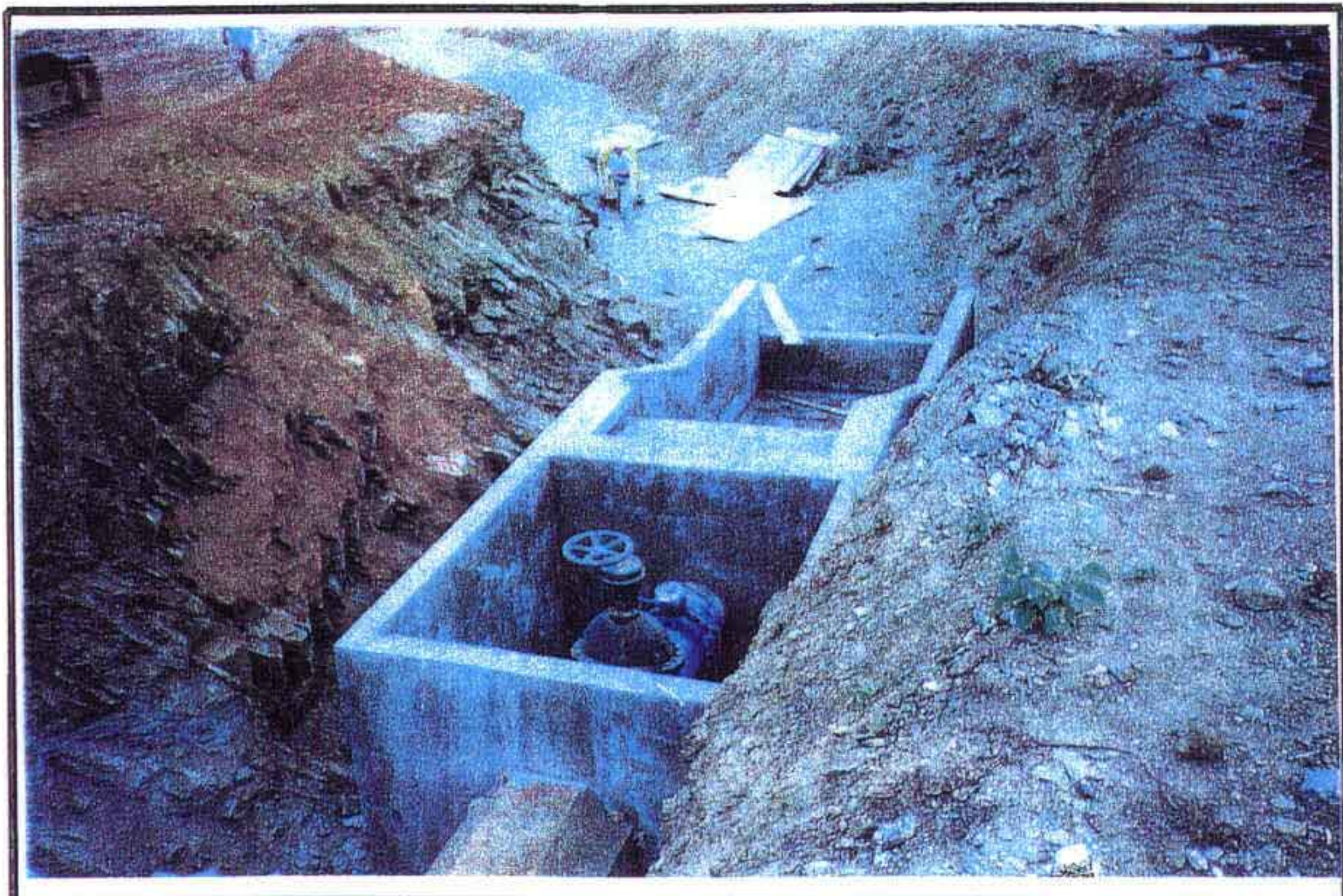
TOMADA D'ÁGUA CAIXA DE JUSANTE - CONCRETAGEM PRONTA
