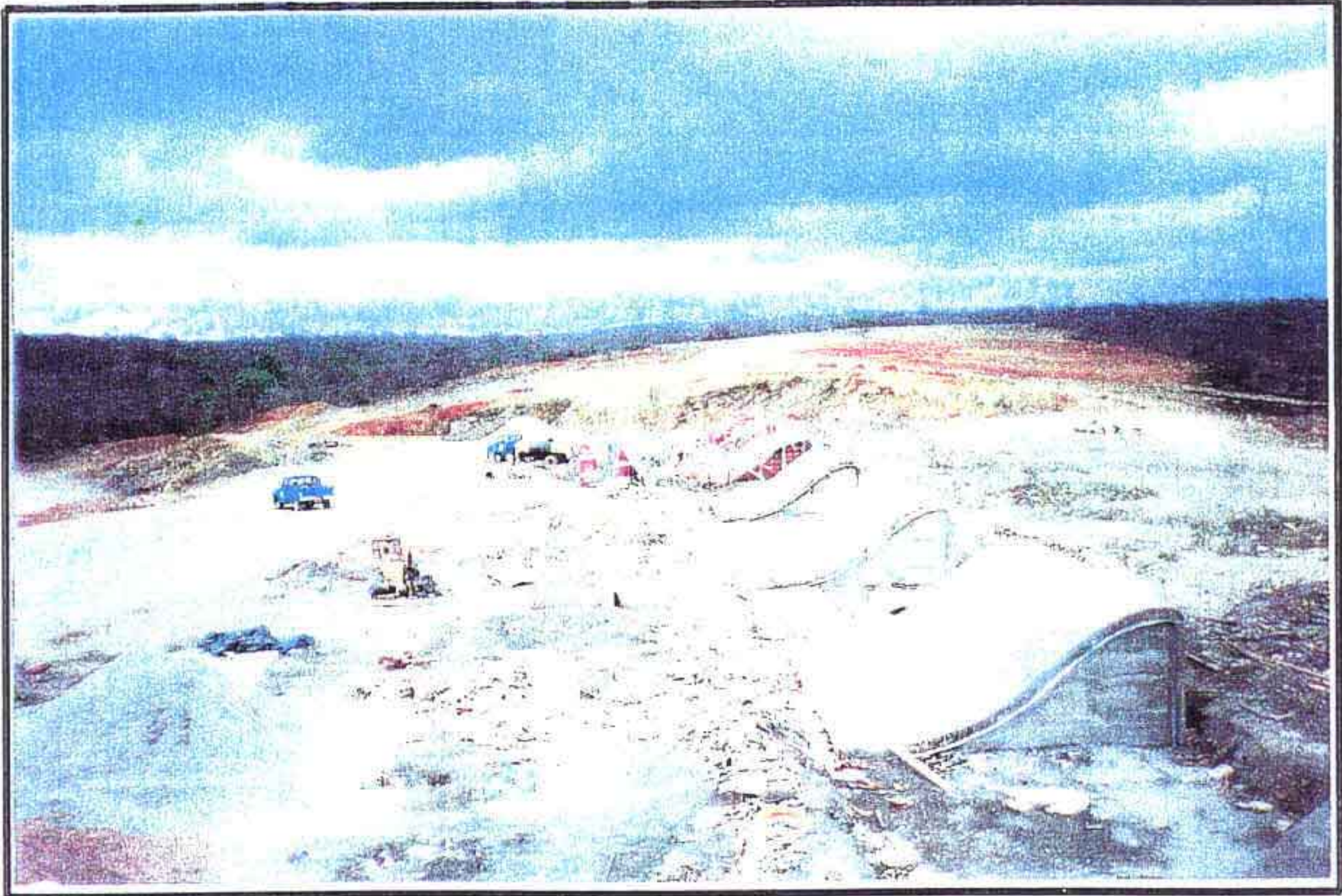
SANGRADOURO - PERFIL CREAGER BLOCOS PRONTOS ALTERNADAMENTE
