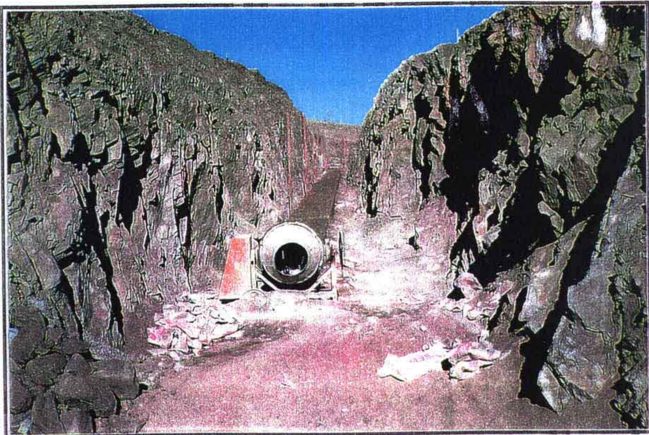
TOMADA D'ÁGUA: CONDIÇÕES DA ROCHA DA CAVA.
