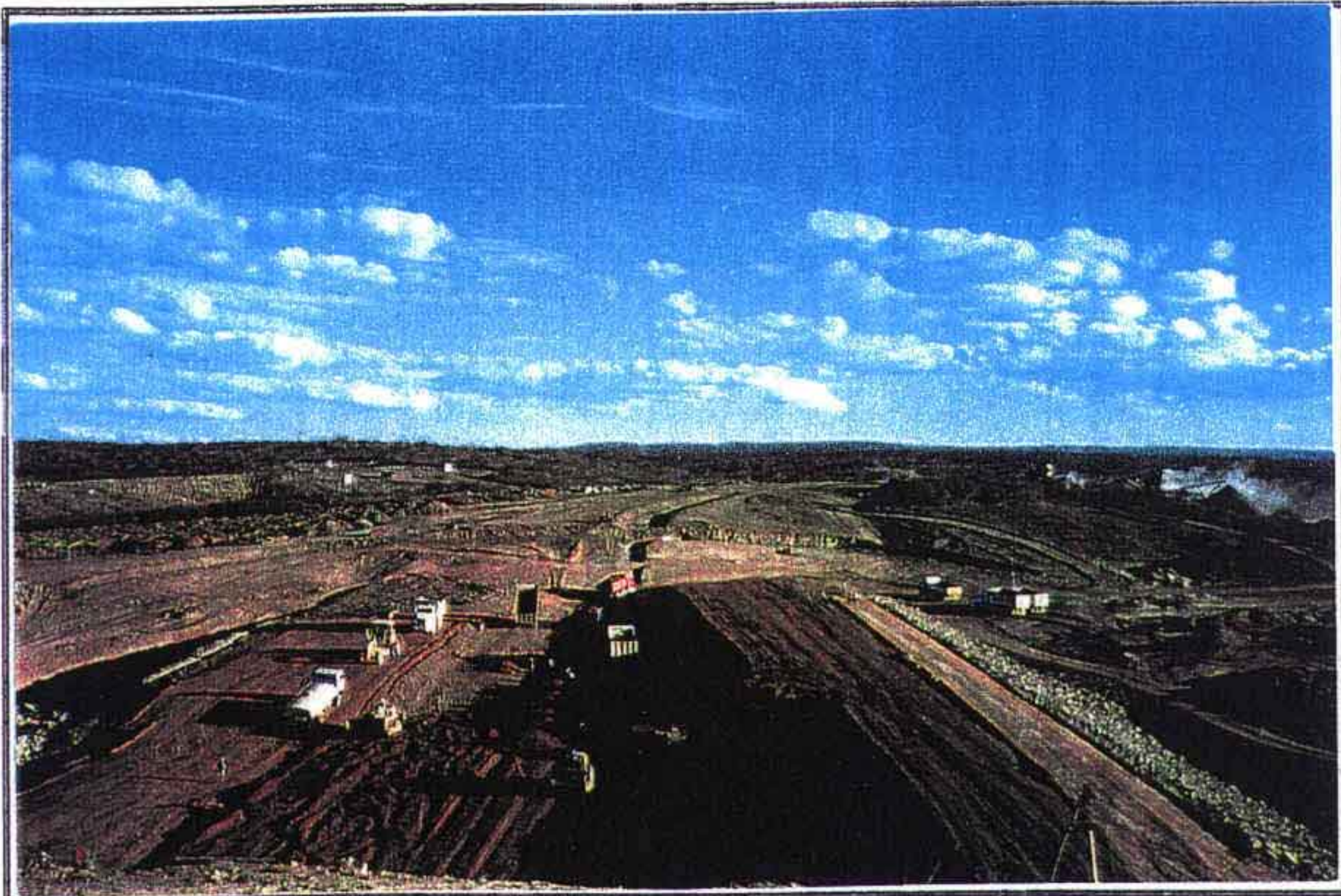
VISTA GERAL DA BARRAGEM
