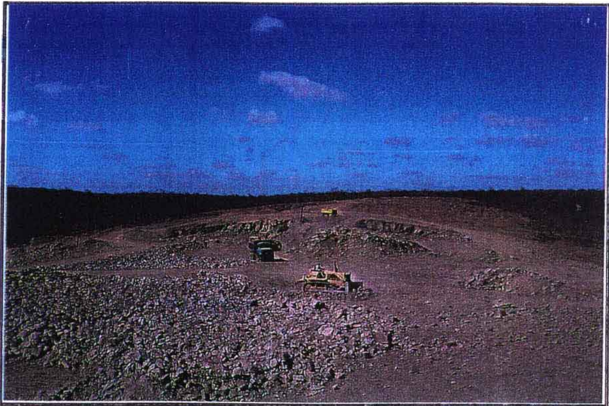
SANGRADOURO : ROCHAS DETONADAS E PERFURAÇÃO EM MATERIAL DE 3ª CATEGORIA
