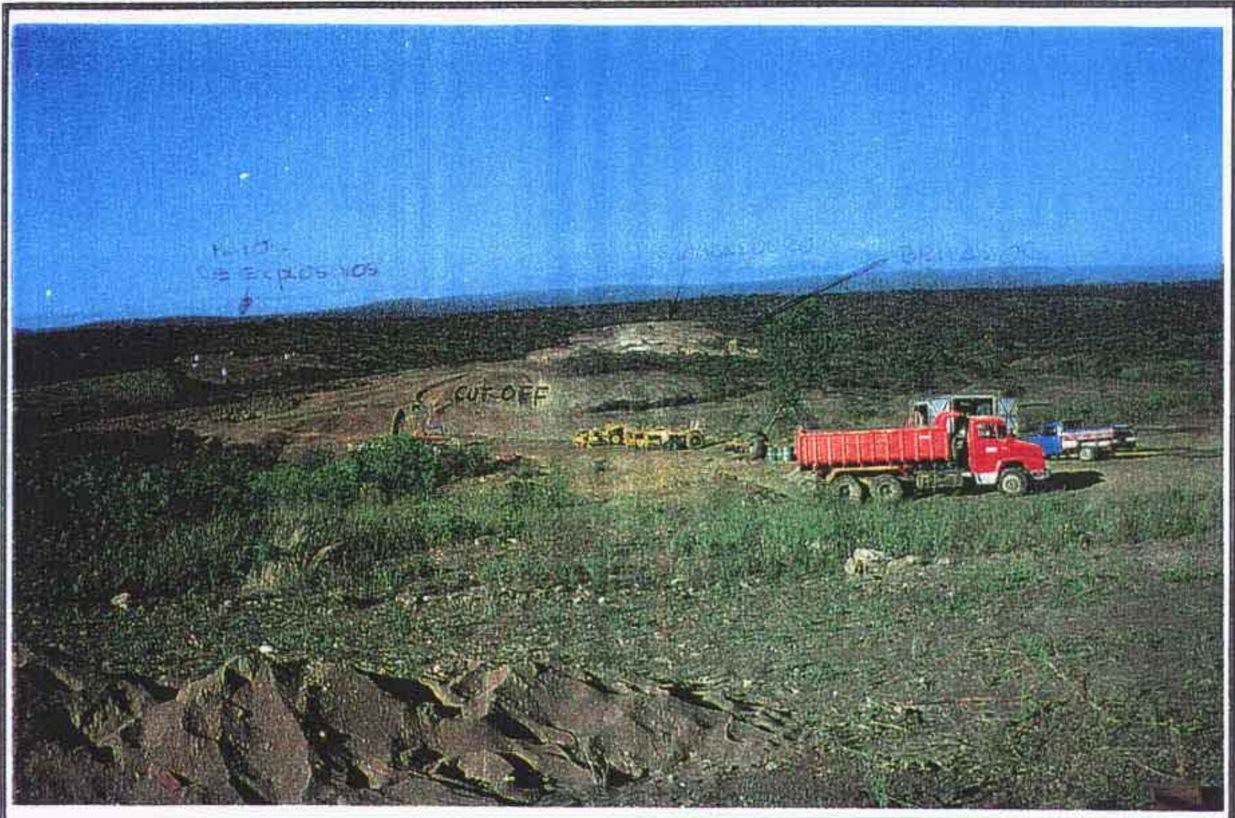
VISTA GERAL DA BARRAGEM
