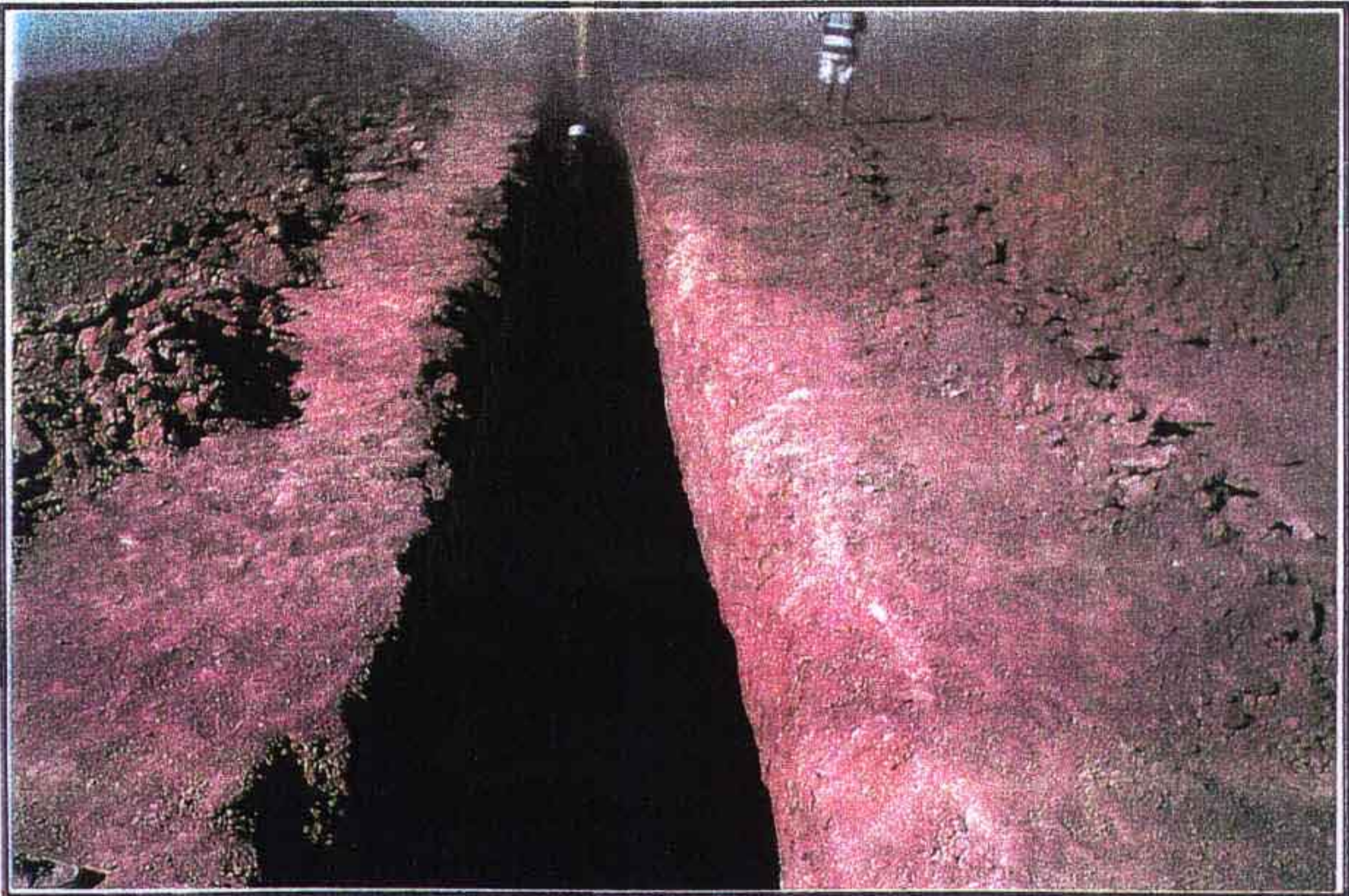
ESCAV. DA VALA PARA LANÇAMENTO DA AREIA DO FILTRO VERTICAL
