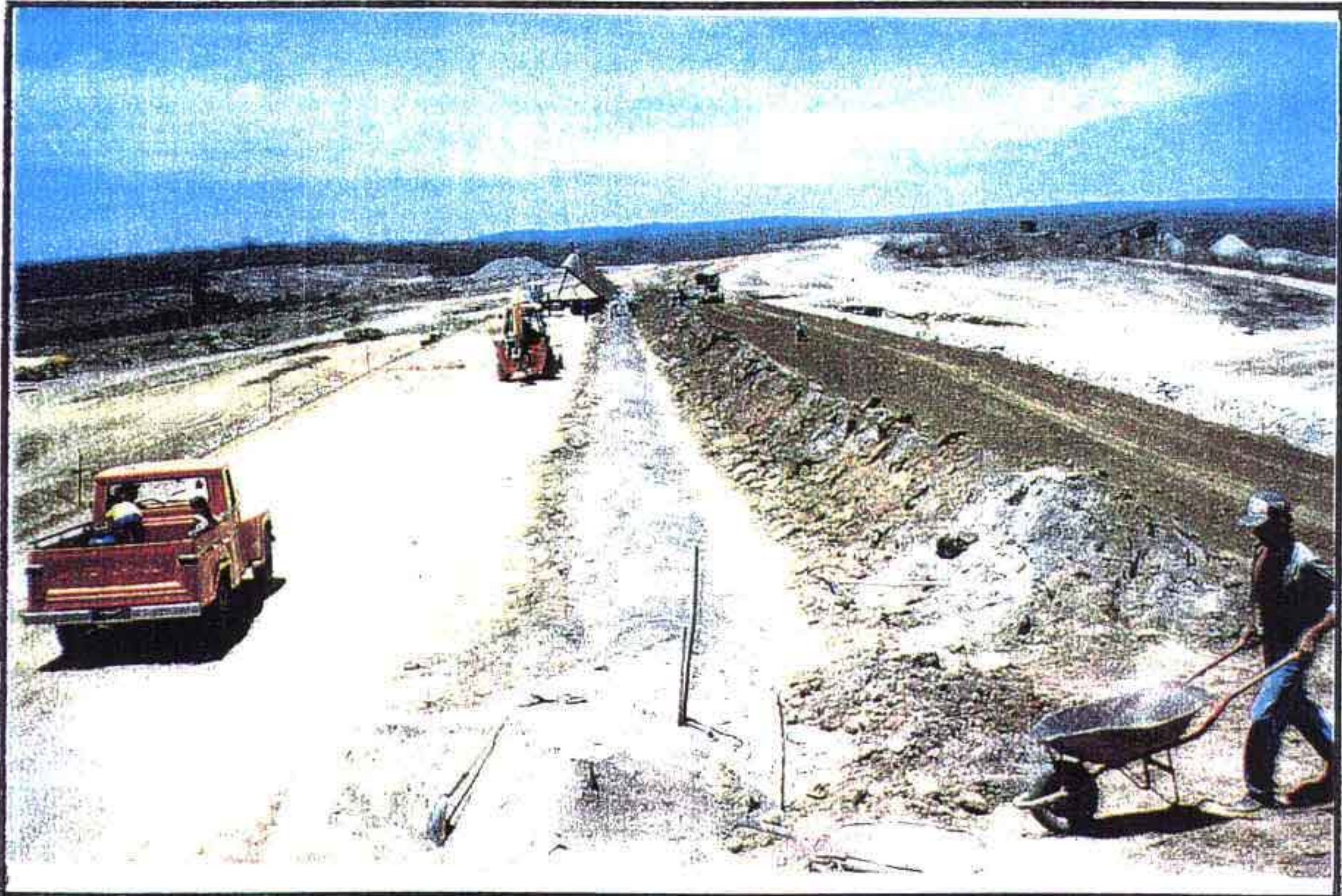
AREIA COLOCADA NA VALA DO DRENO VERTICAL ( 2ª CAMADA )
