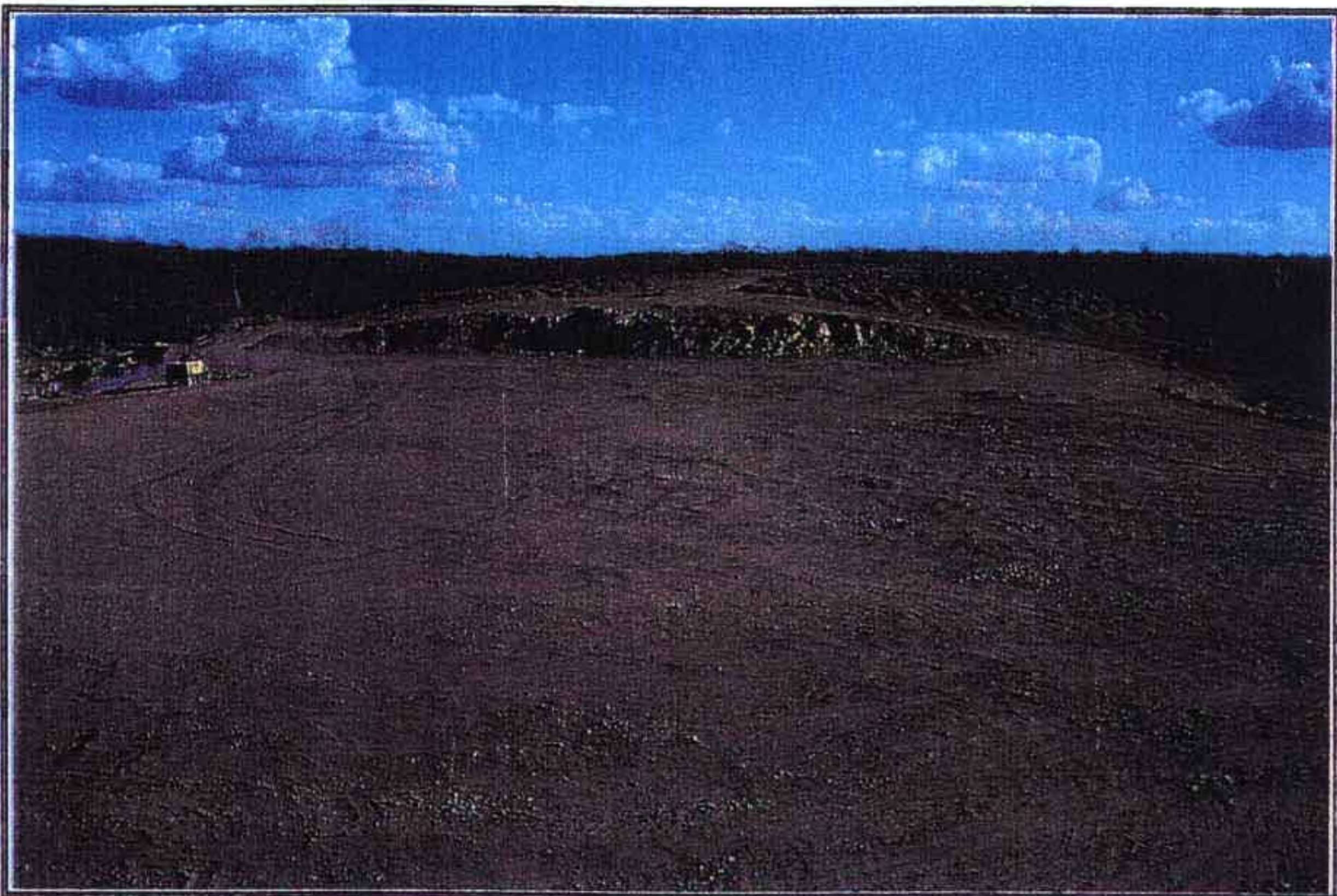
SANGRADOURO : ESCAVAÇÃO CONCLUÍDA
