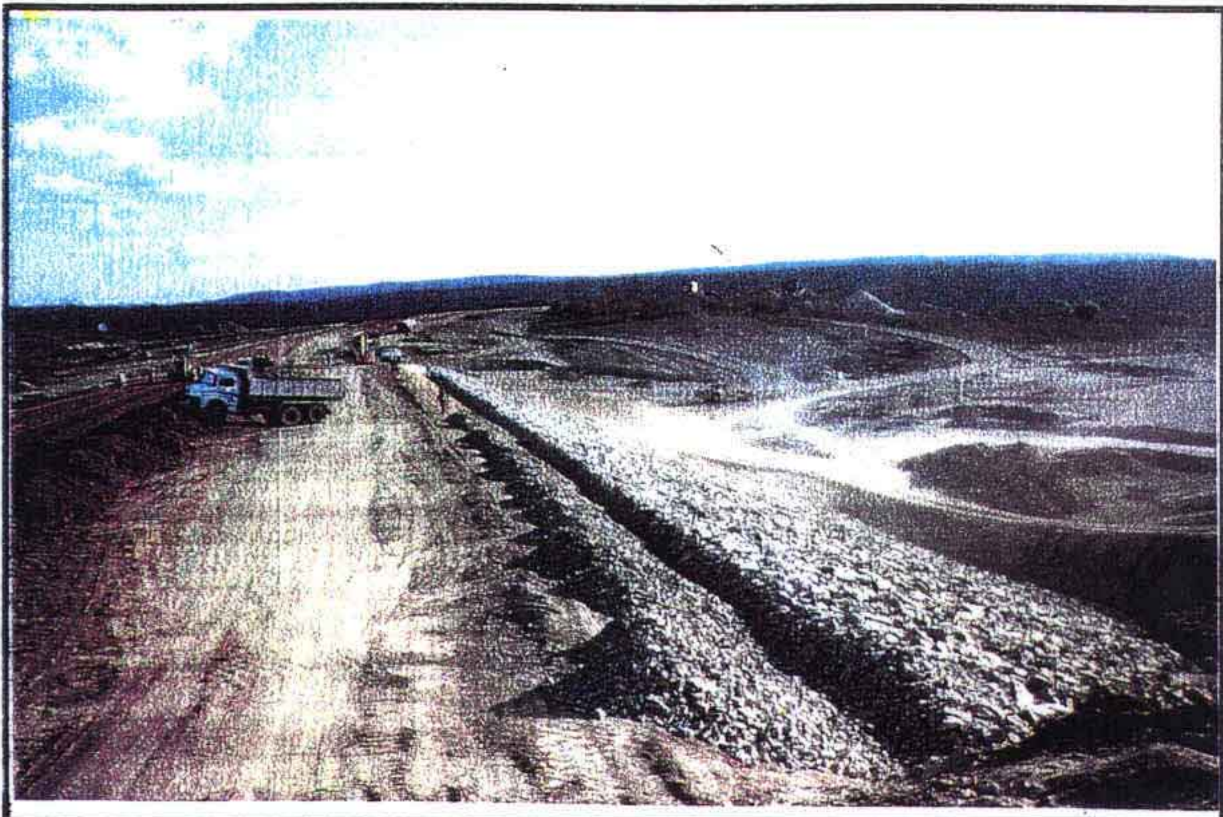
EXECUÇÃO DA TRANSIÇÃO ( BRITA 6' ) DO RIP- RAP
