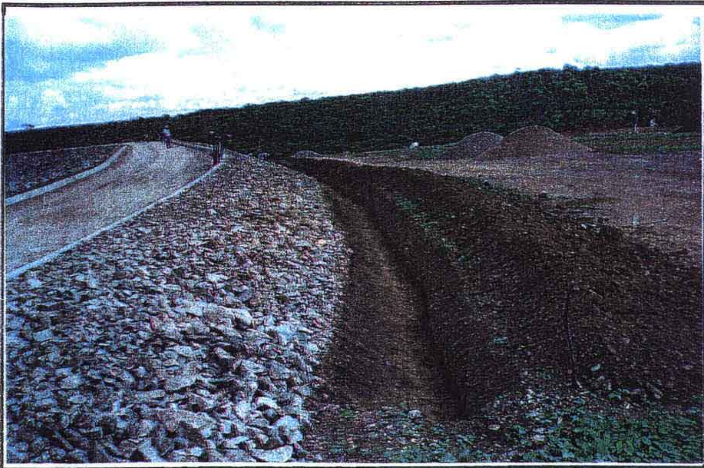
ESCAVAÇÃO DA CALHA DE PROTEÇÃO A JUSANTE – OMBREIRA ESQUERDA
