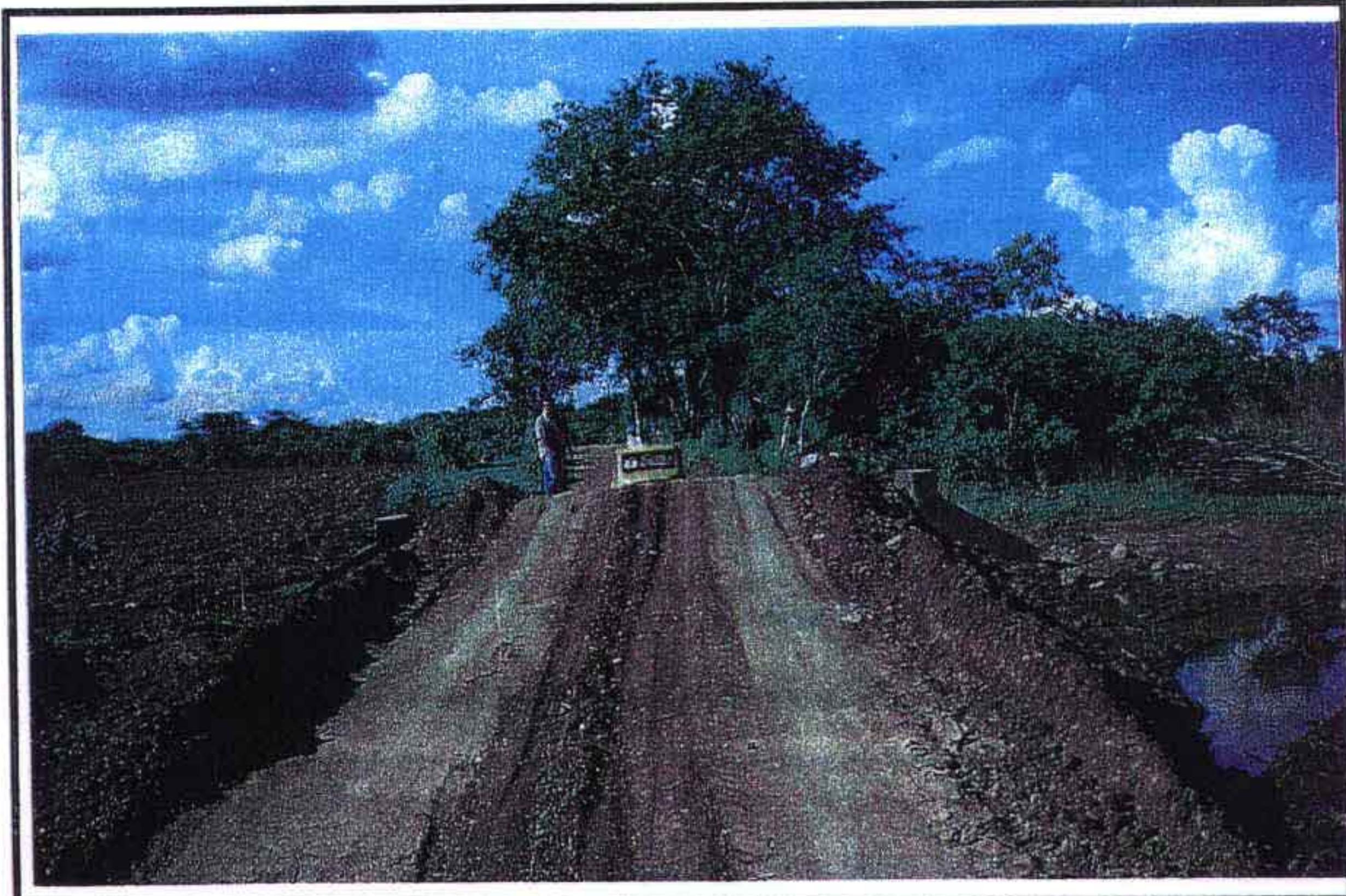
ESTRADA DE CONTORNO: ATERRO DE BUEIRO
