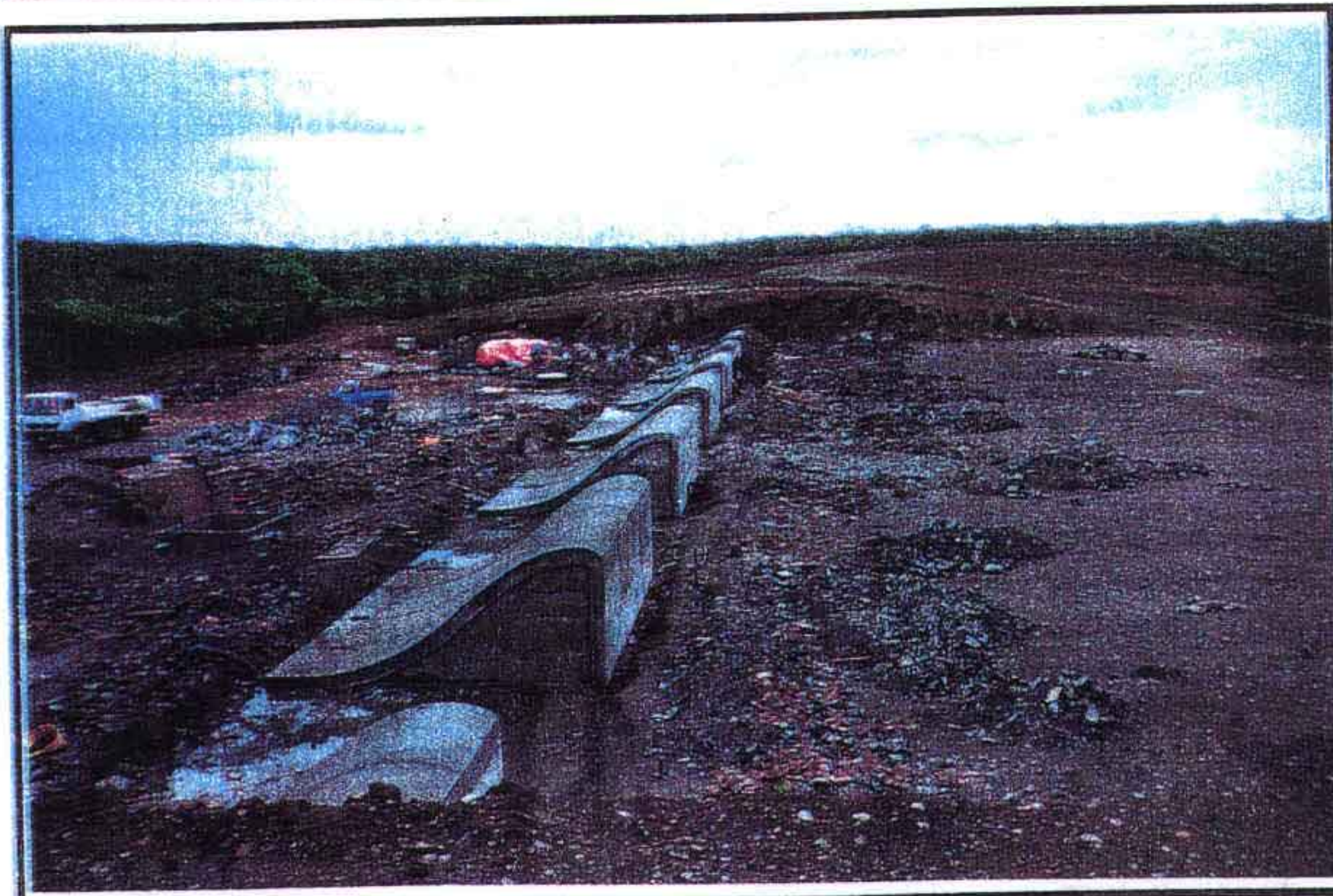
PERFIL CREAGER: DETALHE DA CONCRETAGEM MONTANTE
