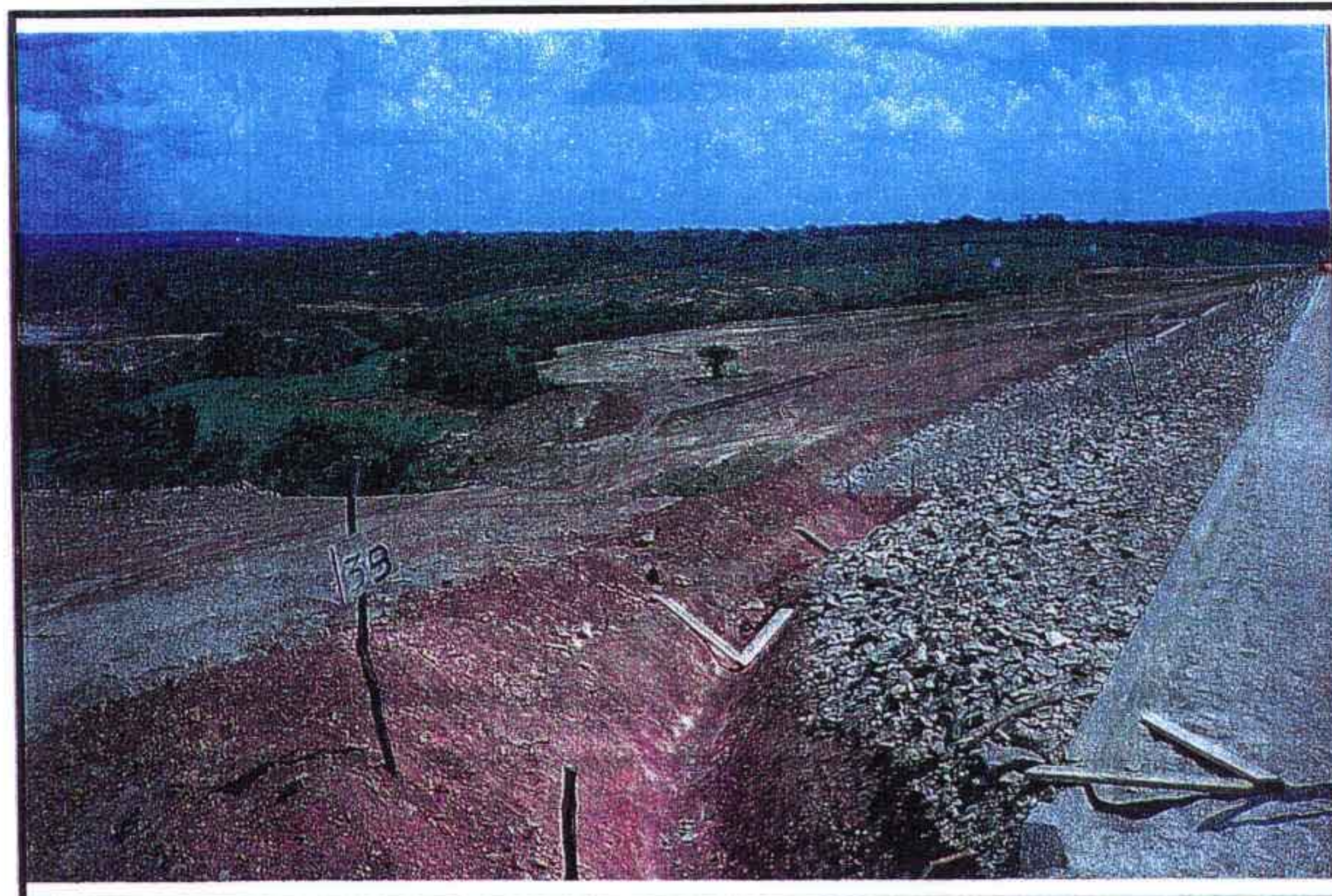
OMBREIRA ESQUERDA - JUSANTE: EXECUÇÃO DE VALETA DE PROTEÇÃO
