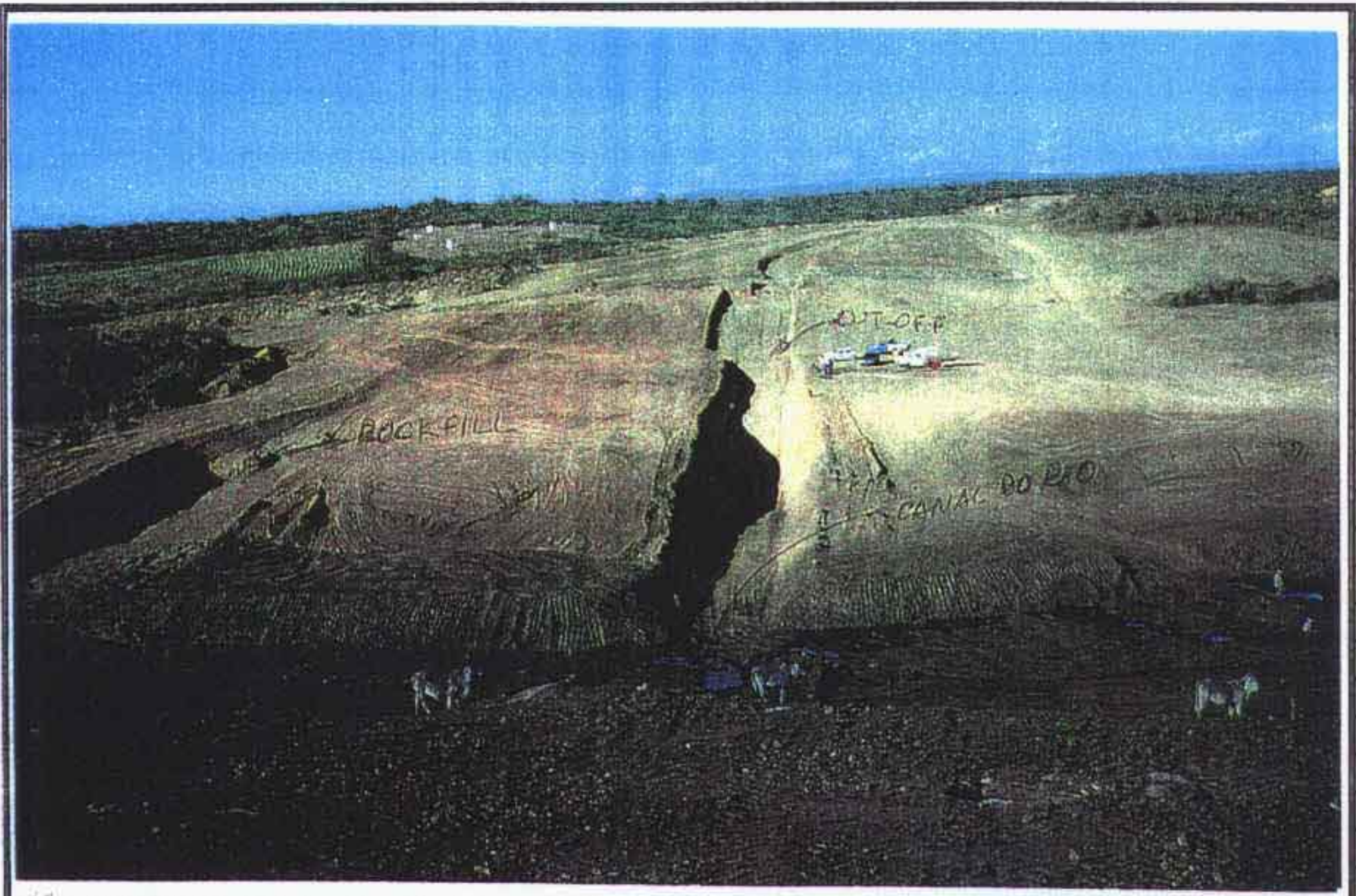
ESCAVAÇÃO DO CUT-OFF E DO ROCKFILL
