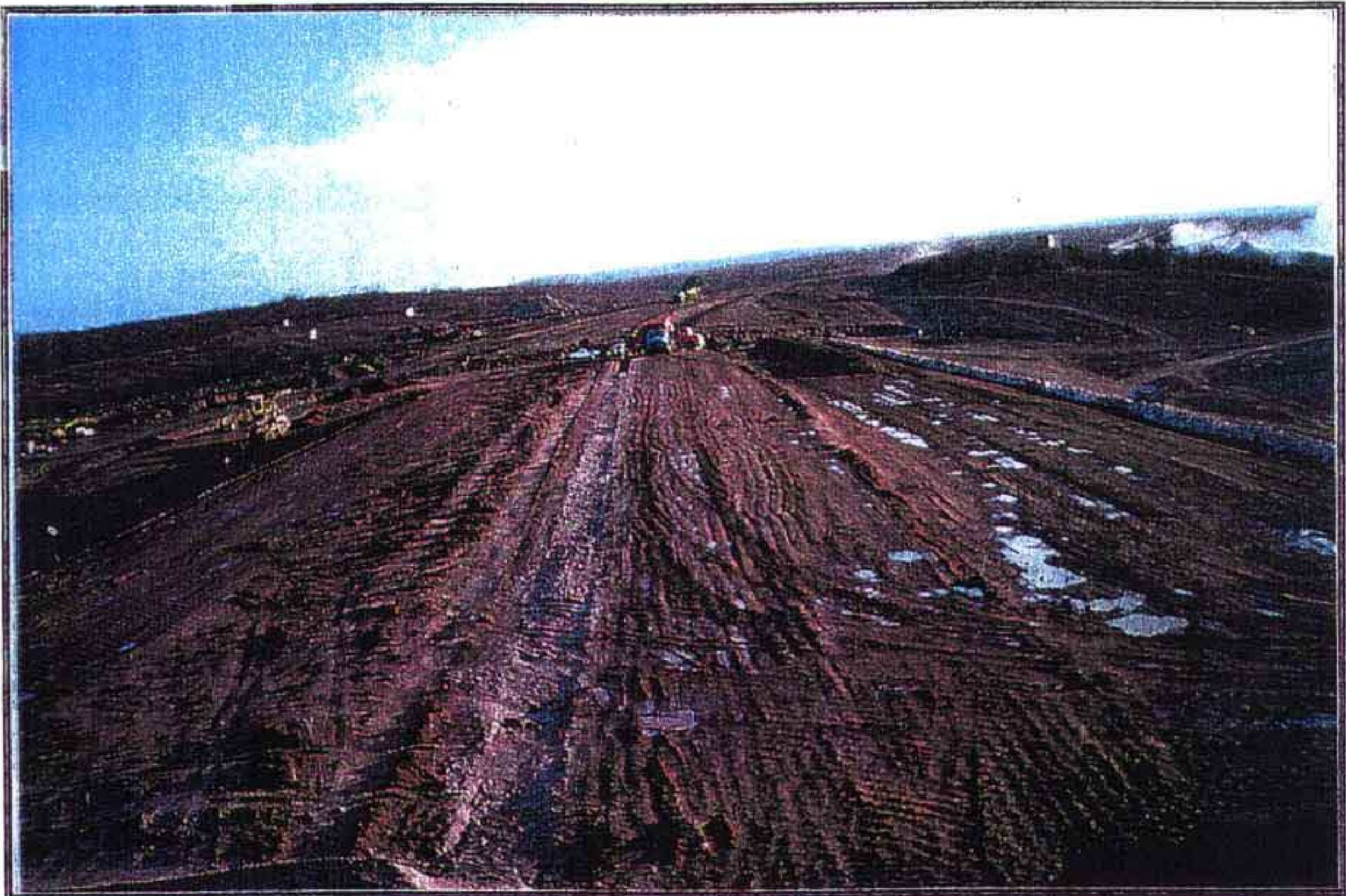
EXECUÇÃO DO FILTRO VERTICAL
