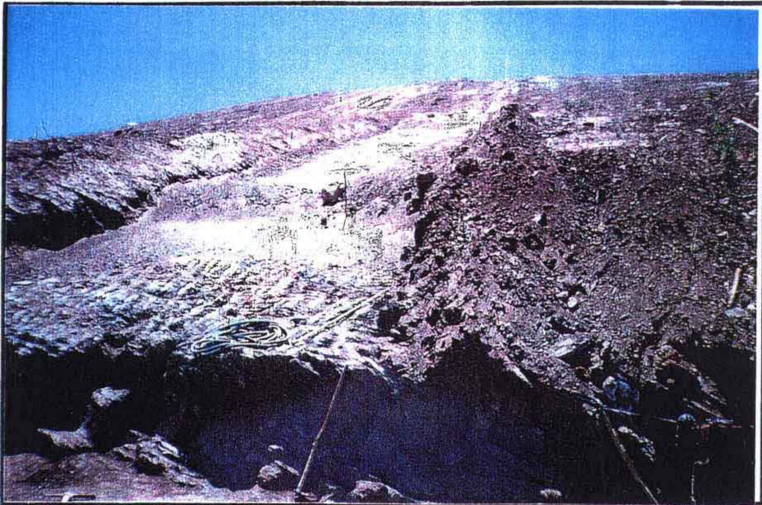
CUT-OFF – LIMPEZA DE ROCHA NA OMBREIRA ESQUERDA
