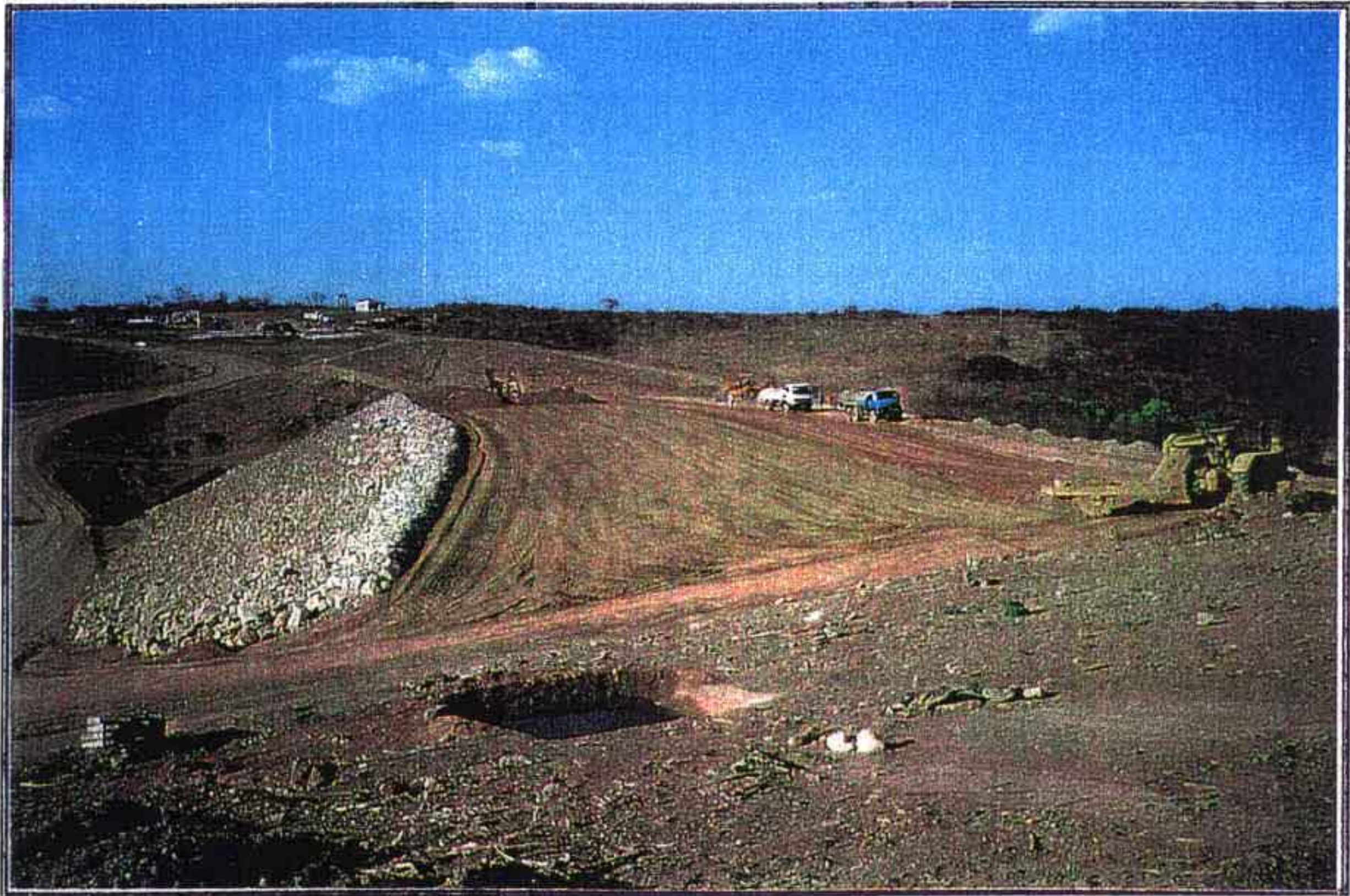
VISTA GERAL DA BARRAGEM (á partir da ombreira direita)
