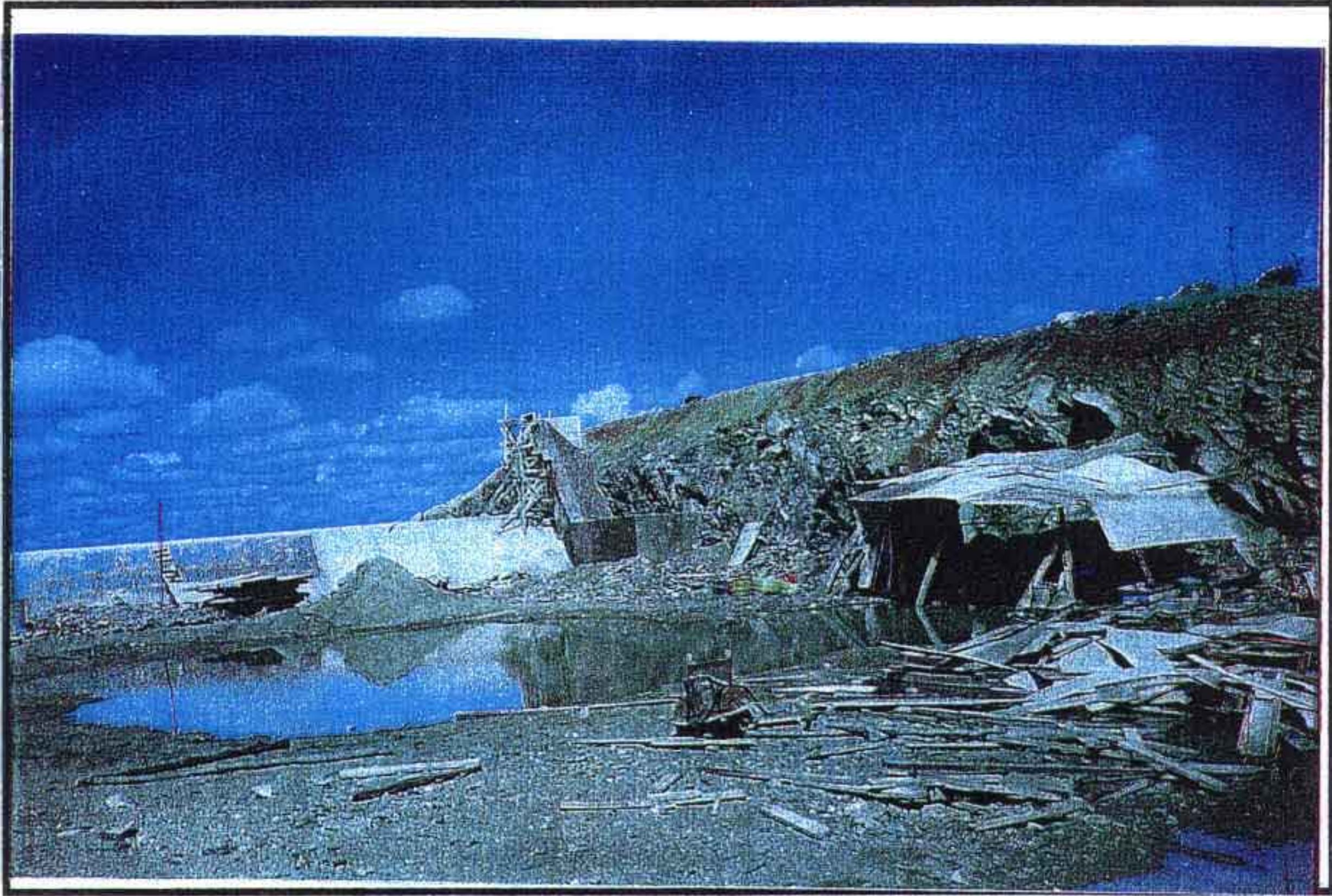
MURO DE CONTENÇÃO: EM EXECUÇÃO
