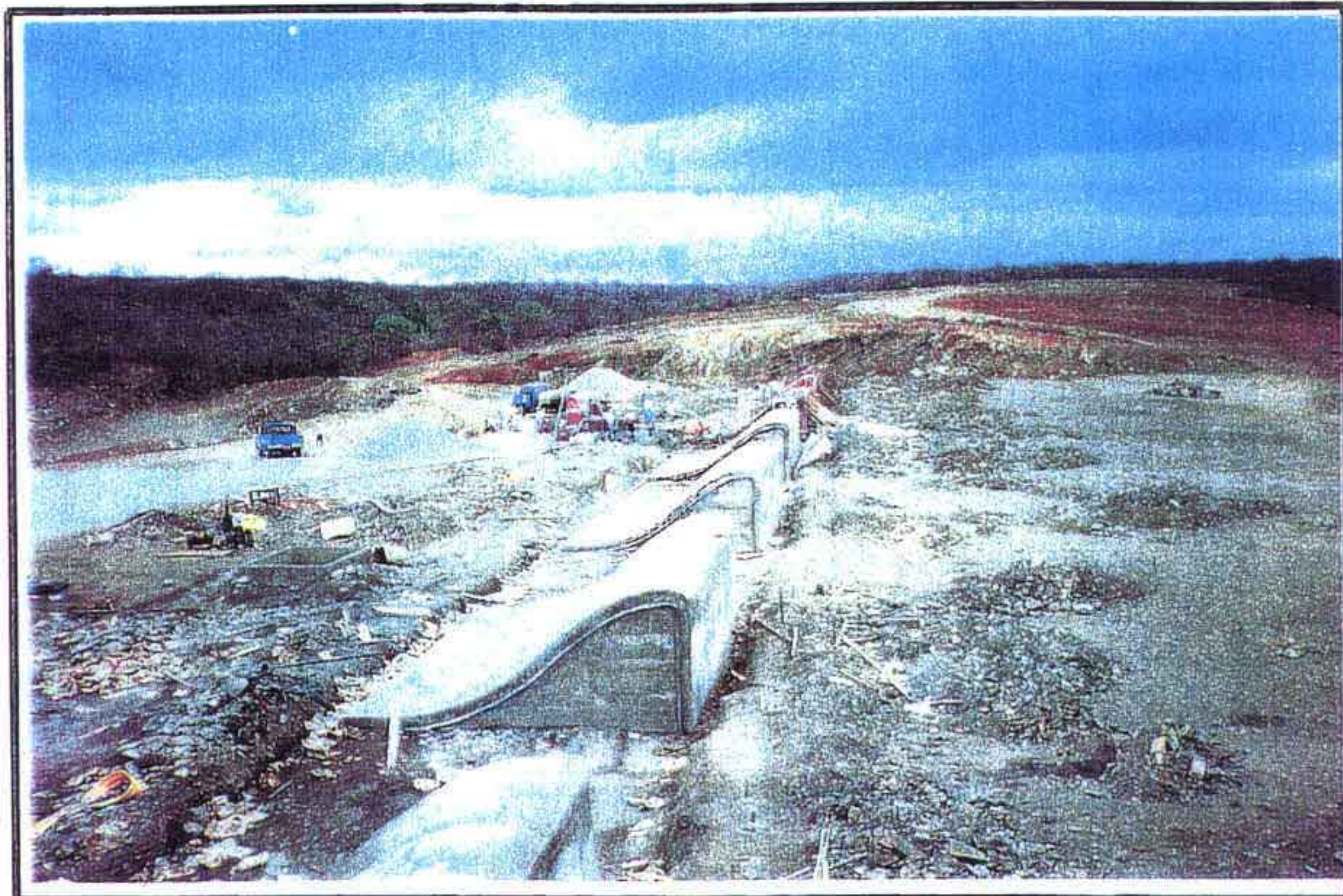
- SANGRADOURO - PERFIL CREAGER BLOCOS PRONTOS ALTERNADAMENTE
