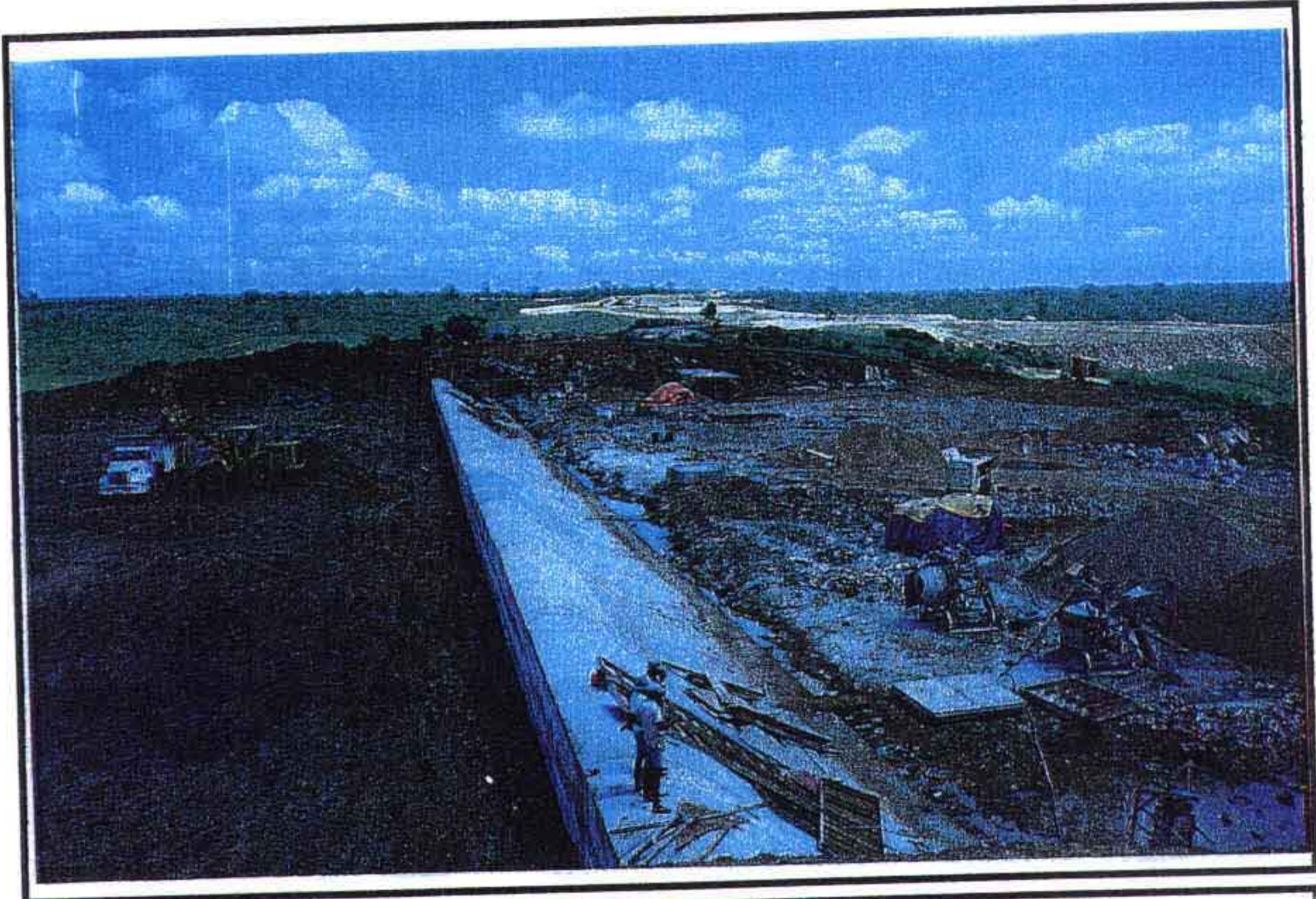
SANGRADOURO – REGULARIZAÇÃO DO LADO MONTANTE COM LIMPEZA
