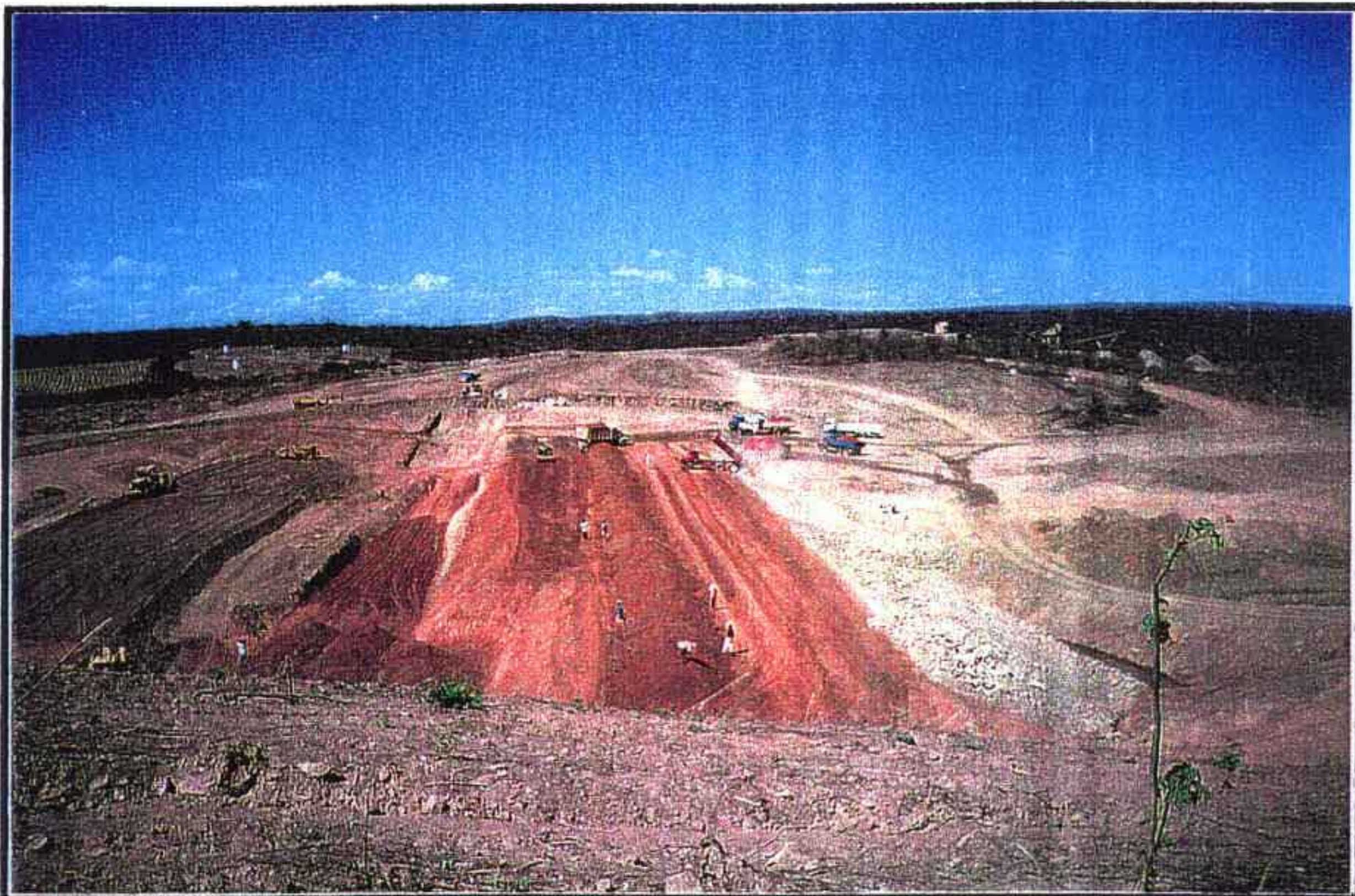
MACIÇO DA BARRAGEM – LANÇAMENTO DE BRITA PARA TRANSIÇÃO DO ENROCAMENTO
