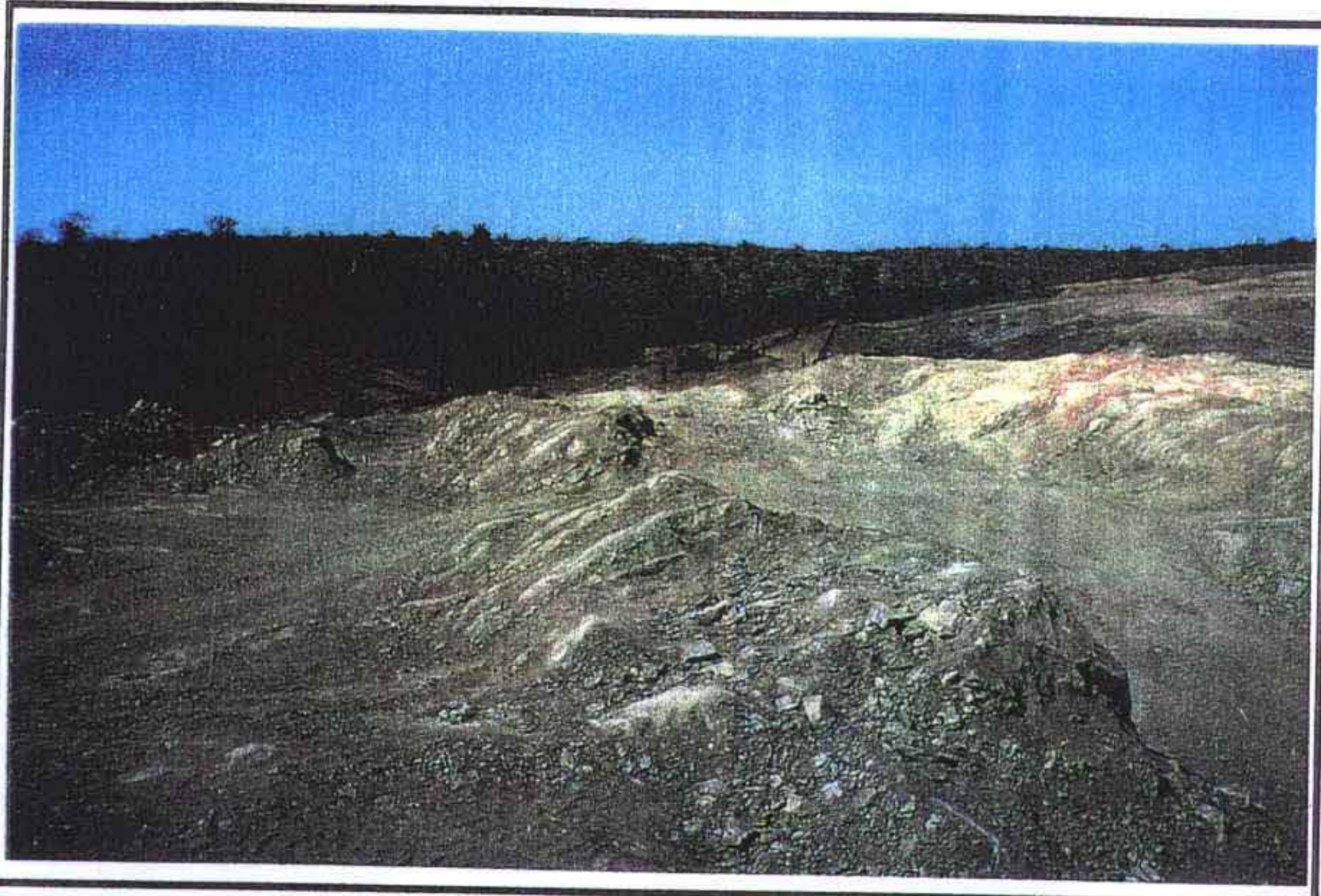
7 ÁREA DO VERTEDOURO PARA PERFURAÇÃO EM MATERIAL DE 3ª CATEGORIA
