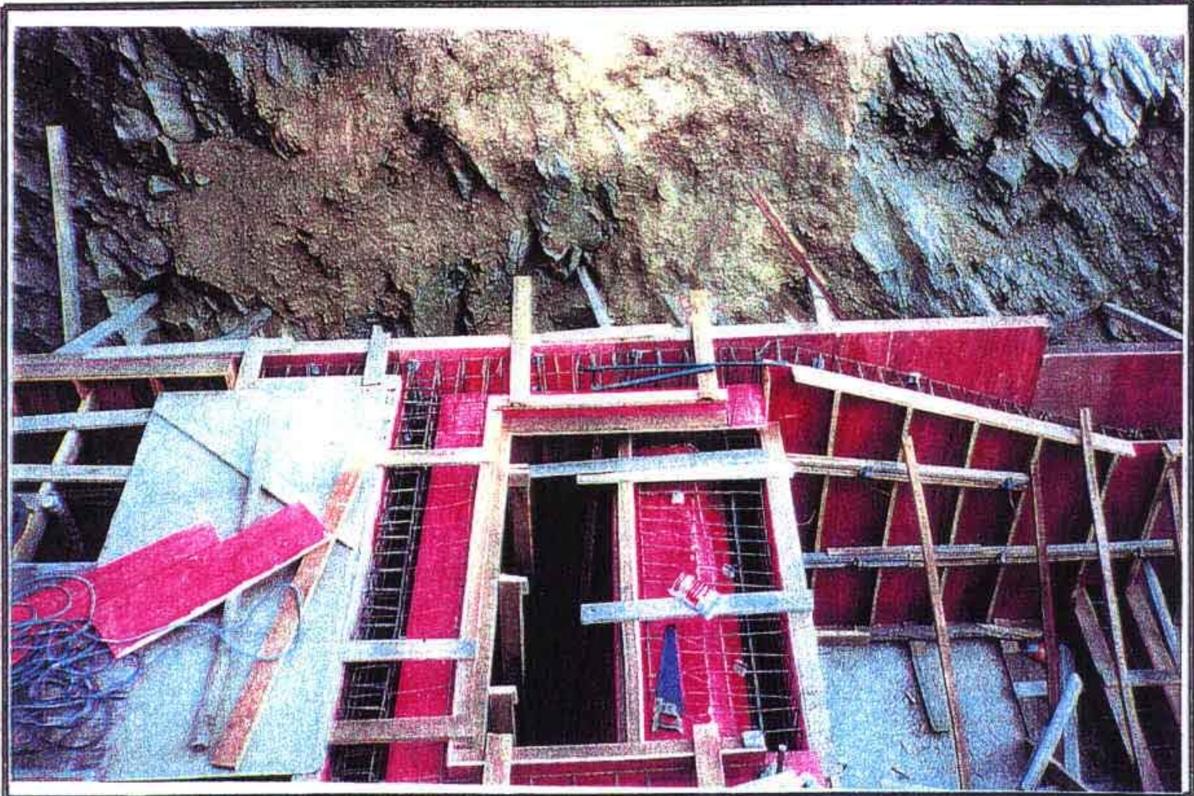
TOMADA D'ÁGUA CAIXA DE JUSANTE – COLOCAÇÃO DE FÔRMA E FERRAGEM
