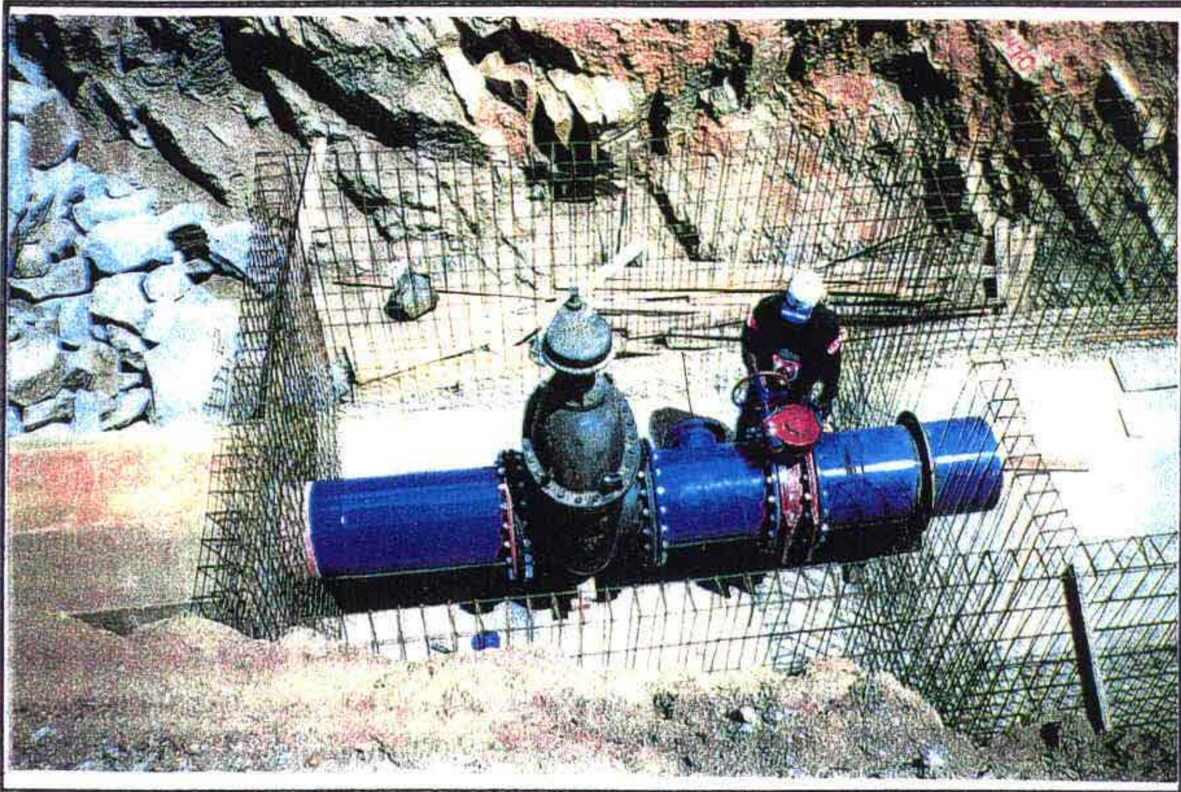
TOMADA D' ÁGUA: COLOCAÇÃO DAS PEÇAS HIDRO- MECÂNICAS DA CAIXA JUSANTE
