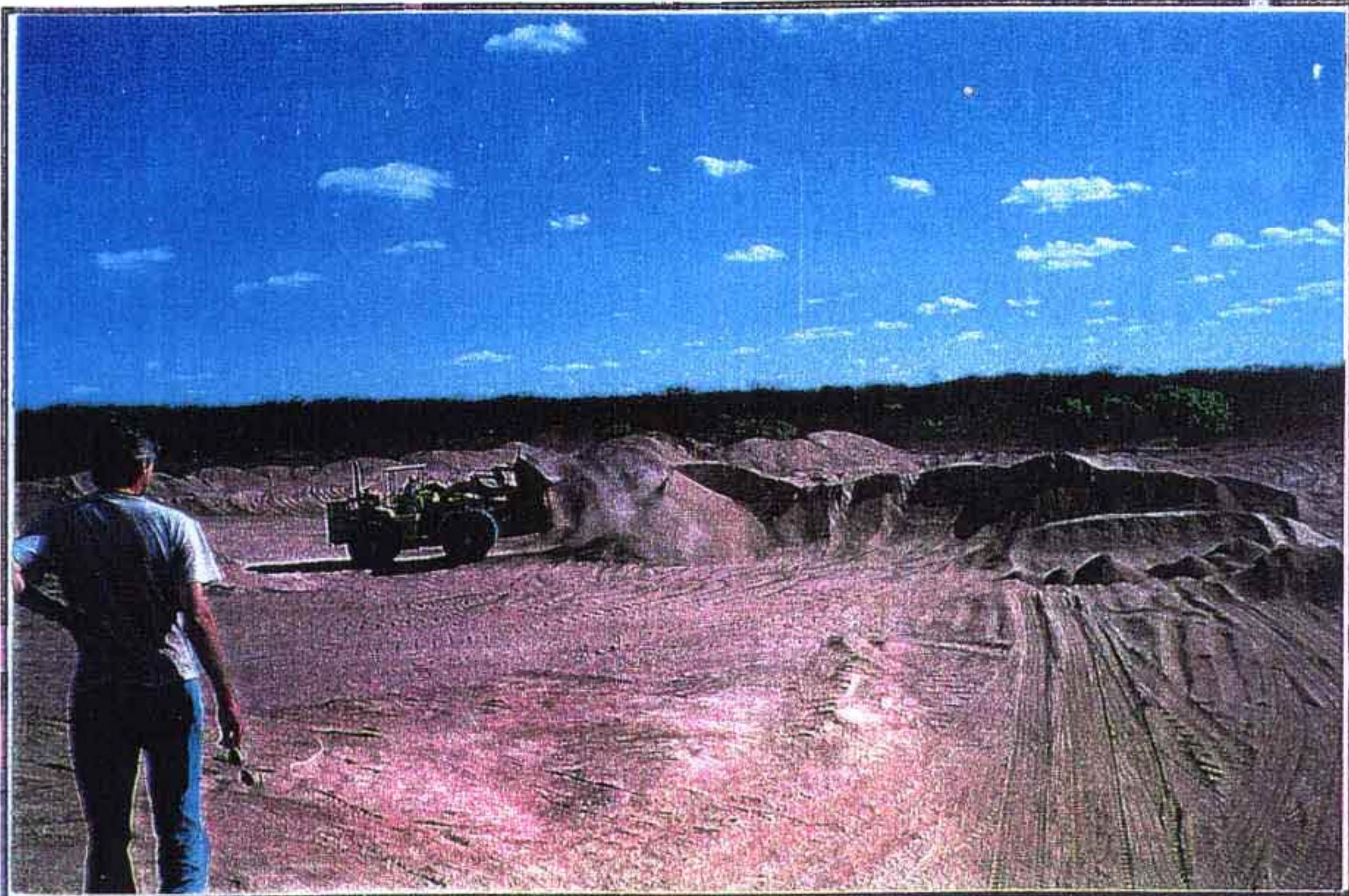
PREPARO DE AREIA PARA FILTROS HORIZONTAL E VERTICAL, NO SÍTIO TORRES.
