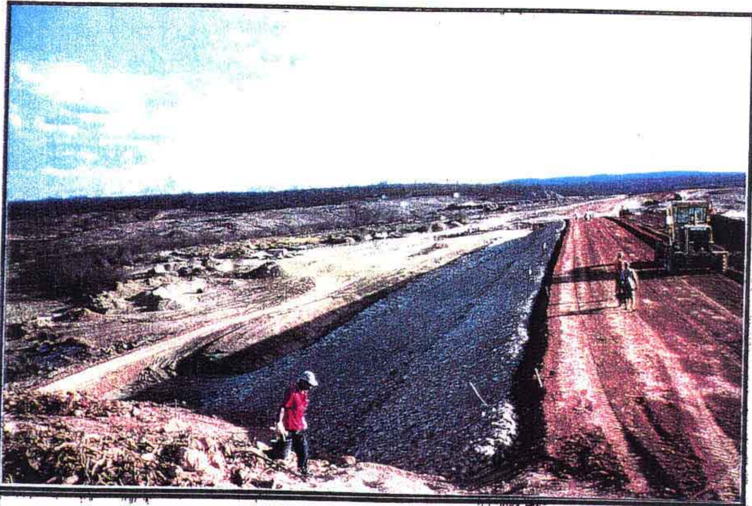
EXECUÇÃO DE CAMADA DE SOLO
