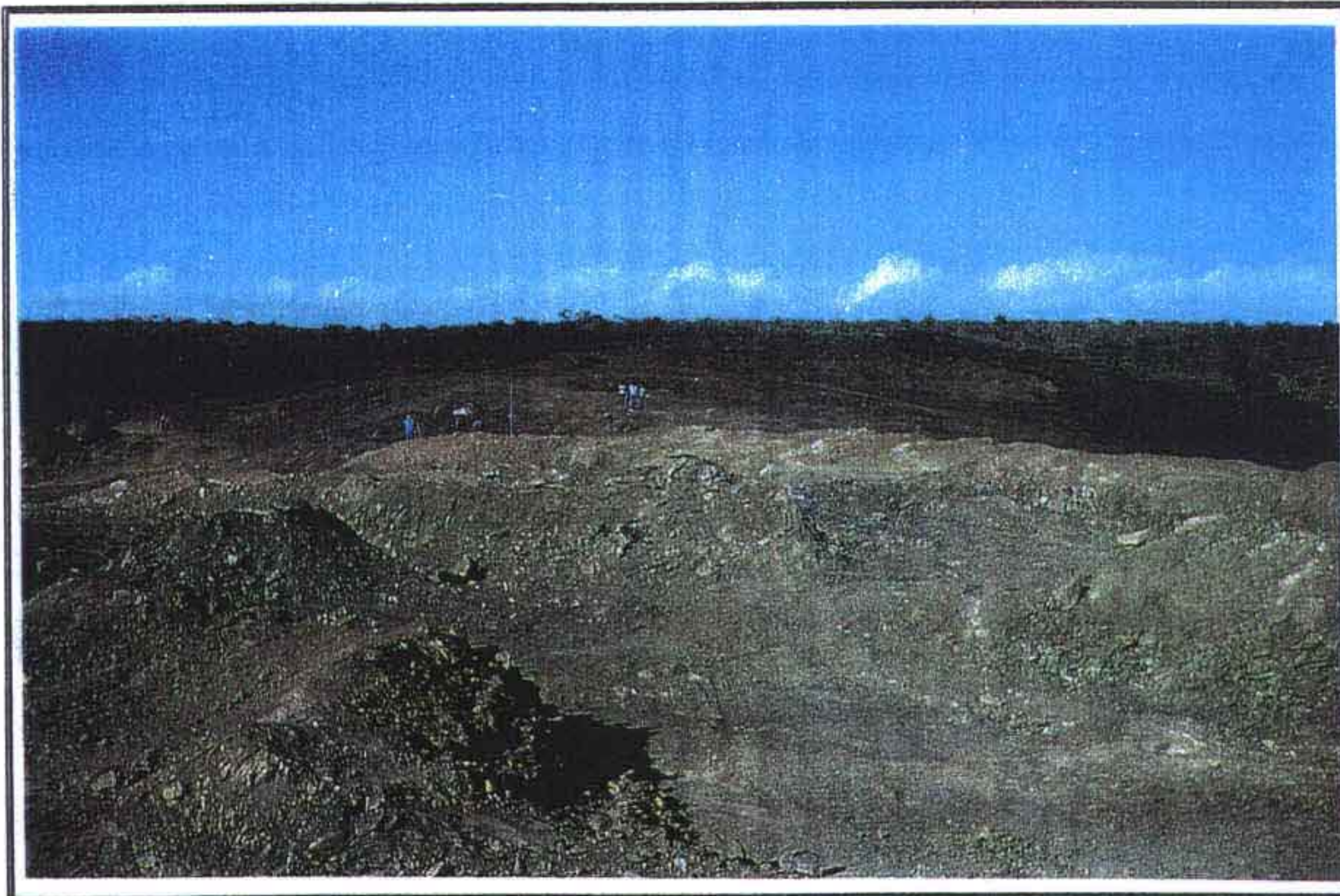
ESCAVAÇÃO DE MATERIAL DE 2ª CATEGORIA DO VERTEDOURO
