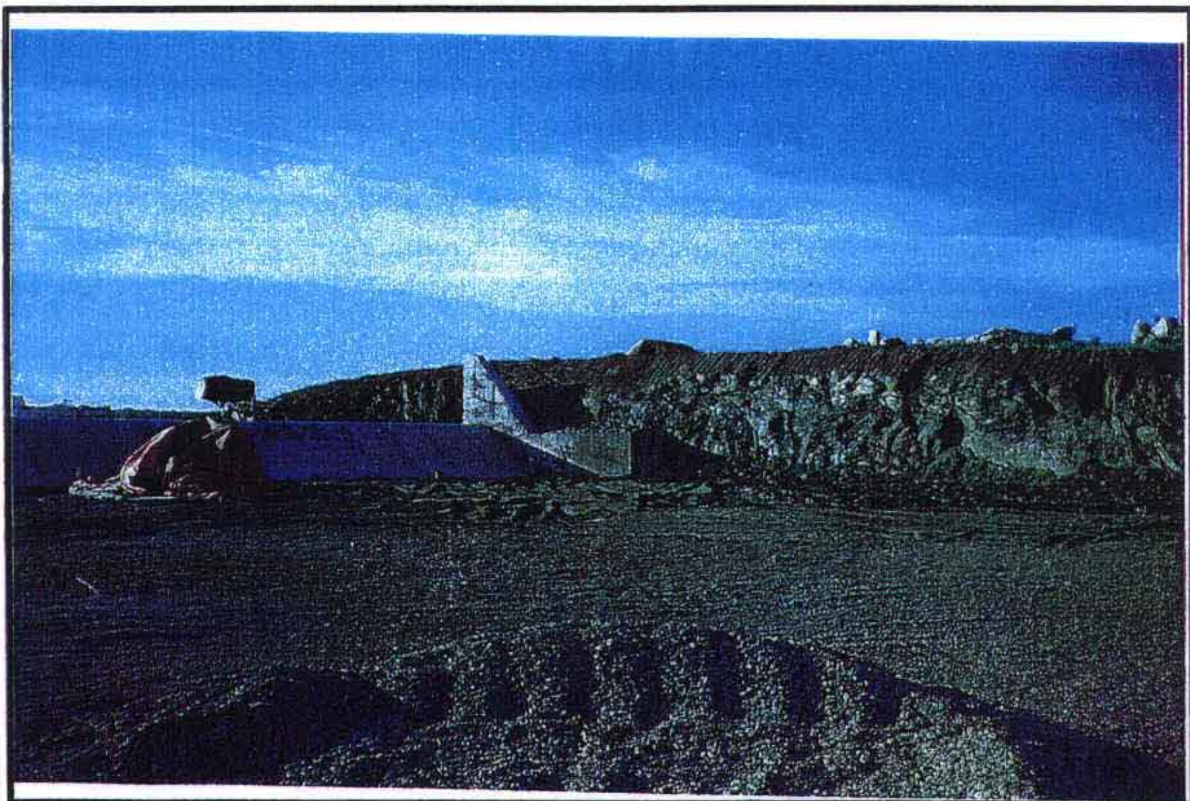
MURO DE CONTENÇÃO: CONCLUÍDO
