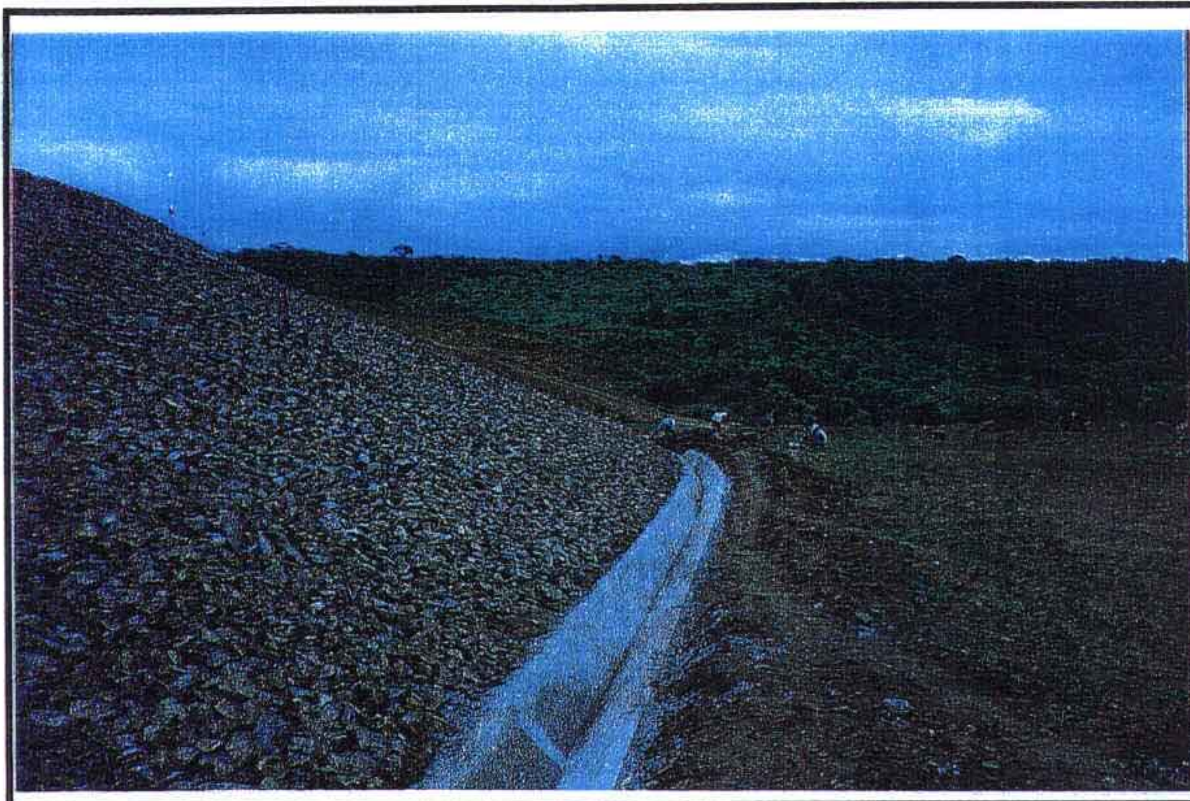
OMBREIRA DIREITA - JUSANTE: VALETA DE PROTEÇÃO
