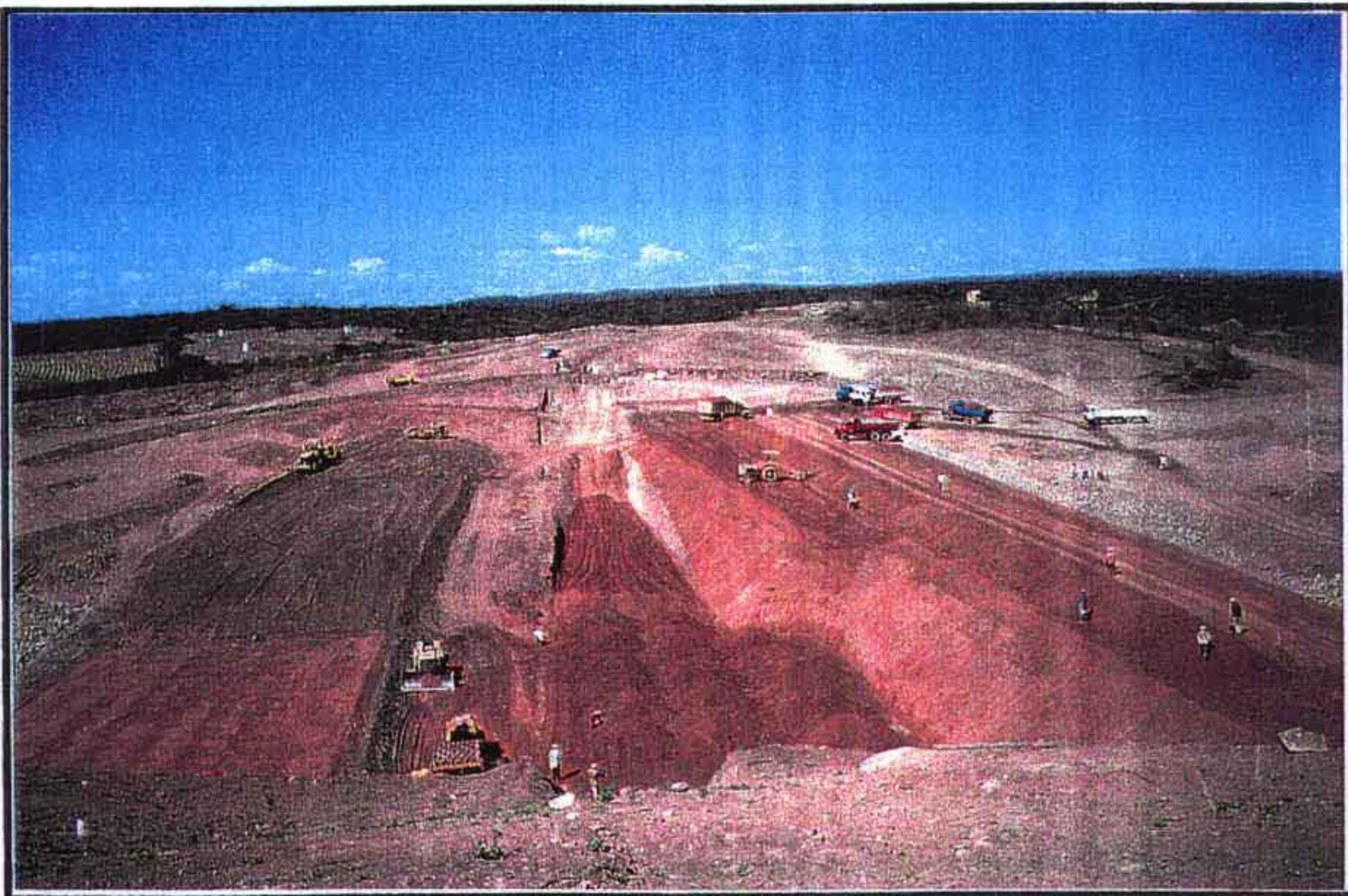
MACIÇO DA BARRAGEM – LANÇAMENTO DE SOLO NO CUT-OFF
