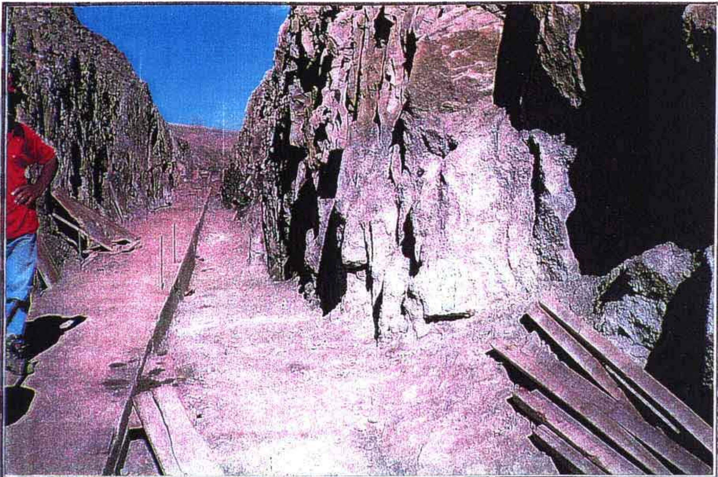
TOMADA D'AGUA : CONCRETO DE REGULARIZAÇÃO
