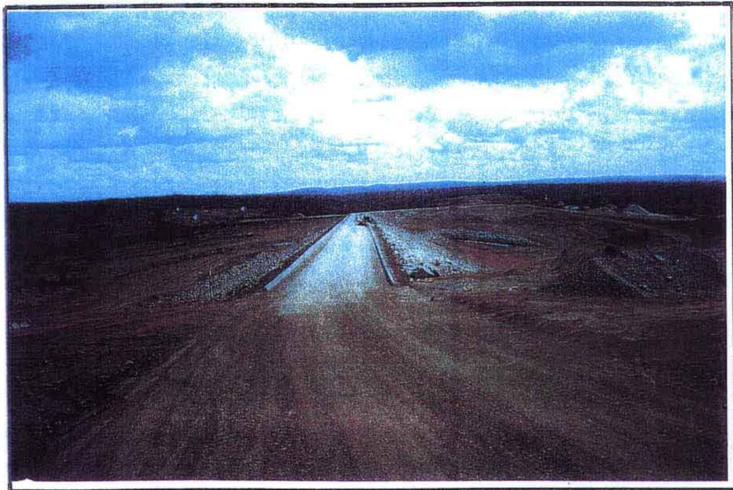
EXECUÇÃO DO MEIO-FIO
