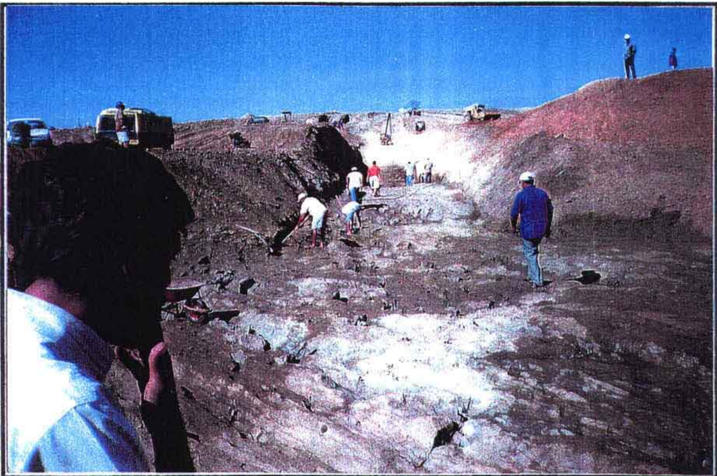
CUT-OFF – LIMPEZA DE ROCHA COM AR COMPRIMIDO
