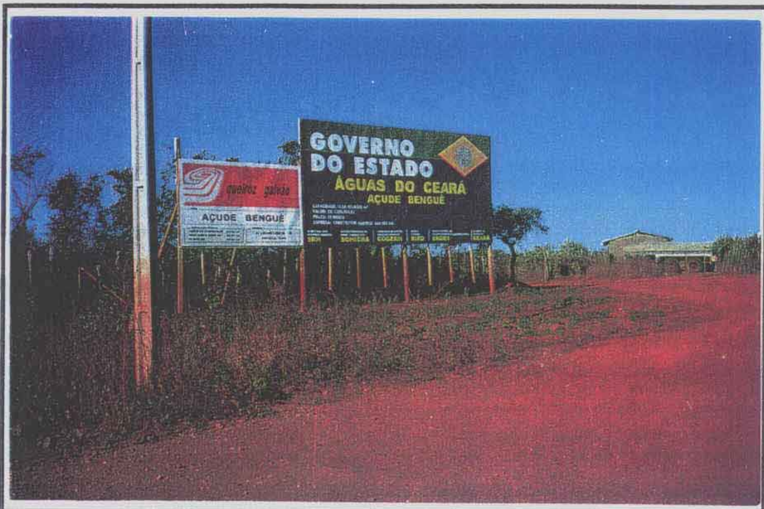
ACESSO AO CANTEIRO DE OBRAS
