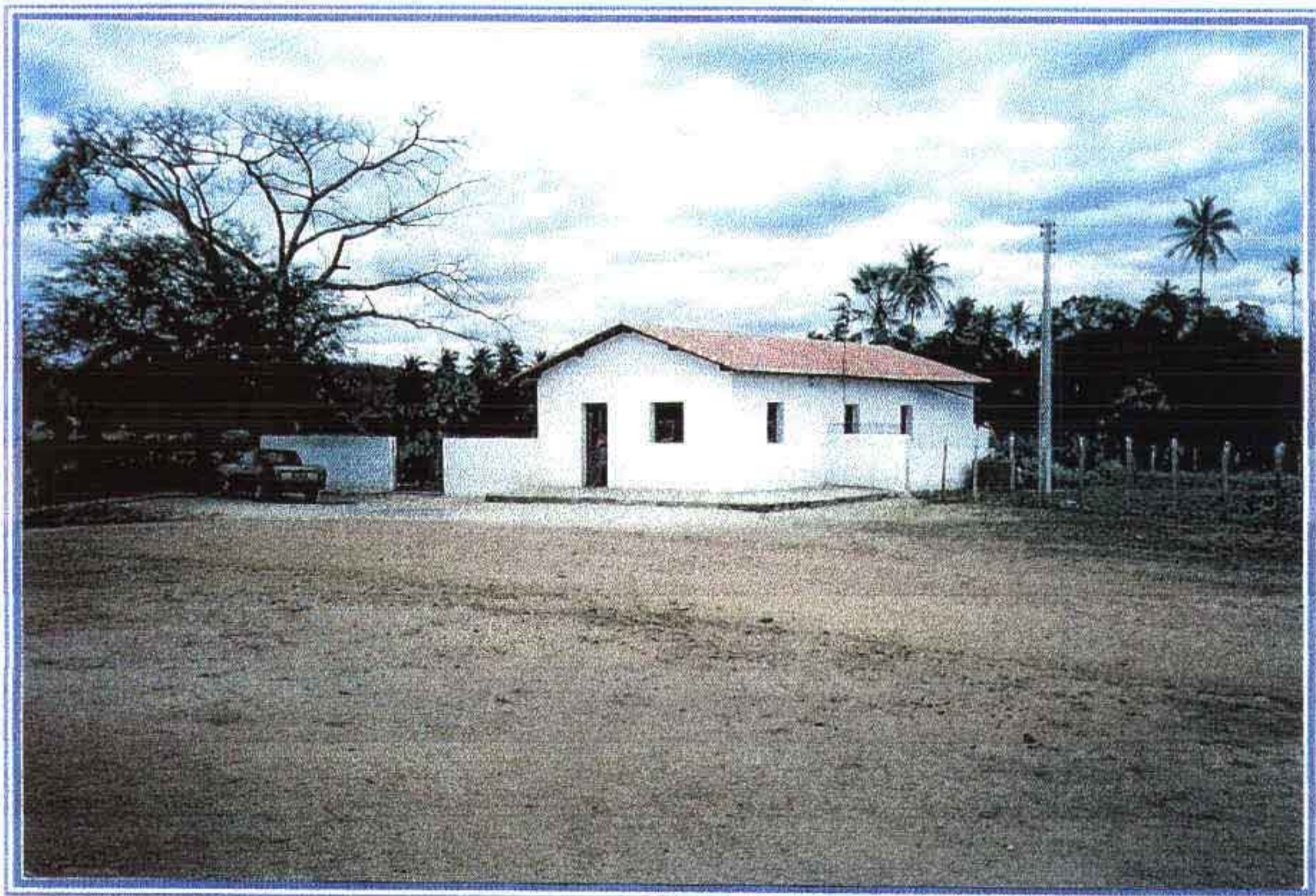
FOTO 09 | PROPRIEDADE LOCALIZADA NA ÁREA DA BACIA HIDRÁULICA.
