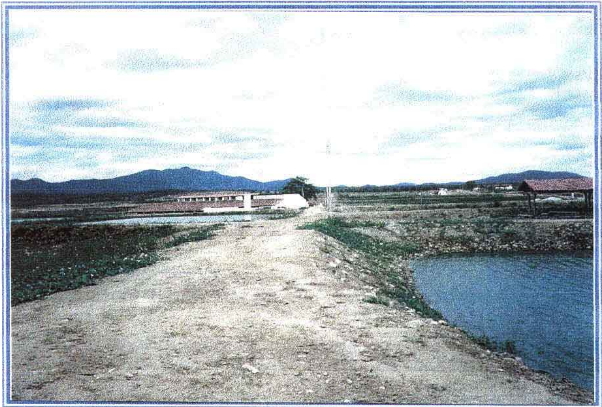
FOTO 11 | INFRA-ESTRUTURA A SER INUNDADA.
