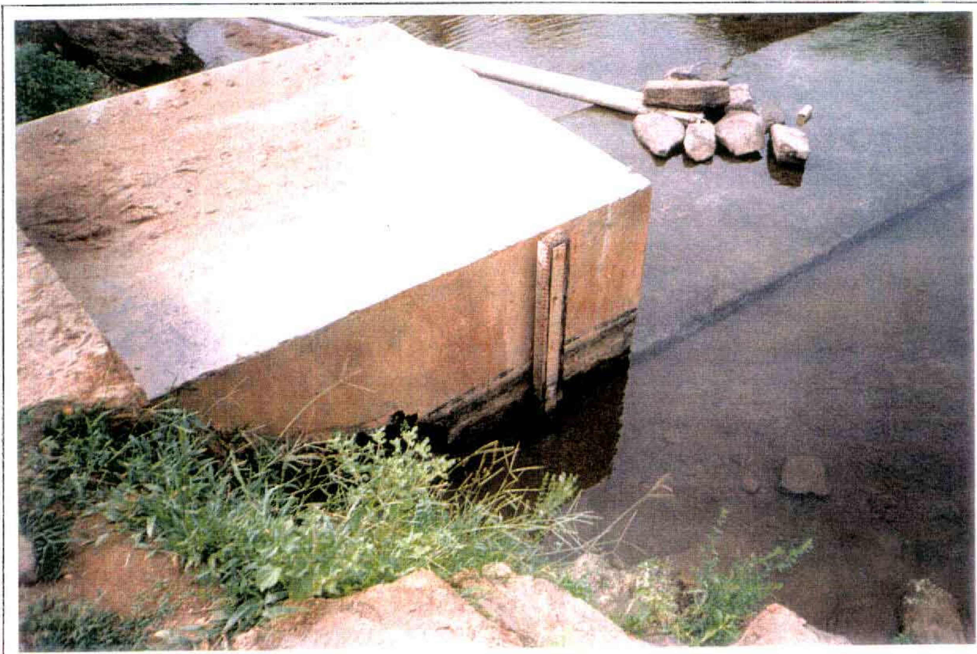
FOTO 74 - ESTAÇÃO FLUVIOMÉTRICA DO AÇUDE CAXITORÉ - CANAL DE FUGA - 1/2 Código: 3556200
