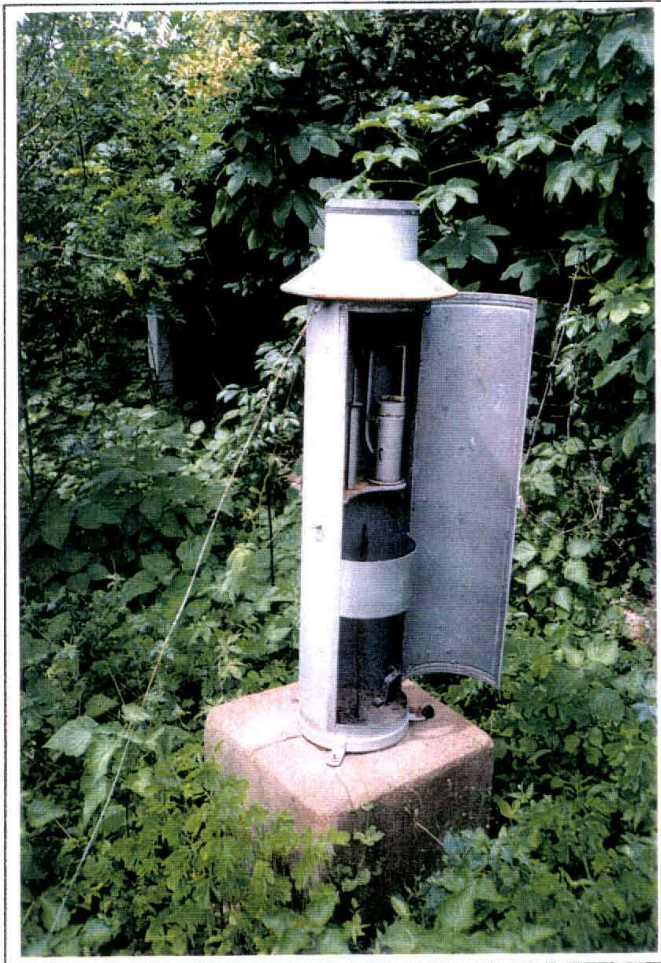
FOTO 16 - ESTAÇÃO METEOROLÓGICA DO AÇUDE GENERAL SAMPAIO - 2/4
