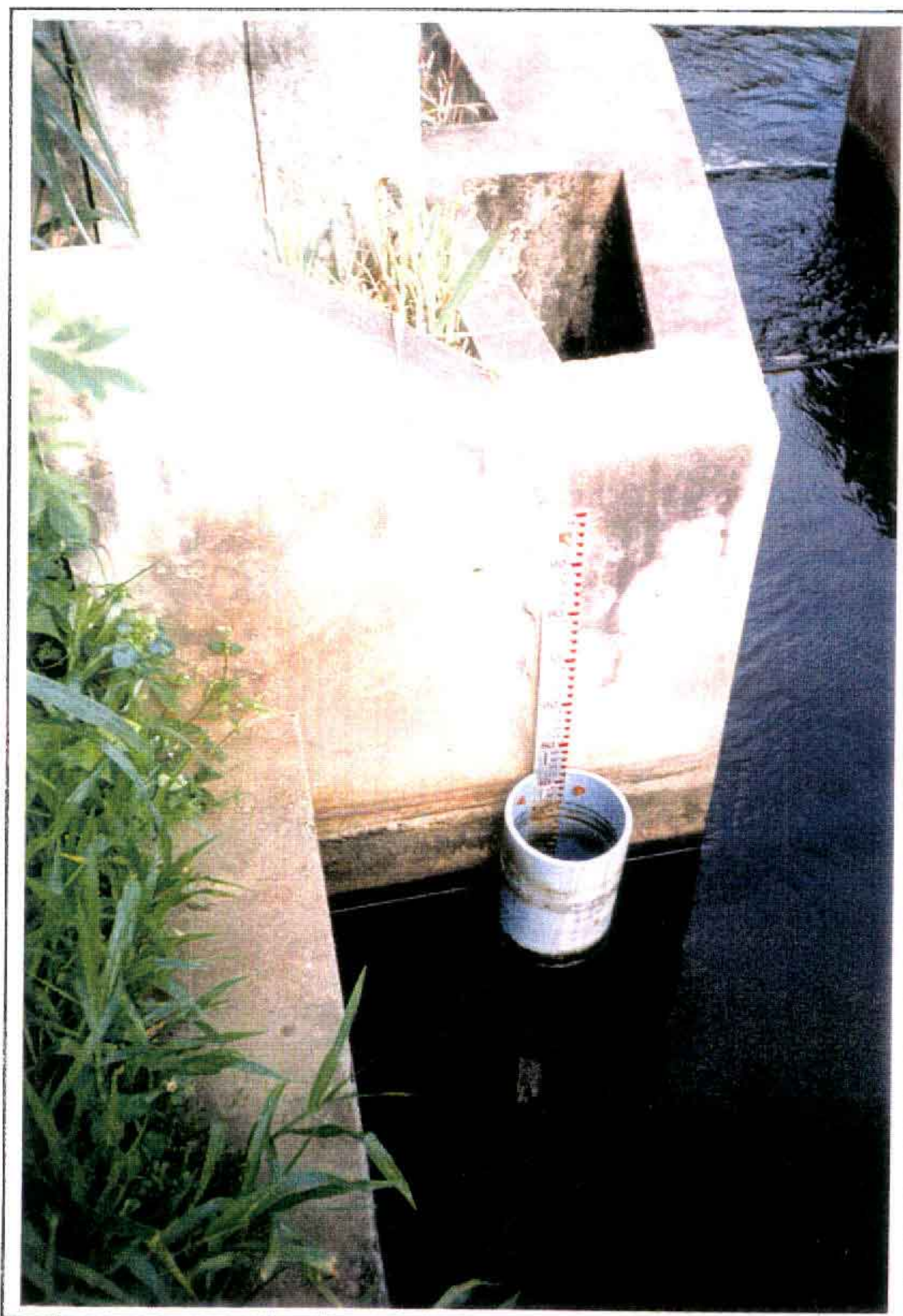
FOTO 69 - ESTAÇÃO FLUVIOMÉTRICA DO AÇUDE PEREIRA DE MIRANDA - CANAL
