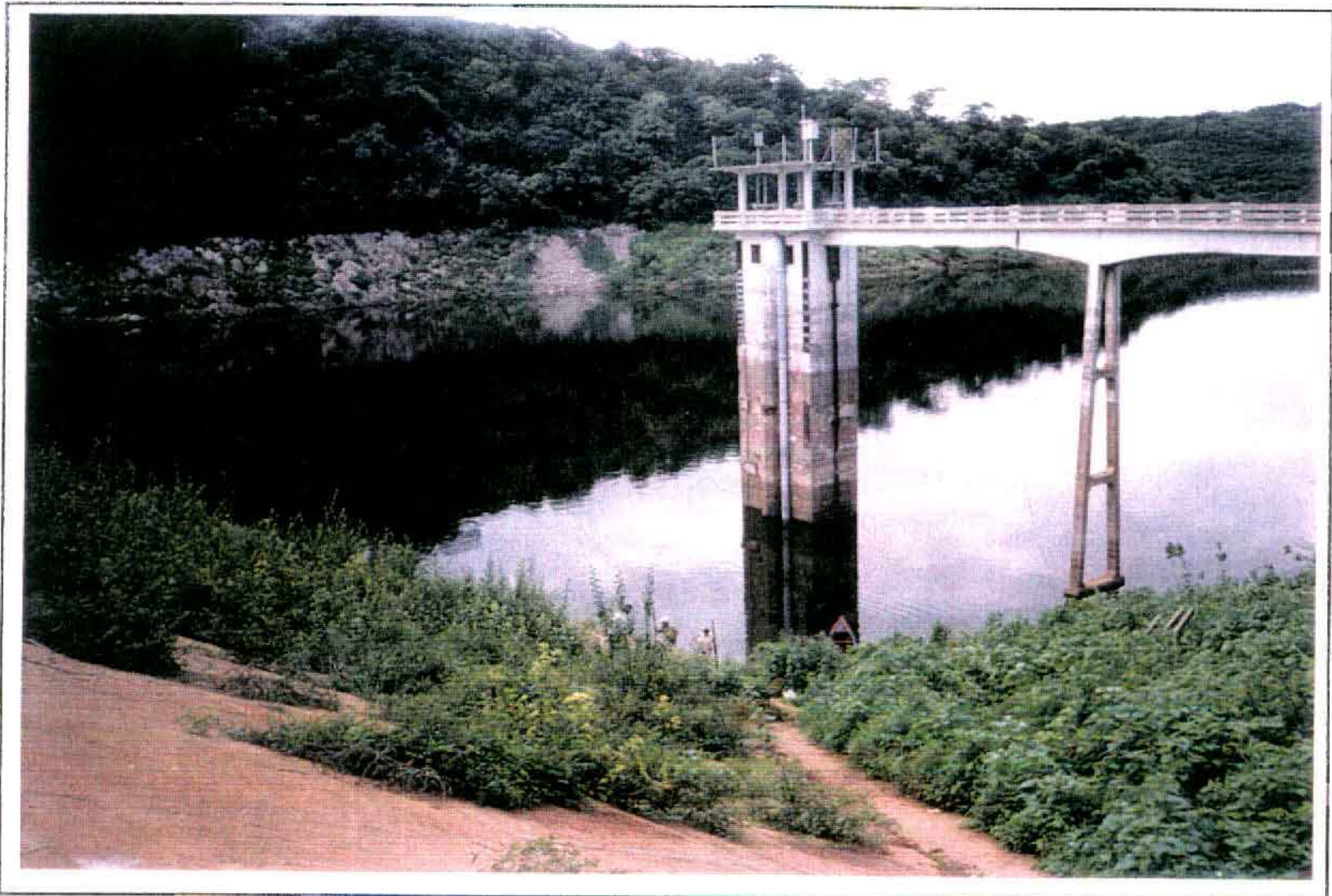
FOTO 61 - ESTAÇÃO LIMNIMÉTRICA DO AÇUDE GENERAL SAMPAIO - 3/4
