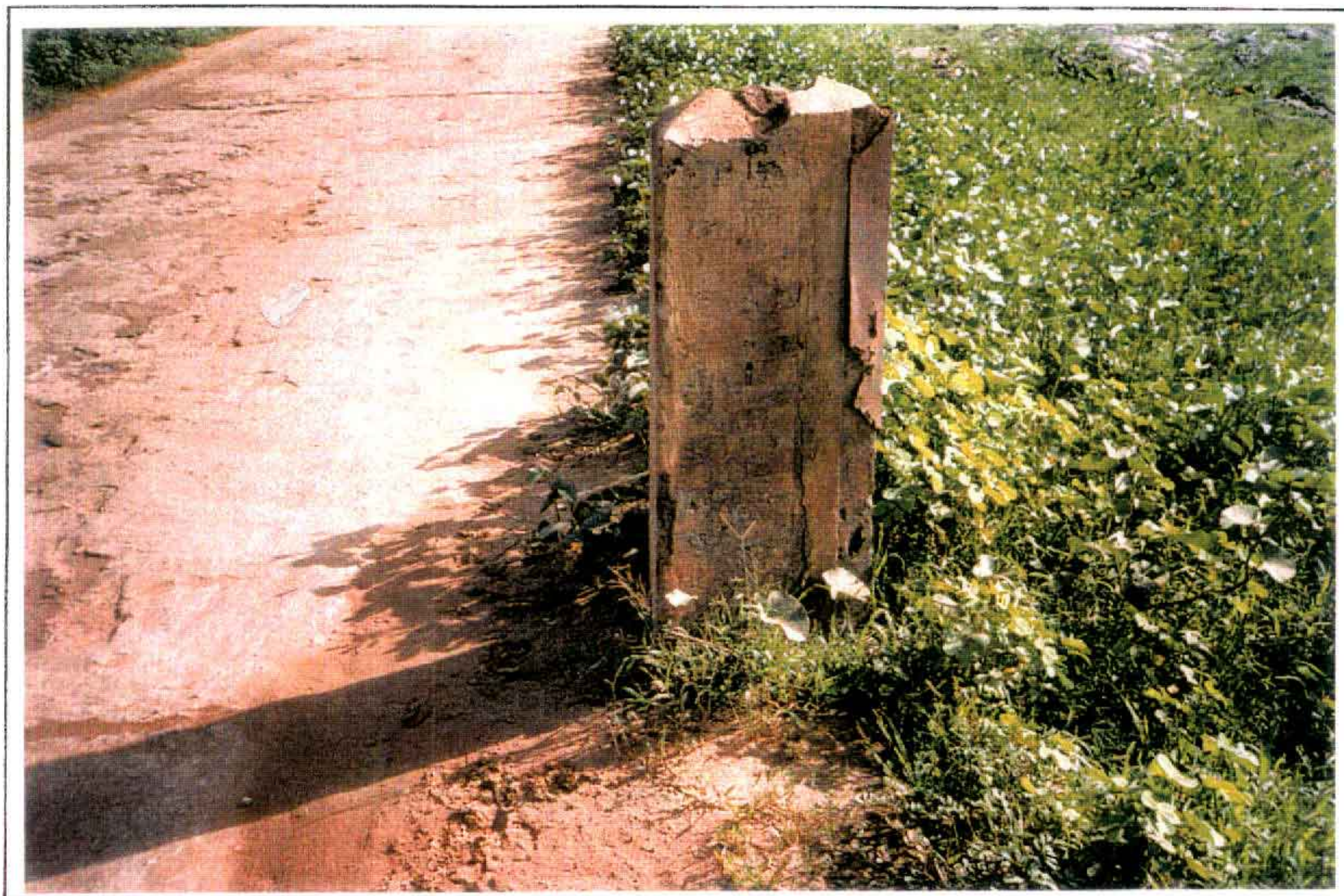
FOTO 66 - ESTAÇÃO LIMNIMÉTRICA DO AÇUDE PEREIRA DE MIRANDA - 1/3
