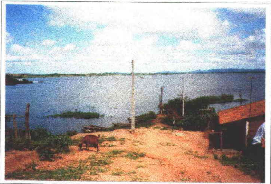
FOTO Nº 4 - LOCAL DA CAPTAÇÃO DA ADUTORA DE ICÔ NO AÇUDE LIMA CAMPOS - CE
