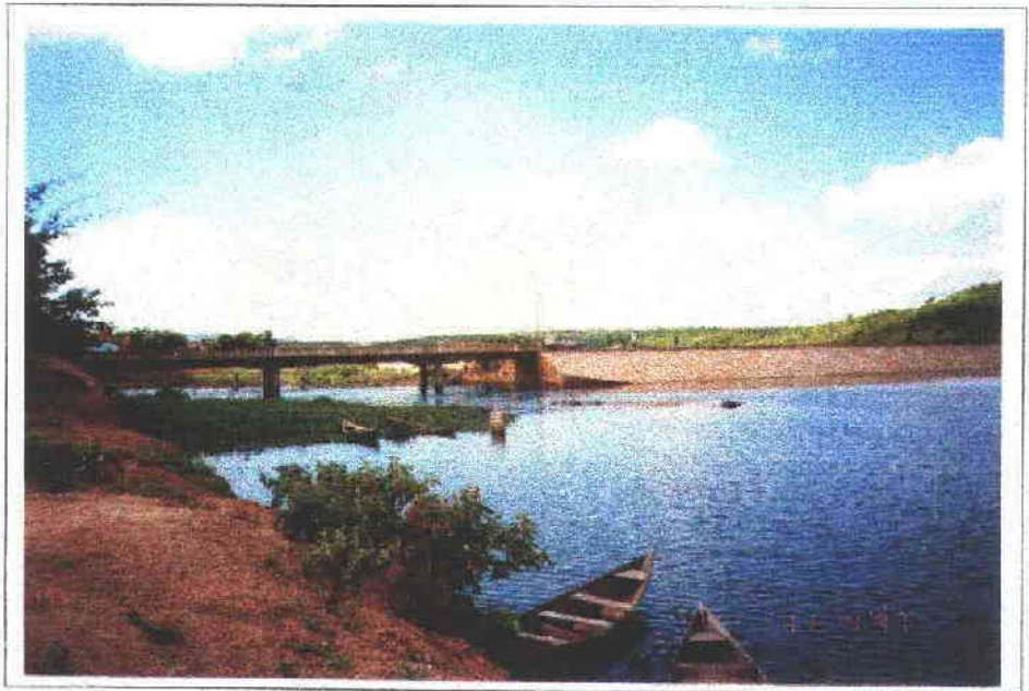
FOTO Nº 3 - DETALHE DO VERTEDOIRO DO AÇUDE LIMA CAMPOS SANGRANDO
