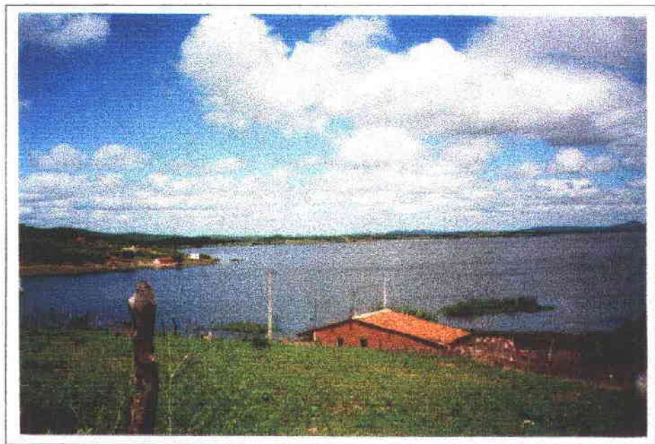
FOTO Nº 1 - AÇUDE LIMA CAMPOS - CE
