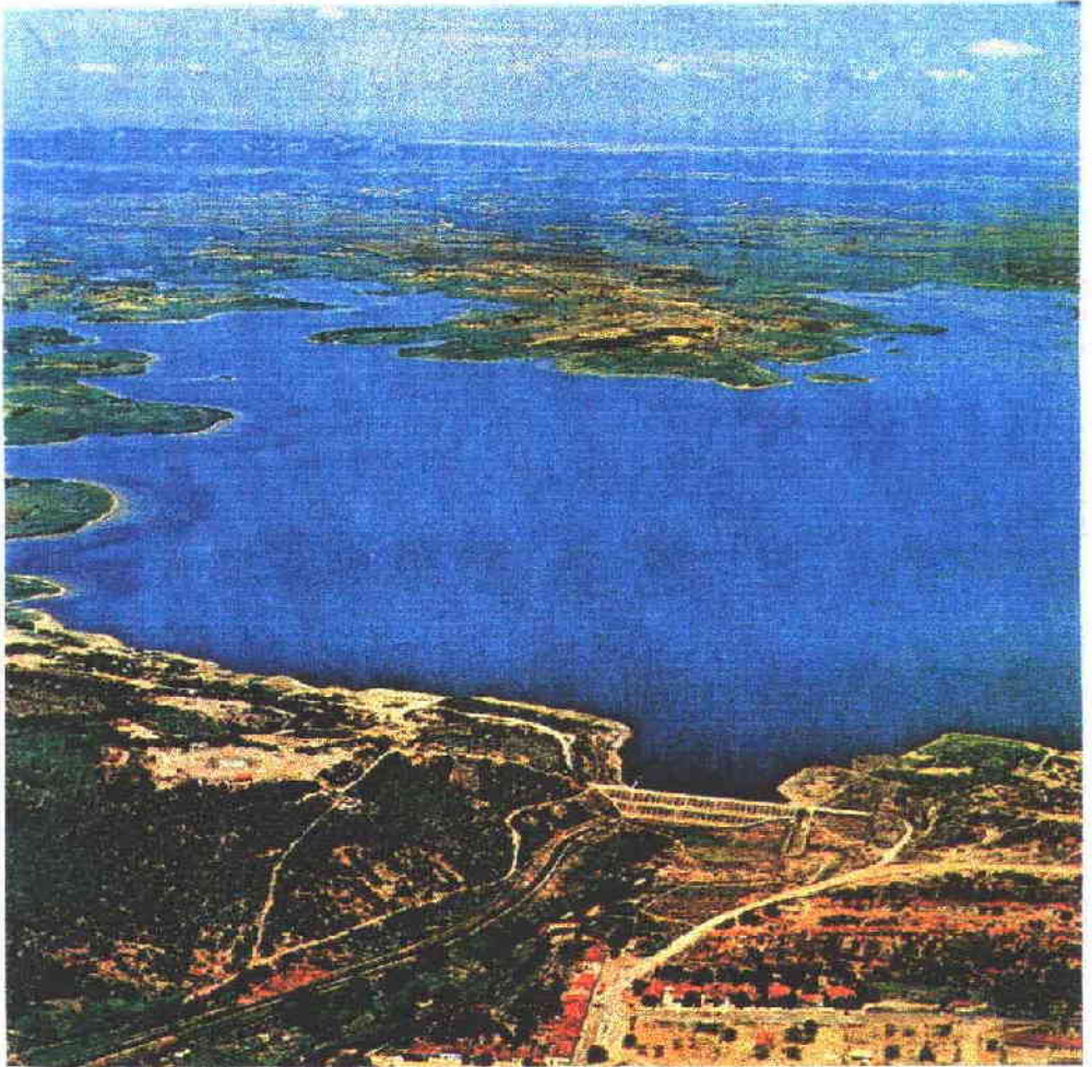
FIGURA 2.3 - VISTA DO AÇUDE LIMA CAMPOS
