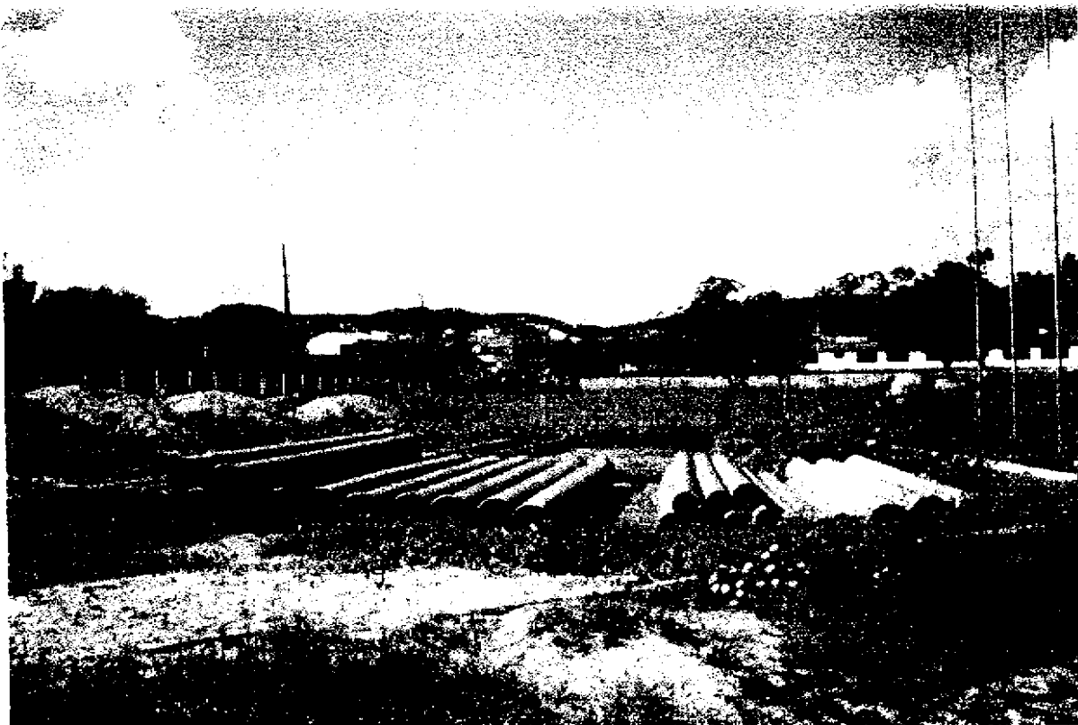
FOTO Nº 11 - LOCAL PARA A INSTALAÇÃO DA NOVA ESTAÇÃO DE TRATAMENTO DE AGUA DO MUNICIPIO DE ICO - CE.
