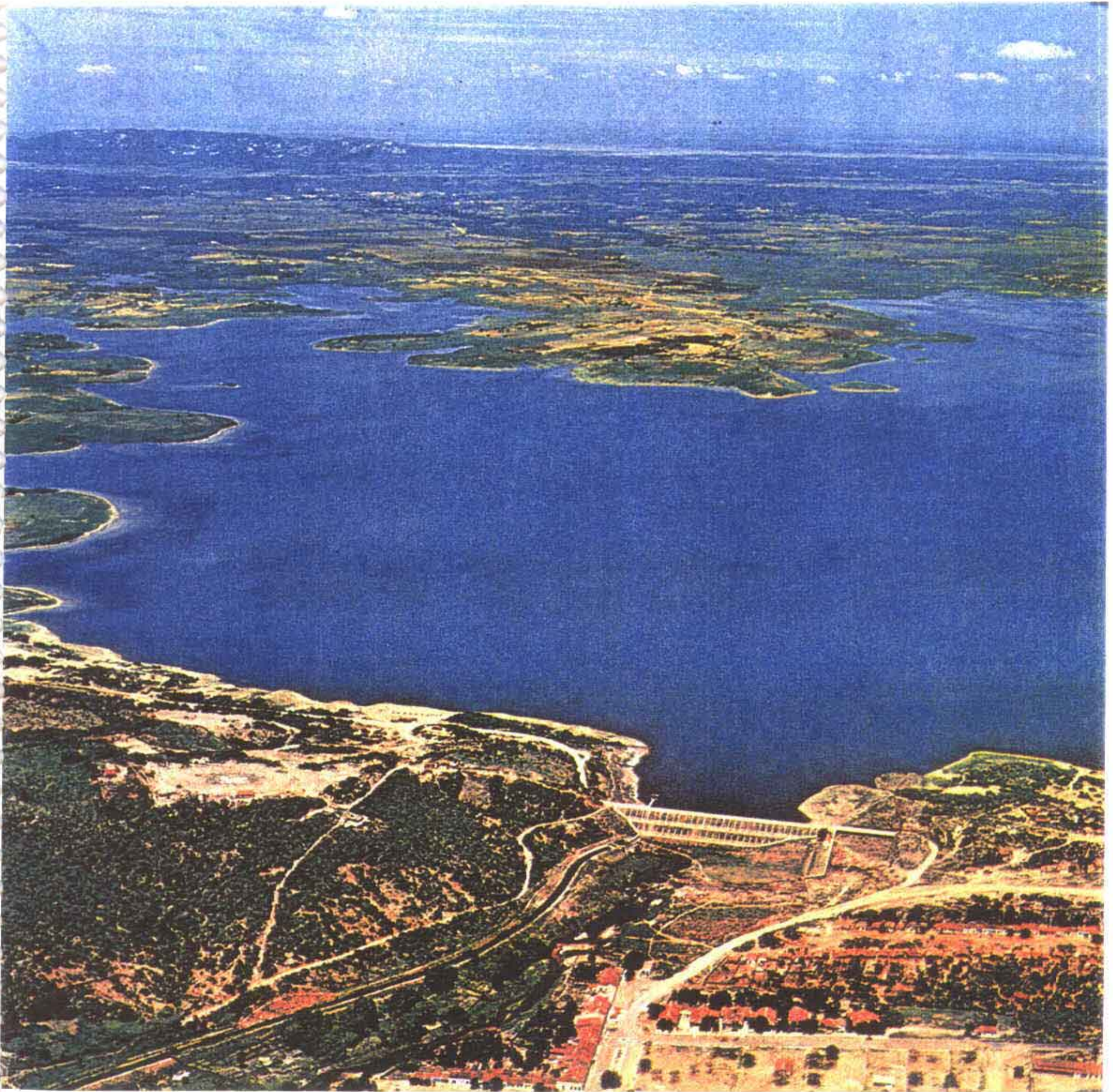
FIGURA 2.3 - VISTA DO AÇUDE LIMA CAMPOS
