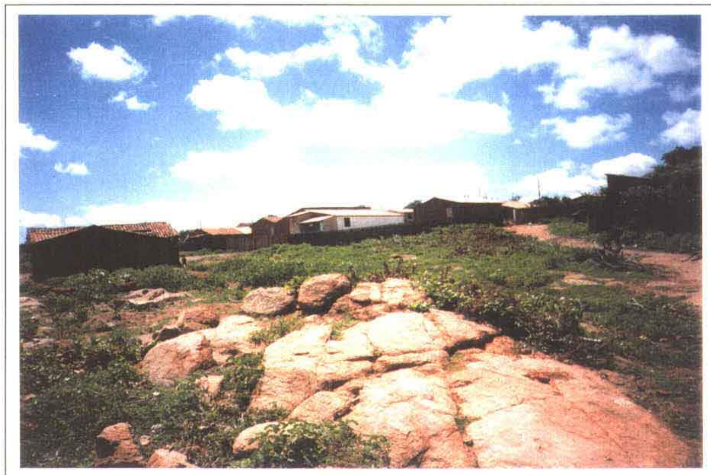
FOTO Nº 6 - LOCAL DA CAIXA DE PASSAGEM - TRECHO INICIAL DA ADUTORA POR GRAVIDADE
