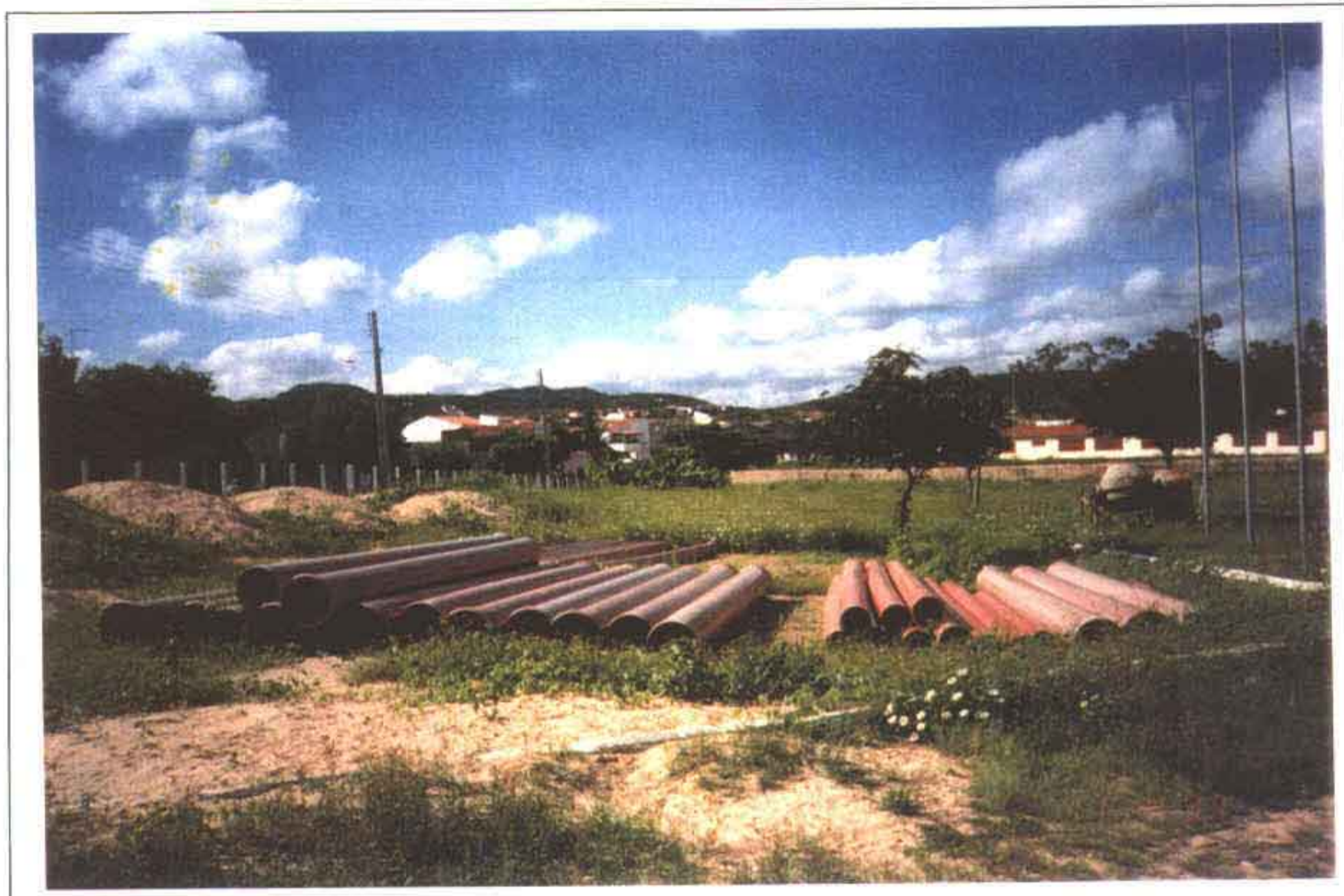
FOTO Nº 11 - LOCAL PARA A INSTALAÇÃO DA NOVA ESTAÇÃO DE TRATAMENTO DE ÁGUA DO MUNICÍPIO DE ICÓ - CE
