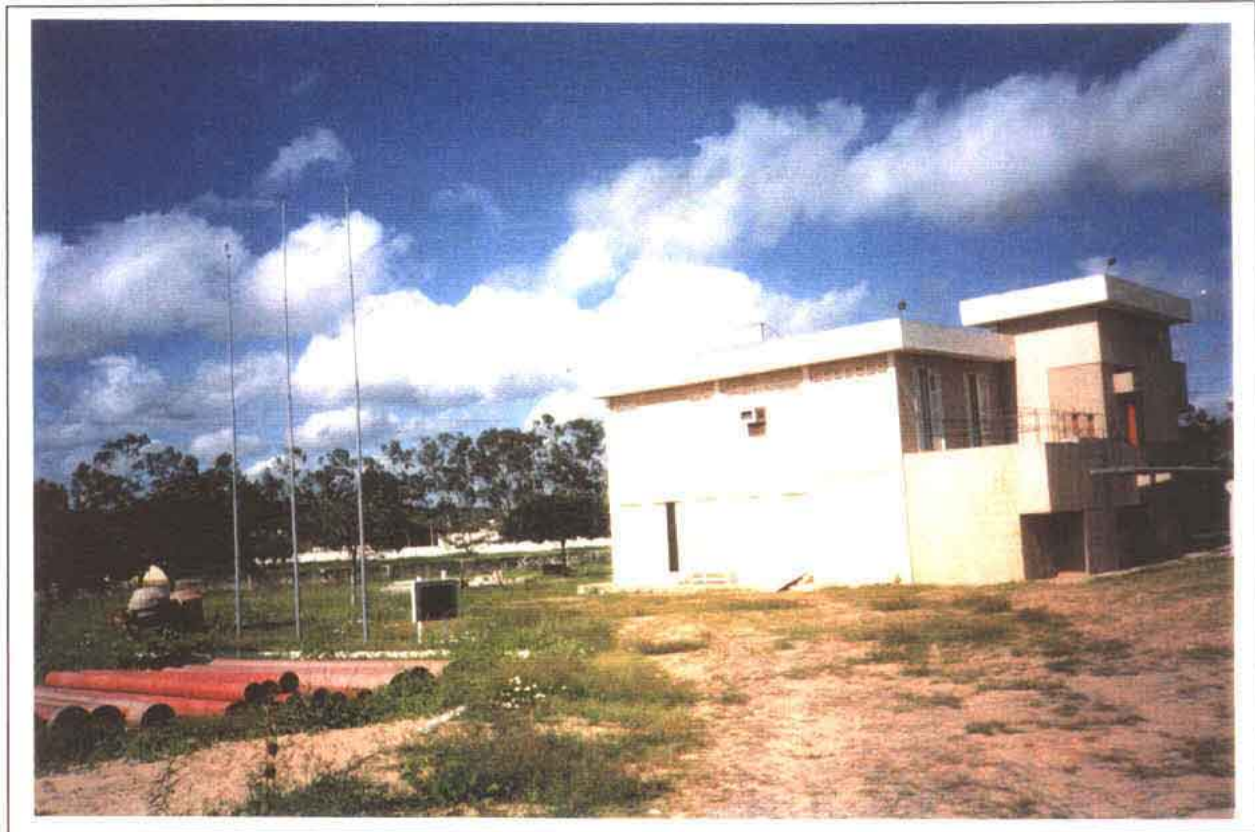
FOTO Nº 7 - ESTAÇÃO DE TRATAMENTO DE ÁGUA (ETA) DO MUNICÍPIO DE ICÓ - CE
