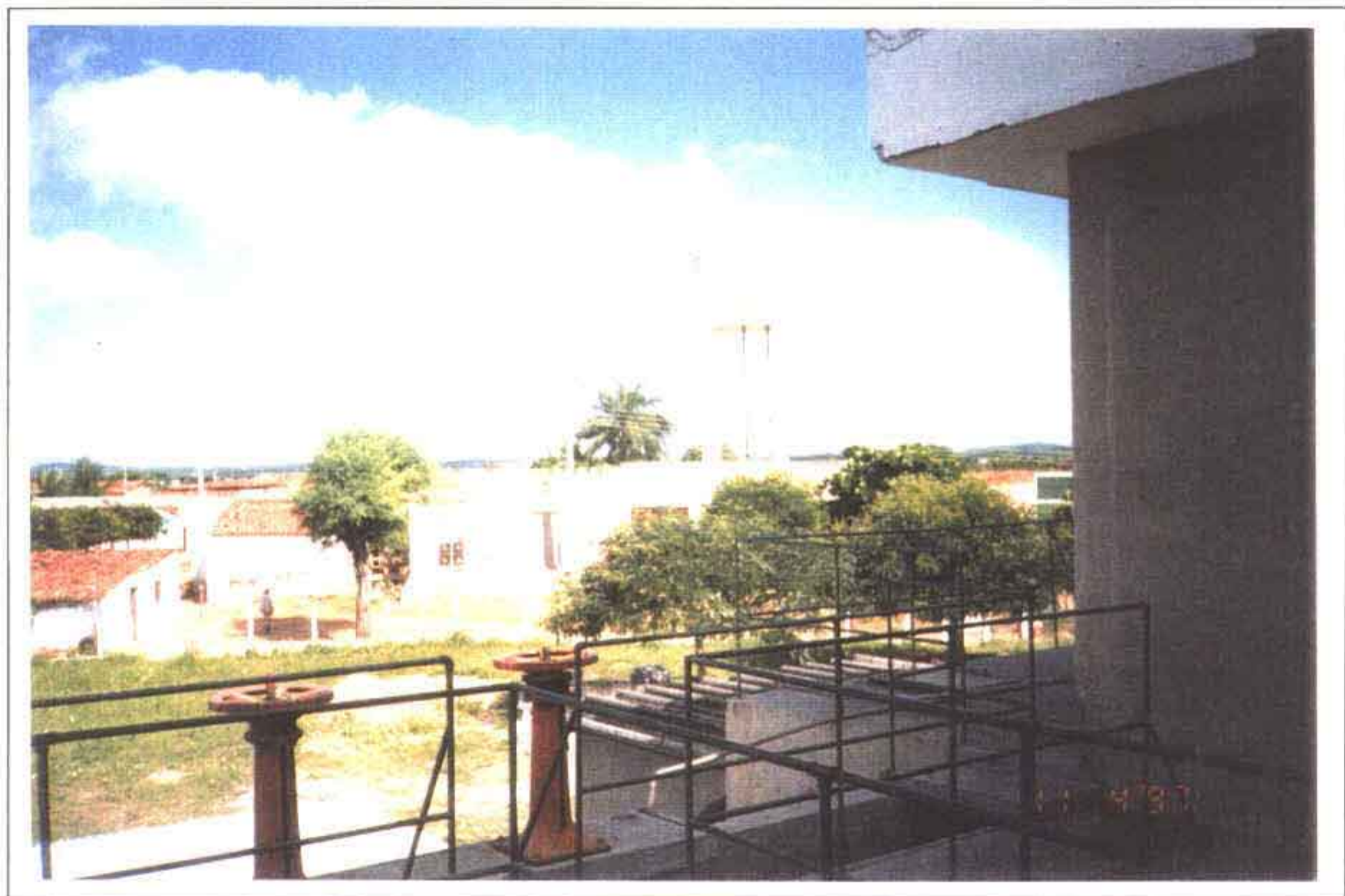
FOTO Nº 10 - RESERVATÓRIO ELEVADO DE ABASTECIMENTO DO MUNICÍPIO DE ICÓ - CE
