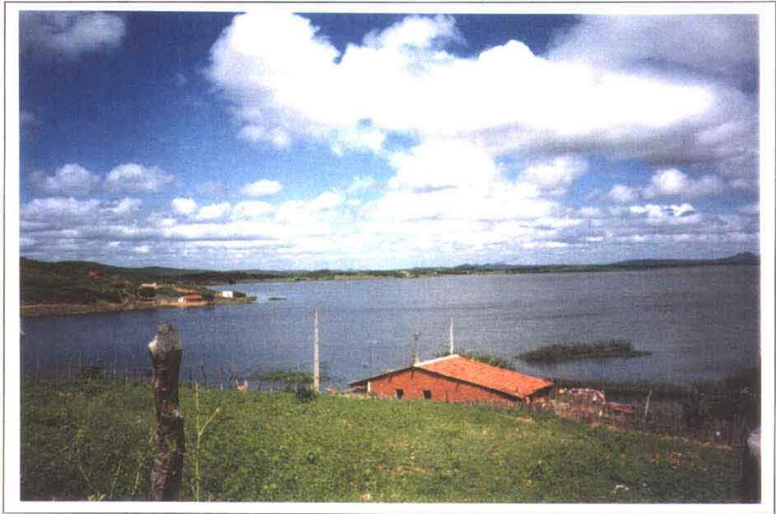
FOTO Nº 1 - AÇUDE LIMA CAMPOS - CE
