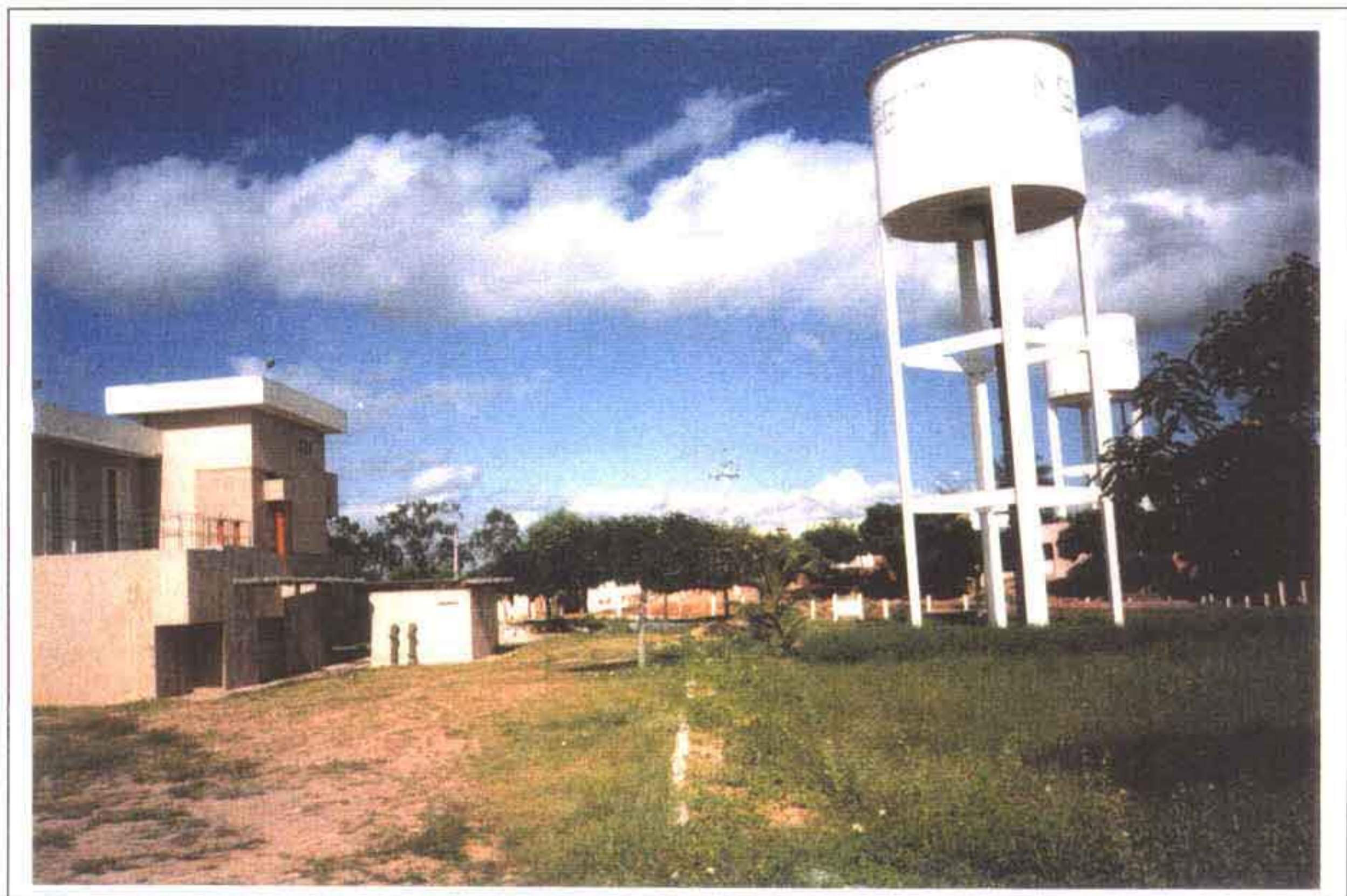
FOTO Nº 8 - ETA E RESERVATÓRIOS ELEVADOS ( EM 1º PLANO RESERVATÓRIO P/ LAV. FILTROS E AO FUNDO RESERVATÓRIO DE ABASTECIMENTO)
