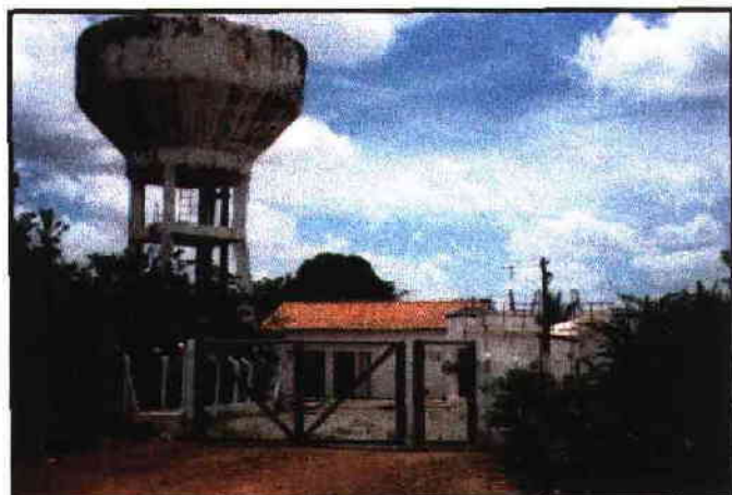
FOTO 03 - ESTAÇÃO DE TRATAMENTO D'ÁGUA DO SISTEMA IPAGUASSÚ - MIRIM / MASSAPÉ (VÊ-SE NO DETALHE O RESERVATÓRIO ELEVADO DE ÁGUA TRATADA ONDE SERÁ FEITA A CAPTAÇÃO DA ADUTORA DE ARRAIAI).
