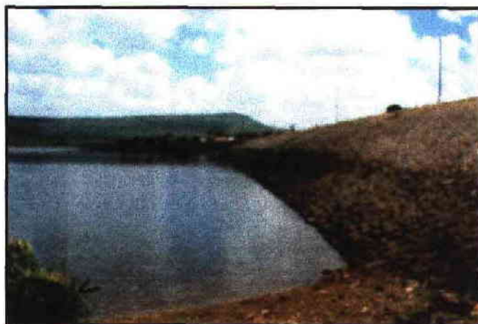
FOTO 01 - AÇUDE ACARAÚ - MIRIM (VISTA DO TALUDE DE MONTANTE DA BARRAGEM)
