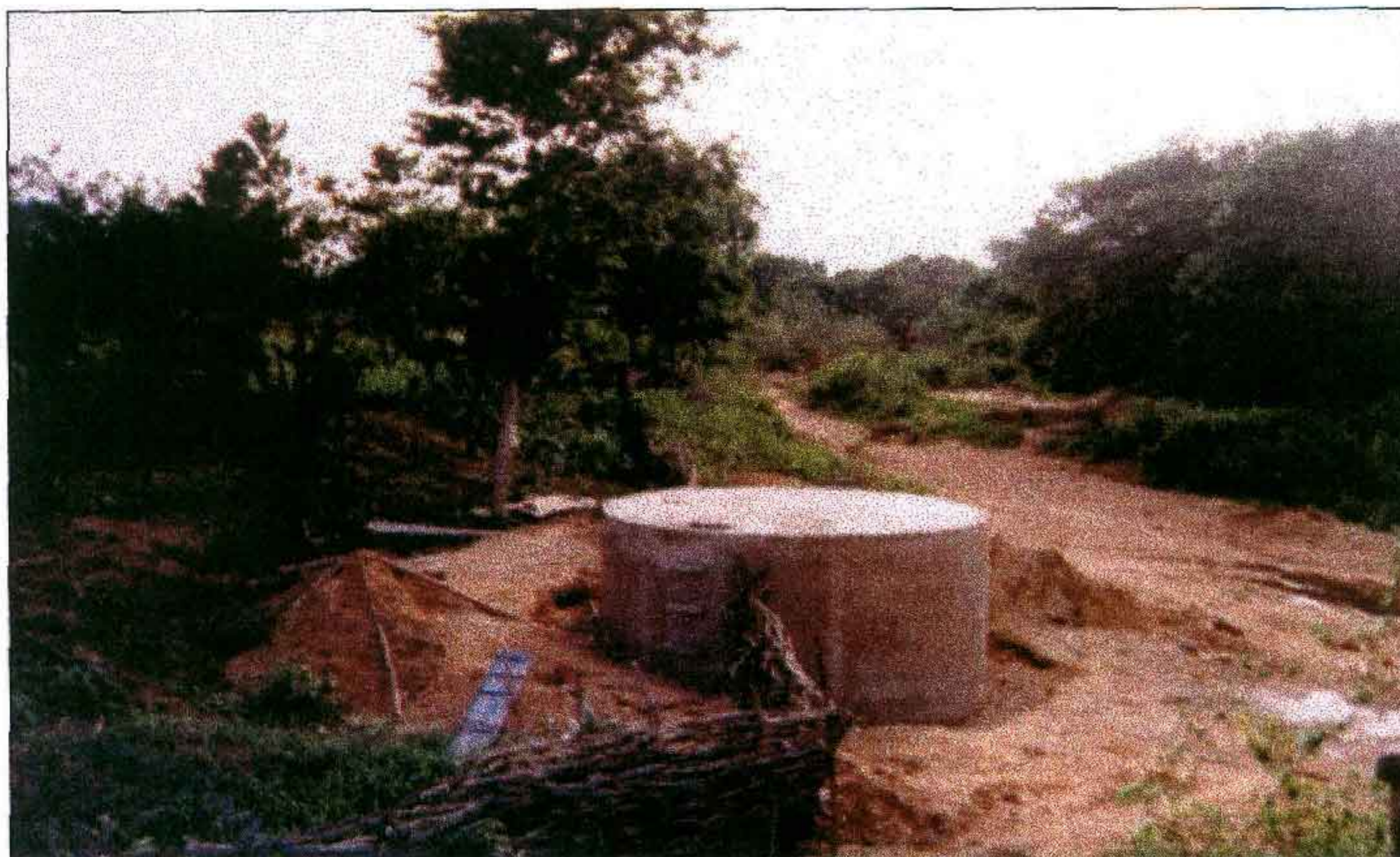
Foto – 01 – Vista do poço onde será implantada a Estação de Bombeamento.
