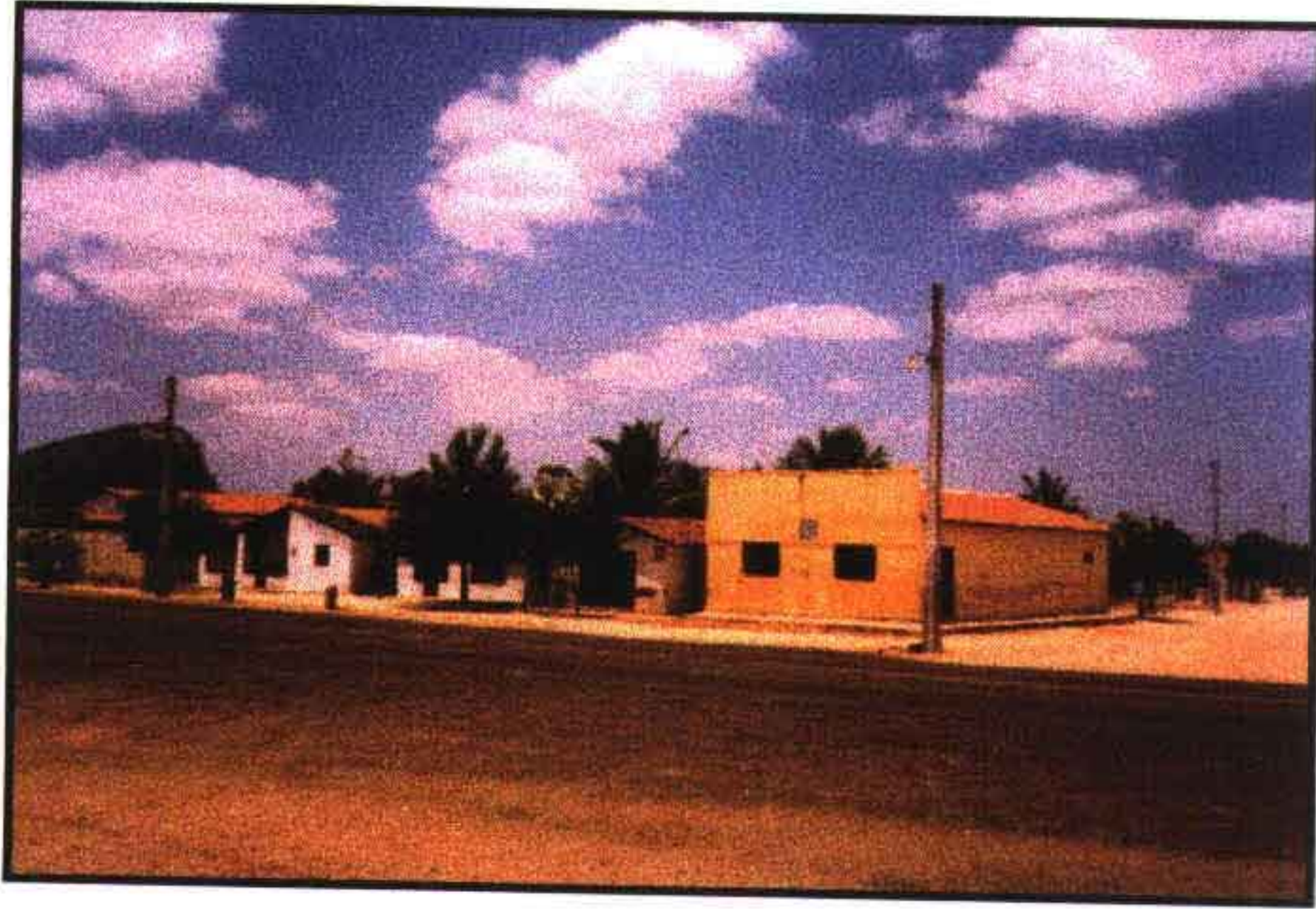
FOTO 01 – VISTA GERAL DO POVOADO DE PLACAS
