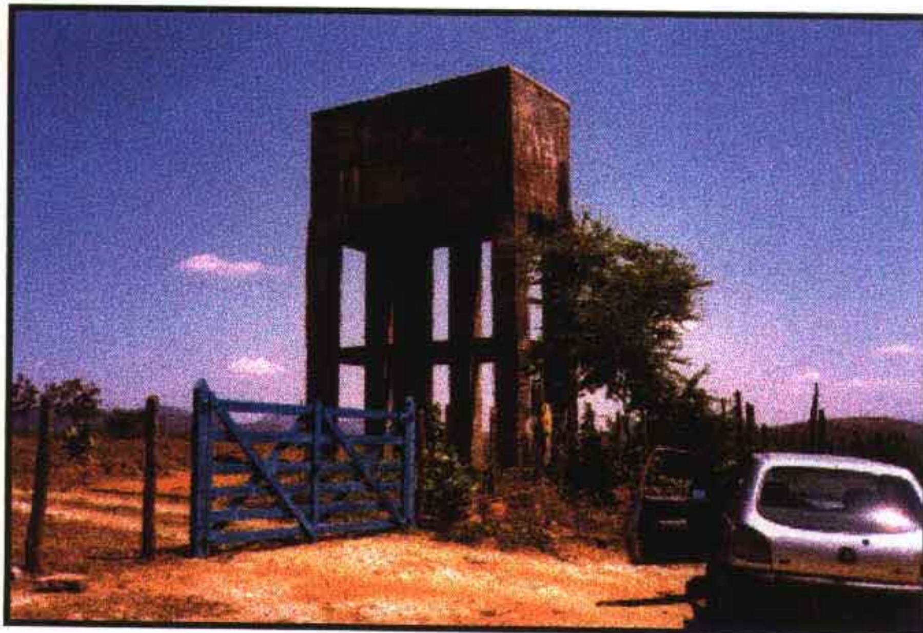
FOTO 05 – RESERVATÓRIO ELEVADO DA FAZENDA NORMAL
