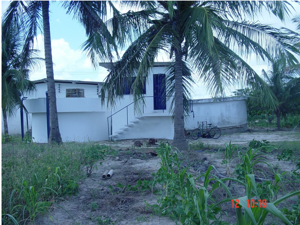
FOTO 9 – Vista do reservatório de reunião de 50m 3 , ao lado a estação de bombeamento, atrás, o RAP de 200m 2 e casa de química.
