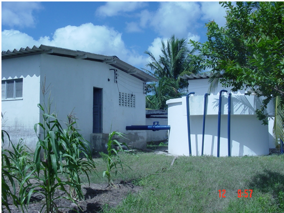
FOTO 12 – Detalhe das entradas de água bruta provenientes dos poços amazonas e tubulares da captação.
