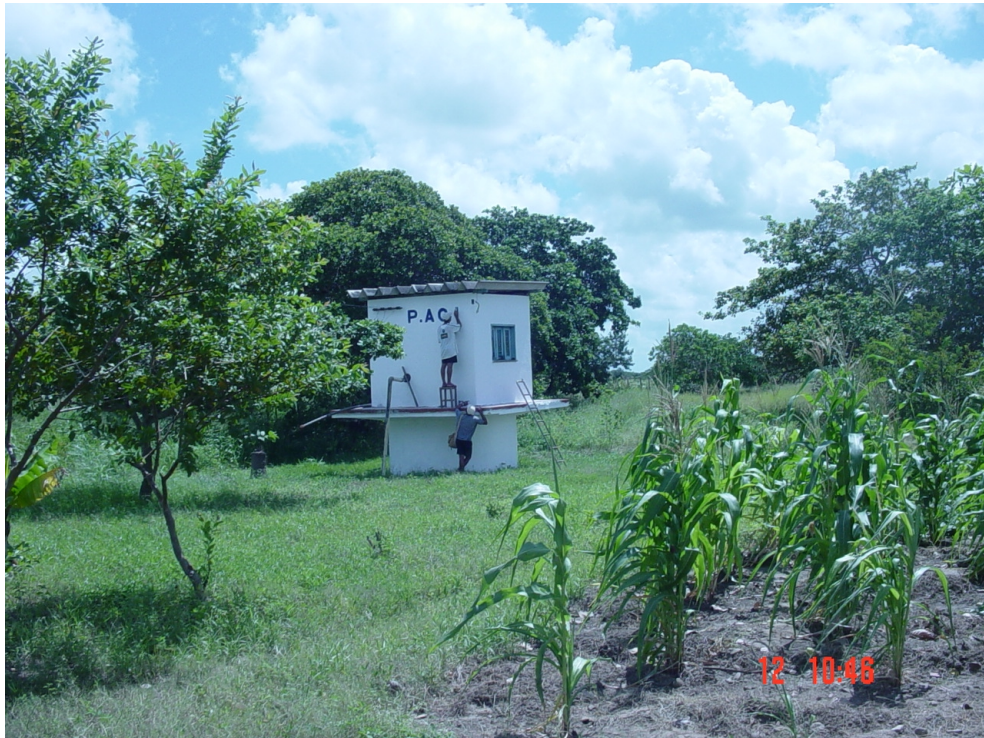
FOTO 3 – Poço amazonas localizado dentro da área da ETA
