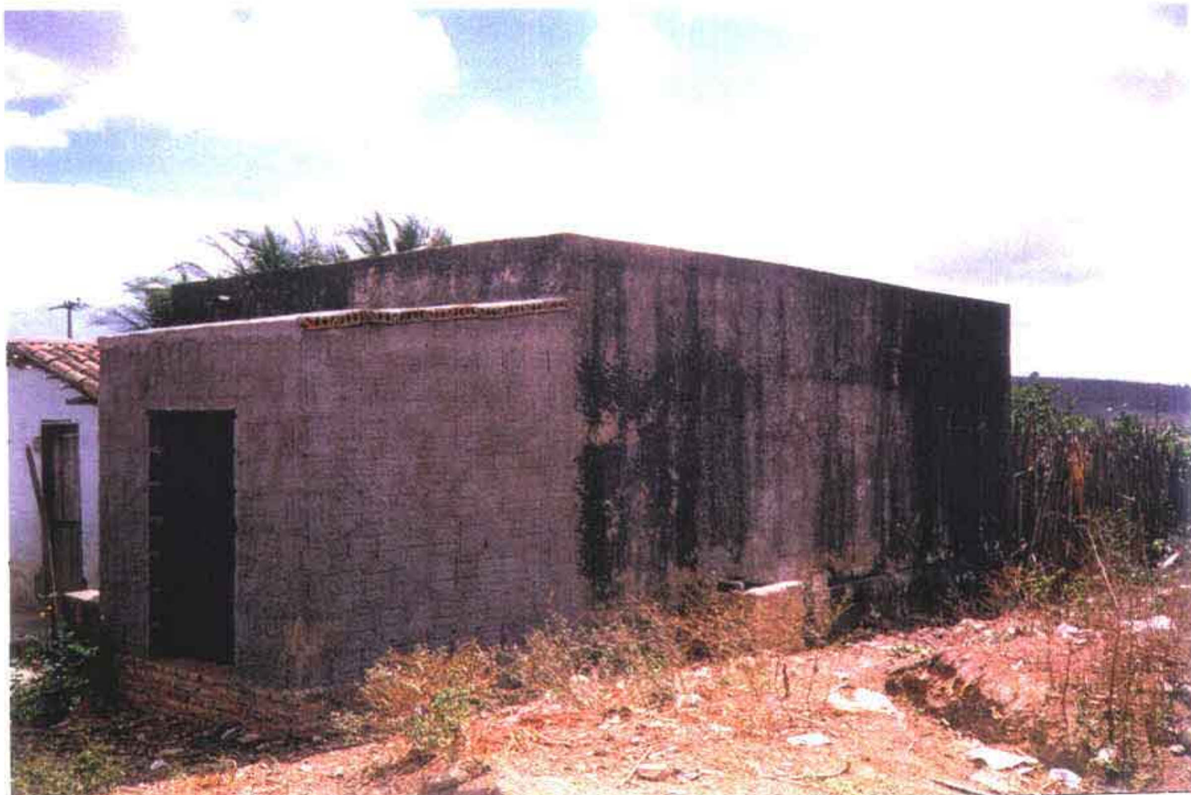
FOTO 6 - RESERVATÓRIO APOIADO EXISTENTE (CAPACIDADE DE ARMAZENAR 60 m 3 )
