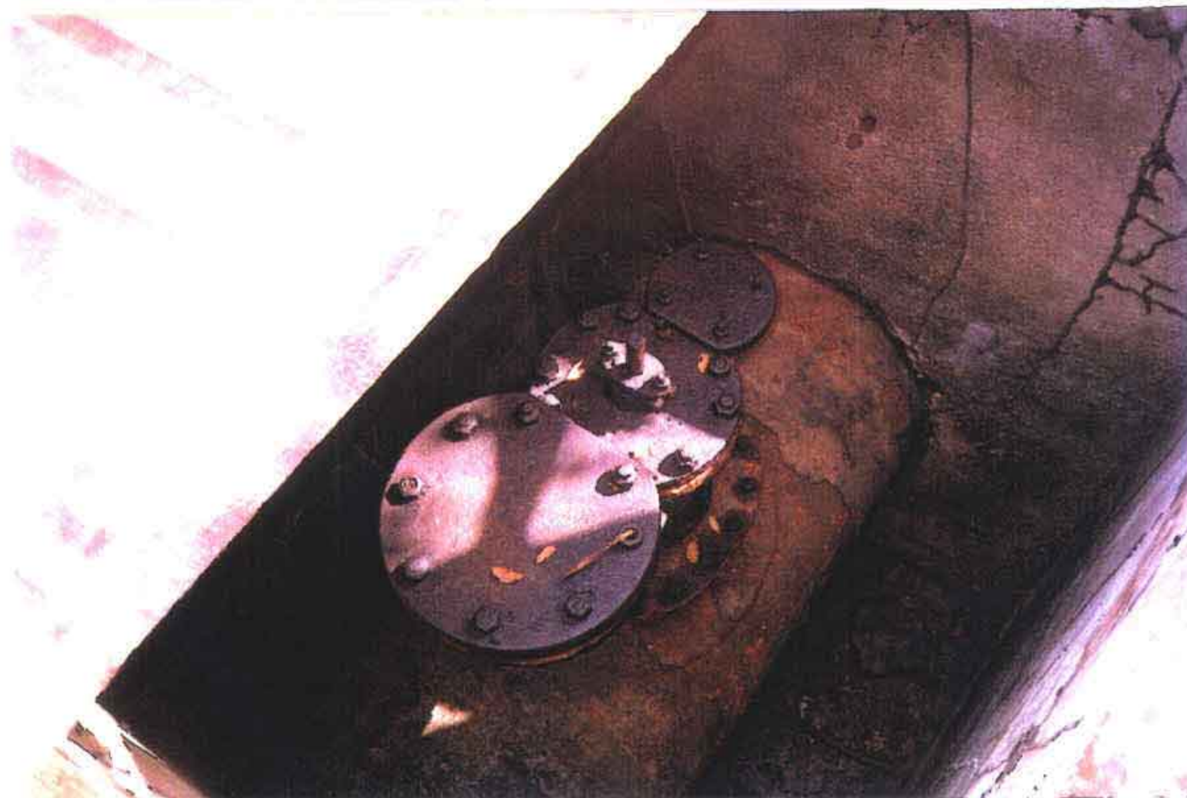
FOTO 2 - VISTA SUPERIOR DA CAIXA Nº 133 - DERIVAÇÃO SERÁ FEITA PELO FLANGE DA VENTOSA DN = 200 mm
