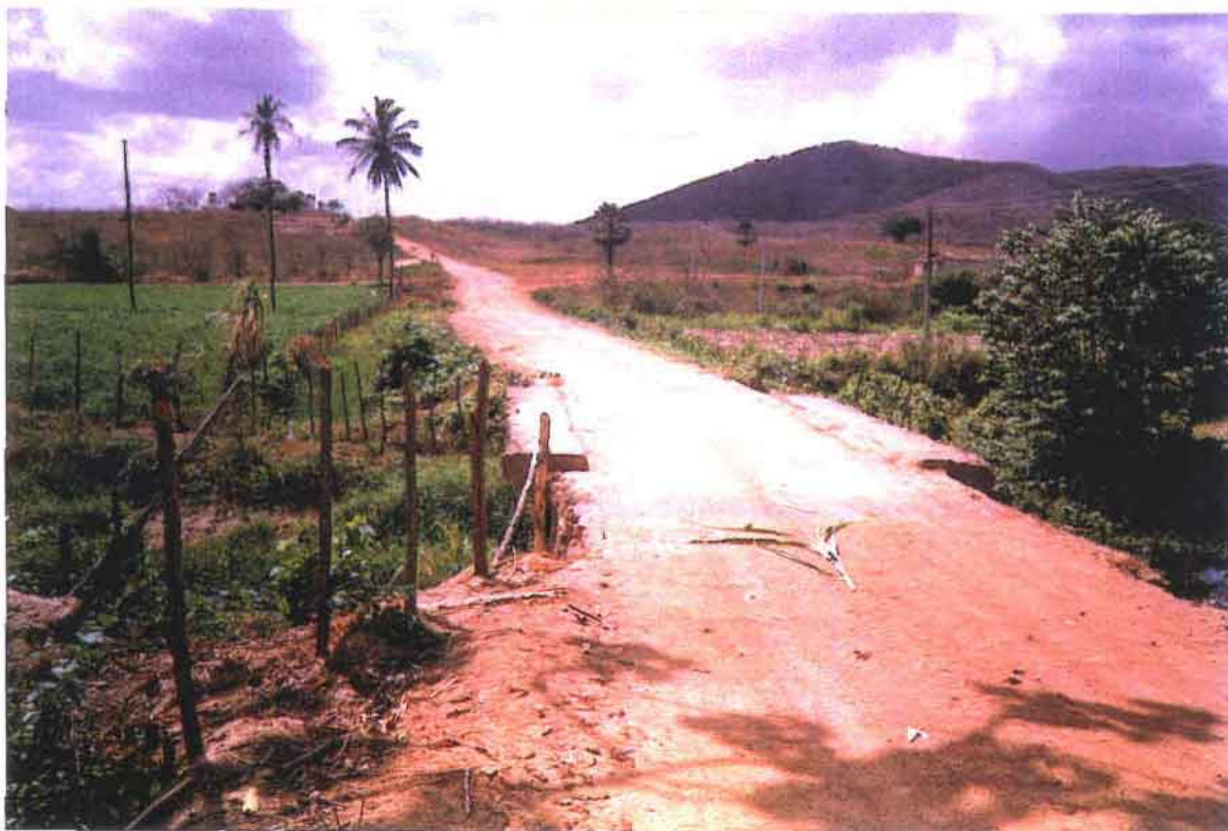
FOTO 4 - PONTE SOBRE RIACHO POR ONDE PASSARÁ A ADUTORA
