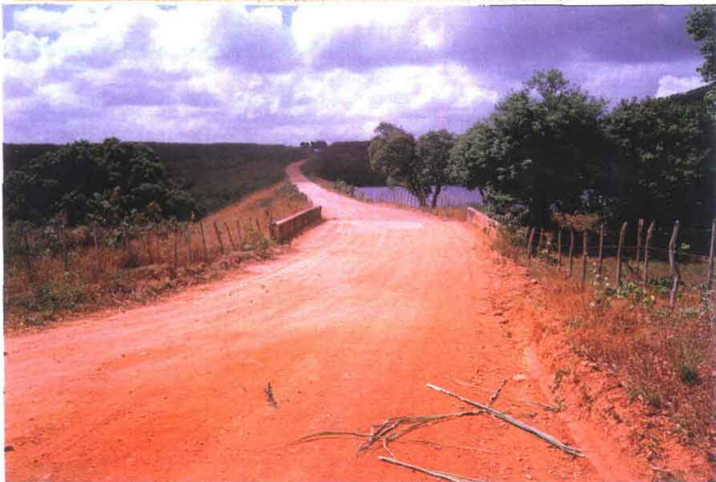
FOTO 3 - ESTRADA POR ONDE PASSARÁ A ADUTORA
