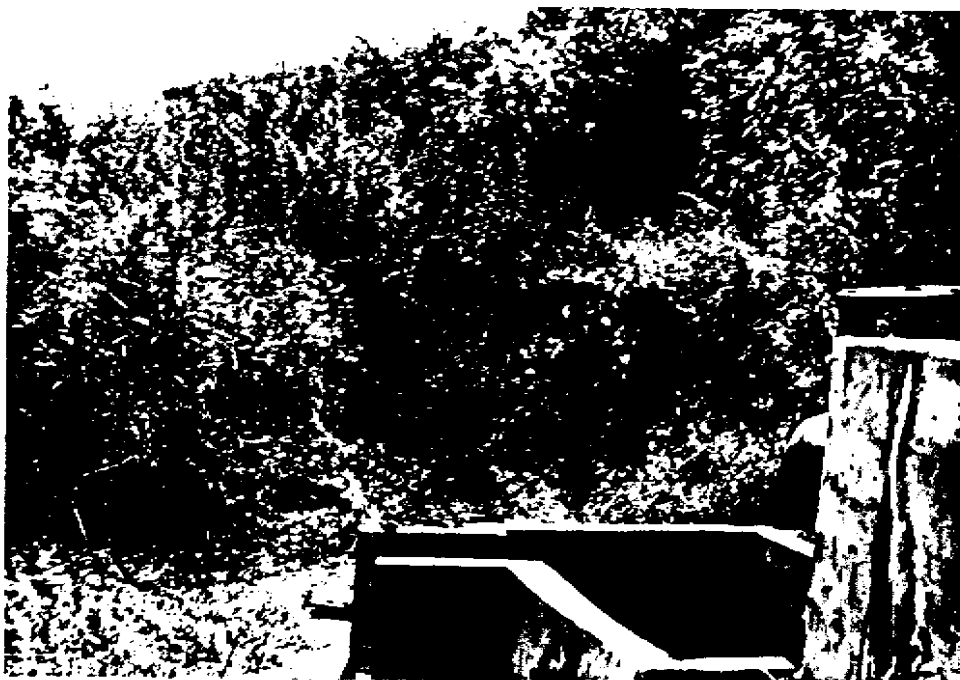
FOTO 3.3 - Vista da bacia de dissipação de energia da saída da galeria do açude Umari (Thomaz Osterne de Alencar).
