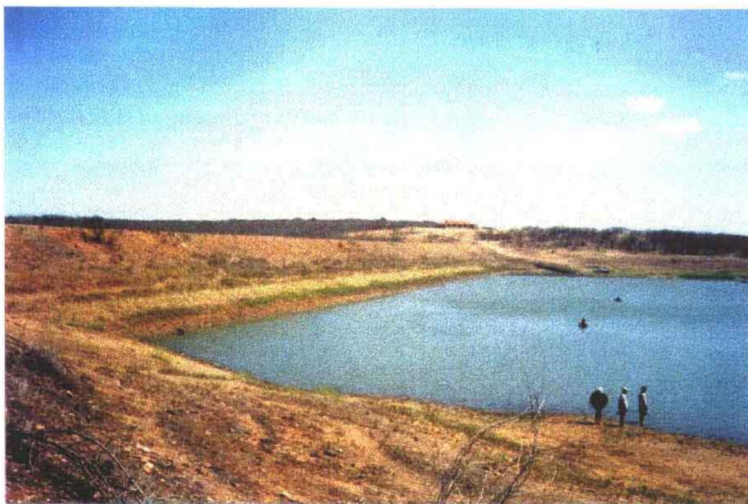
Vista do lago e talude de montante
