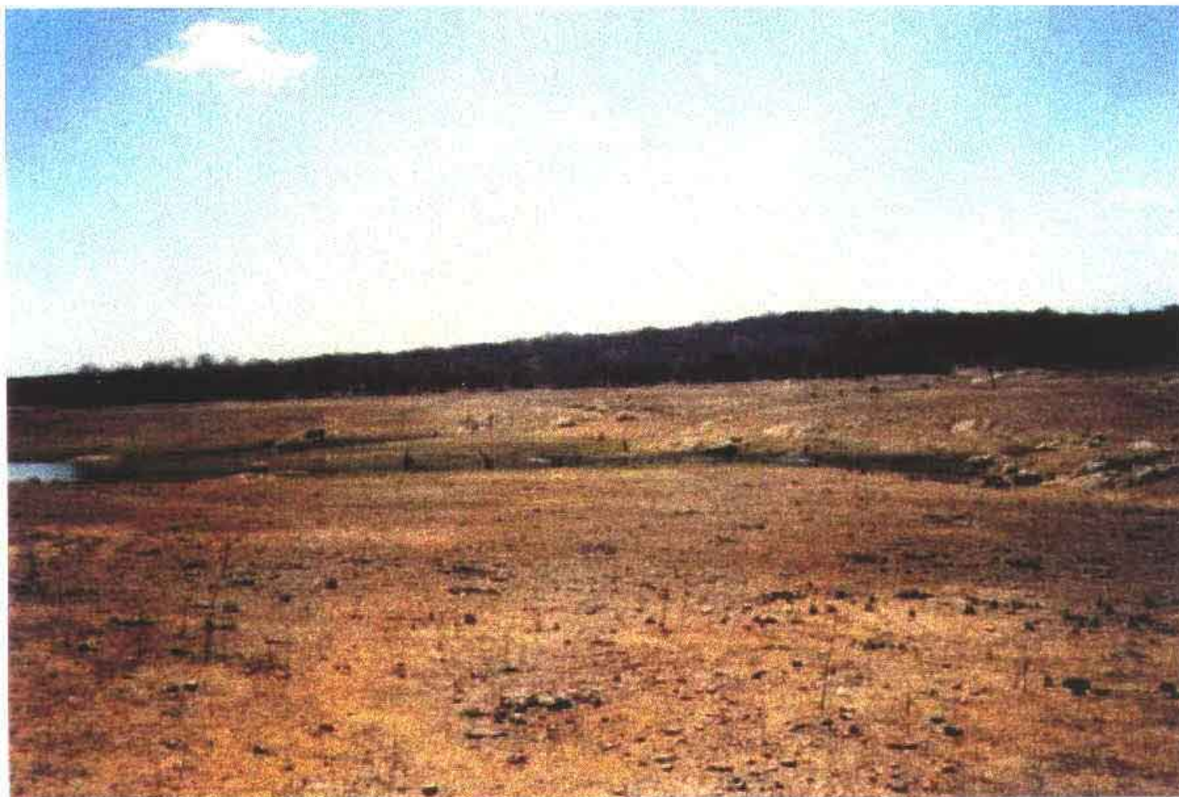
Ao fundo vista parcial do lago e canal de aproximação do sangradouro
