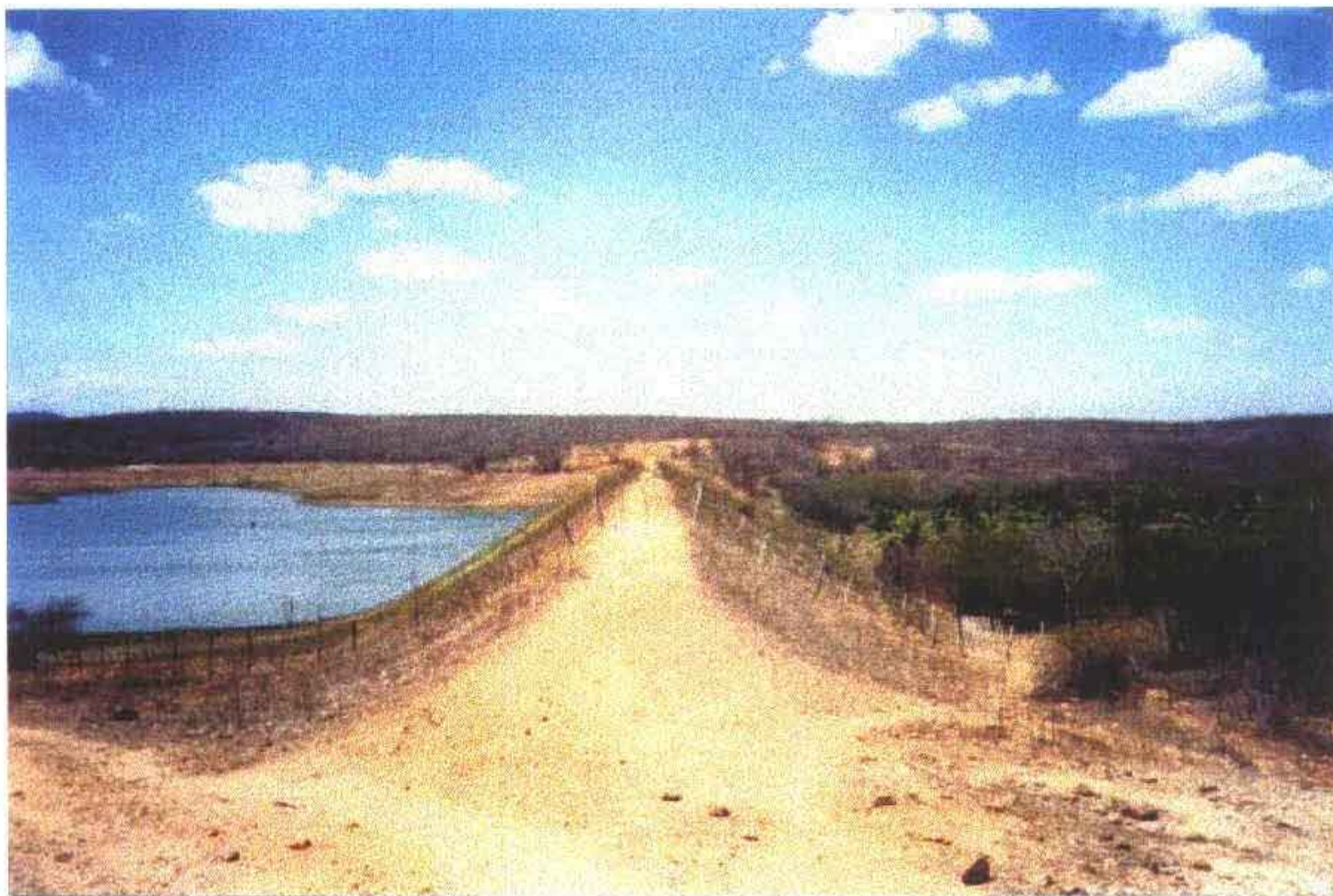
Vista do maciço a partir da ombreira direita
