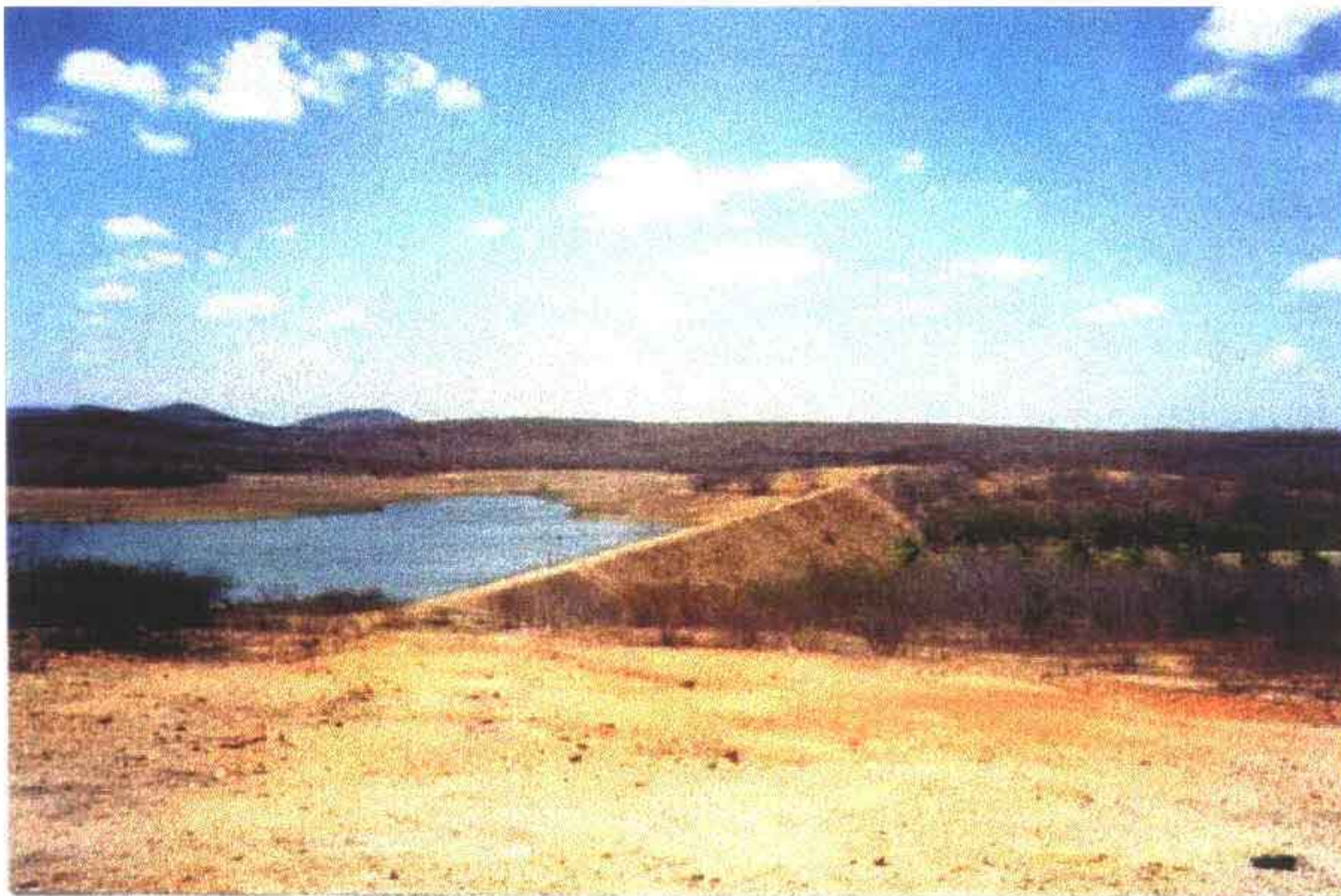
Vista geral do lago e maciço a partir da ombreira direita
