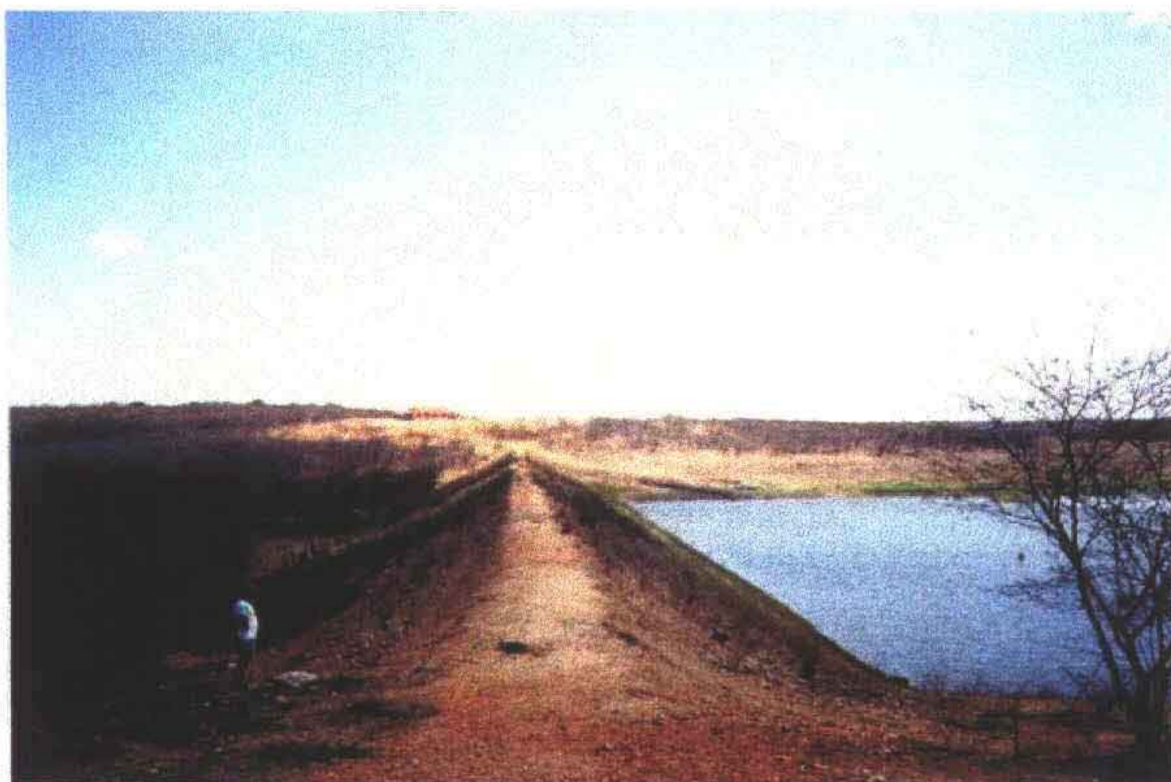
Vista da barragem a partir da ombreira esquerda
