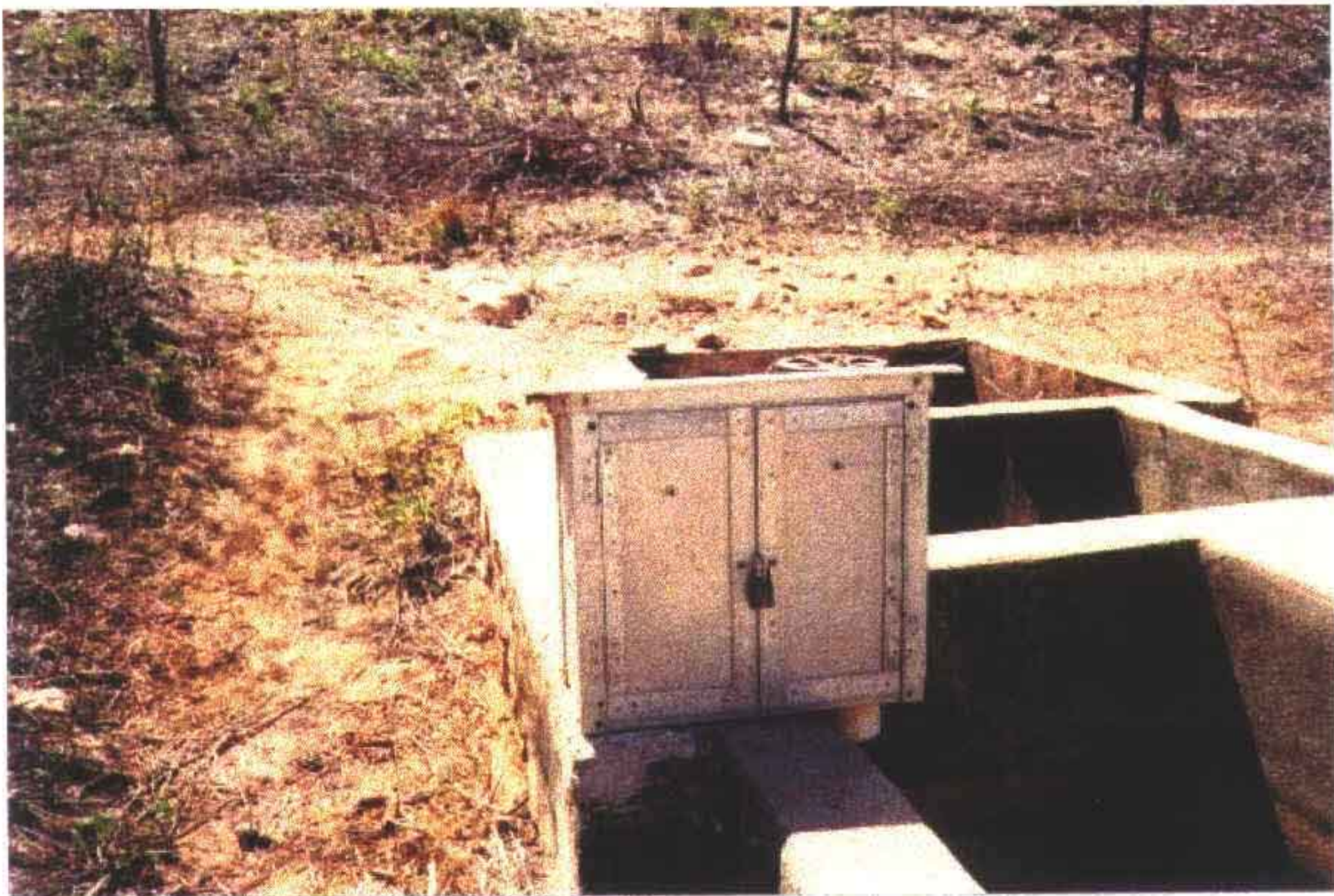
Tomada D'água – Vista Parcial
