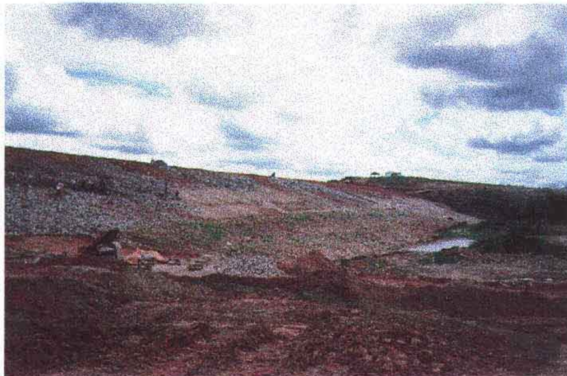
Foto 03 - Aspecto geral do espaldar de montante. Verifique a proteção do talude, onde o trecho mais baixo foi executado com o seixo rolado, enquanto a parte superior já iniciado com bica-corrída. Observe a altura do maciço em relação à execução do "rip-rap".
