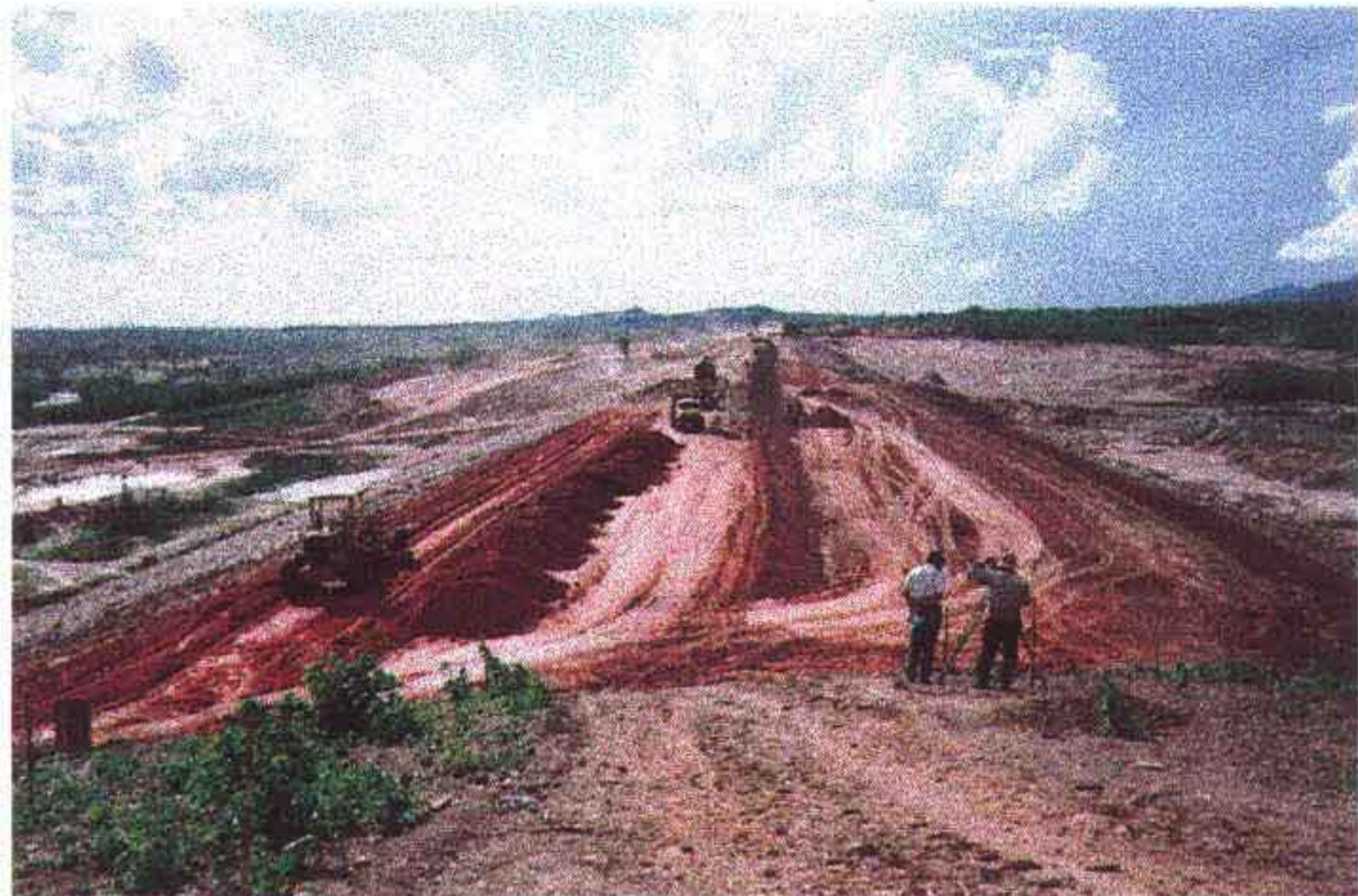
Foto 02 - Vista a partir da ombreira direita. Observe os trechos a montante se aproximando da cota 152.00, enquanto a jusante se aproxima da cota 145.00, os dois trechos em cota plena.
