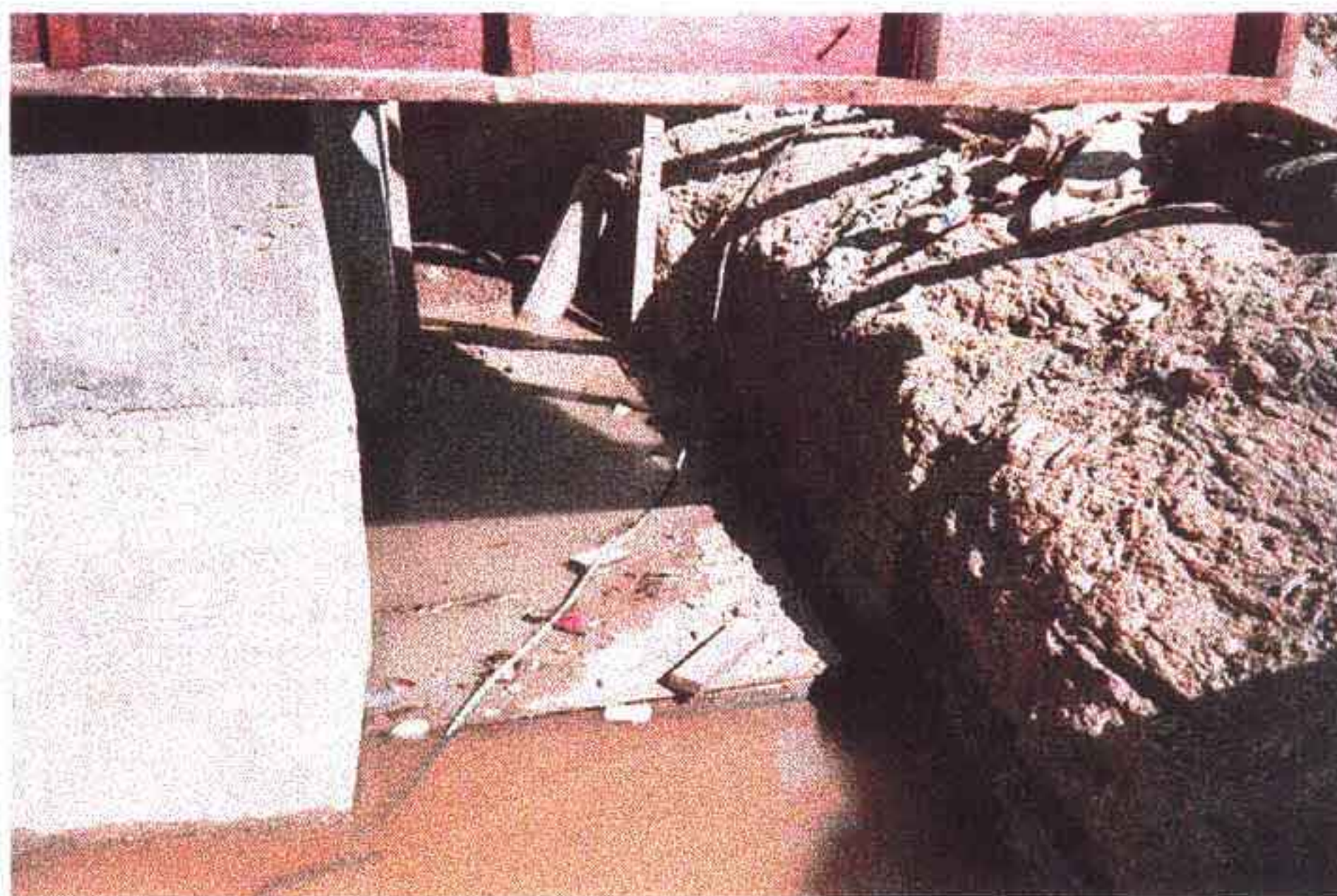
Foto 12 - Vista da entrada da boca da tomada d'água. Verifique o corte em rocha acima da tubulação que deverá ser escavado na cota 135.00.
