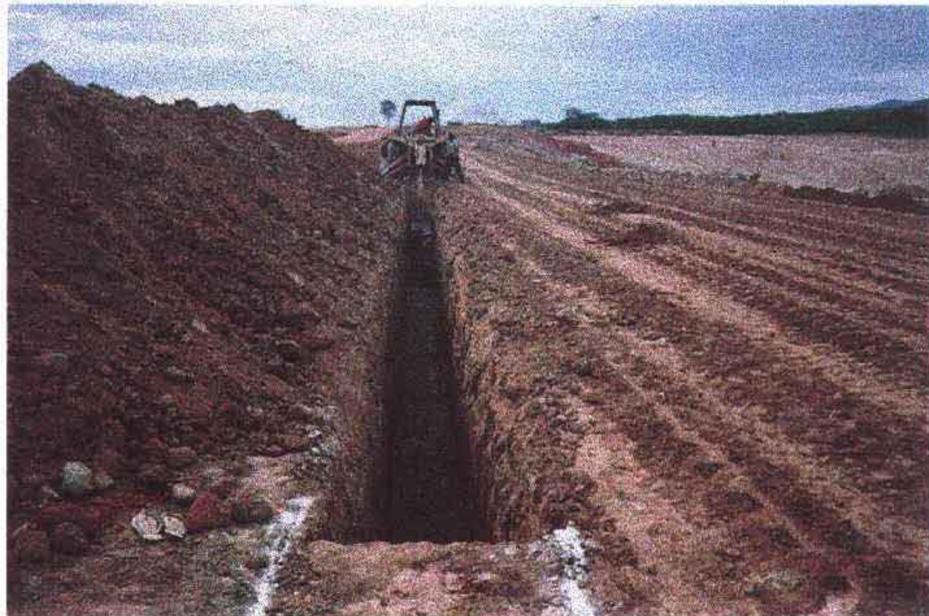
Foto 08 - Trecho em operação de abertura do filtro. Verifique no fundo da cova o encontro da areia e a limpeza do trecho.
