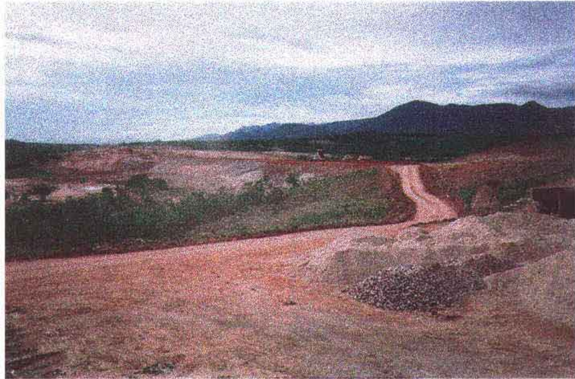
Foto 01 - Vista geral da barragem, tomada a partir da ombreira direita a montante no local do sangradouro.
