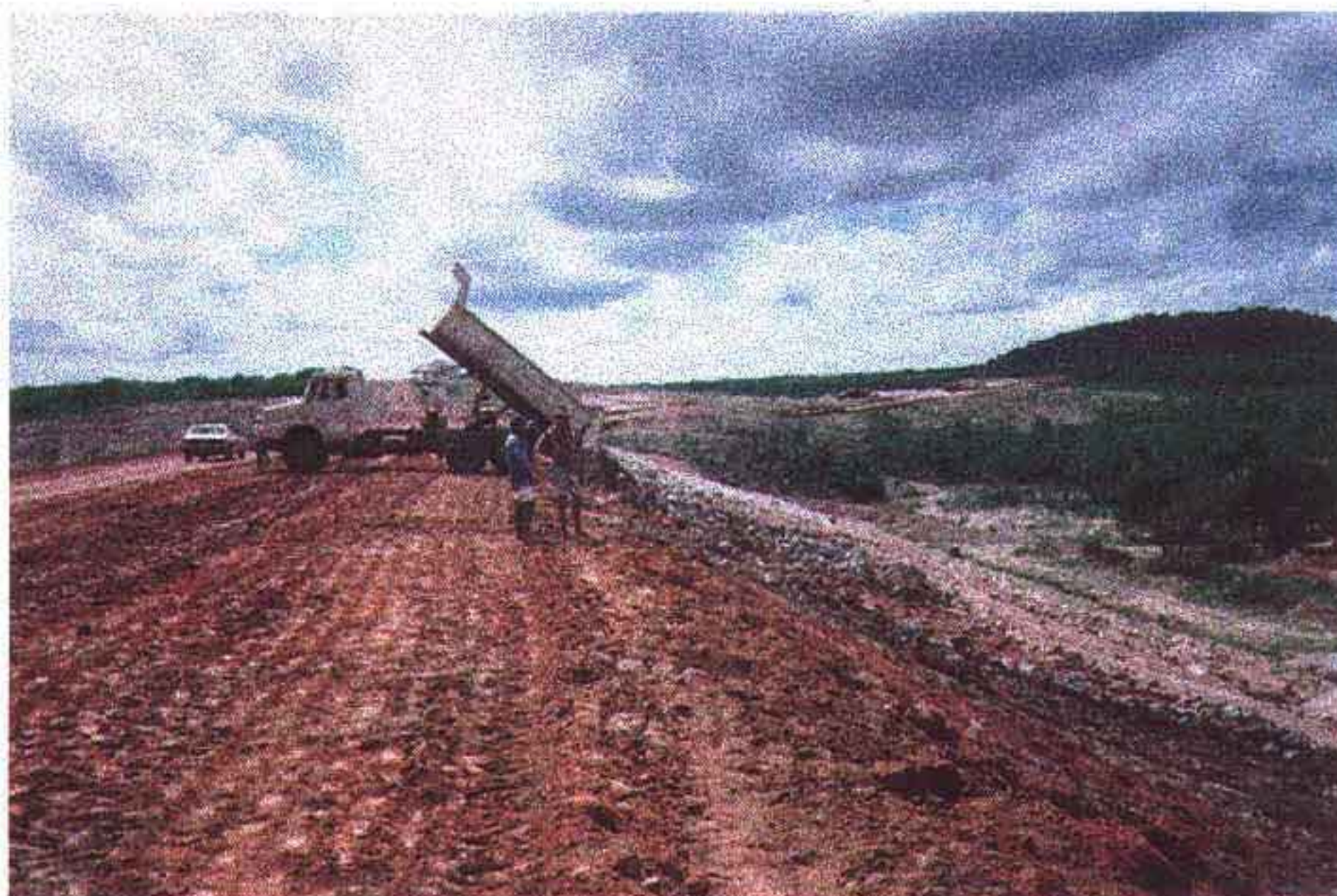
Foto 04 - Lançamento da pedra em bica-corrída a partir do coroamento.
