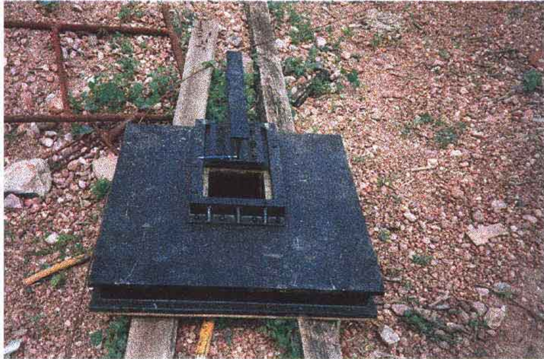
Foto 13 - Comporta da tomada d'água.
