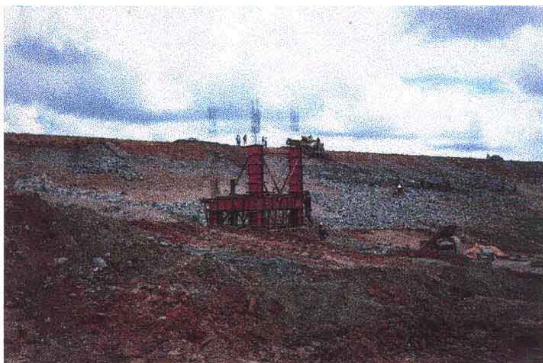
Foto 06 - Operação de espalhamento de bica-corrida com trator e acabamento braçal.
