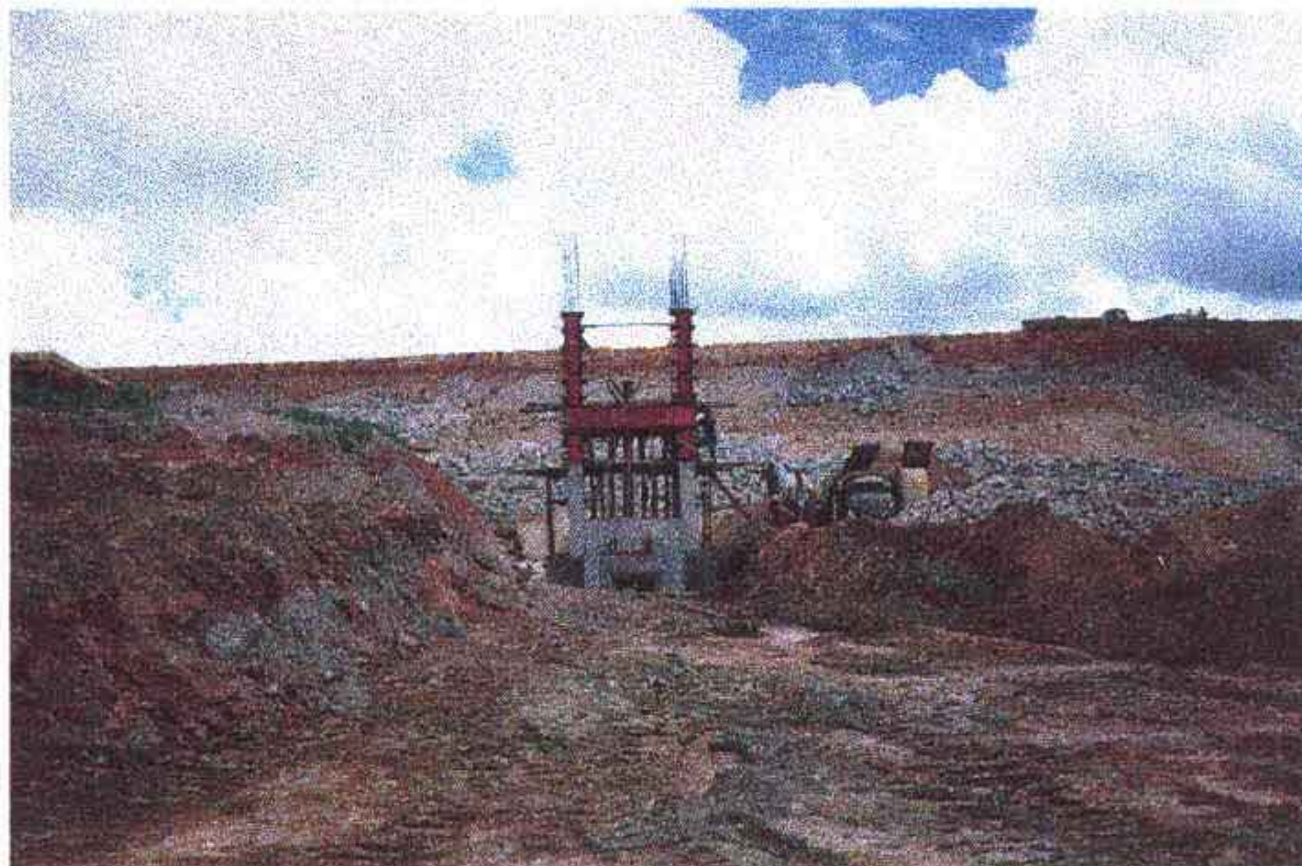
Foto 11 - Vista do canal de aproximação da boca da tomada d'água que será ampliado e escavado em rocha na cota 135.00.
