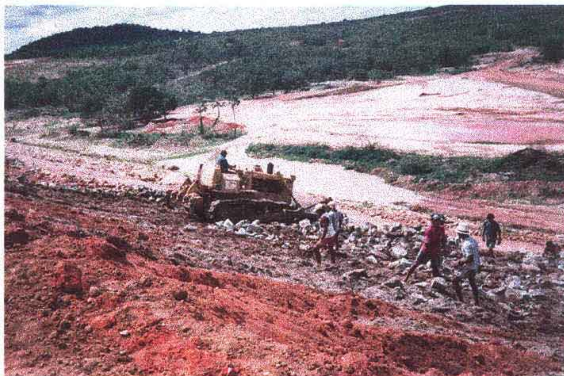
Foto 05 - Operação de espalhamento de bica-corrida com emprego de trator.
