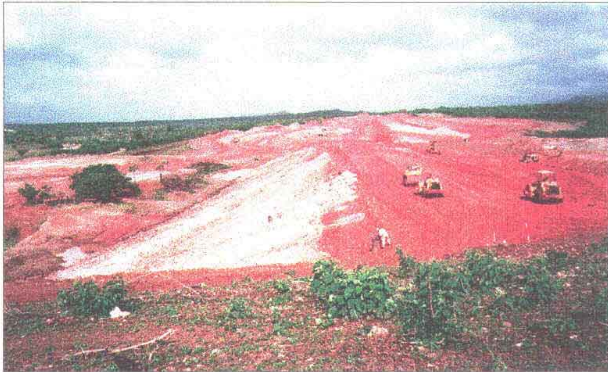
Vista do talude montante. Observar atraso na execução do enrocamento de montante com seixo rolado.
