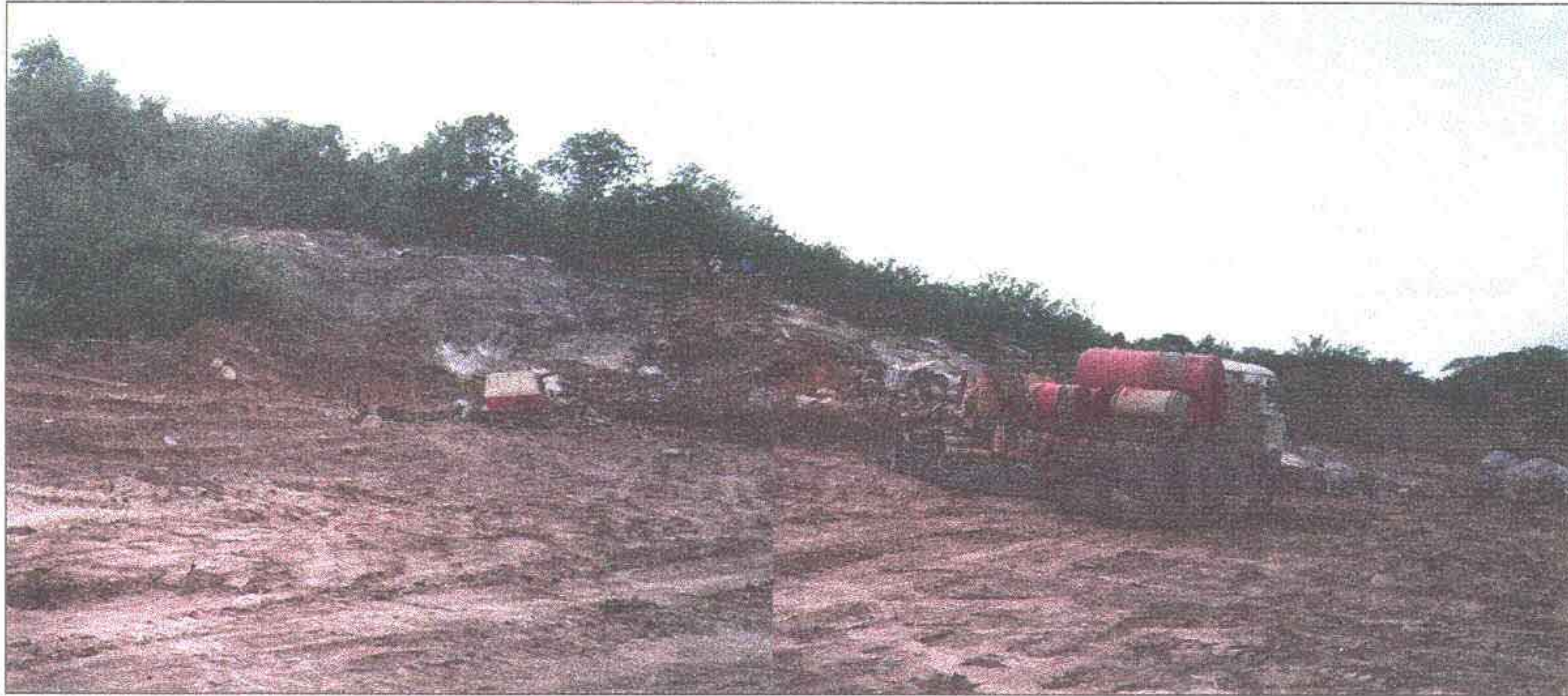
Pedreira Nº 03, início de operação de limpeza e preparação de bancada para exploração.
