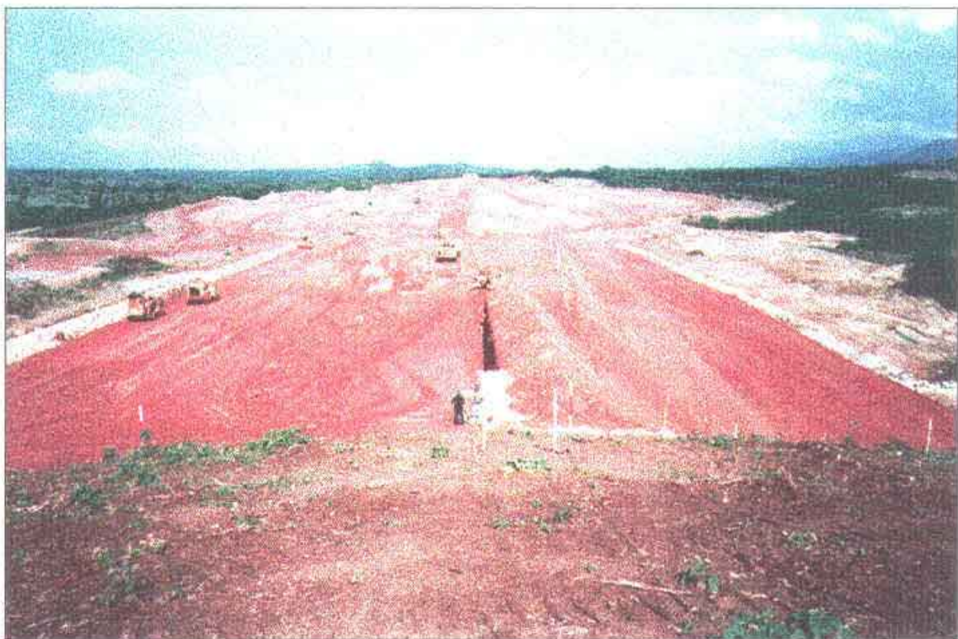
Vista da escavação do dreno vertical aproximadamente na cota 144,50.
