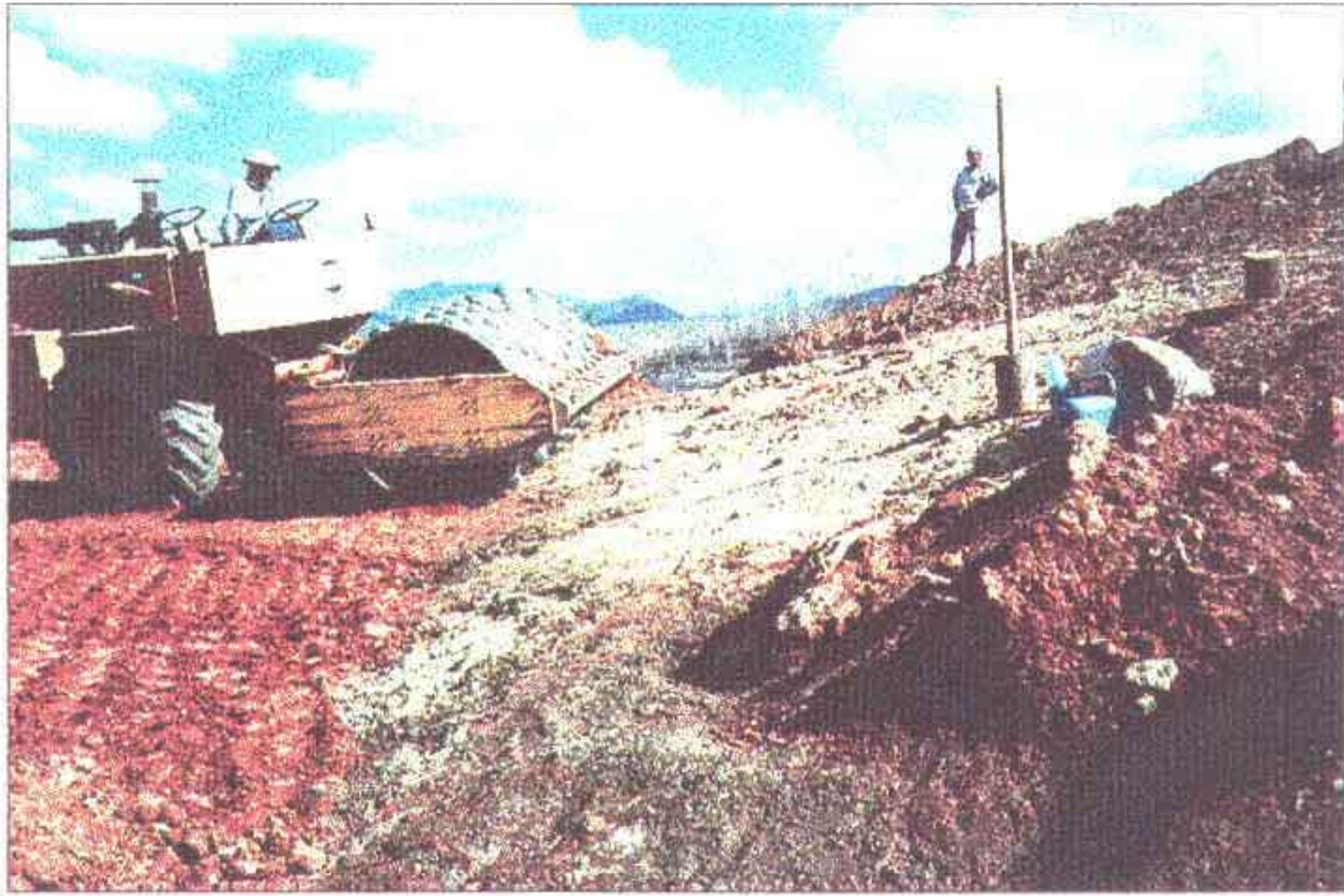
Compactação de camada. Verificar o avanço do rolo compactador no encontro maciço/ombreira.
