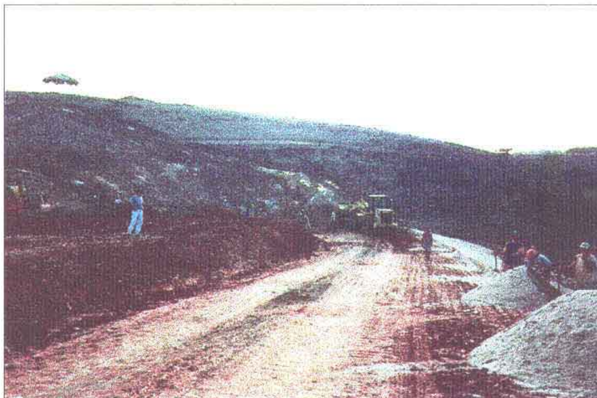
Operação de limpeza de material inconsolidado(Expurgo) realizado na ombreira direita com o uso da pá carregadeira.
