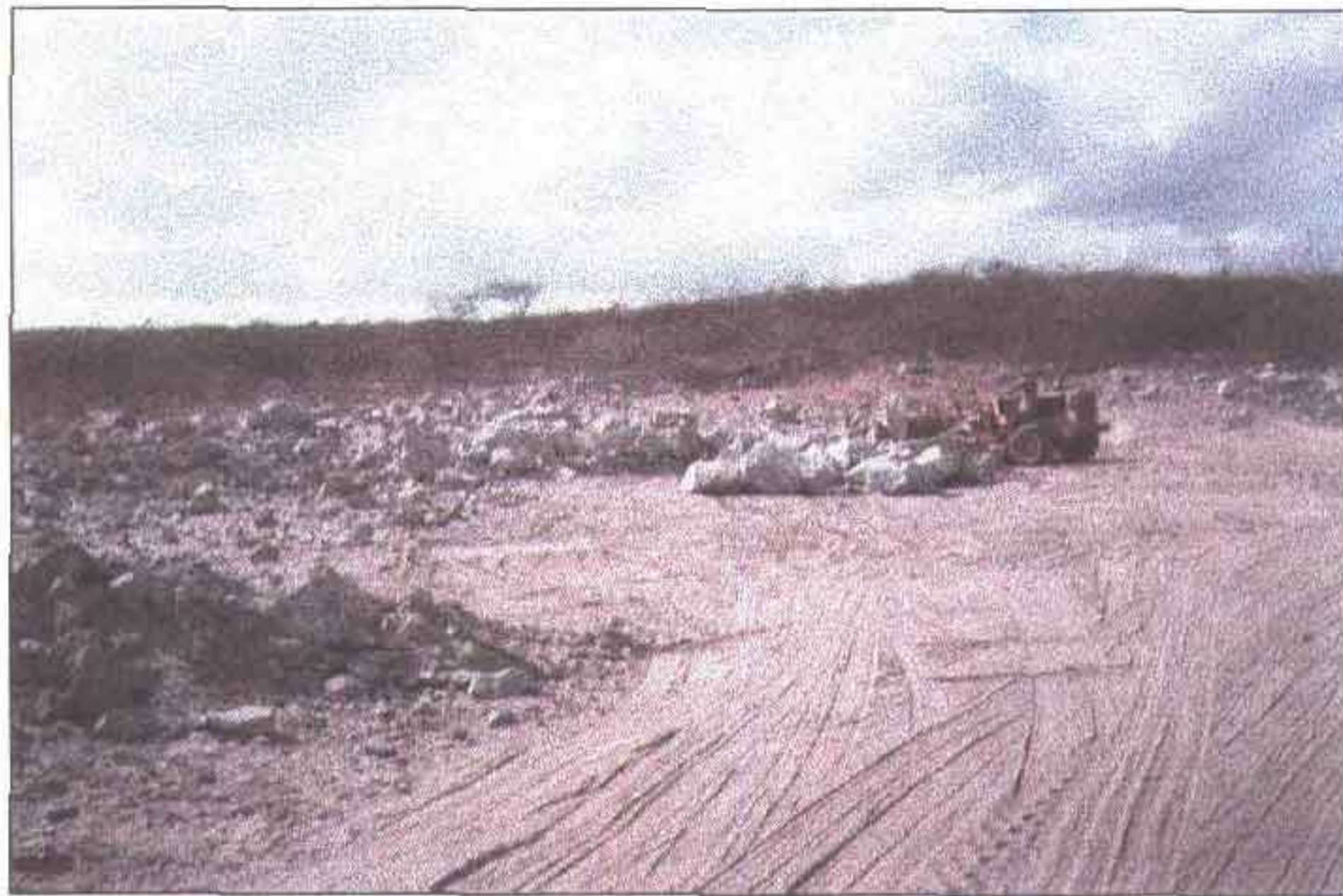
Blocos extraídos da pedreira após ser detonada. Observe-se o tamanho e forma dos blocos
