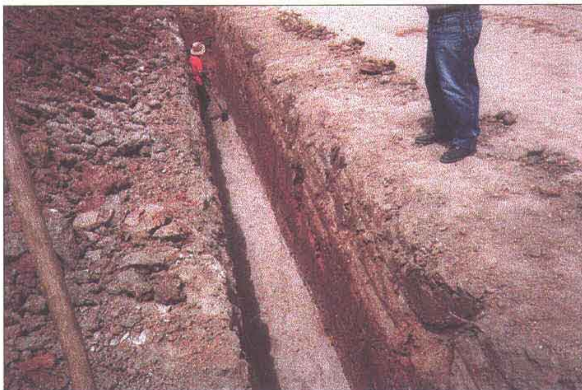
Filtro vertical. Concluída a escavação e limpeza da camada anterior
