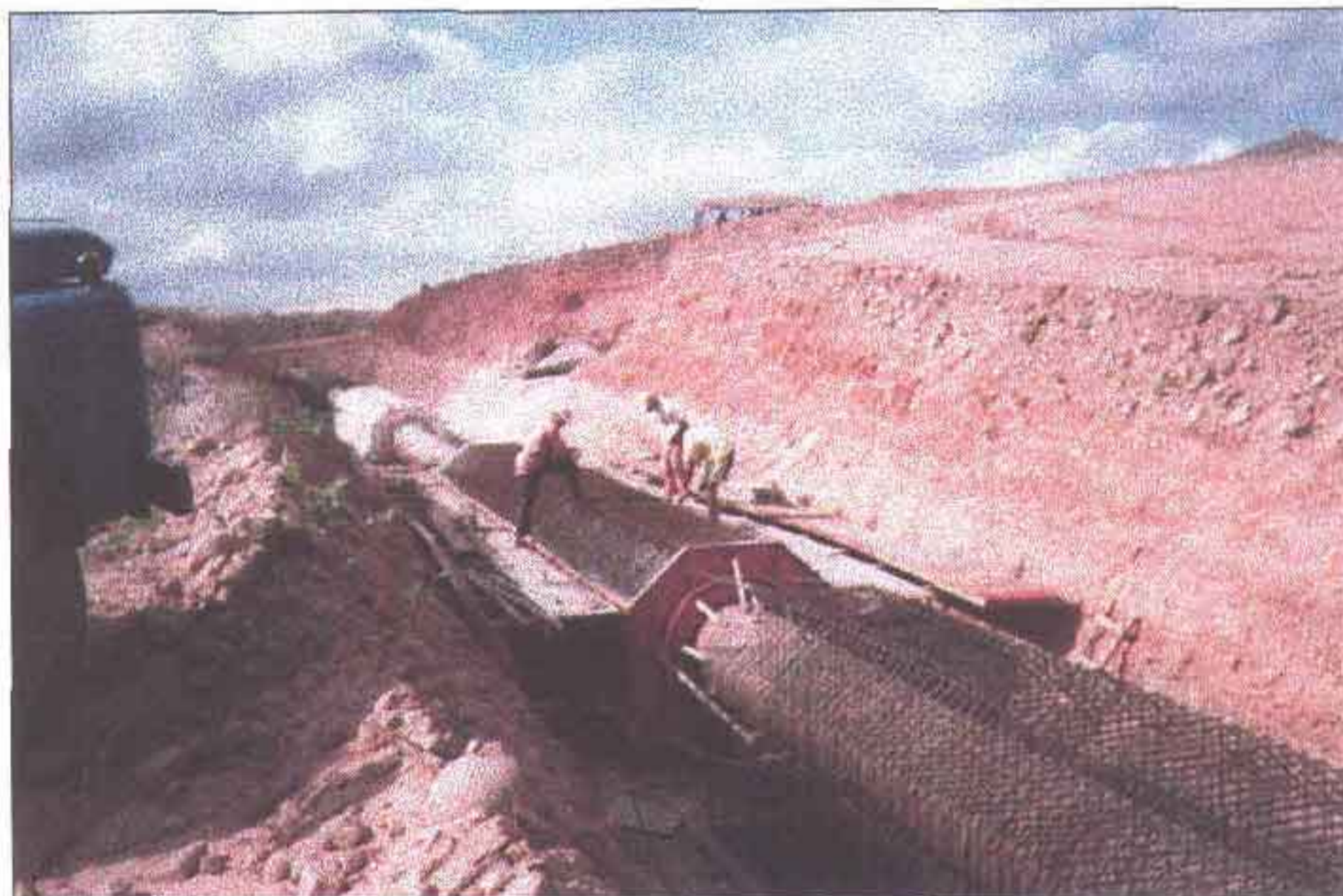
Galeria de tomada d'água. A galeria foi dividida em seções de 12 metros separada por junta Fungenband. Observe-se no canto inferior direito a ferragem já colocada, logo em seguida a conferência para efeito da concretagem e ao fundo uma seção já concretada.
