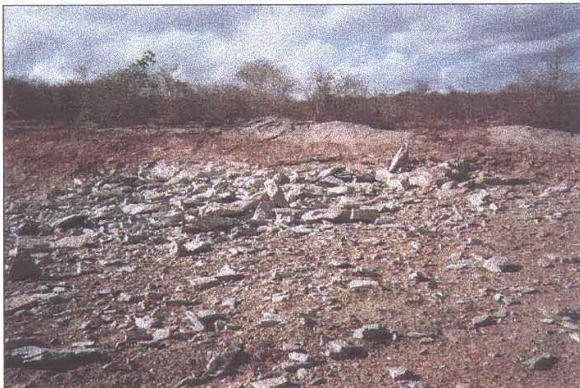
Resultado da primeira detonação. Observe-se o tamanho e forma dos blocos da Pedreira.
