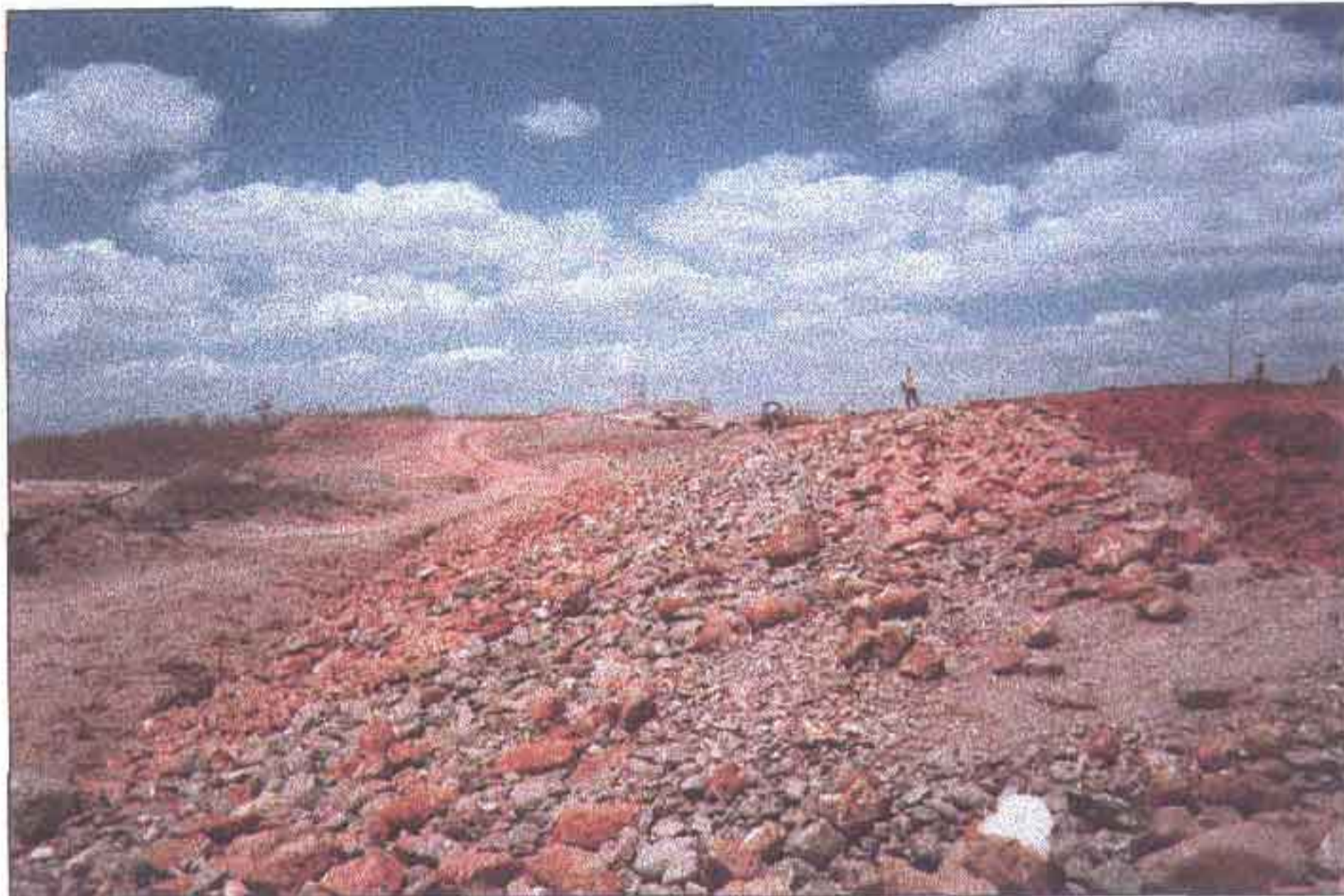
Trecho do rip-rap entre as estacas 10 e 13. Observe-se a camada de areia subjacente à camada de seixo rolado. Observe-se também o início do lançamento do blocos formadores da camada externa do rip-rap.
