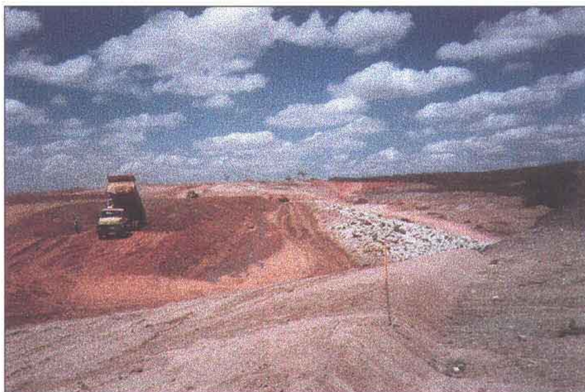
Trecho entre estaca 19 e 21. Lançamento de terra sobre o tapete filtrante horizontal. Na parte inferior observe-se porção de tapete horizontal.
