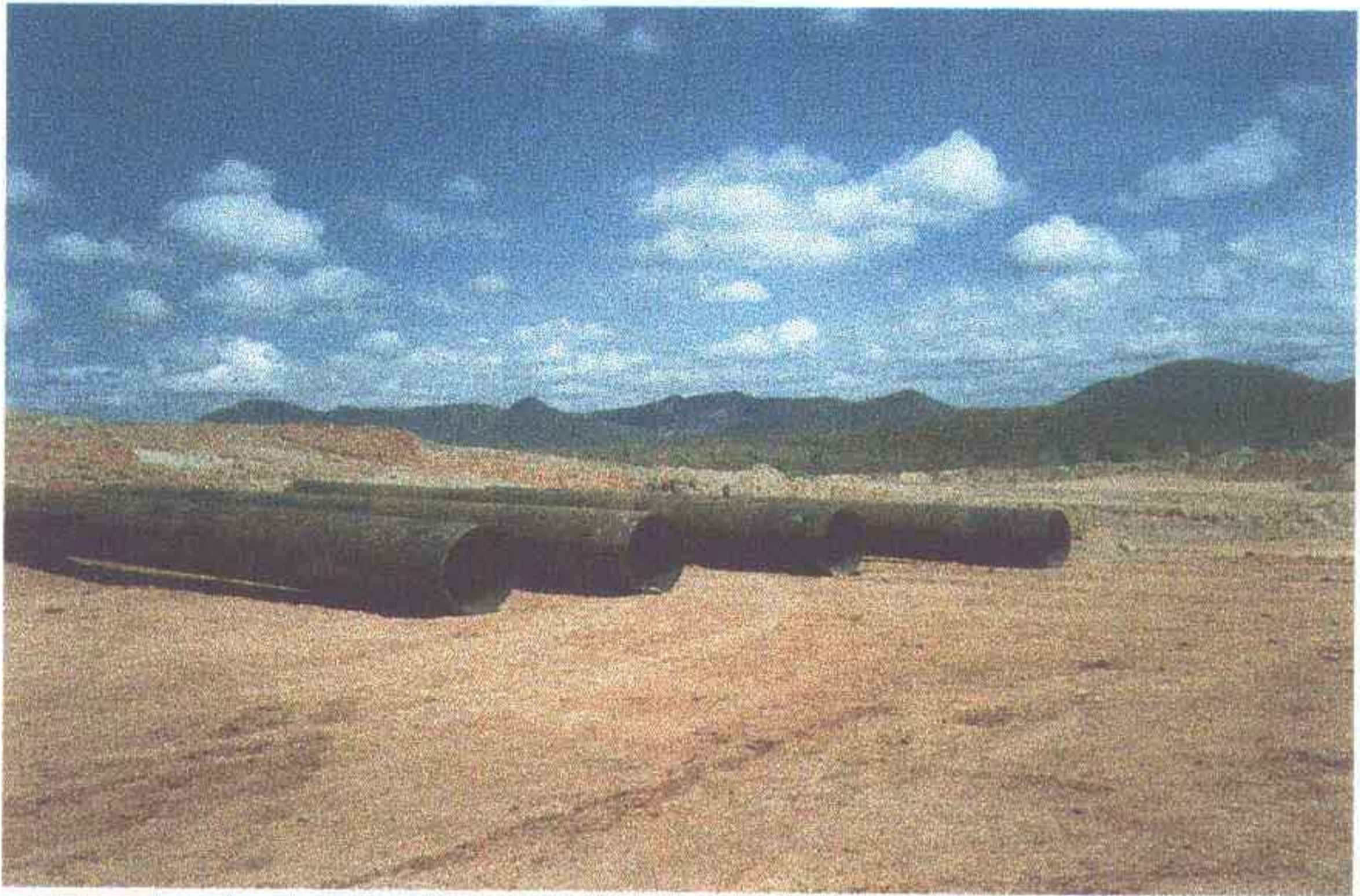
Foto 7 - Tubos depositados no canteiro aguardando o lançamento sobre a fundação.
