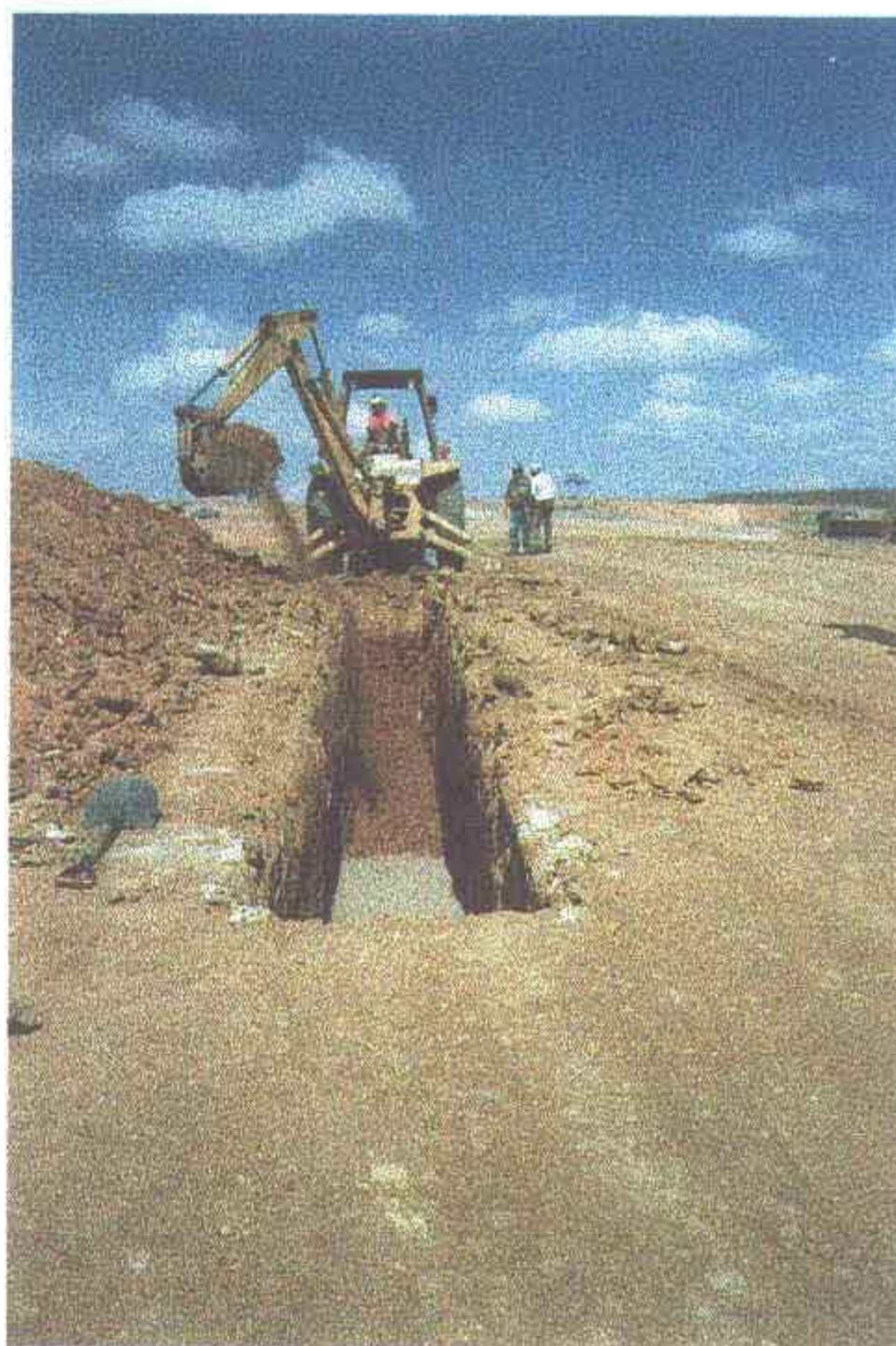
Foto 2 - Escavação do filtro vertical. Operação feita com retro-escavadeira.
