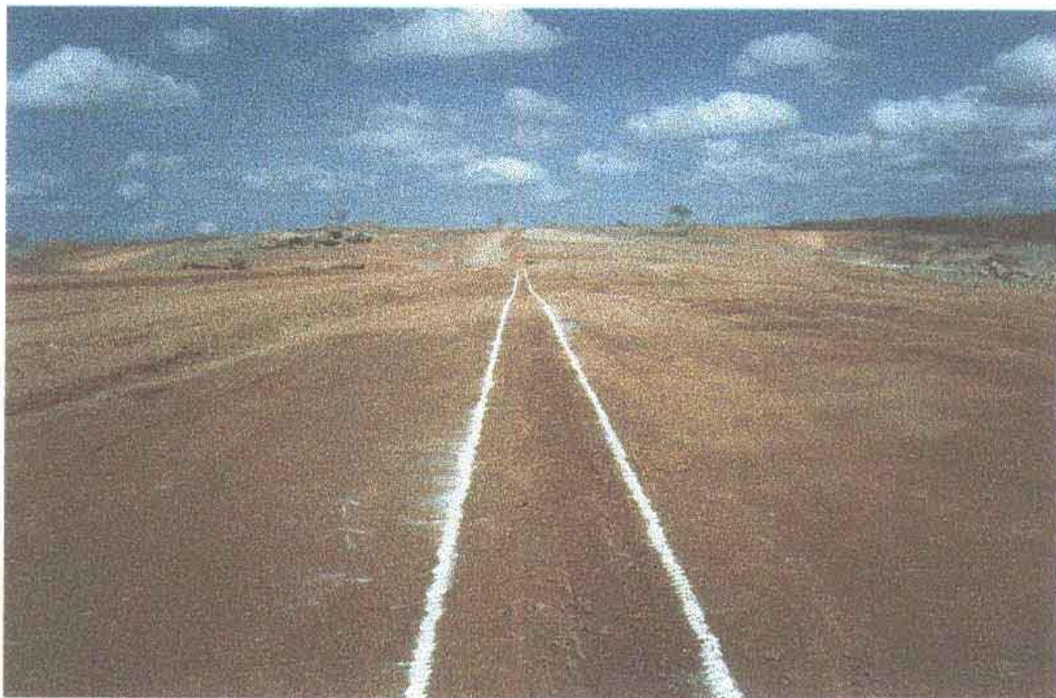
Foto 1 - Localização do filtro vertical entre as estacas 12 e 20 - Observa-se a marcação com cal.
