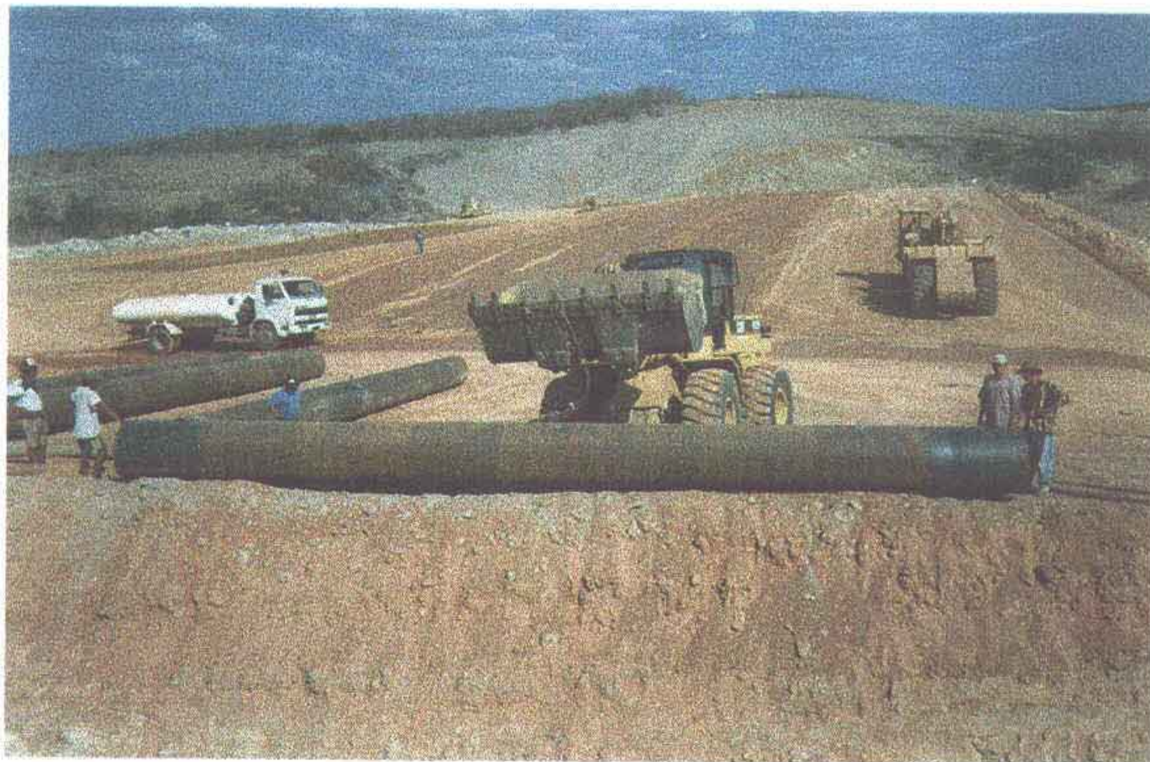
Foto 6 - Lançamento do tubo com o auxílio de uma pá carregadeira.
