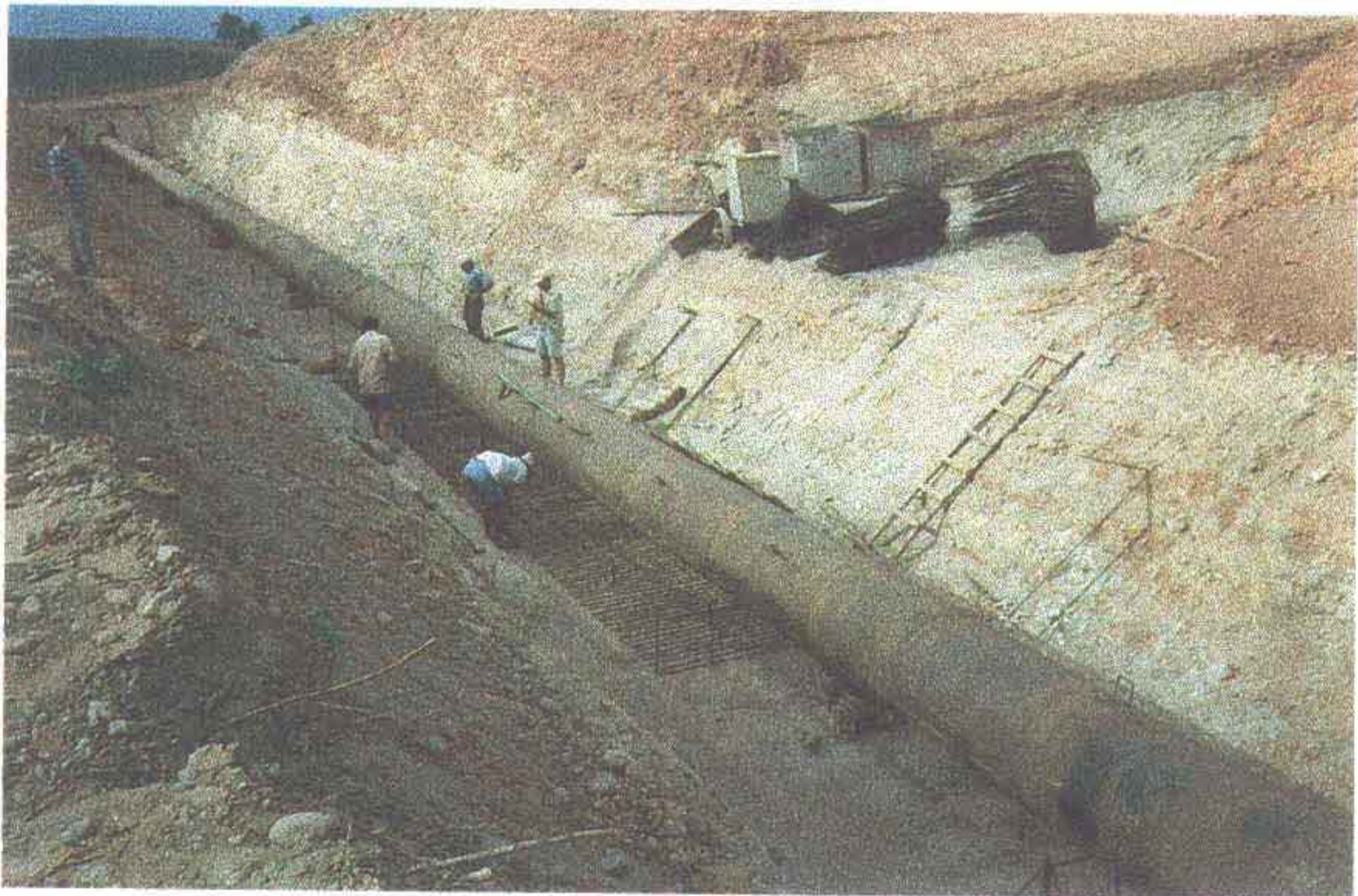
Foto 8 - Armação da galeria no trecho que corresponde ao cut-off.
