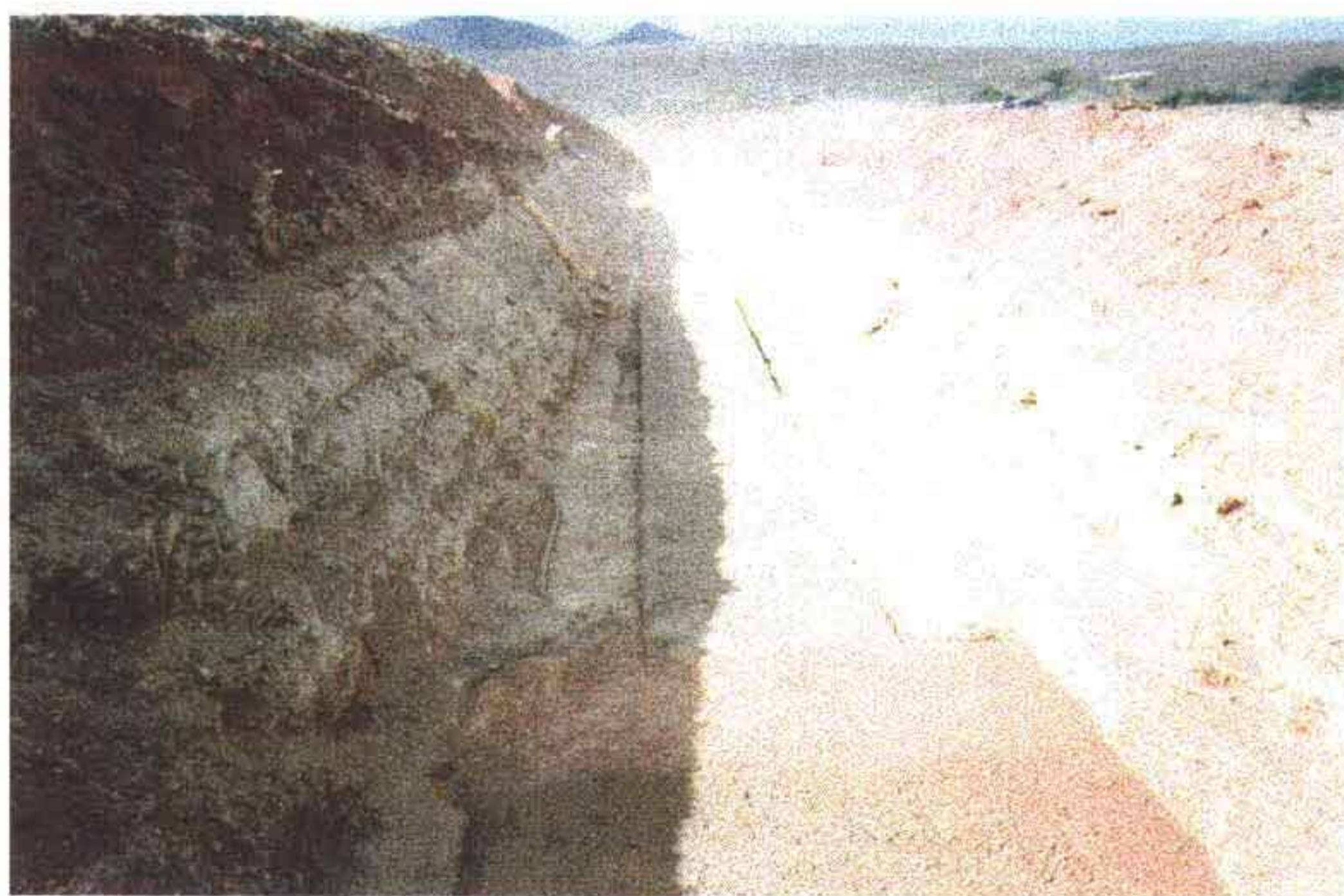
Foto 12 - Vista da fundação da galeria. Camada de regularização já executada. Na parte inferior da foto nota-se o alargamento para base da torre.
