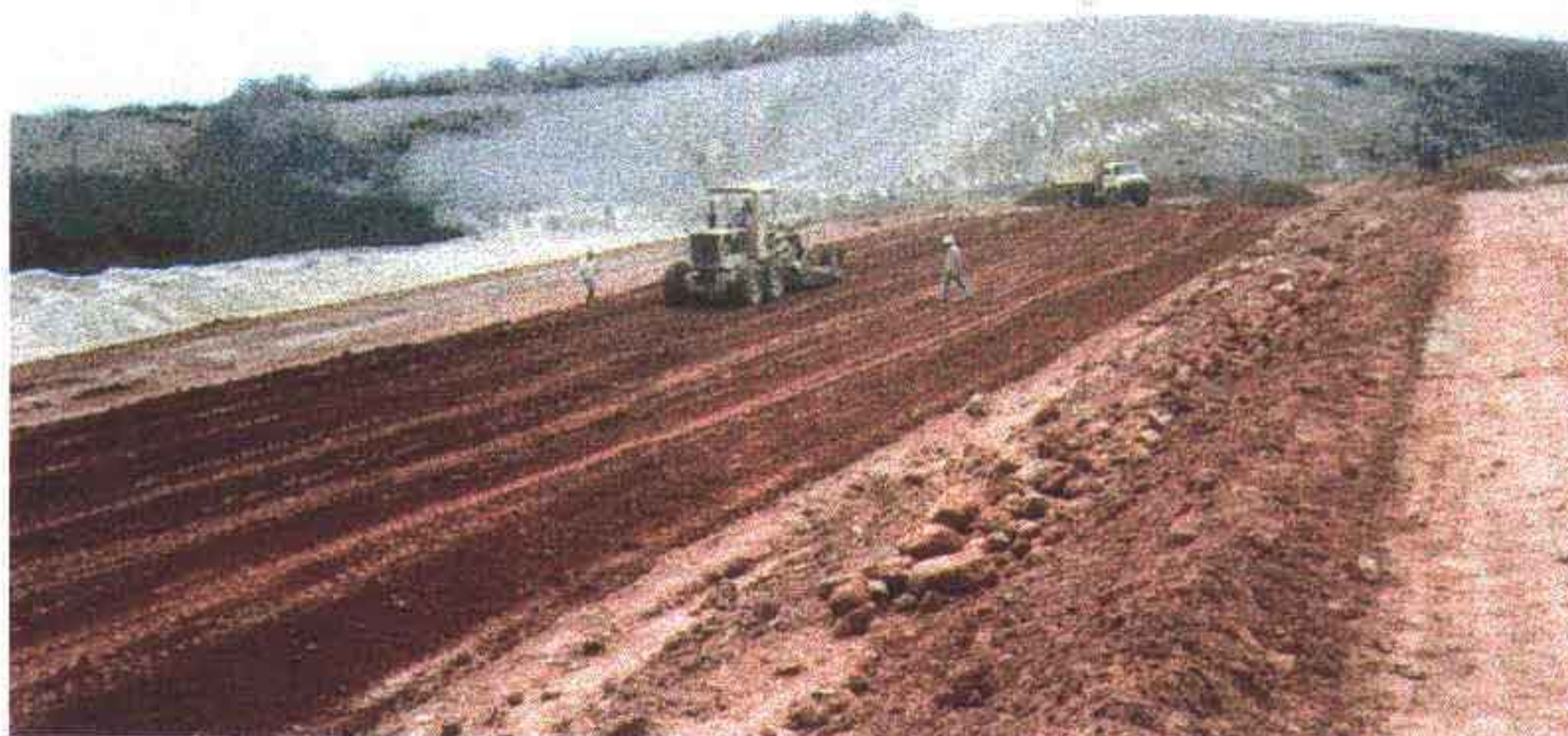
Foto 7 - Lançamento e espalhamento do material entre estacas 17 e 19.
