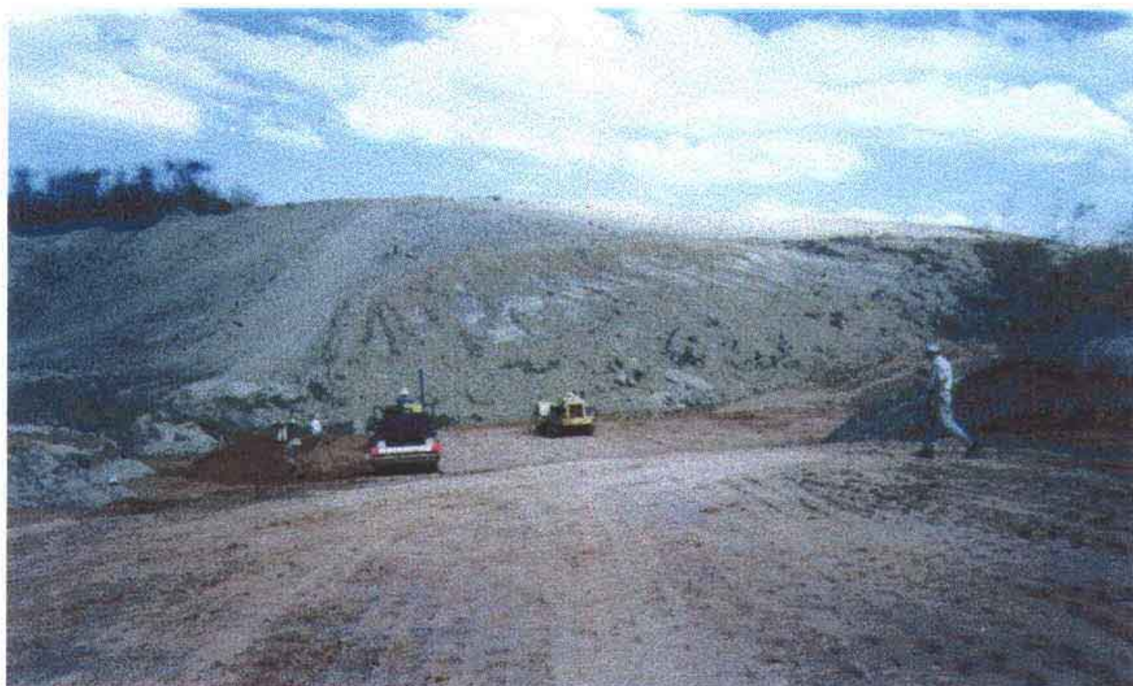
Foto 4 - Compactação entre as estacas 18 e 20, trecho correspondente ao leito do rio.
