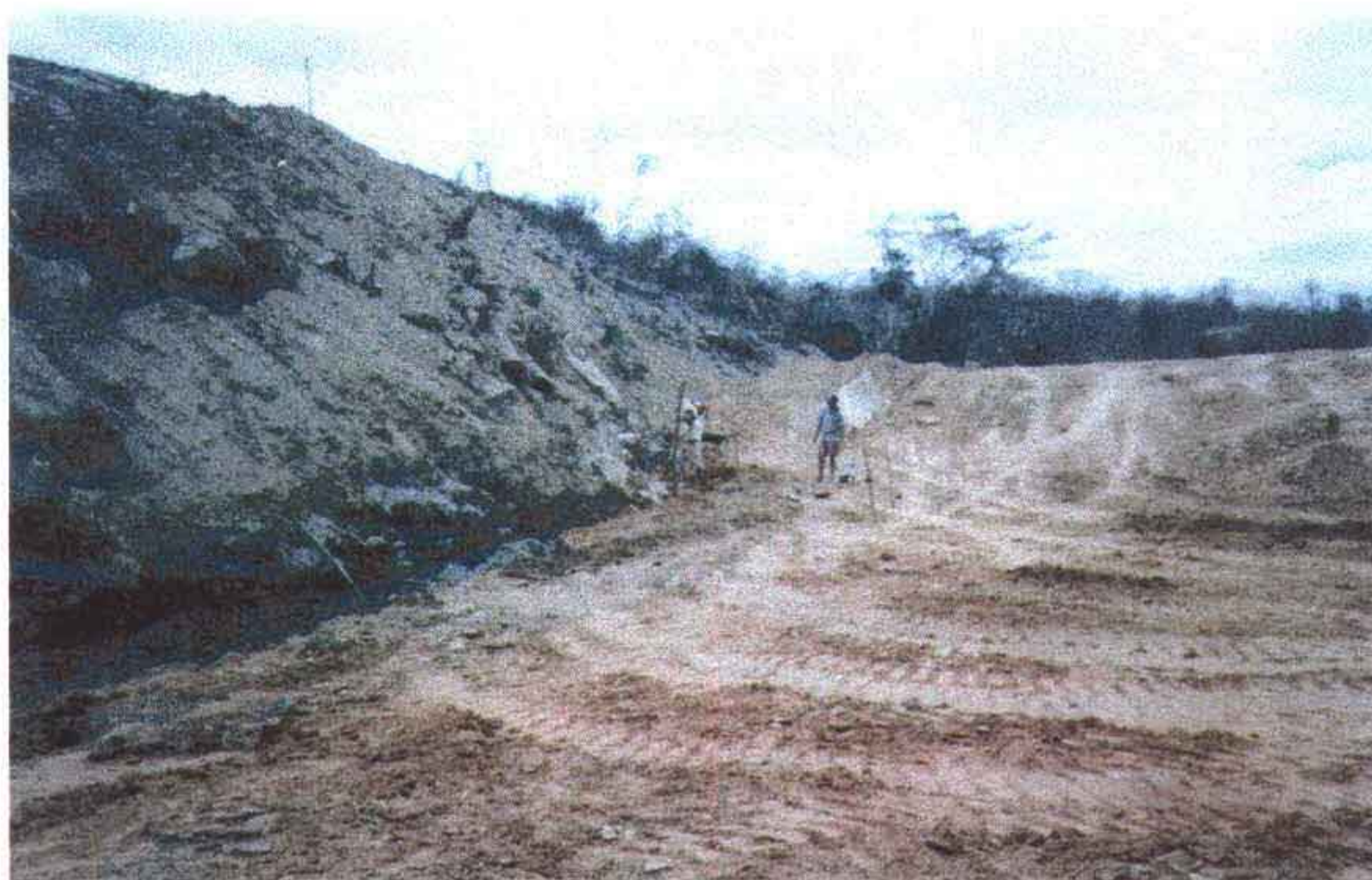
Foto 3 - Ombreira direita, estaca 21, encontro do maciço com a ombreira. Observa-se o tratamento manual.
