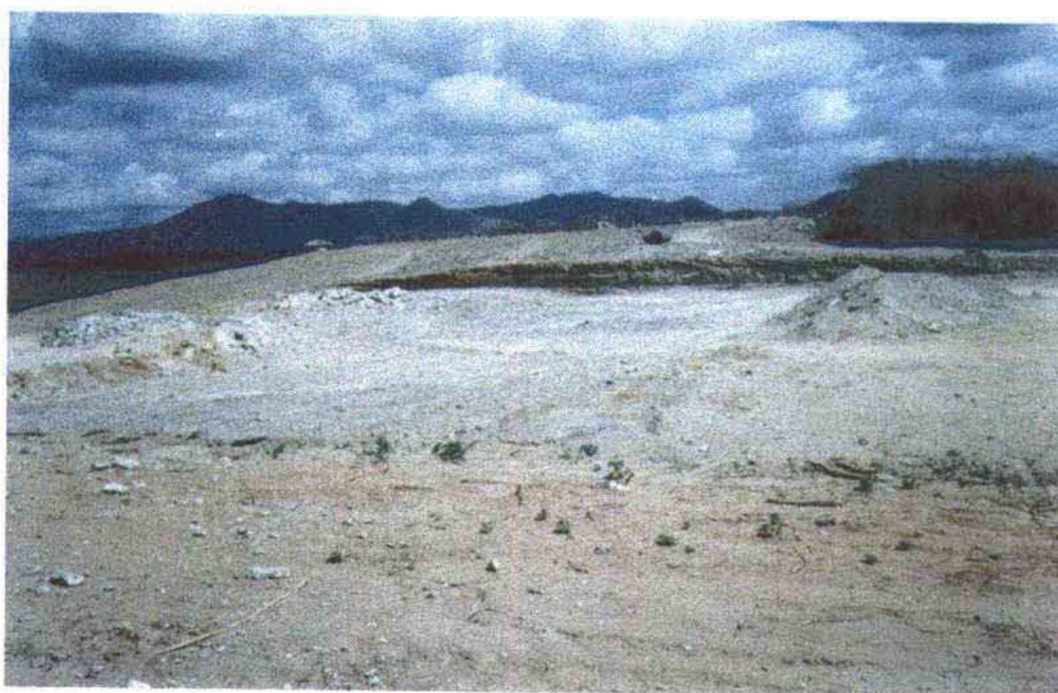
Foto 2 - Escavação do sangradouro. Observa-se a formação rochosa do local da bacia, rocha gnáissica. Já atingida a cota de projeto
