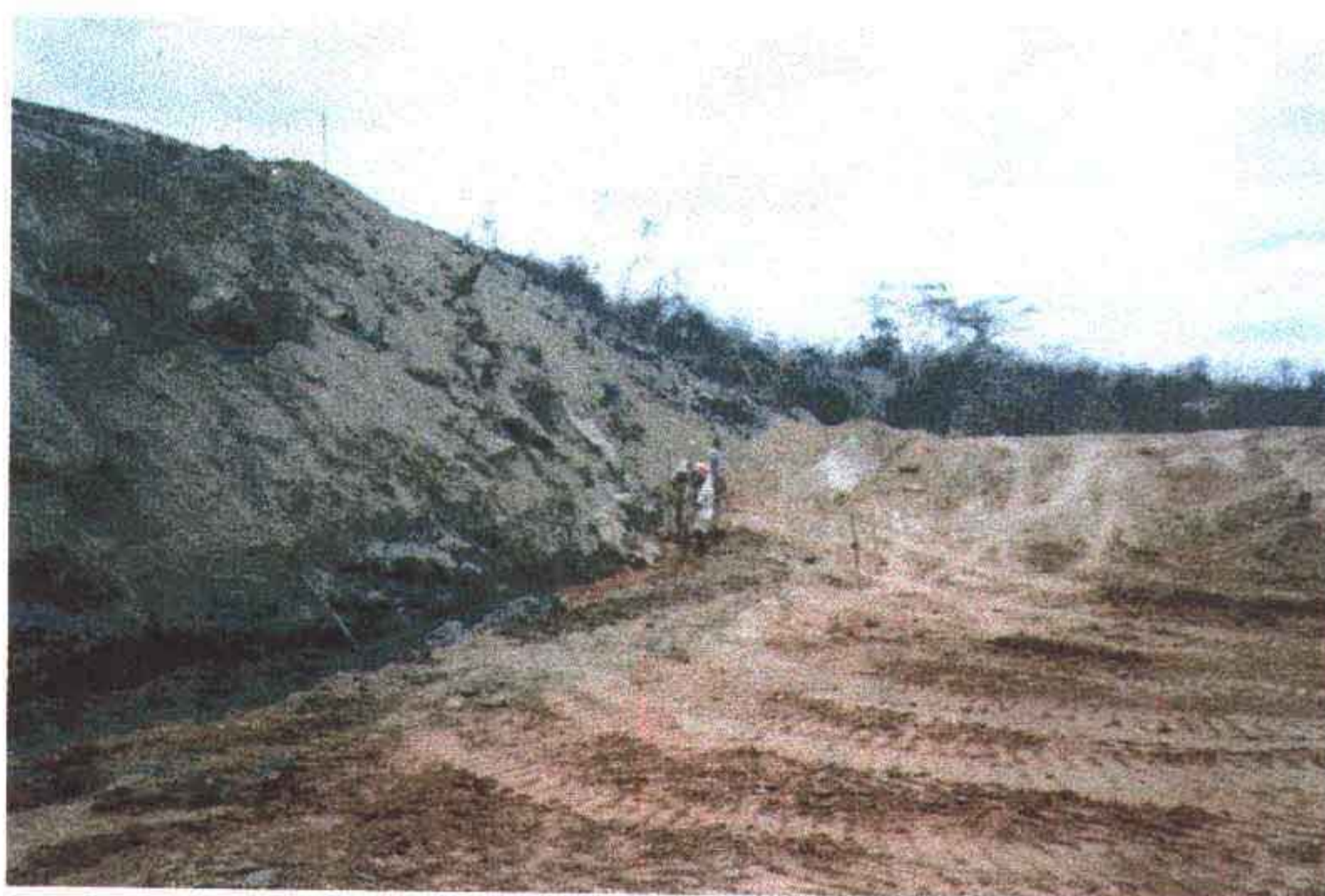
Foto 6 - Encontro da ombreira direita. Observa-se a limpeza manual da rocha do encontro.
