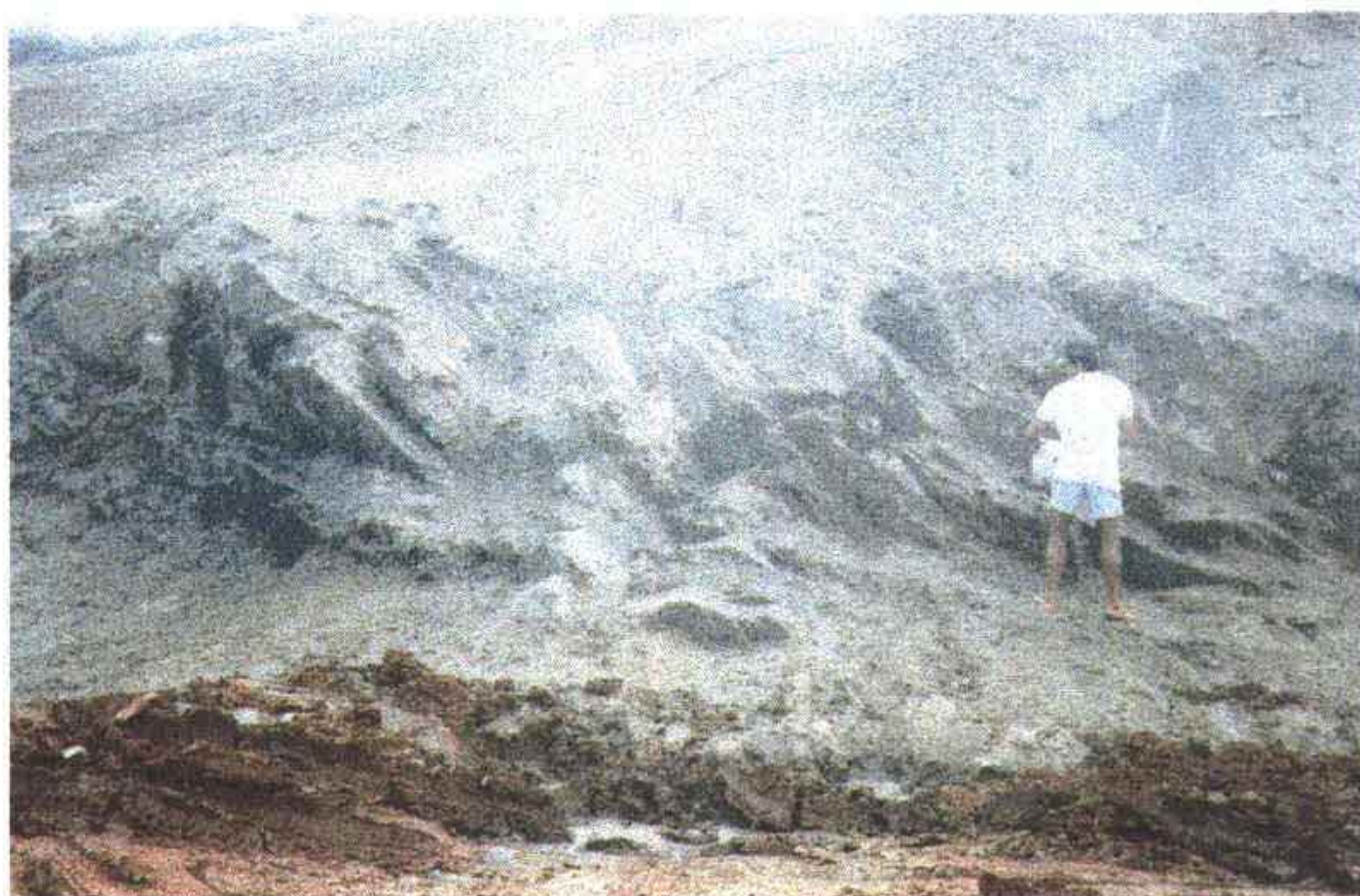
Foto 11 - Ombreira direita. Outra fase da limpeza-fina.
