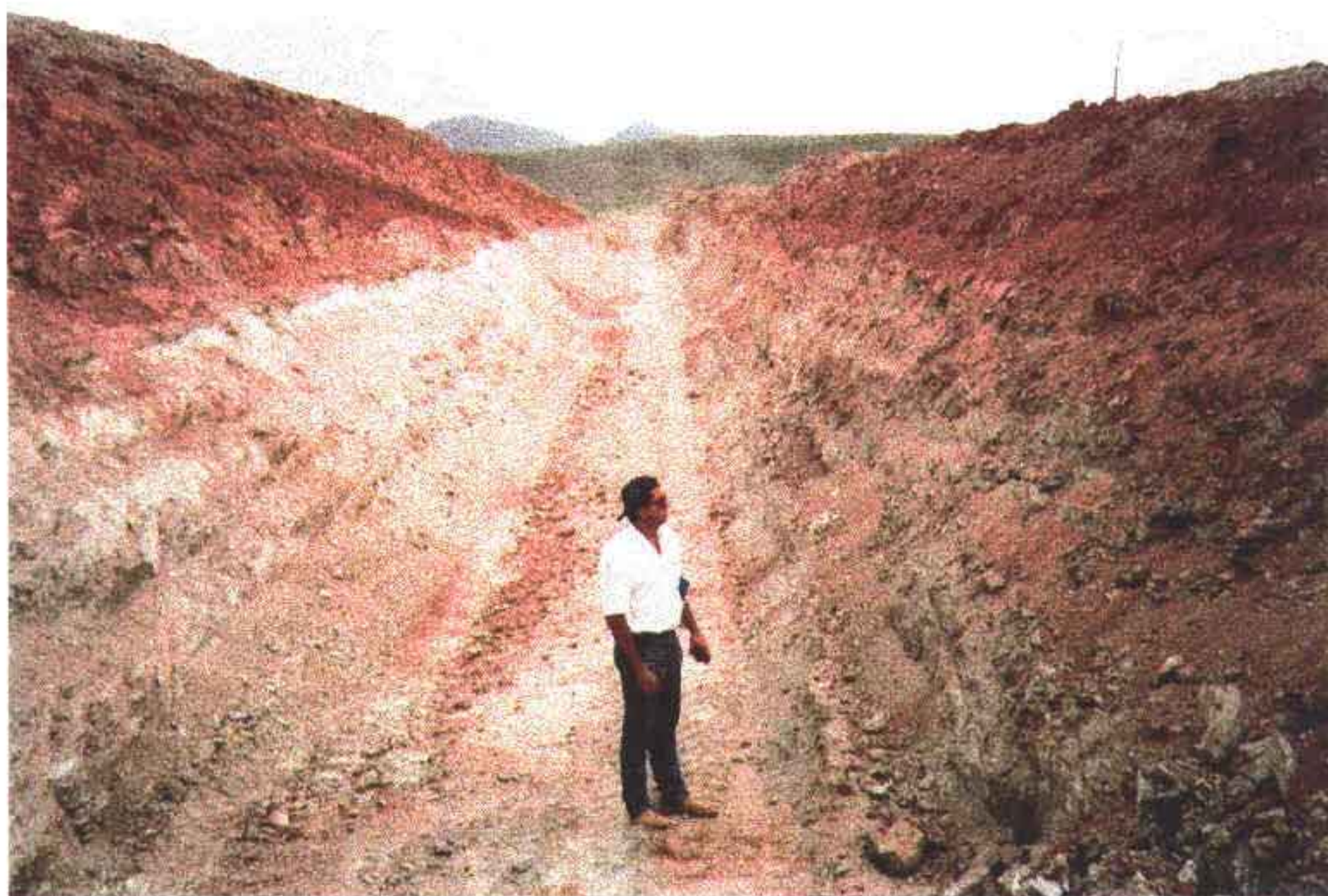
Foto 3 - Escavação da fundação da galeria. Vista de montante para jusante onde observa-se o perfil geológico. Bem definida a separação entre material de 1ª e de 2ª categoria. Já atingida a cota do projeto restando apenas a limpeza fina.
