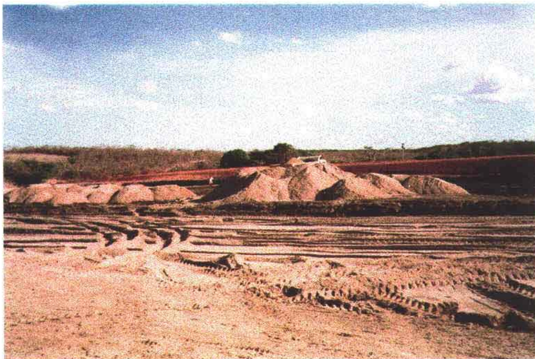
Foto 11 - Depósito de areia para o tapete filtrante horizontal. Ao fundo parte de jusante do maciço, já compactado.
