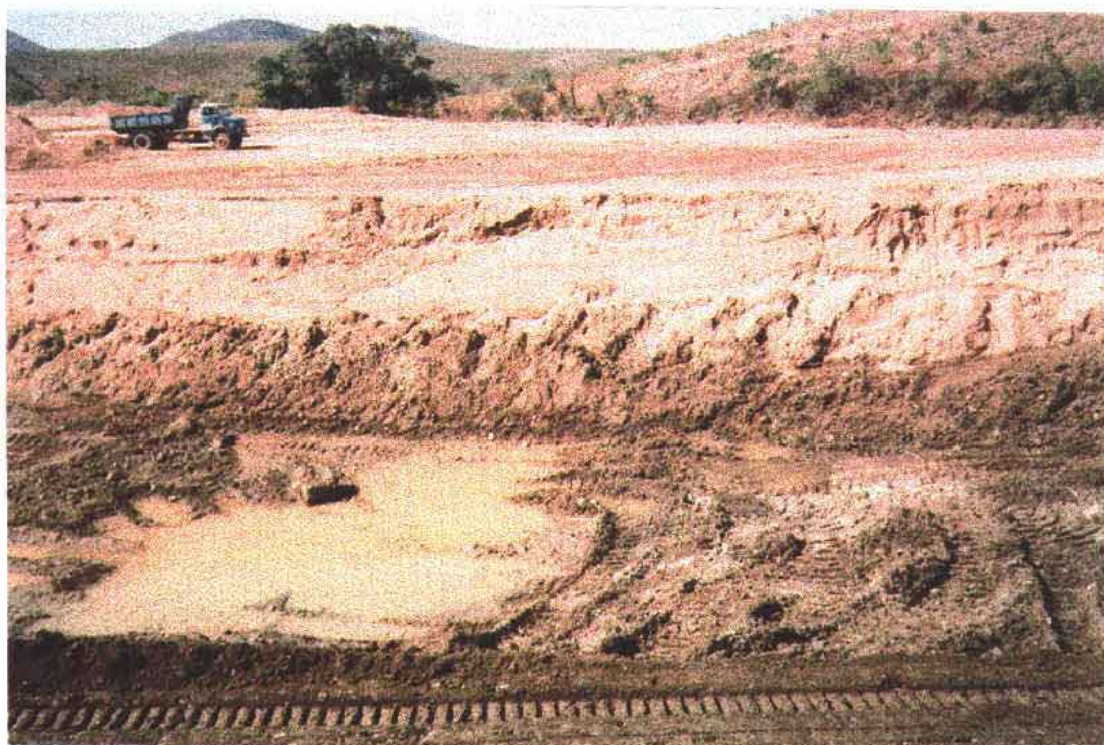
Foto 6 - Cut-off entre estacas 20 e 21. Observa-se surgência sem maiores dificuldades.
