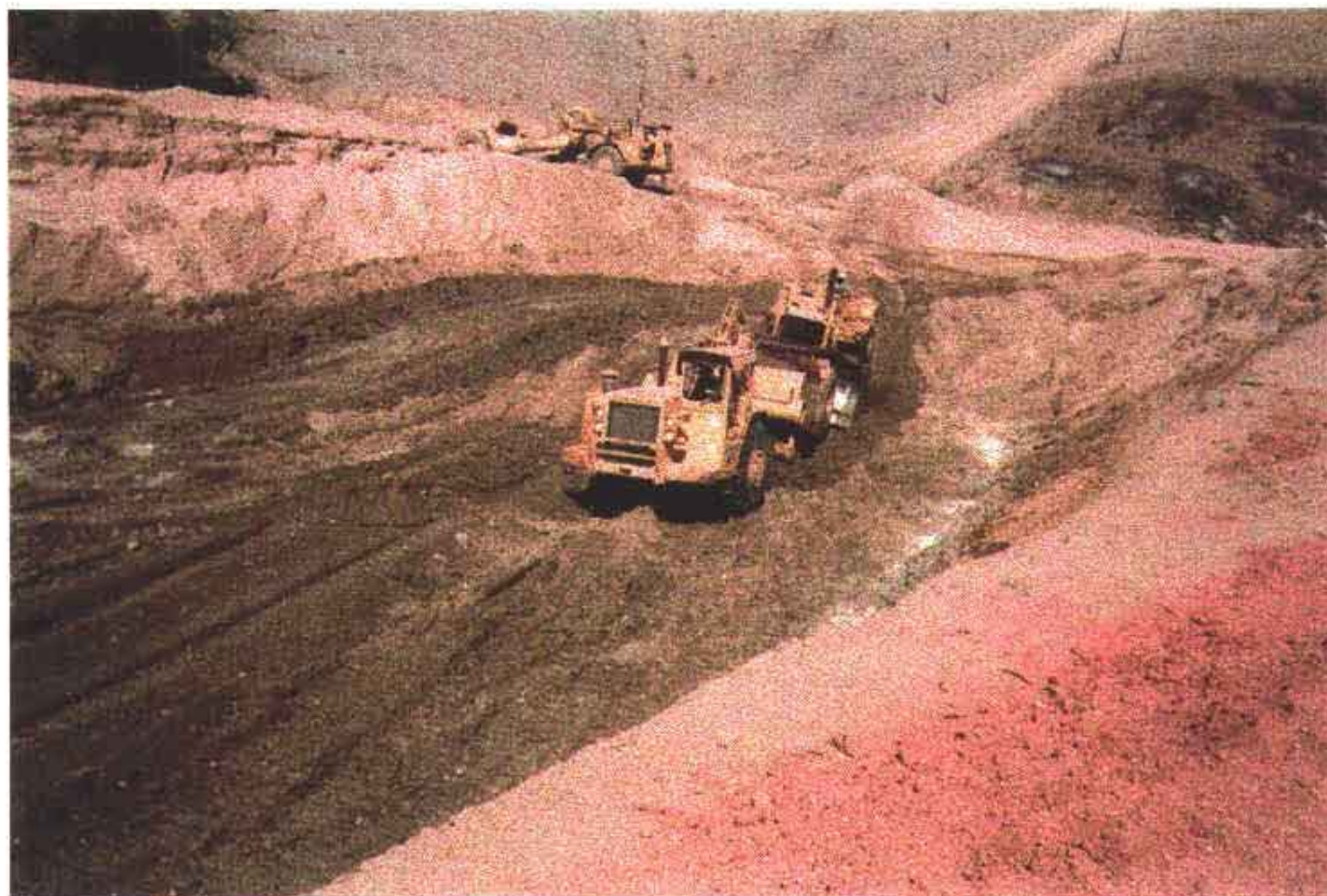
Foto 7 - Escavação do cut-off em torno da estaca 19. A formação rochosa é vista entre a Scraper e o talude da escavação. No canto superior direito observa-se a ombreira direita já expurgada da vegetação existente.
