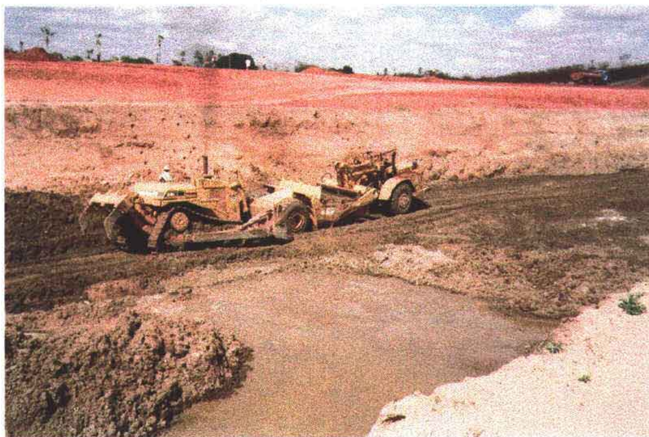
Foto 8 - Cut-off. Na parte inferior da foto observa-se parte do maciço já compactado, lado de montante.
