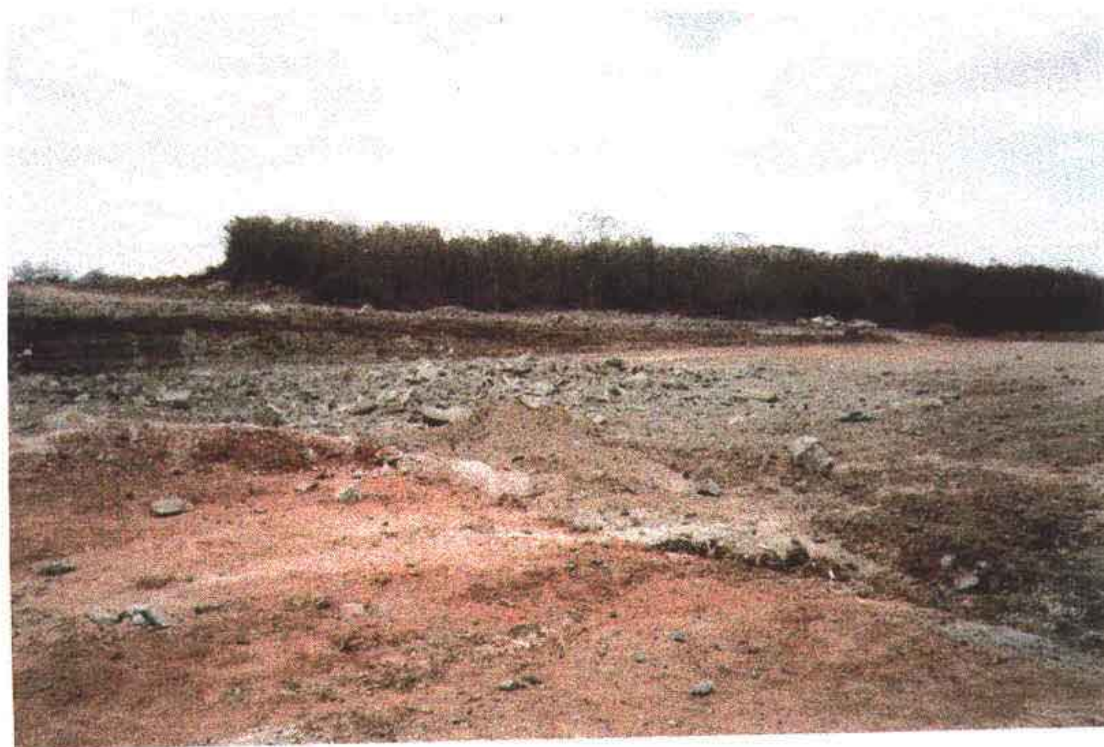
Foto 2 - Vista do sangradouro. Observa-se o perfil da formação geológica no corte. O lado de montante já na cota de projeto.
