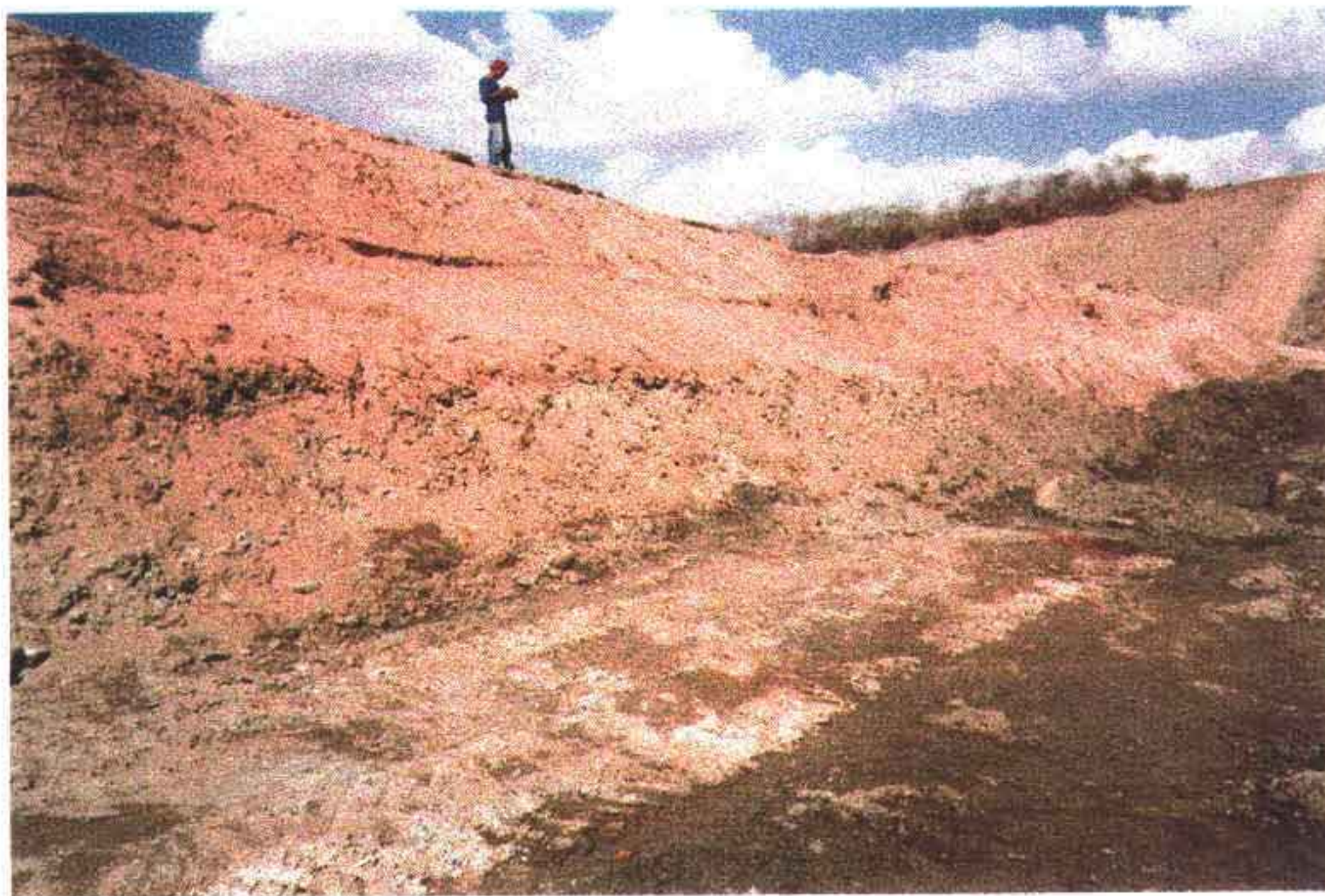
Foto 5 - Escavação do cut-off entre estacas 17 e 18. Espessa camada de seixo rolado é observada. O projeto prevê a cobertura da camada de seixo com filtro. Na parte inferior da foto pode ser observada a rocha já aflorando. Resta a limpeza fina para ser liberado o cut-off para enchimento.
