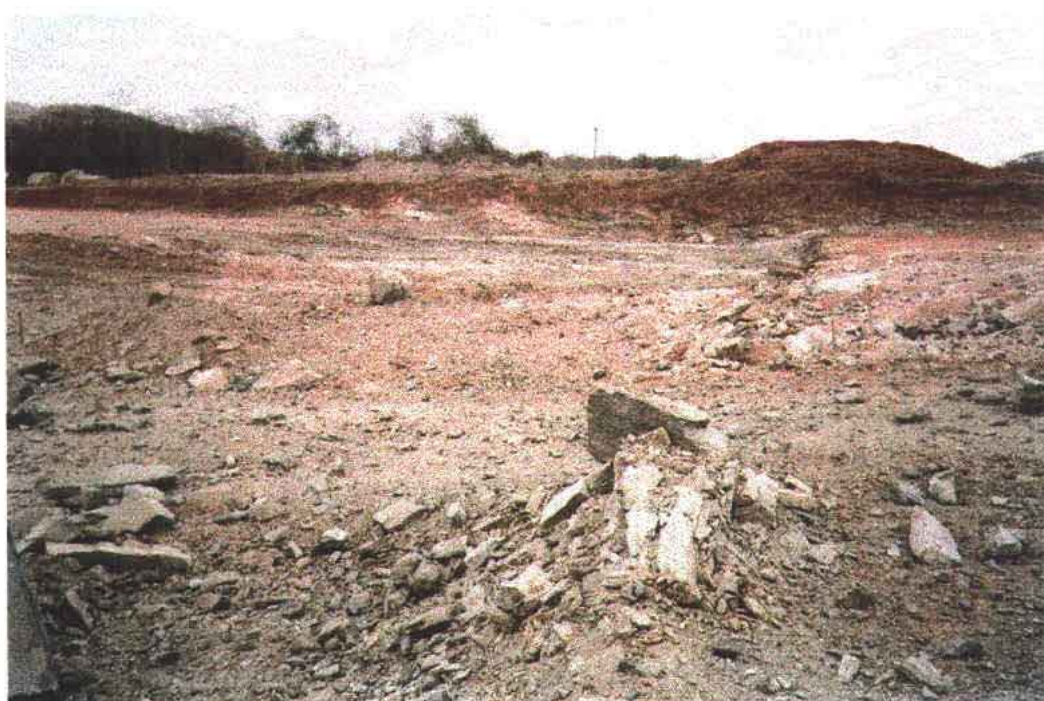
Foto 1 - Vista do sangradouro separando o eixo. Observa-se a formação rochosa e a extremidade da barragem auxiliar , já na cota do coroamento.
