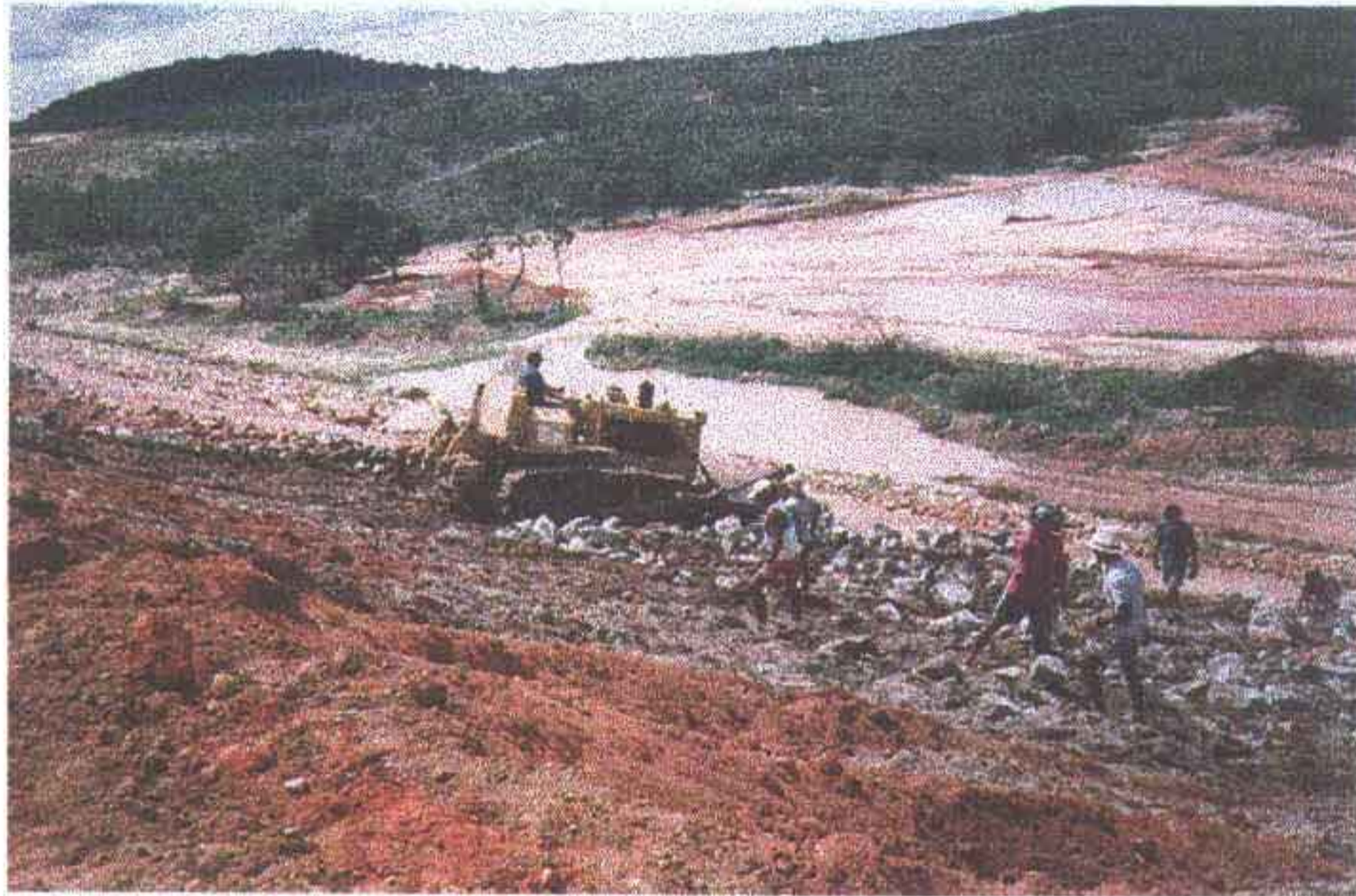
Foto 05 - Operação de espalhamento de bica-corrída com emprego de trator.
