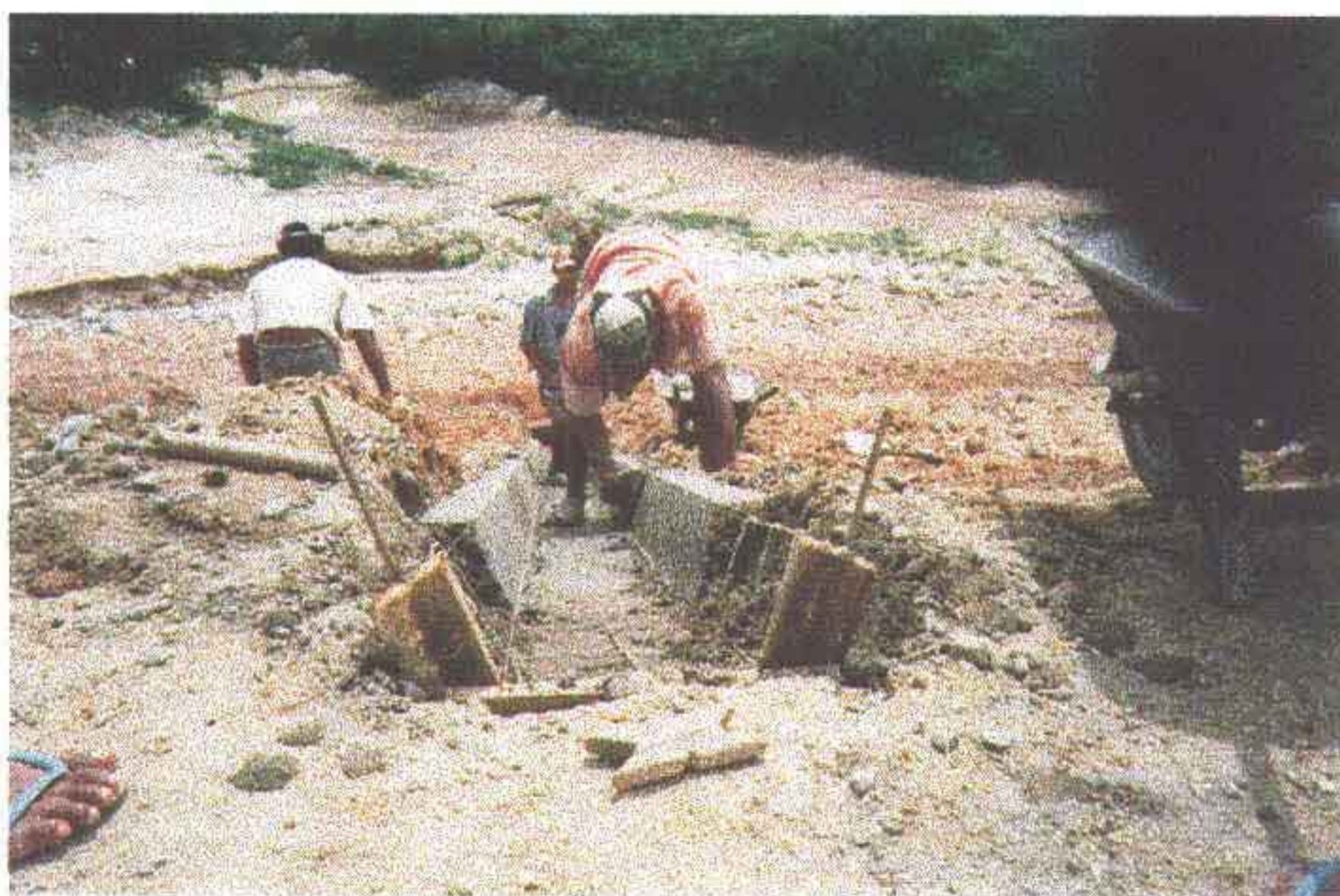
Foto 15 - Execução de rápido de descida, observe a ferragem lateral.
