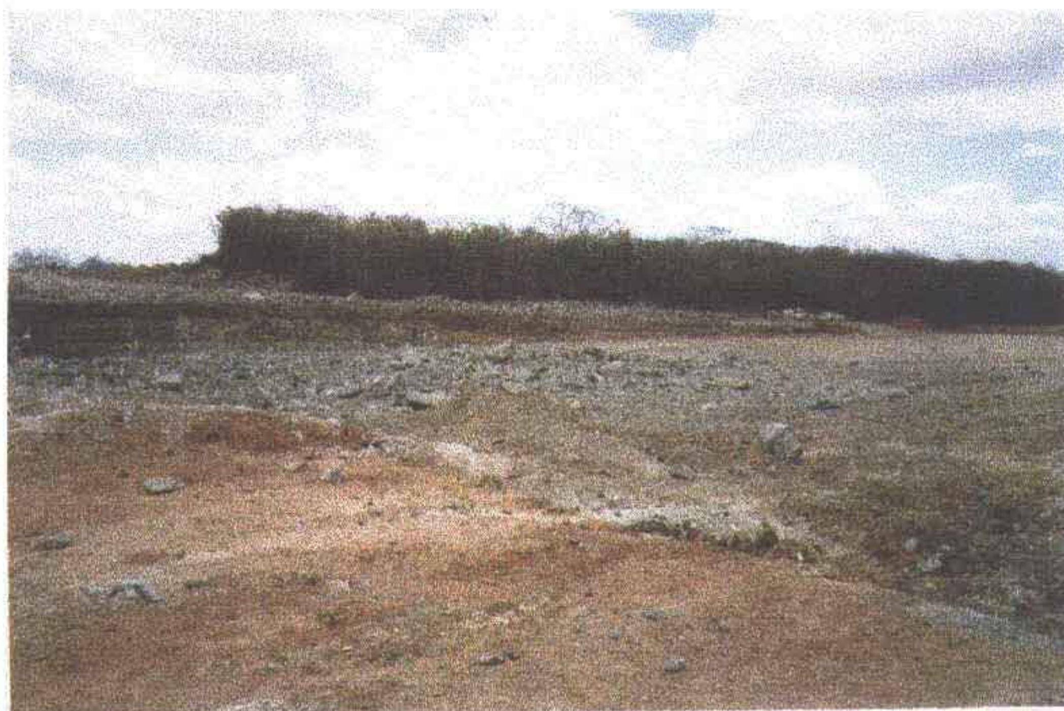
Foto 1 - Vista do sangradouro. Observa-se o perfil da formação geológica no corte. O lado do montante já na cota de projeto.
