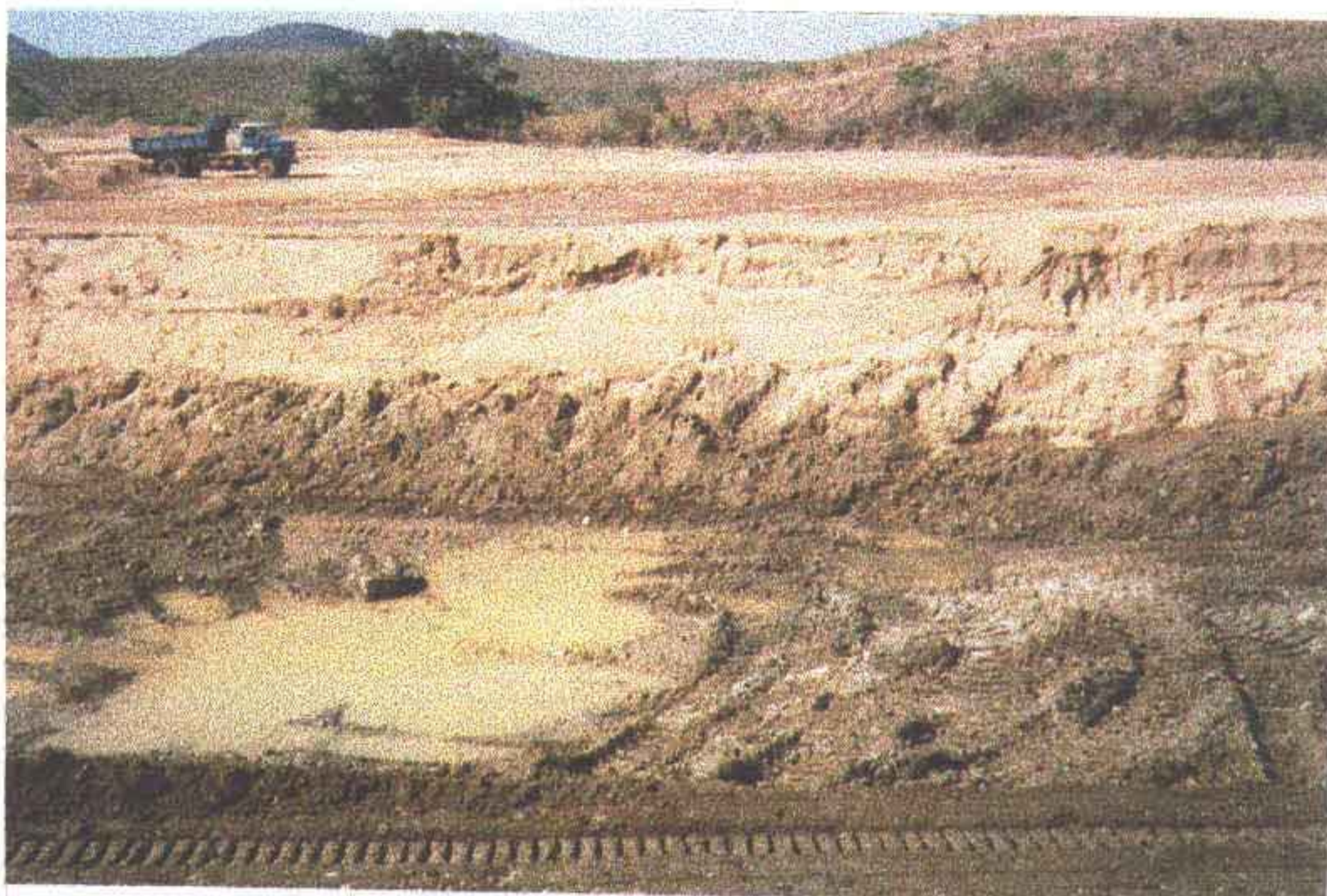
Foto 5 - Cut-off entre estacas 20 e 21. Observa-se surgência sem maiores dificuldades.
