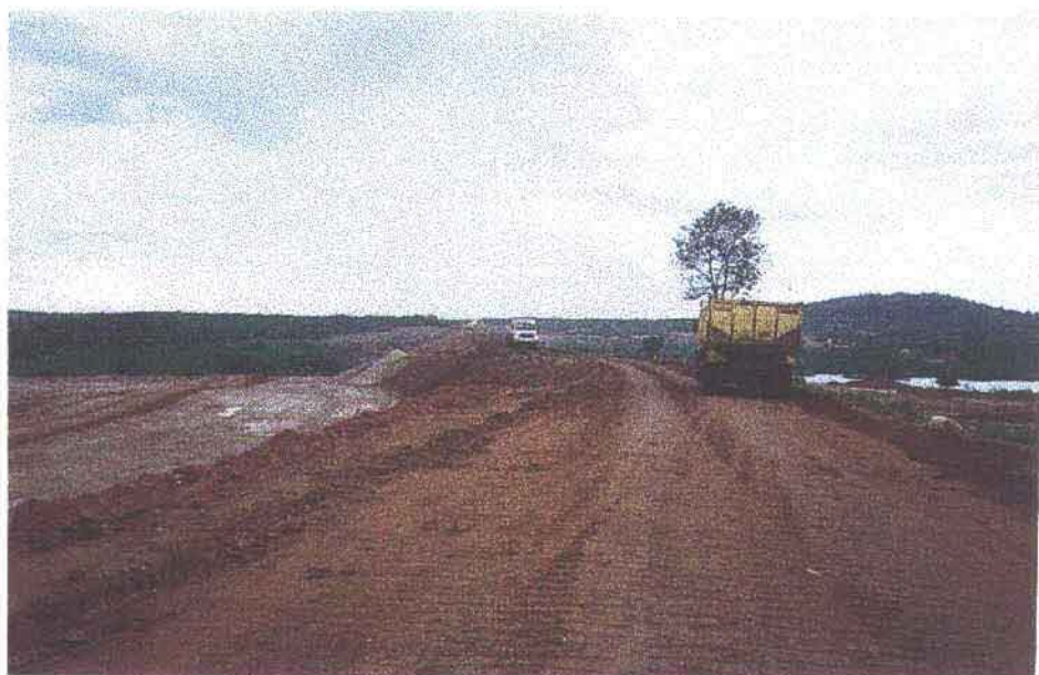
Foto 06 - Vista do maciço, tomada a partir da ombreira esquerda.
