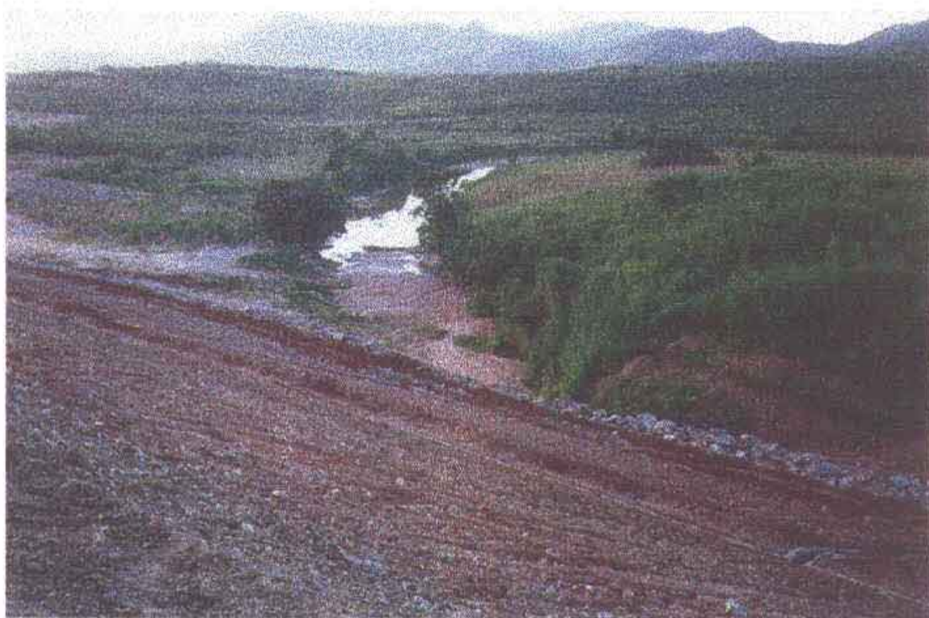
Foto 04 - Calha do rio a jusante do maciço. Observe no pé do talude a inexistência de surgência.
