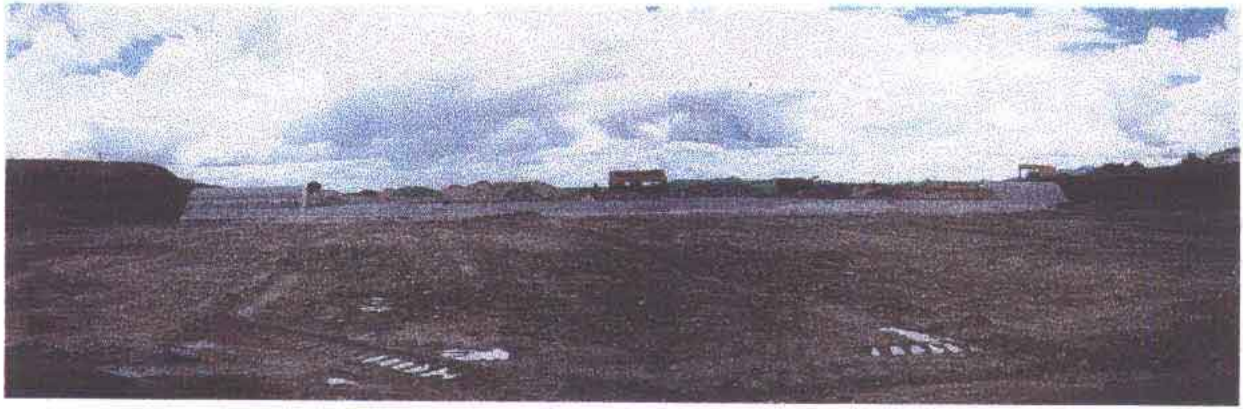
Foto 14 - Vista frontal do sangradouro em muro Creager, tomada a partir de jusante. Verifique o nível da concretagem do mesmo.
