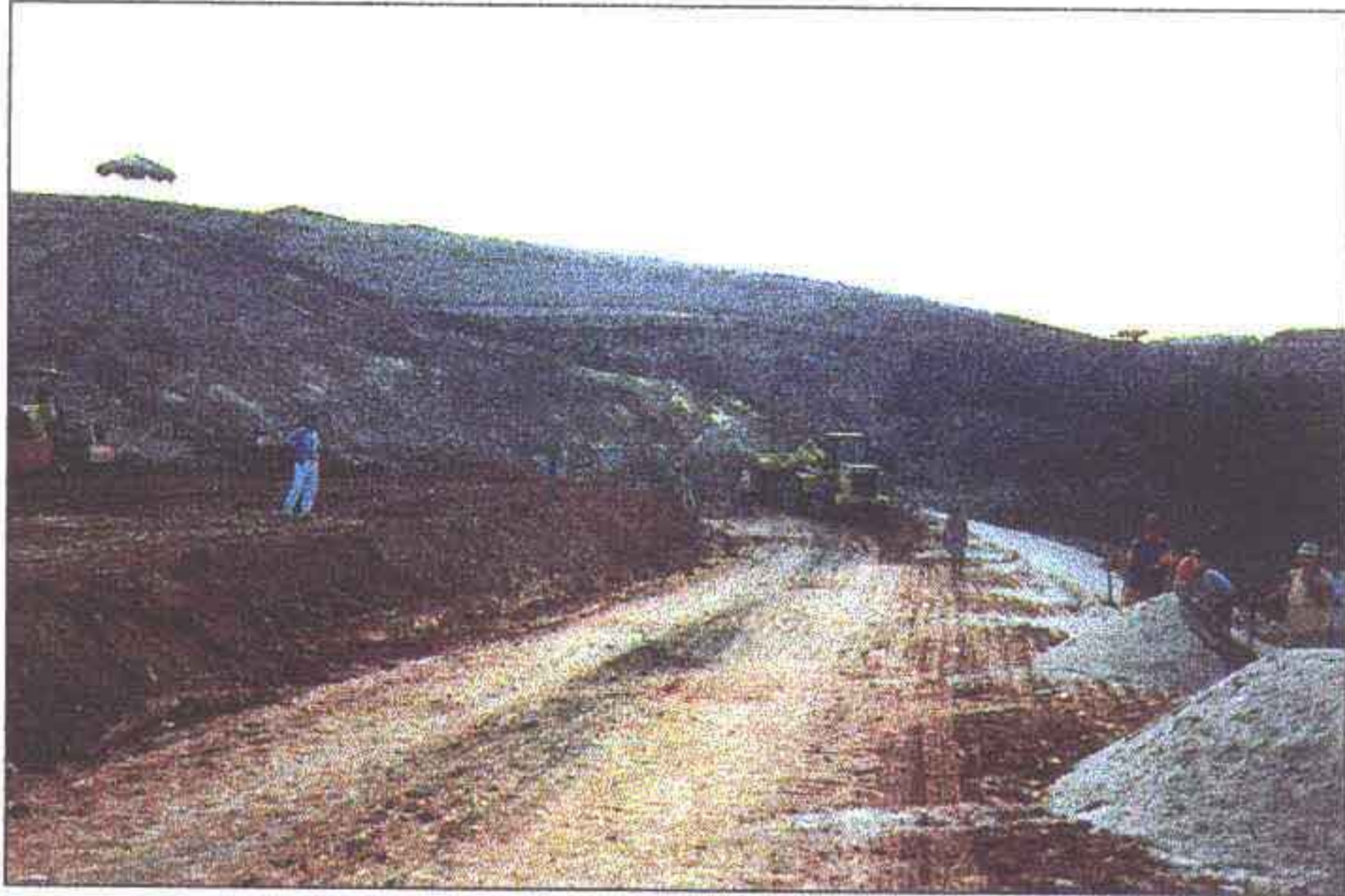
Operação de limpeza de material inconsolidado(Expurgo) realizado na ombreira direita com o uso da pá carregadeira.
