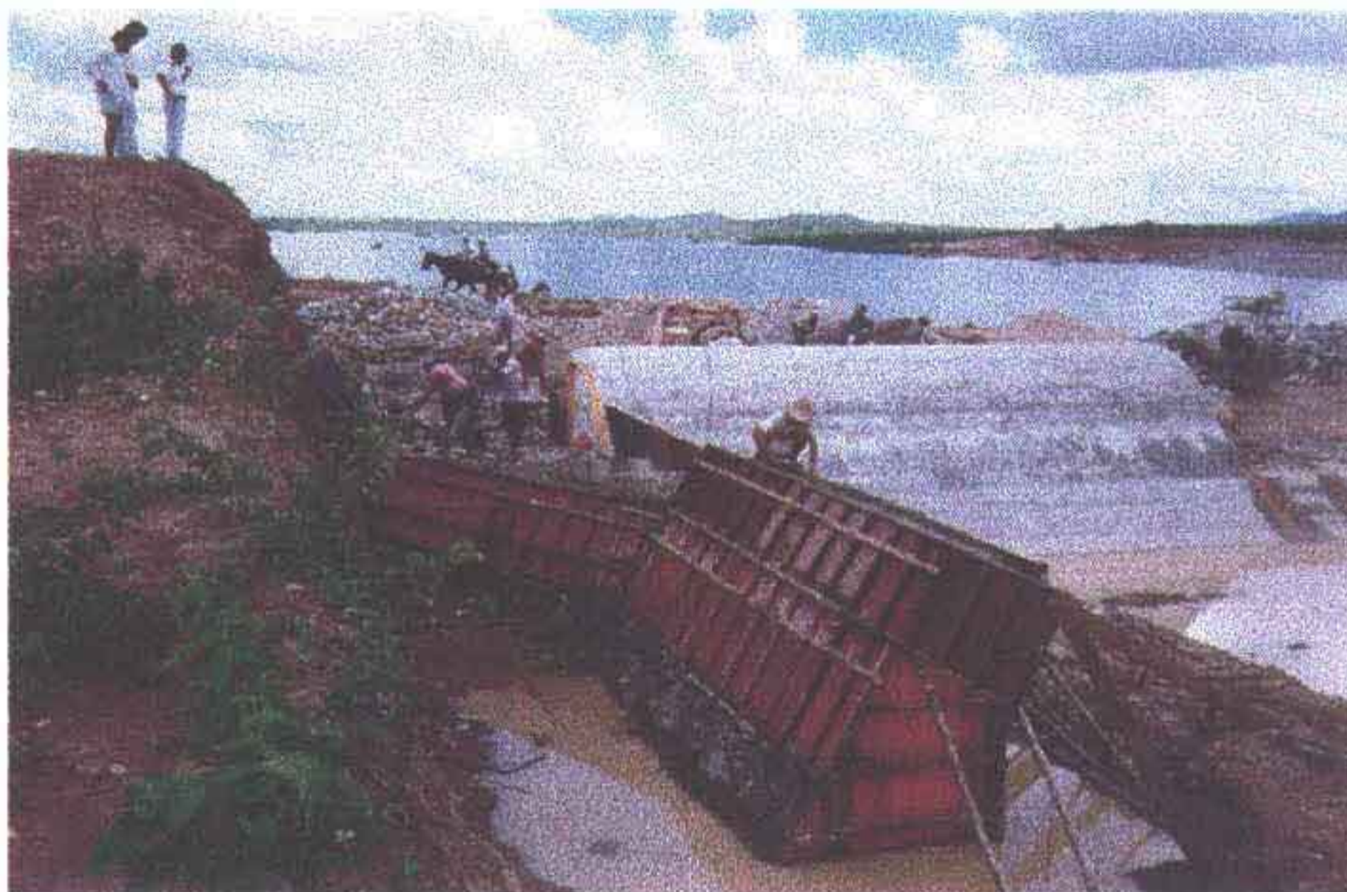
Foto 22 - Construção do muro lateral. A esquerda extremidade da barragem auxiliar na cota do coroamento.
