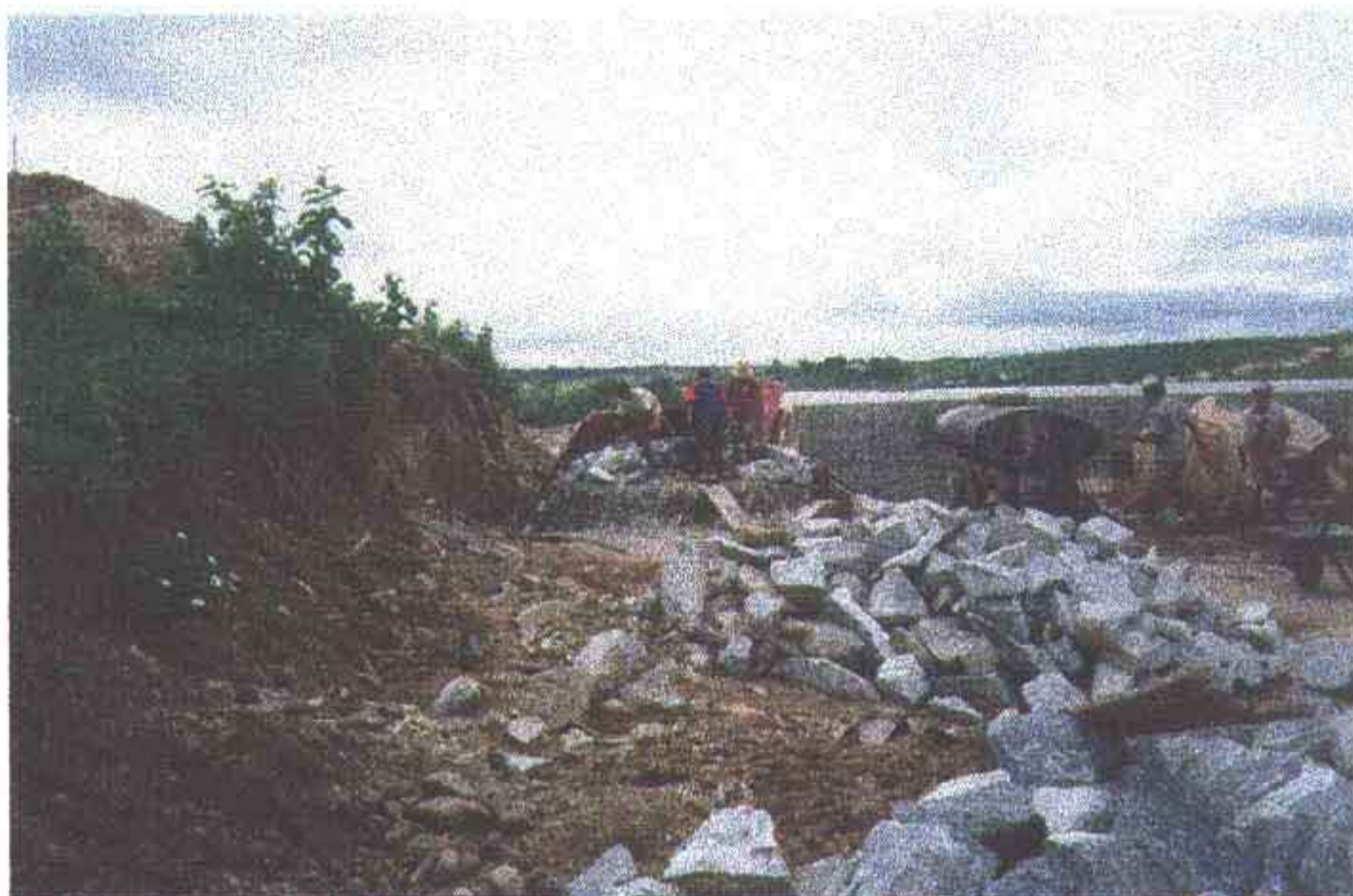
Foto 20 - Construção do muro lateral direito do sangradouro.
