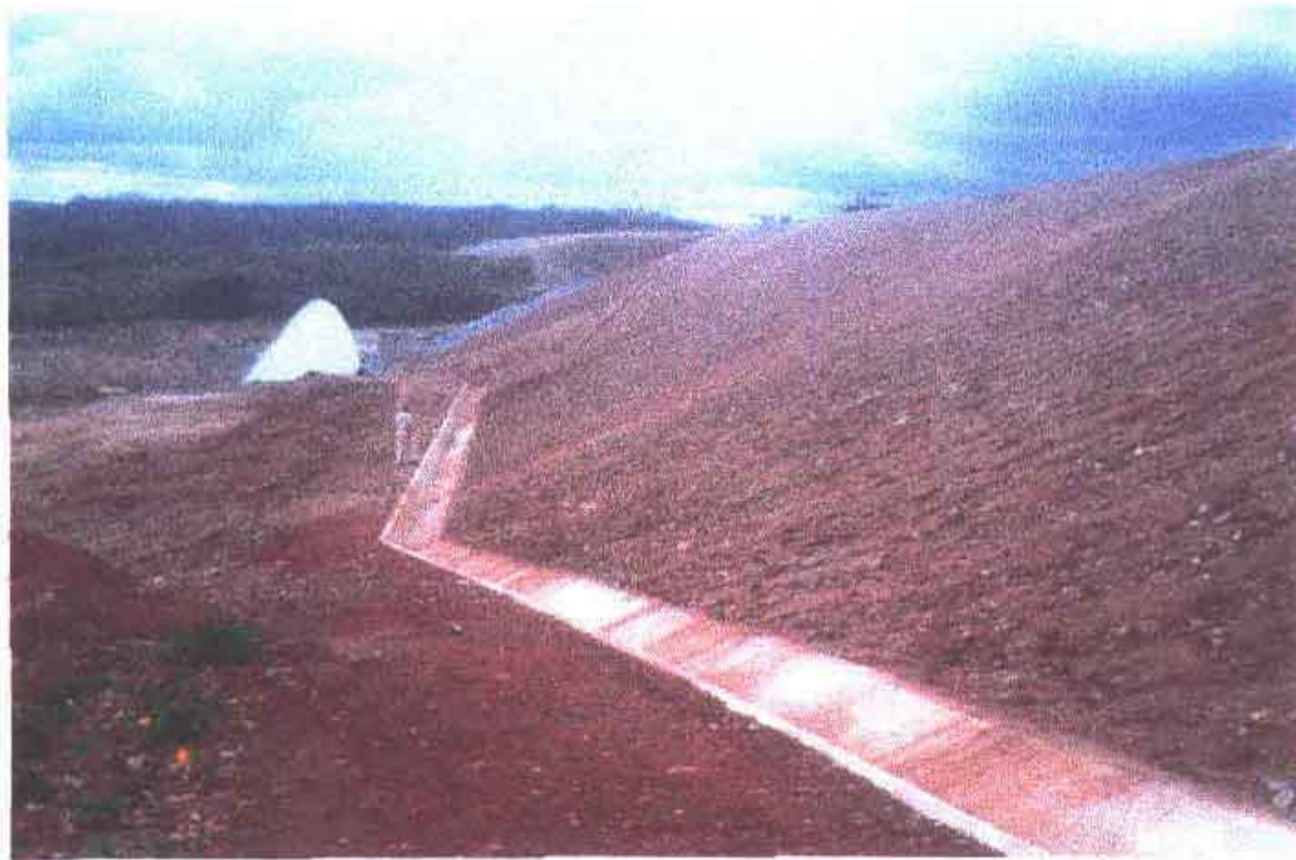
FOTO 9 - Vista da calha e válvula dispersora na ombreira esquerda
