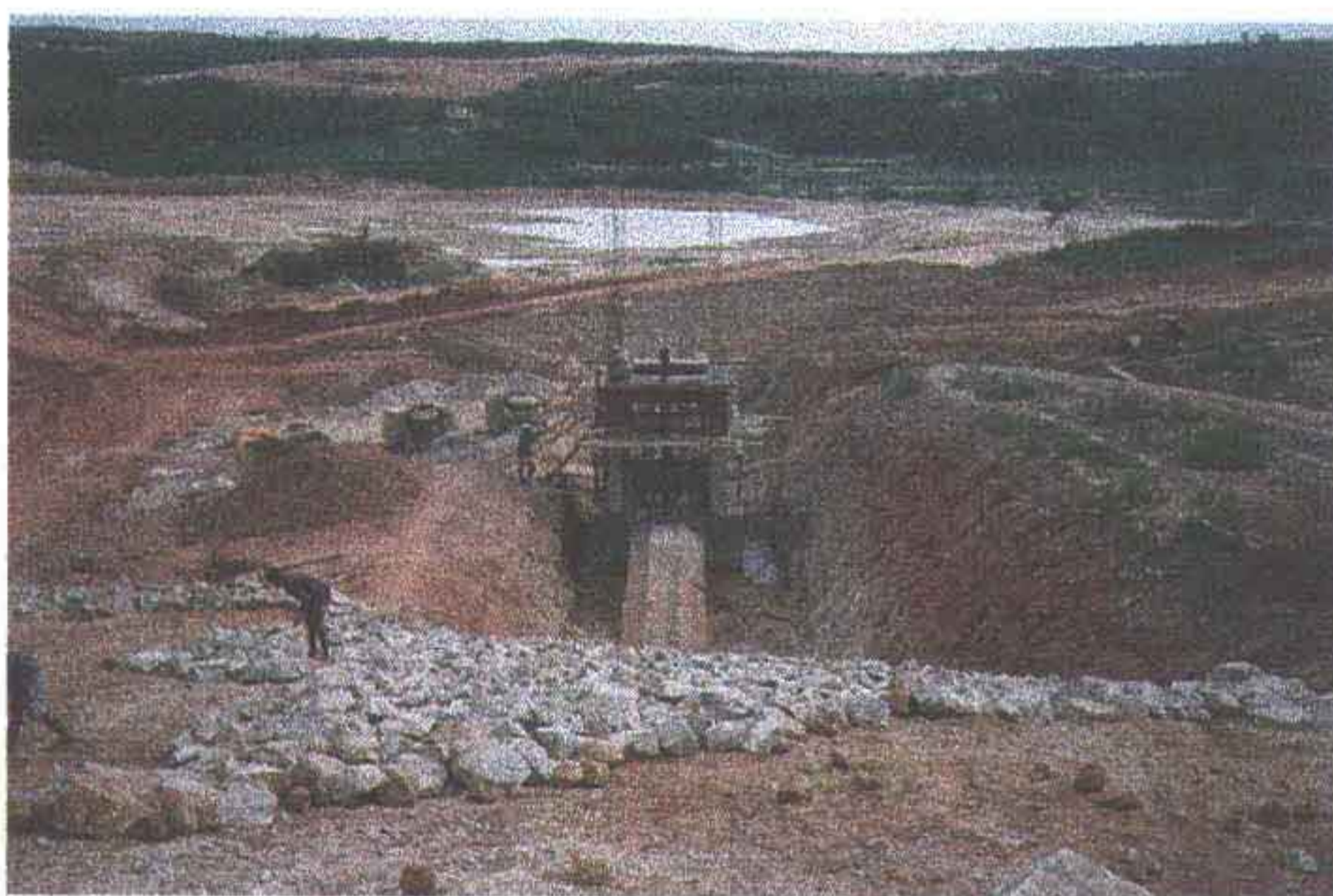
Foto 10 - Vista da estrutura da tomada d'água a montante. Observe o encontro da galeria com a torre e a cava que será preenchida com solo compactado.
