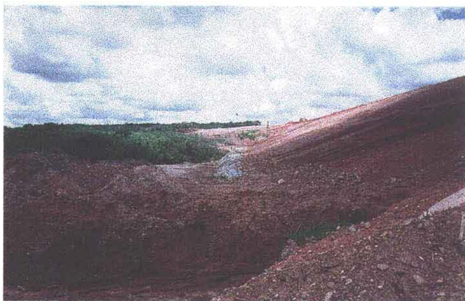
Foto 07 - Vista de jusante. Observe o aspecto do enrocamento de pé, "rock-fill". Até o momento encontra-se na cota 135,50 e deverá atingir a cota de projeto a 136,00.
