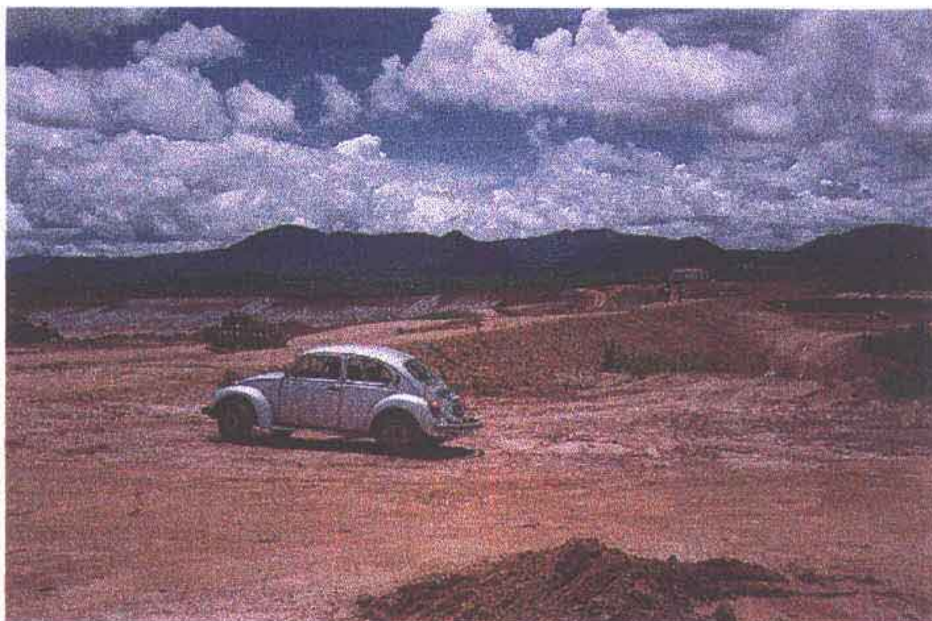
Foto 08 - Barragem auxiliar, vista tomada de jusante a partir da ombreira direita .
