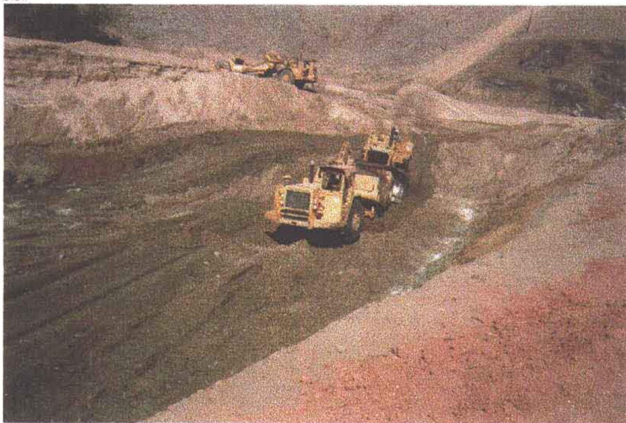
Foto 6 - Escavação do cut-off em torno da estaca 19. A formação rochosa é vista entre a Scraper e o Talude da escavação. No canto superior direito observa-se a ombreira direita já expurgada da vegetação existente.
