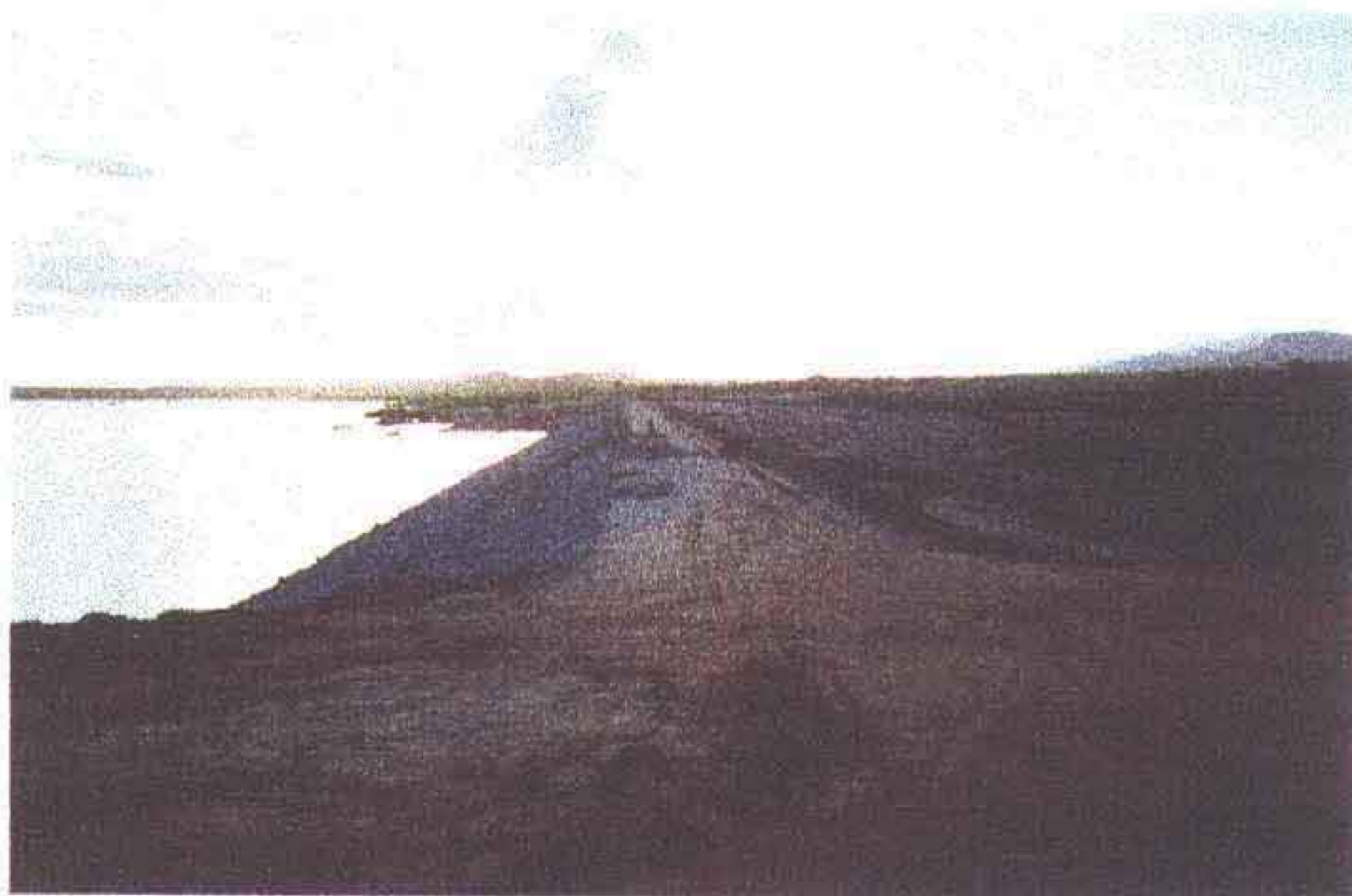
Foto 02 - Execução de enrocamento com operação manual. A direita acabamento do meio fio.
