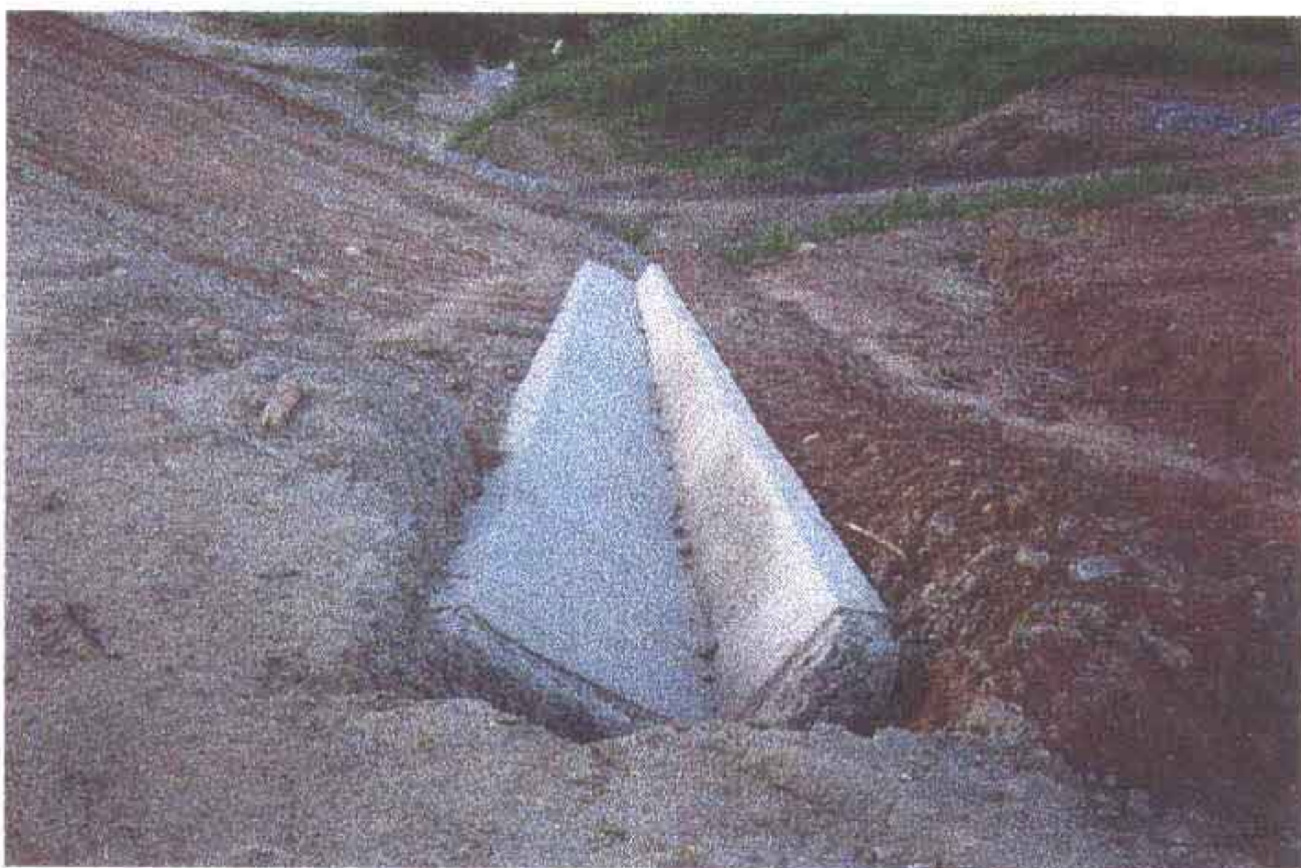
Foto 06 - Vista parcial da calha de ombreira a partir do coroamento. Observe a espessura e a qualidade visual do concreto.
