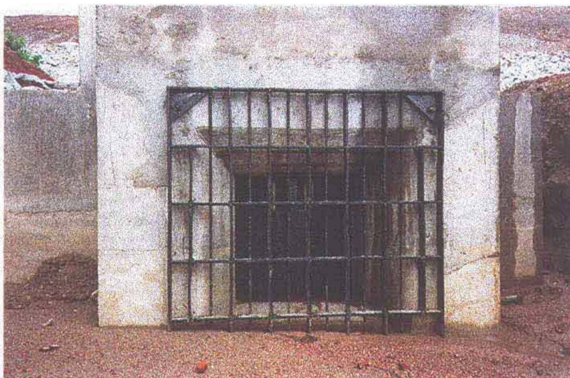
Foto 10 - Boca de entrada da galeria. Verifique ao centro, o by-pass adaptado a comporta.
