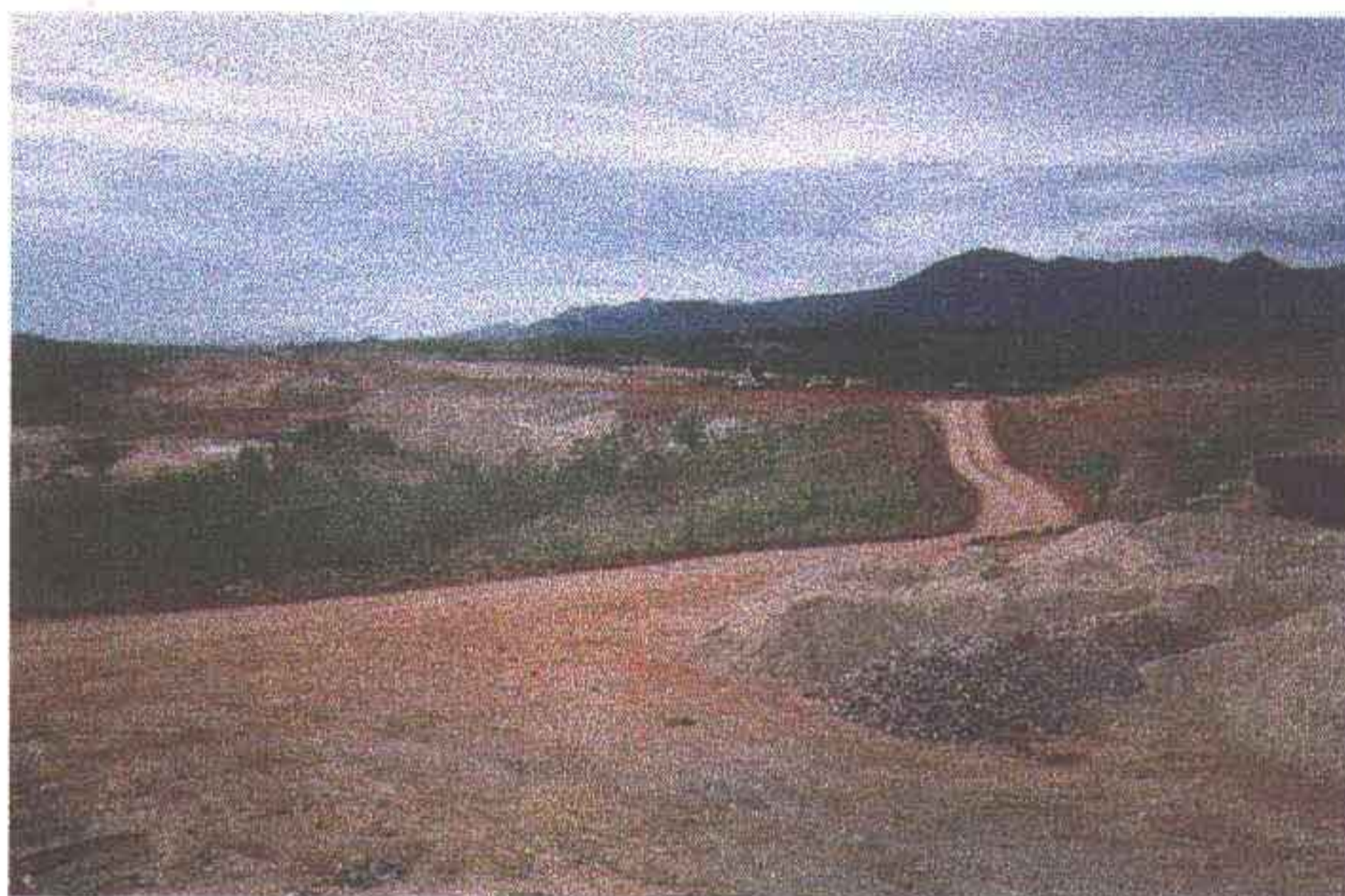
Foto 01 - Vista geral da barragem, tomada a partir da ombreira direita a montante no local do sangradouro.
