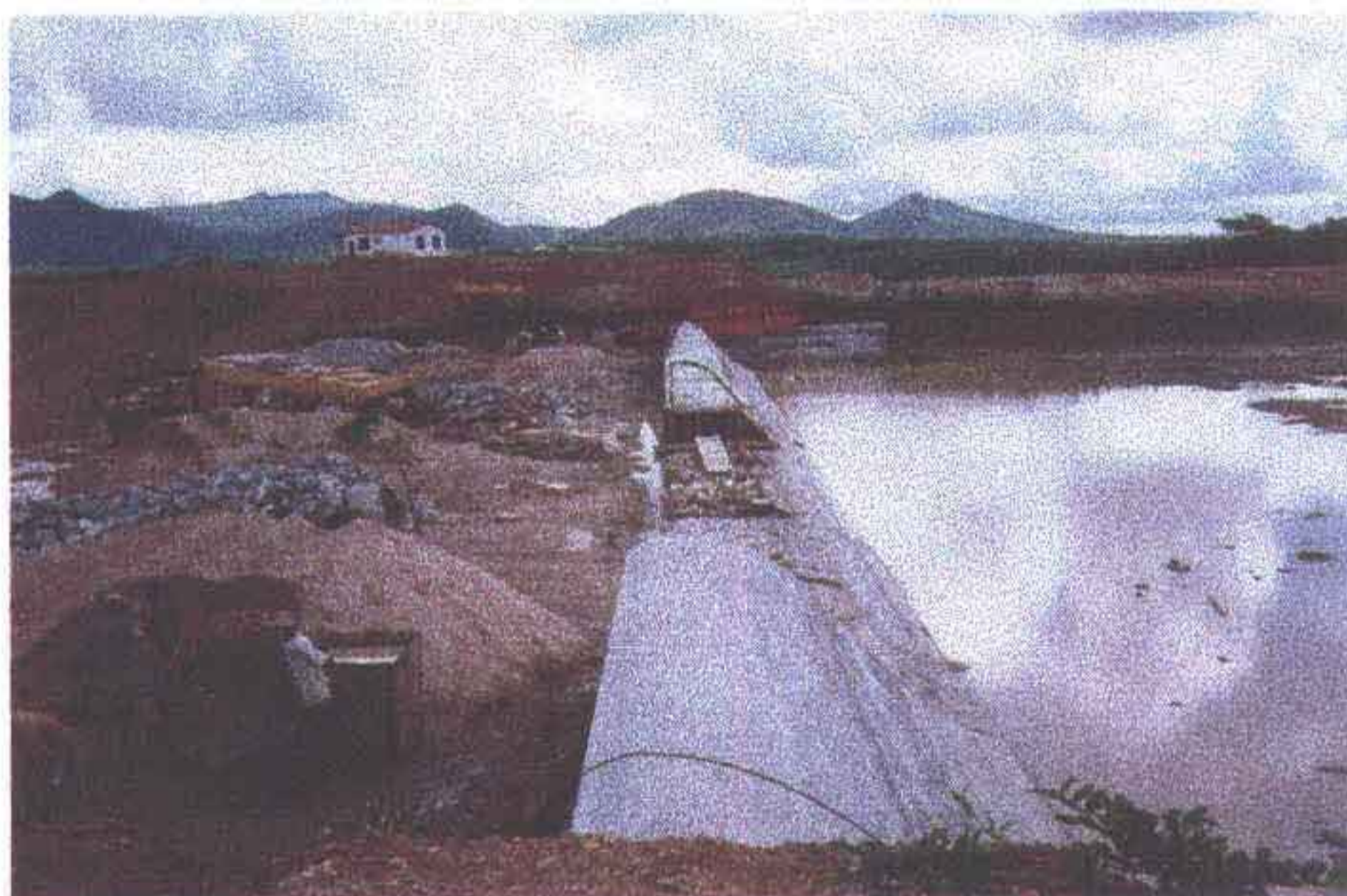
Foto 17 - Vista do Creager e muro lateral em execução.
