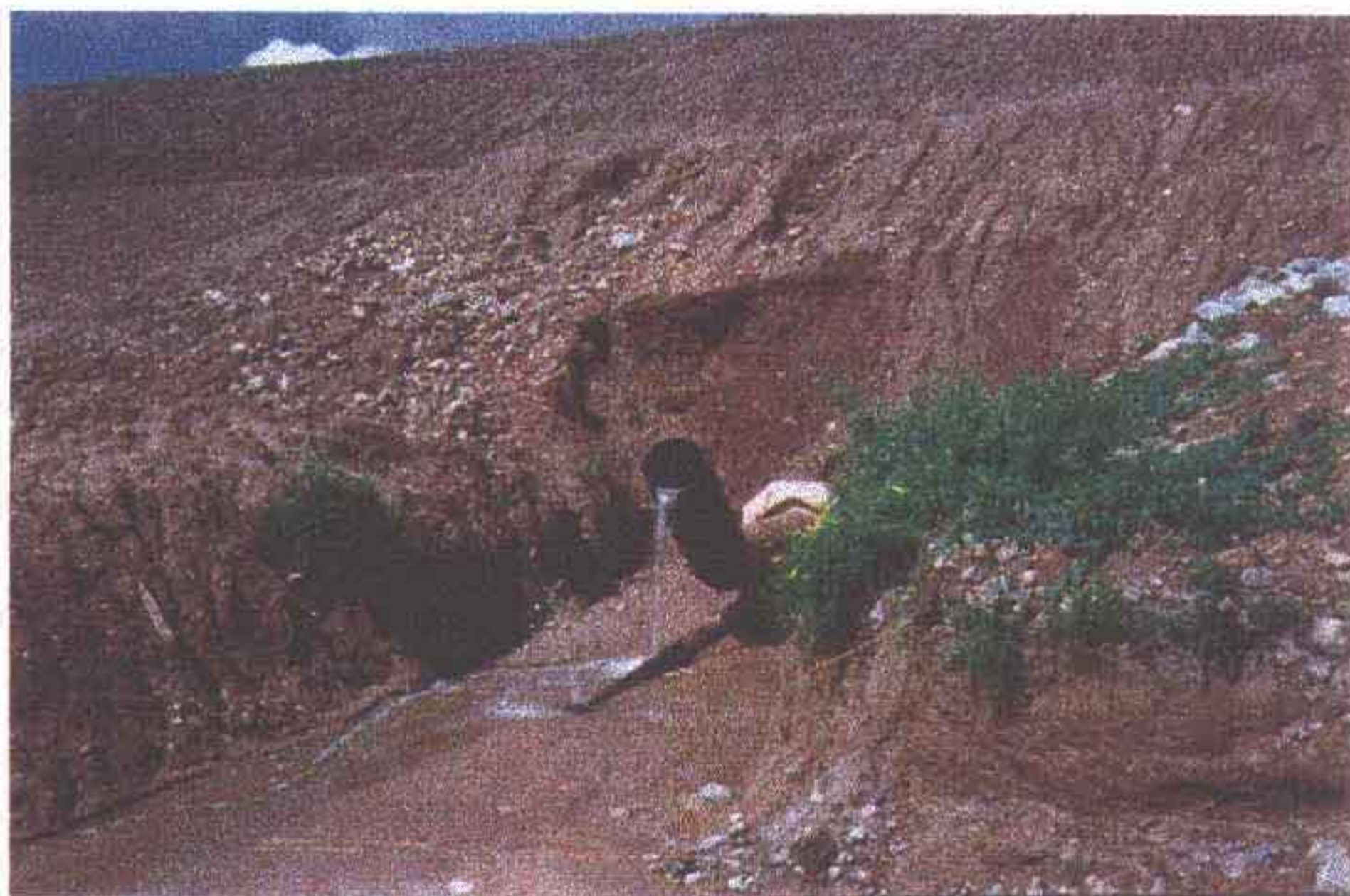
Foto 09 - Extremidade de jusante da tubulação da tomada d'água.
