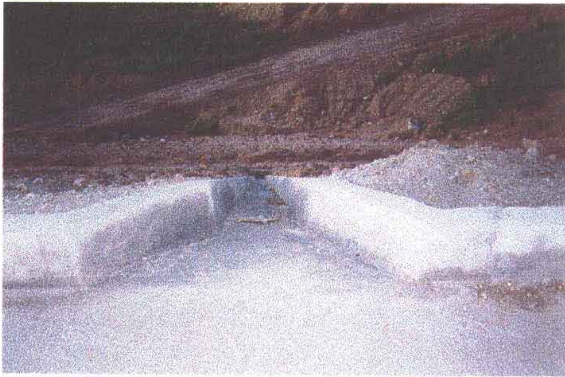
Foto 07 - Encontro do meio-fio com o rápido de descida, ao fundo a calha coletora.
