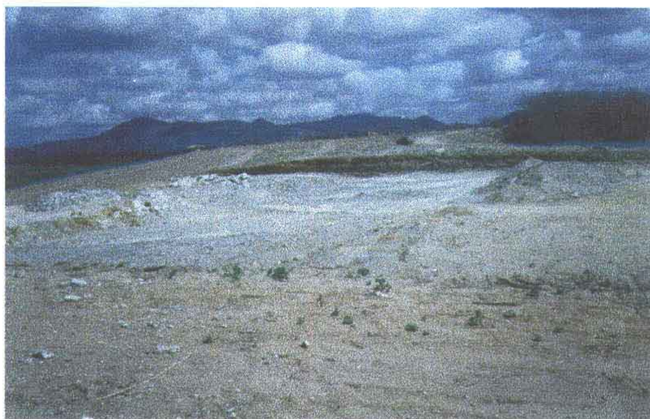
Foto 2 - Escavação do sangradouro. Observa-se a formação rochosa do local da bacia, rocha gnáissica. Já atingida a cota de projeto
