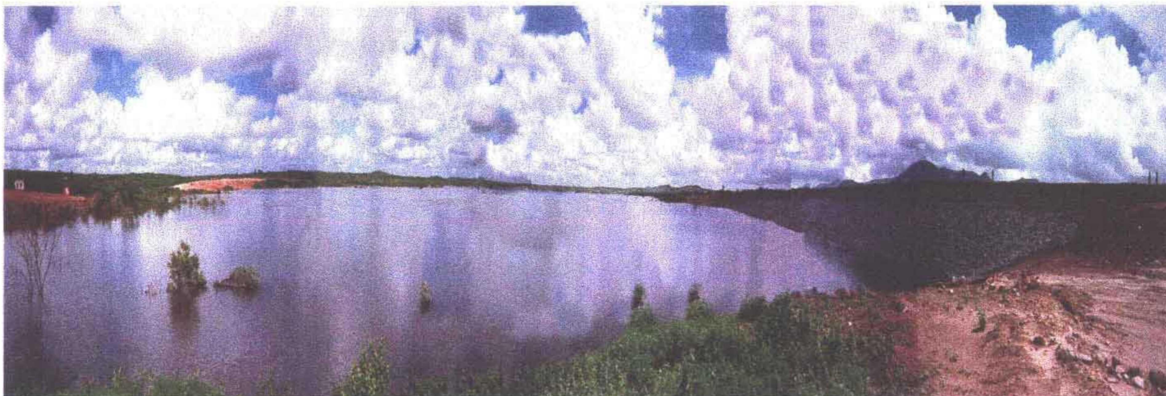
Foto 03 - Vista parcial do lago, a direita o talude de montante.
