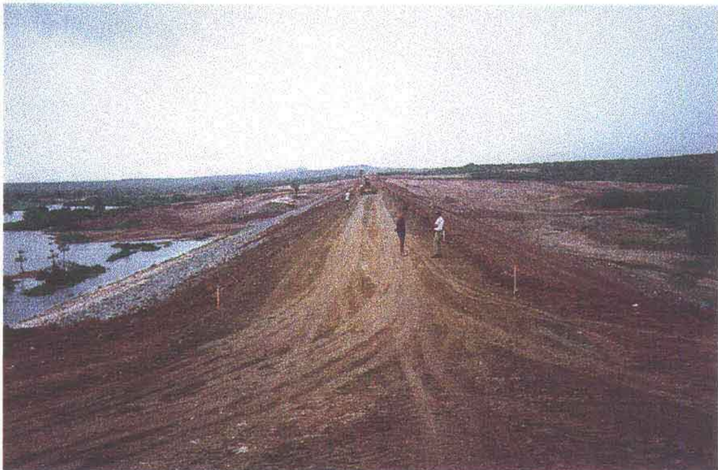
Foto 05 - Vista do maciço, tomada a partir da ombreira direita do eixo do coroamento.
