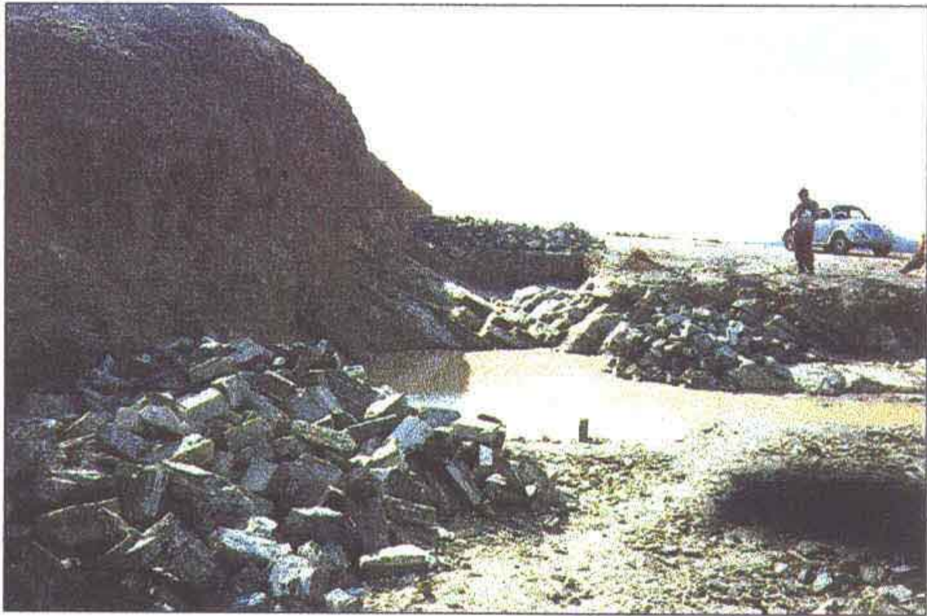
Trecho do sangradouro na fundação do muro lado direito, onde foi executado escavação manual.
