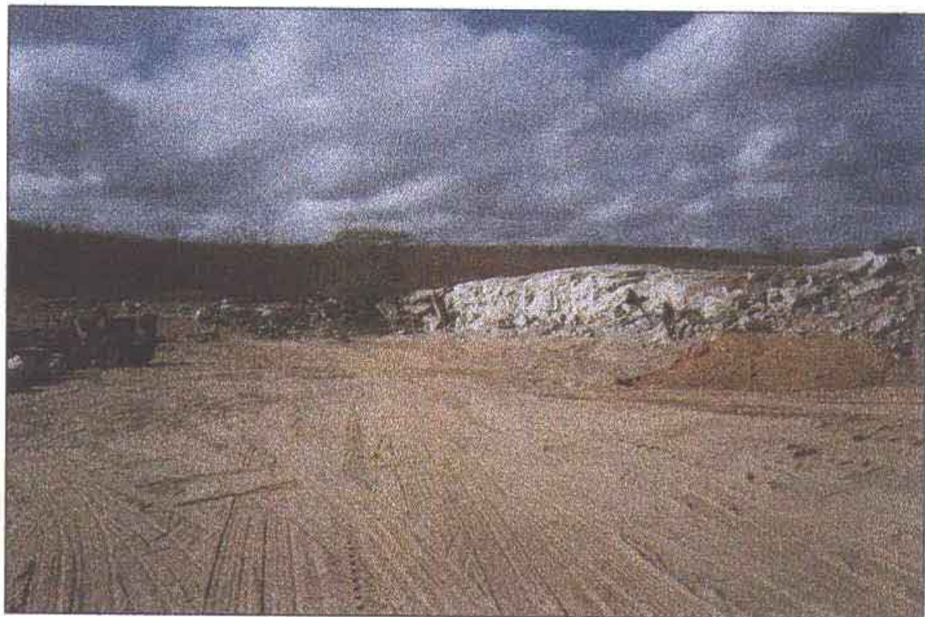
Pedreira. Observe-se a bancada formada após a decapagem.
