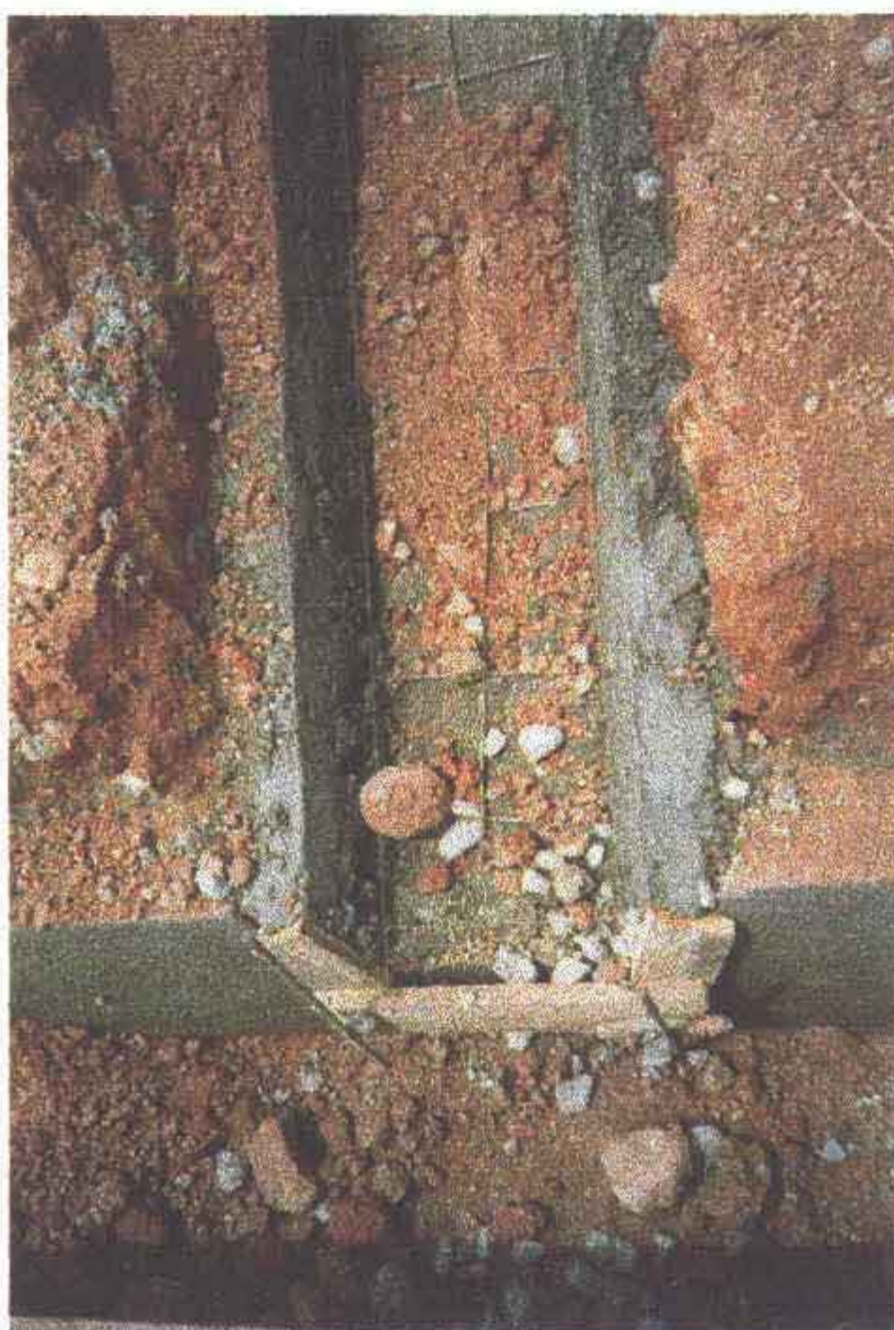
Foto 14 - Execução de rápido de descida, observe a ferragem ao fundo.
