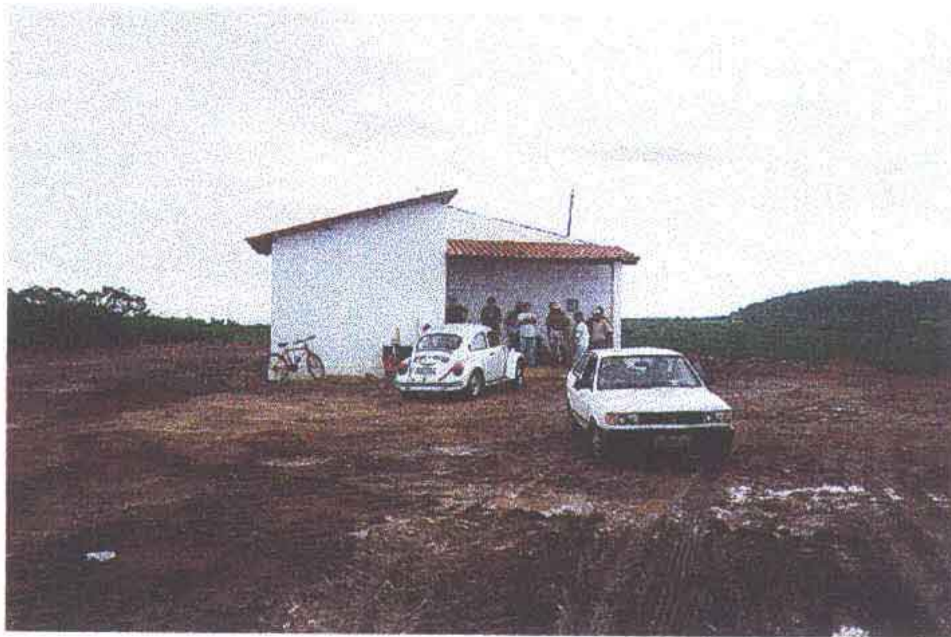
Foto 16 - Vista da casa de residência da barragem.
