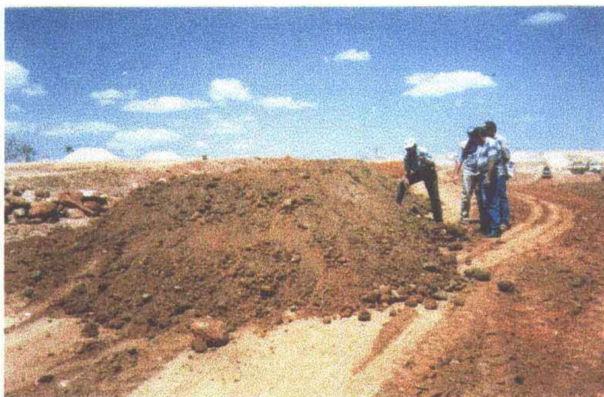
Foto 8 - Material lançado na praça de compactação. Objeto do exame táctil-final.
