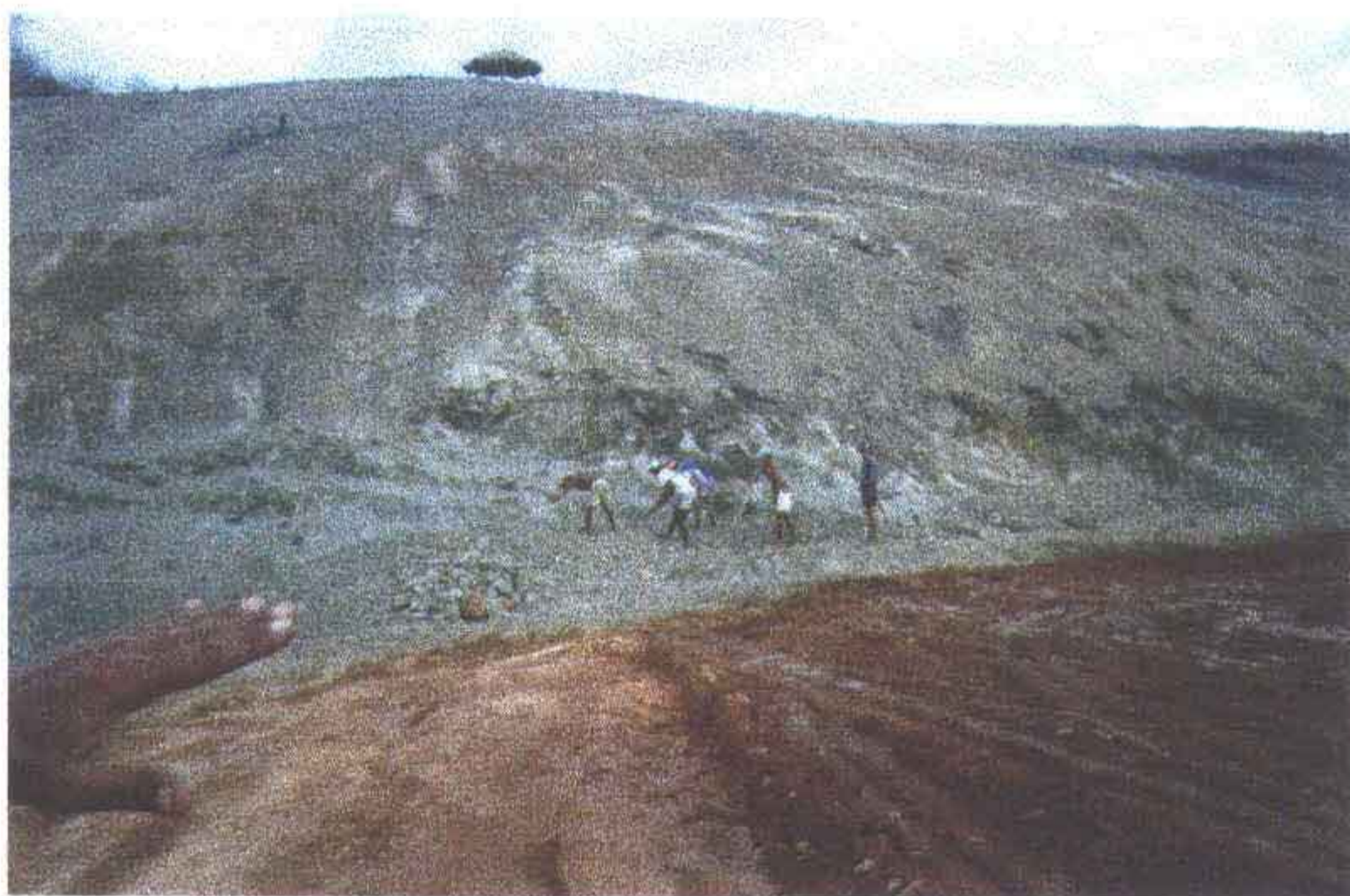
Foto 10 - Ombreira direita. Observa-se a natureza da rocha. Foto feita durante limpeza-fina.
