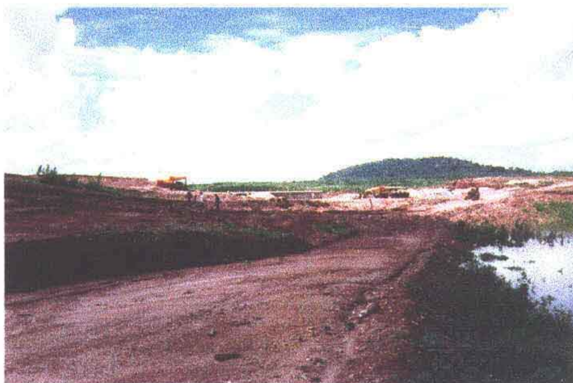
Foto 19 - Vista a montante do muro Creager, observe o nível d'água.
