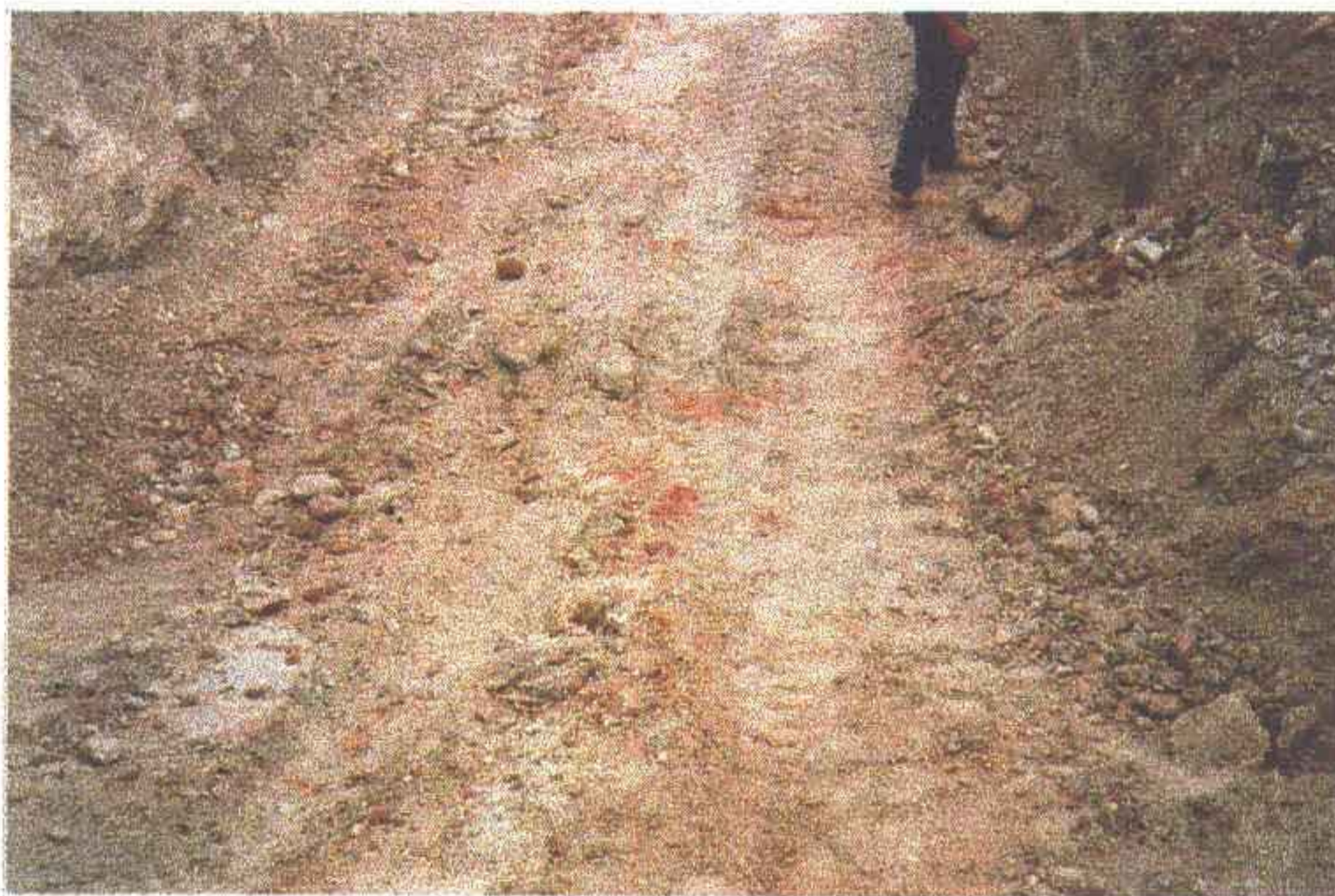
Foto 3 - Local da fundação da torre de controle. Este local será rebaixado para execução do bloco de apoio.
