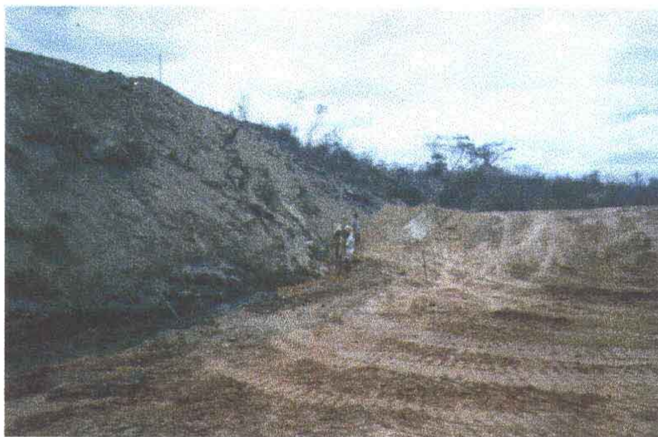
Foto 6 - Encontro da ombreira direita. Observa-se a limpeza manual da rocha do encontro.
