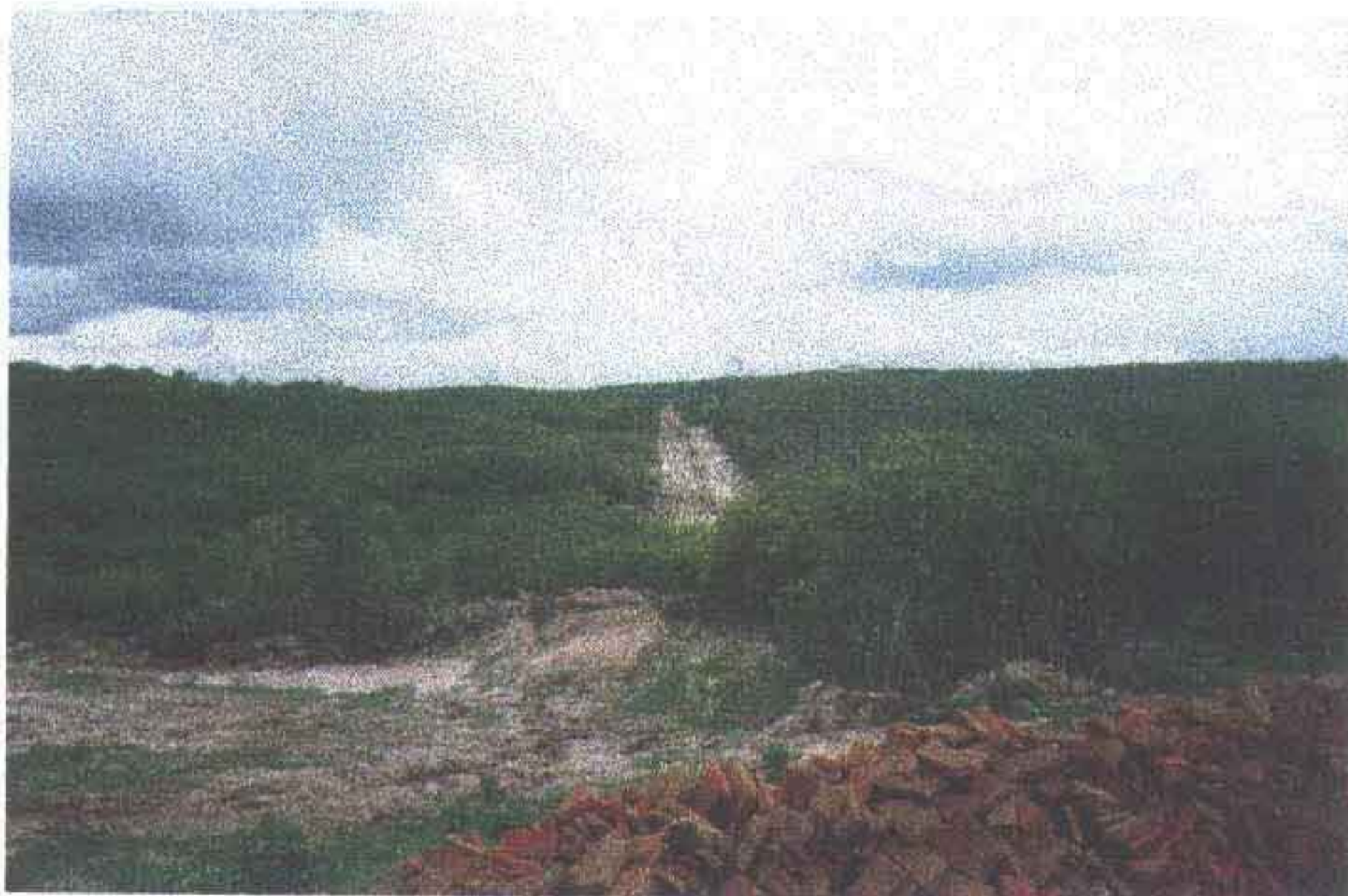
Foto 25 - Vista parcial da estrada de contorno durante o desmatamento.
