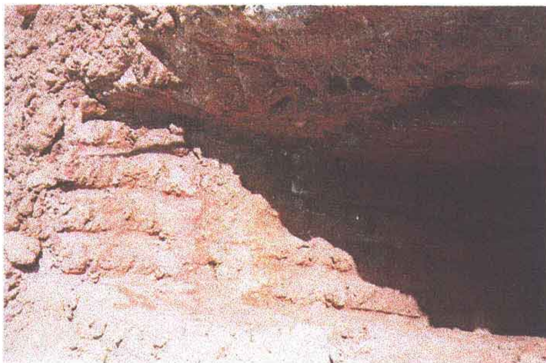
Foto 09 - Abertura de trincheira com retroescavadeira para inspeção realizada na estaca 18. Observe a homogeneidade do maciço.
