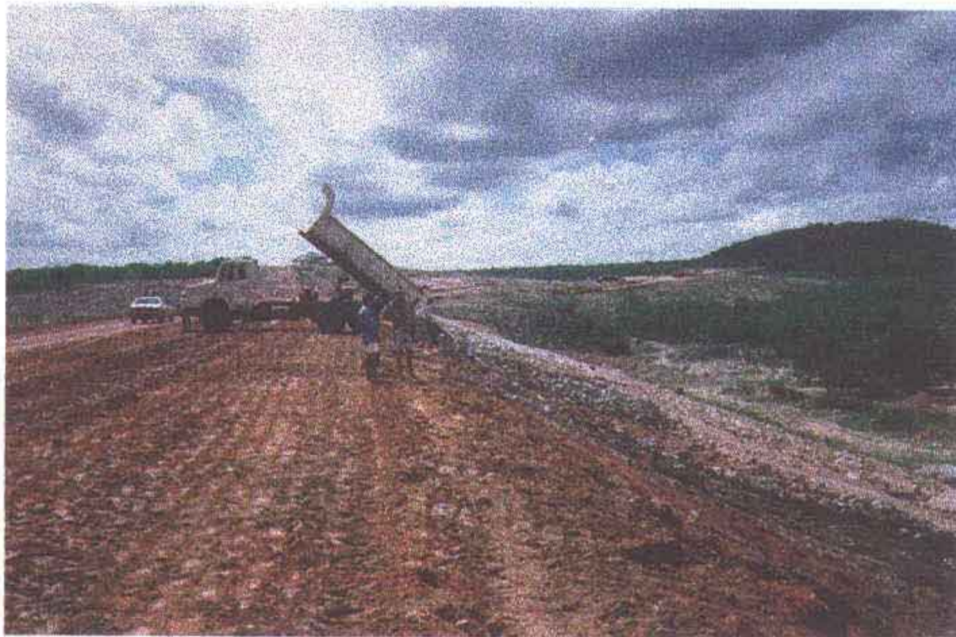
Foto 04 - Lançamento da pedra em bica-corrida a partir do coroamento.
