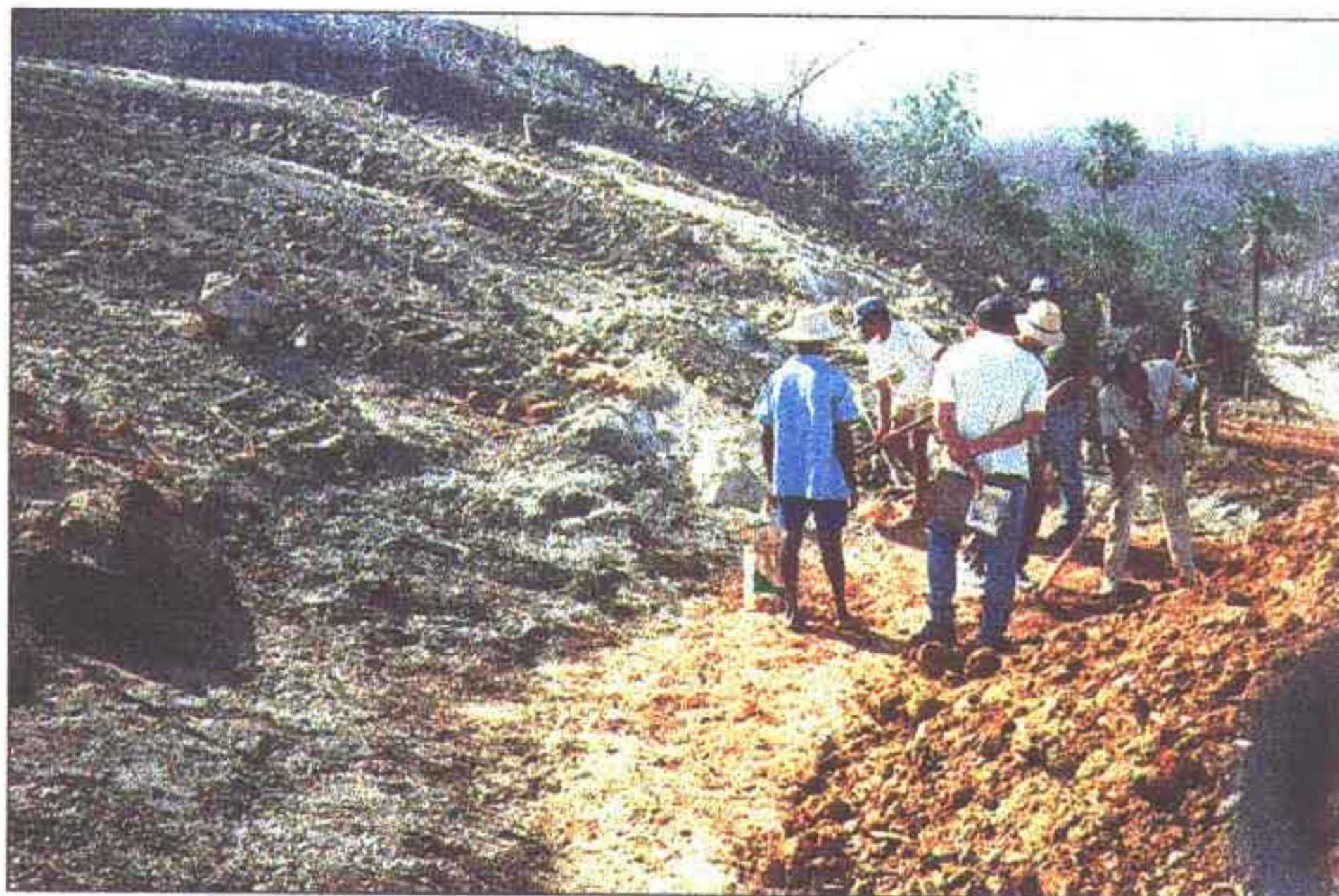
Operação manual de limpeza e regularização no encontro maciço/ombreira direita.
