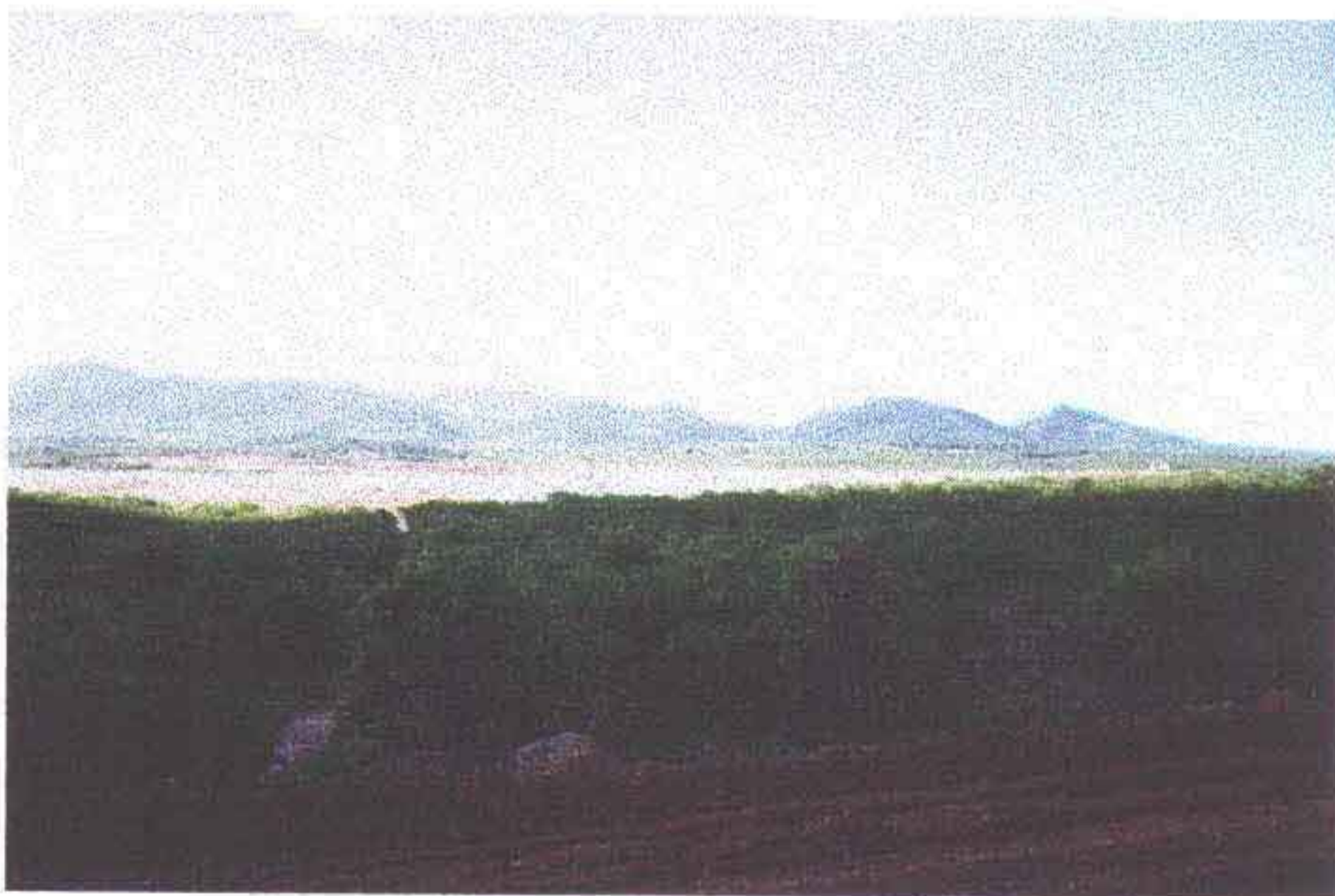
Foto 08 - Vista da barragem a partir da estrada de contorno.
