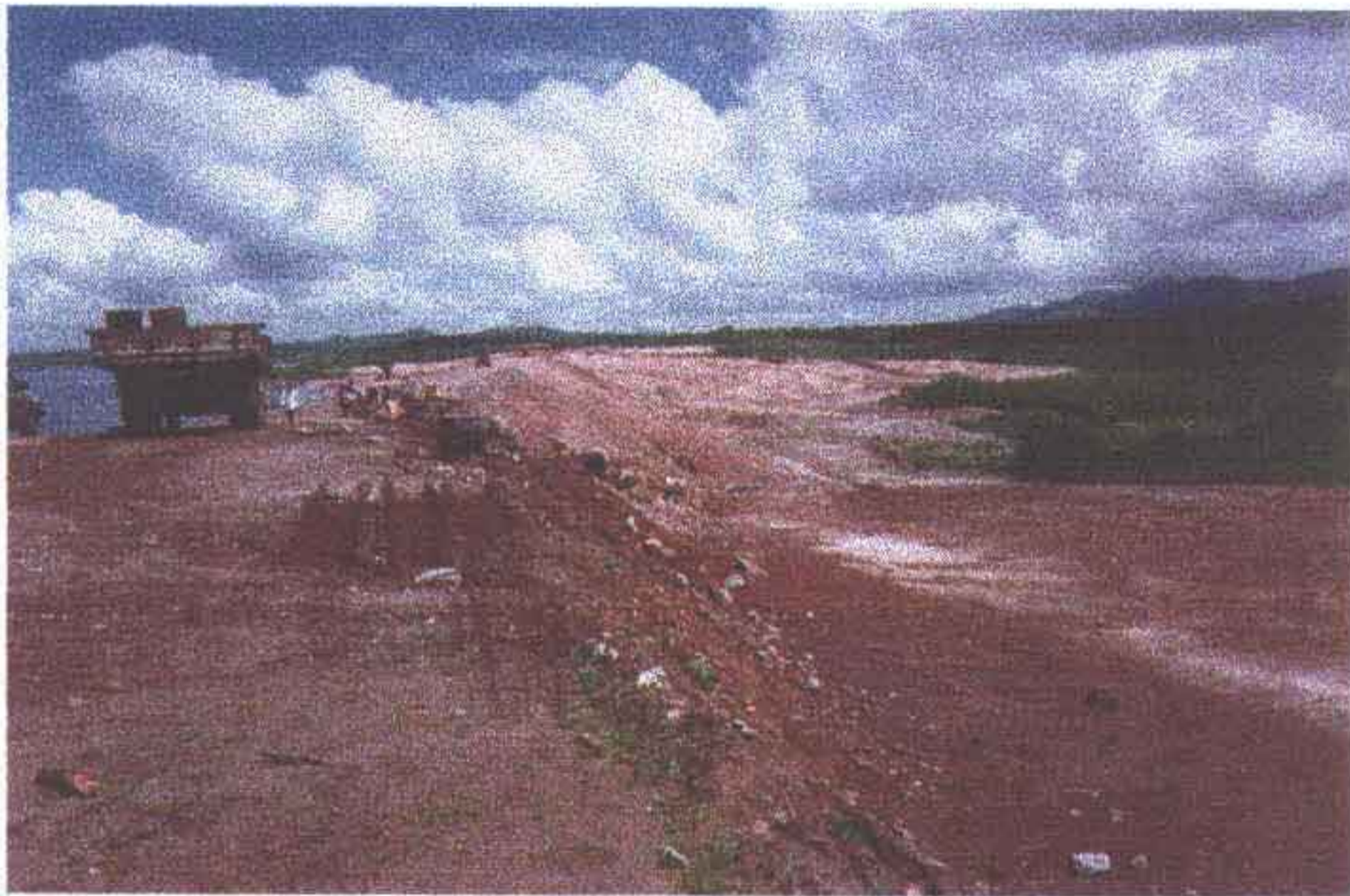
Foto 07 - Vista parcial do talude de jusante. A esquerda operários iniciando a execução de meio fio e calhas.
