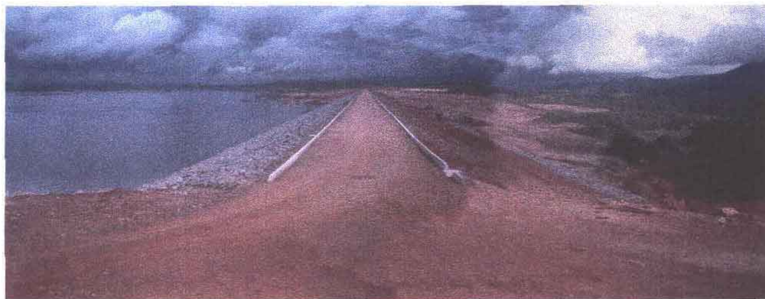
FOTO 4 - Vista do maciço a partir da ombreira direita
