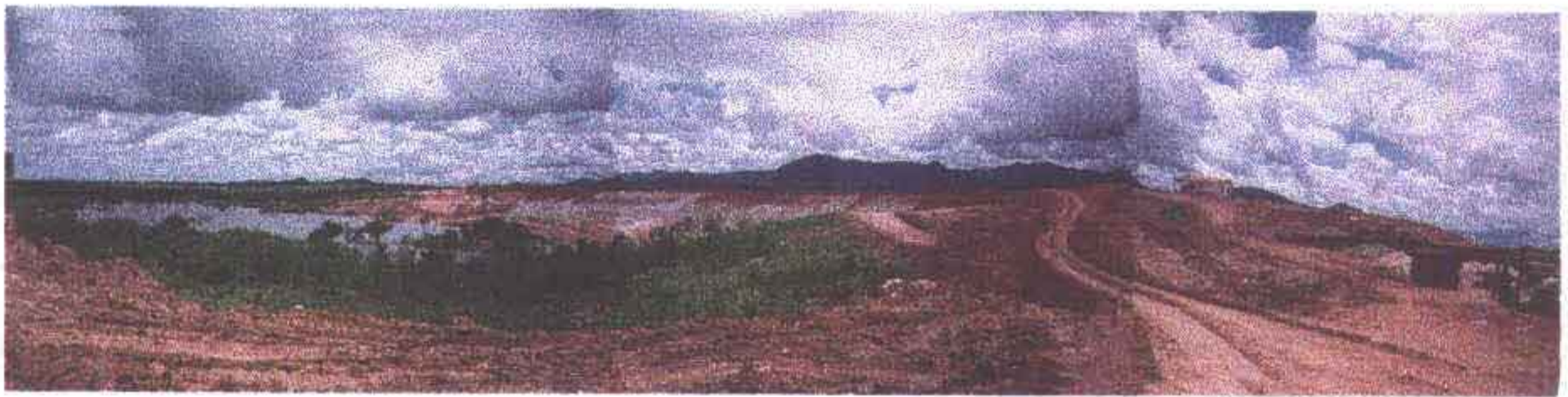
Foto 03 - Vista do talude de montante, a partir do local do sangradouro.
