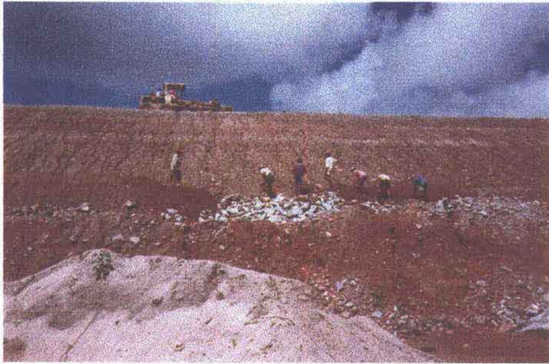
Foto 06 - Operação manual com poucos homens na regularização de taludes.
