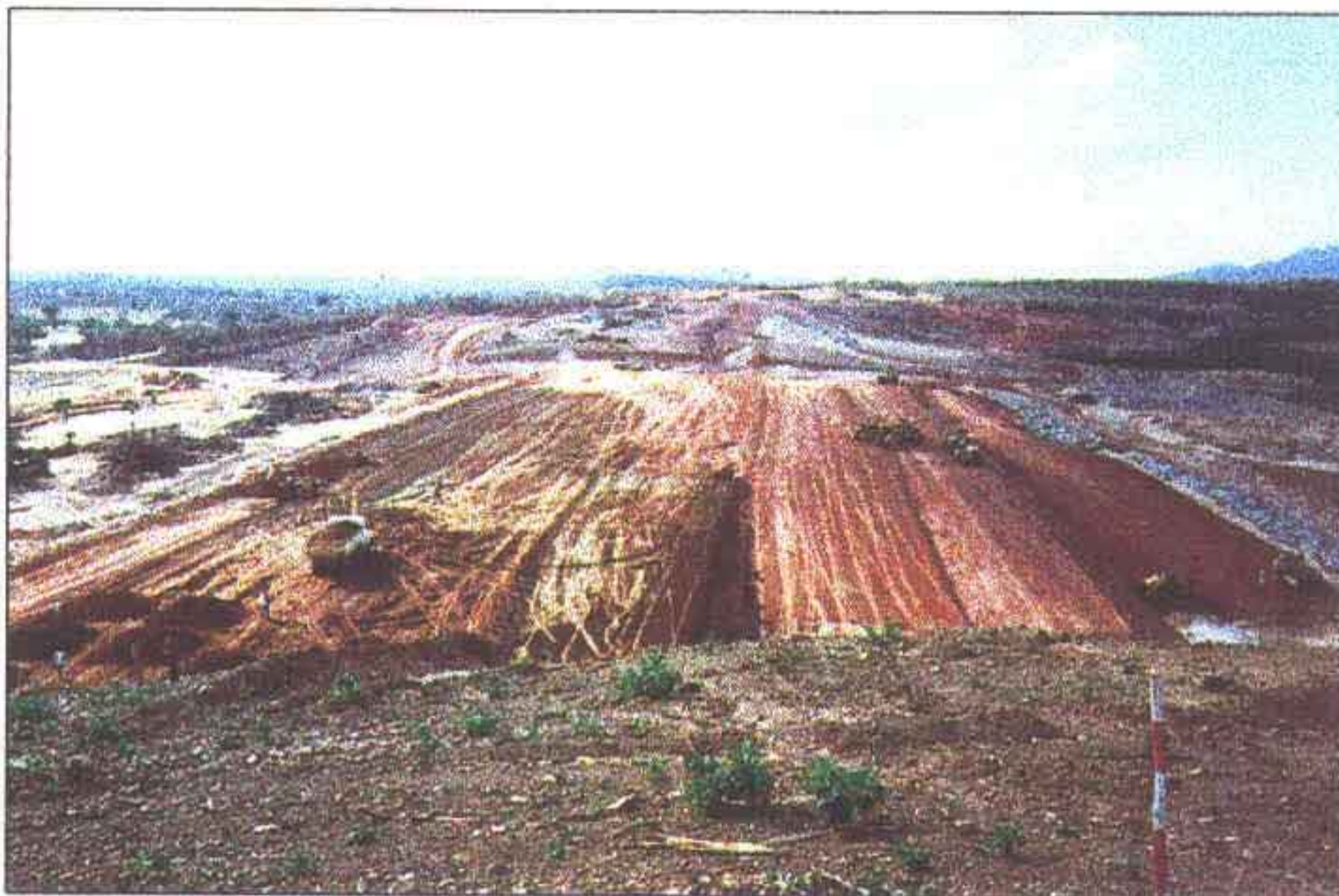
Vista da praça de compactação no início do mês de janeiro.
