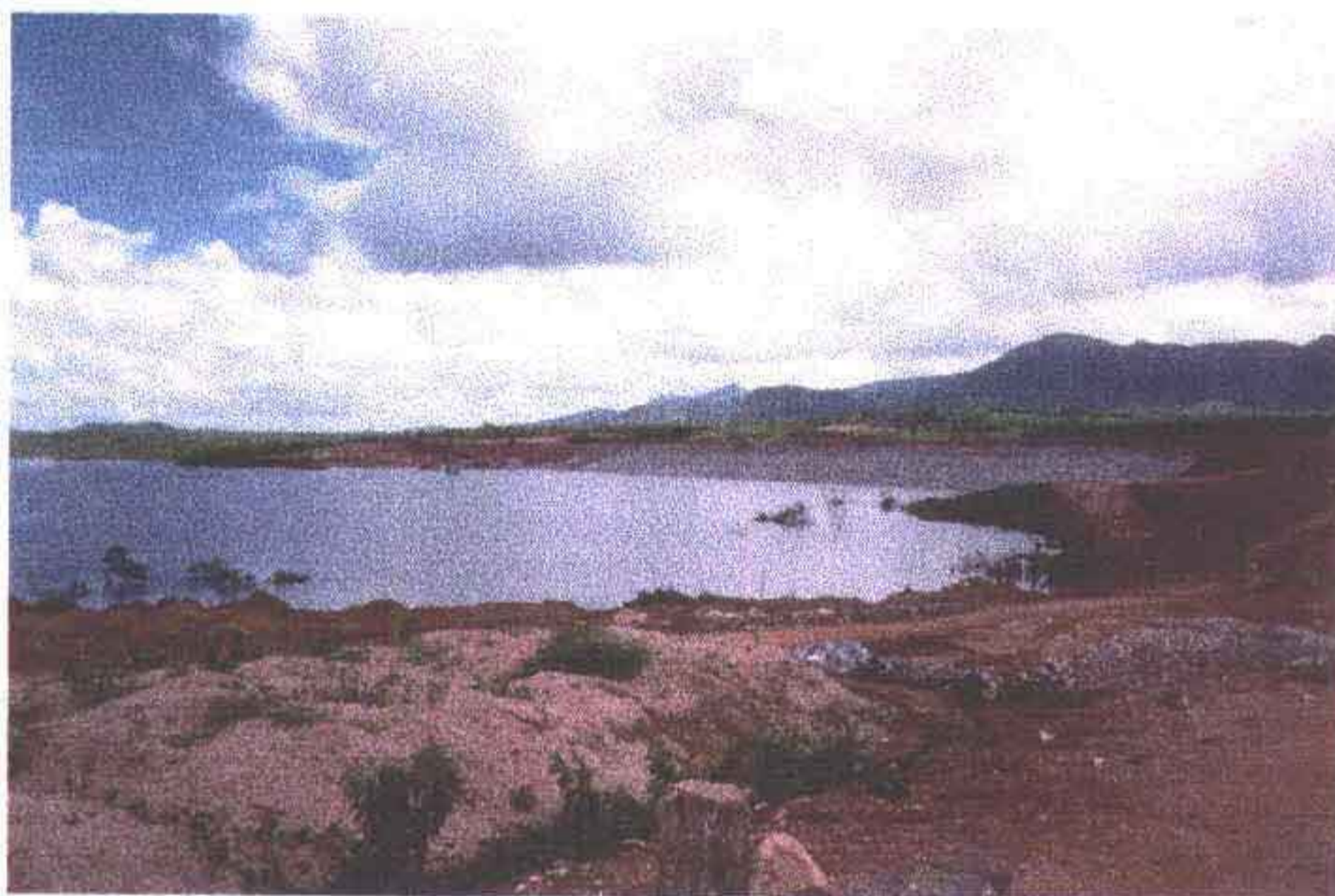
Foto 02 - Talude a montante, observe o nível d'água e a execução do enrocamento.
