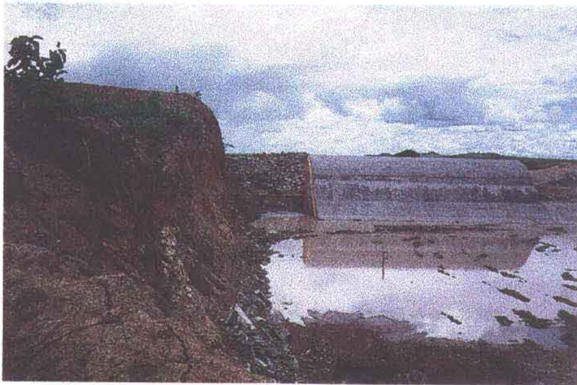
Foto 15 - Local onde deverá ser concretado o muro lateral direito, que liga o maciço da barragem auxiliar com o Creager.
