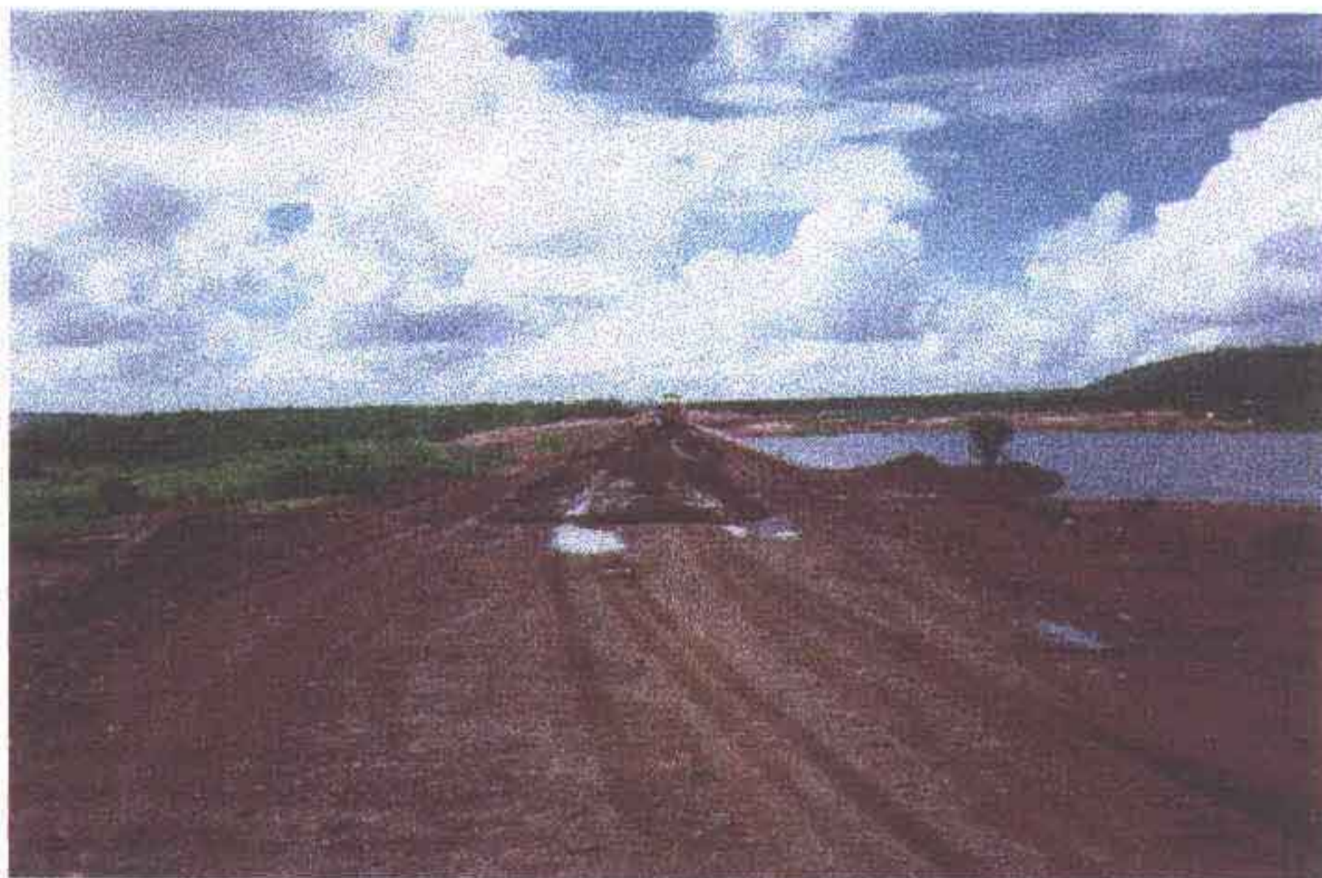
Foto 05 - Vista do coroamento tomada a partir da ombreira esquerda.
