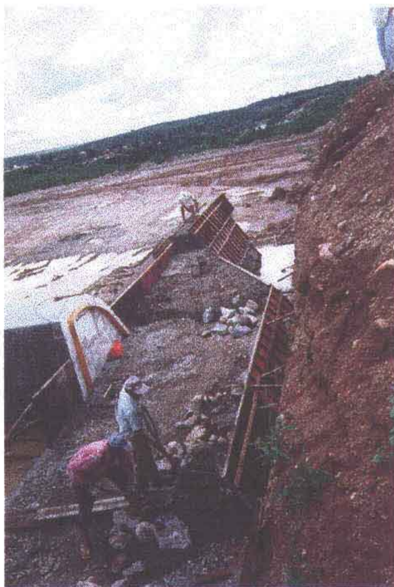
Foto 21 - Concretagem do muro, ver a junta fungebond no Creager.
