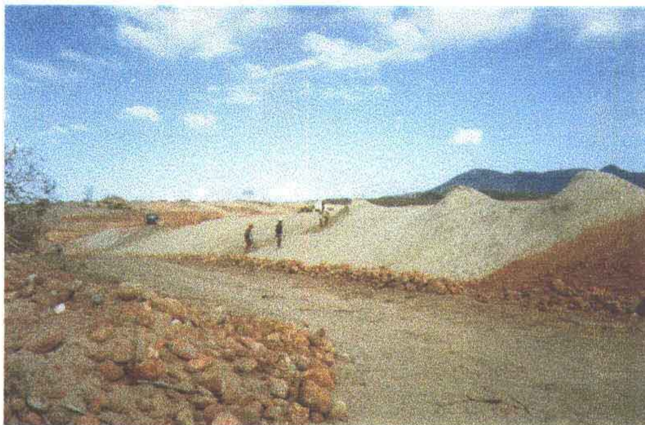
Foto 9 - Rip-rap. Espalhamento da camada de areia. Região compreendida entre estacas 12 e 18.
