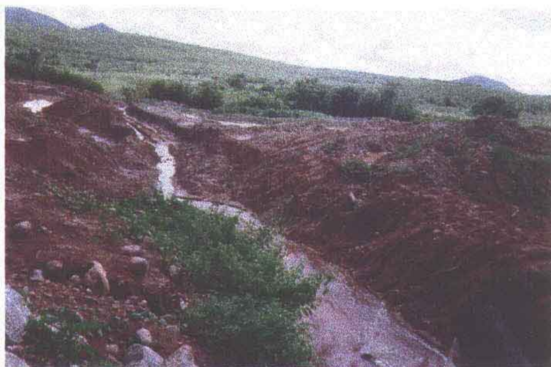
Foto 11 - Canal de fuga a jusante da tomada d'água.
