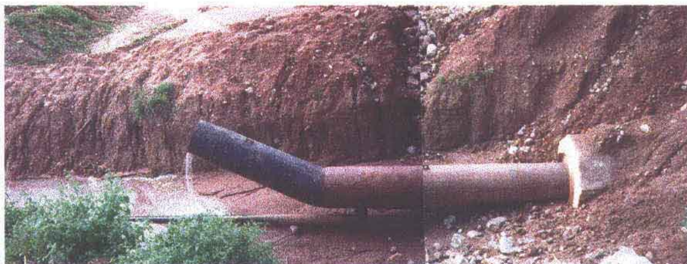
Foto 10 - Vista lateral da extremidade de jusante da tomada d'água, onde será implantada uma válvula dispersora.
