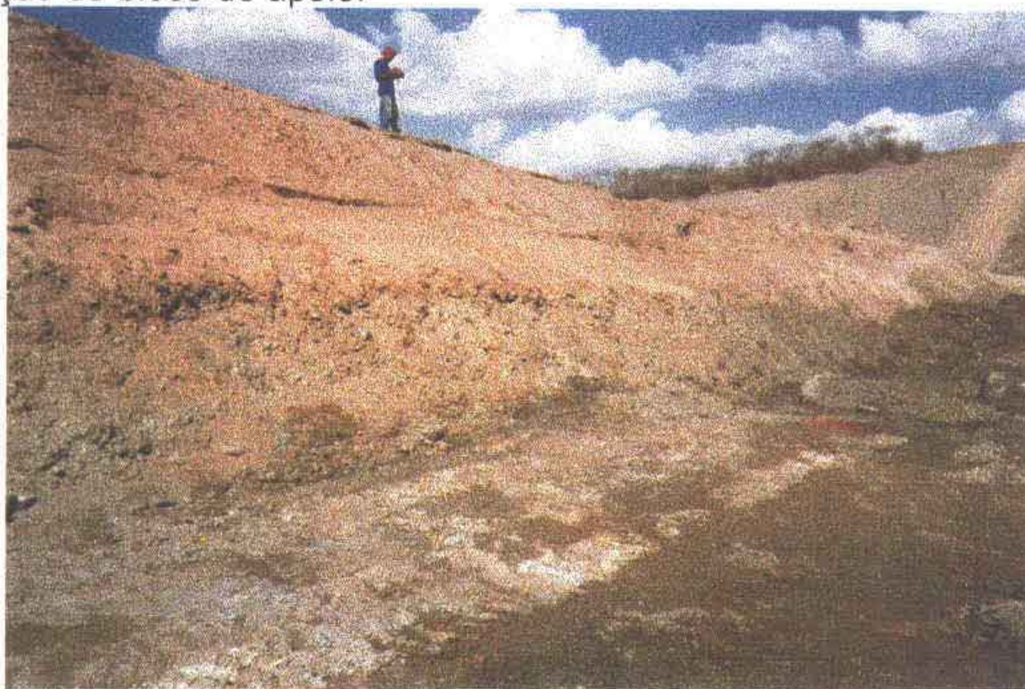
Foto 4 - Escavação do cut-off entre estacas 17 e 18. Espessa camada eixo rolado e observada. O projeto prevê a cobertura da camada de seixo com filtro. Na parte inferior da foto pode ser observado a rocha já aflorando, Resta a limpeza fina para ser liberada o cut-off para enchimento.
