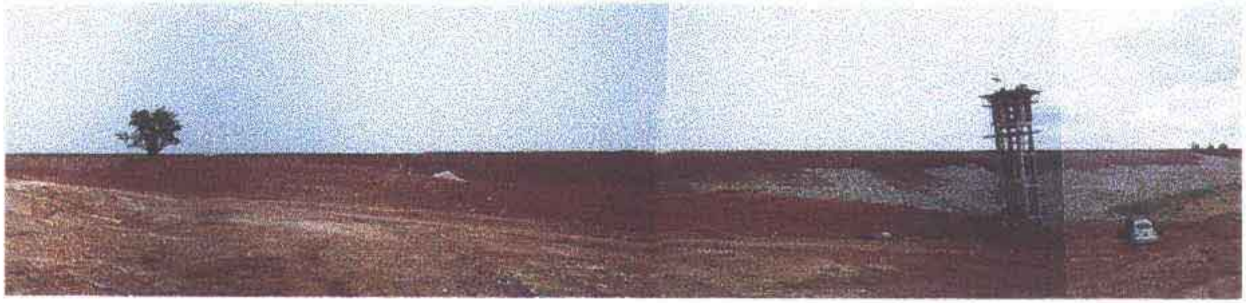
Foto 01 - Vista frontal do maciço, tomada a partir de montante da ombreira esquerda .
