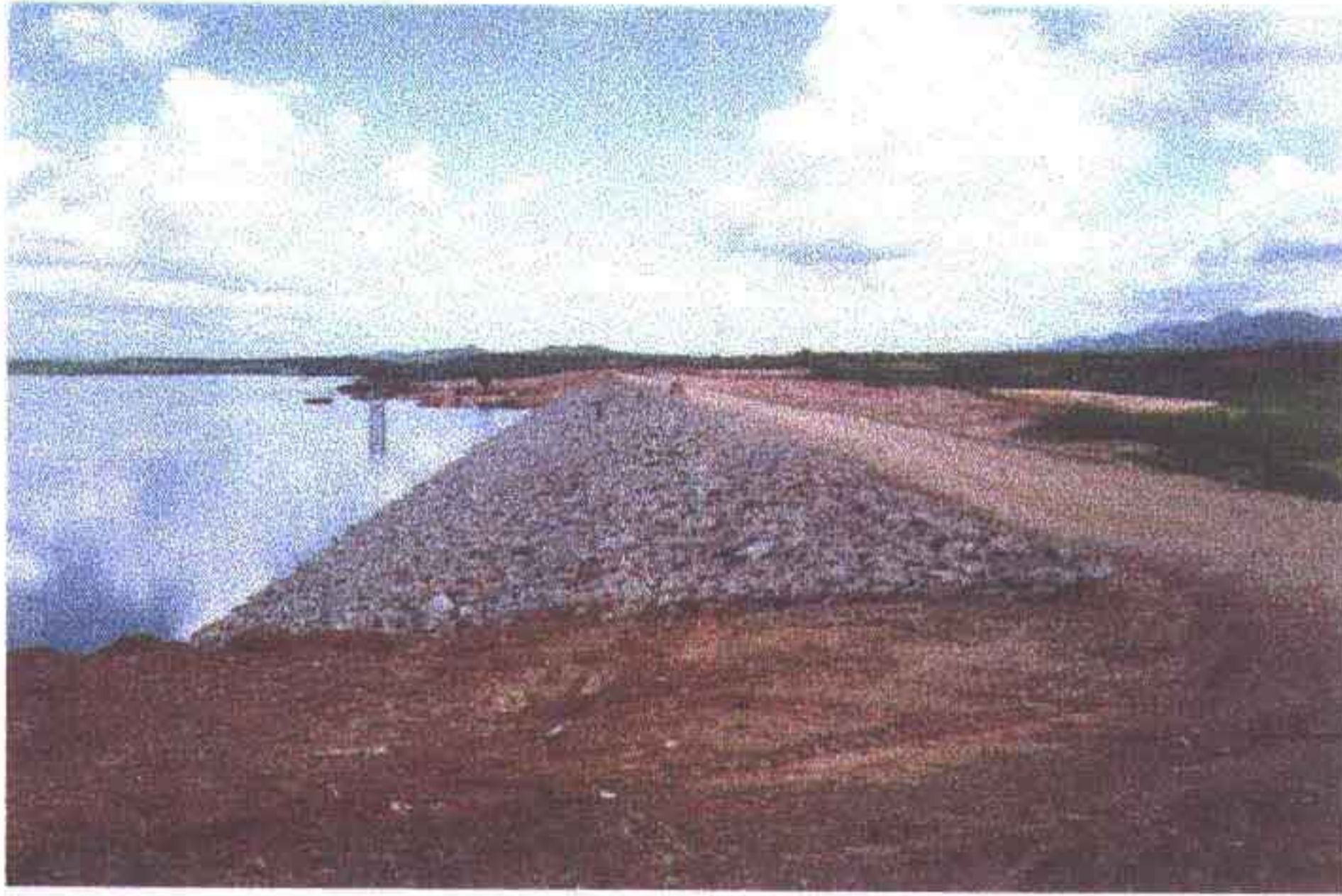
Foto 01 - Vista do talude de montante, observe o avanço do enrocamento parcialmente concluído.
