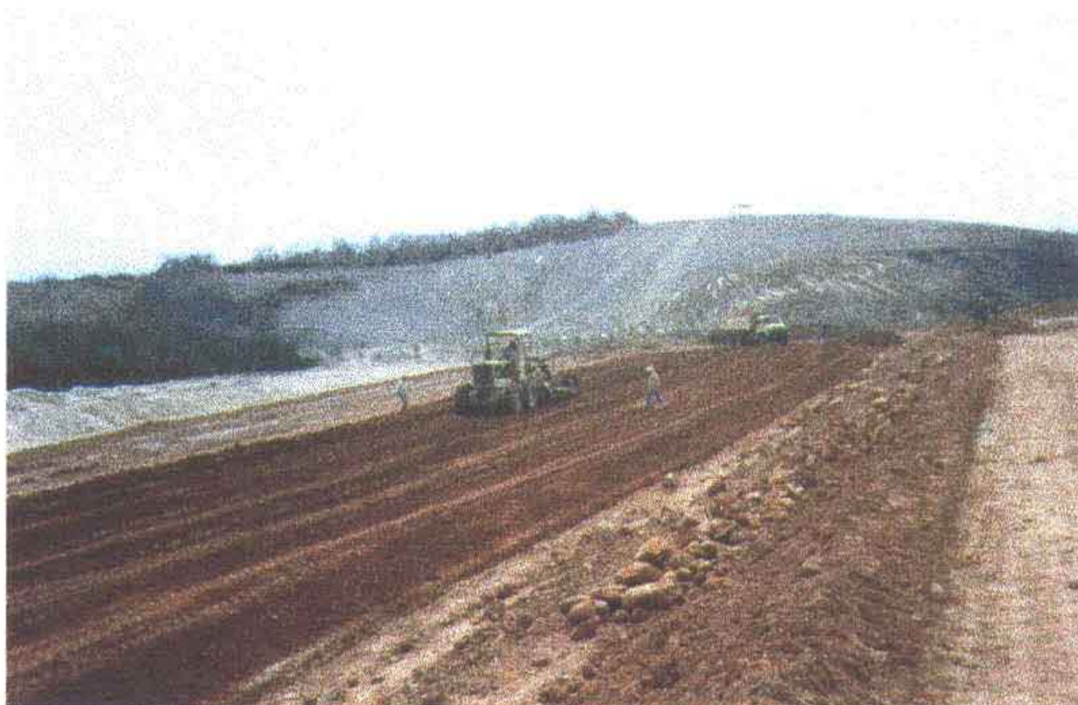
Foto 7 - Lançamento e espalhamento do material entre estacas 17 e 19.
