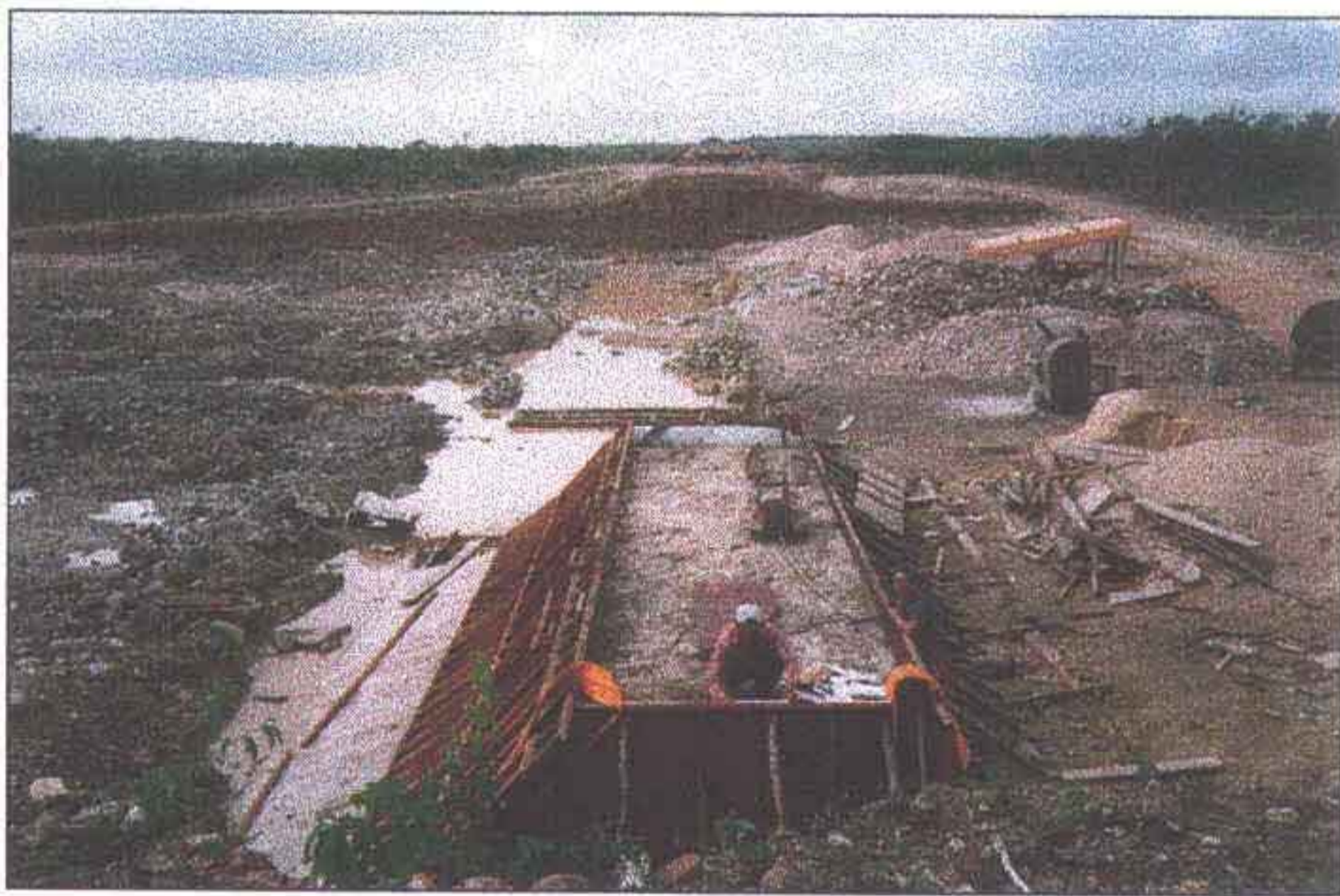
Concretagem do primeiro bloco do creager no lado esquerdo do sangradouro.
