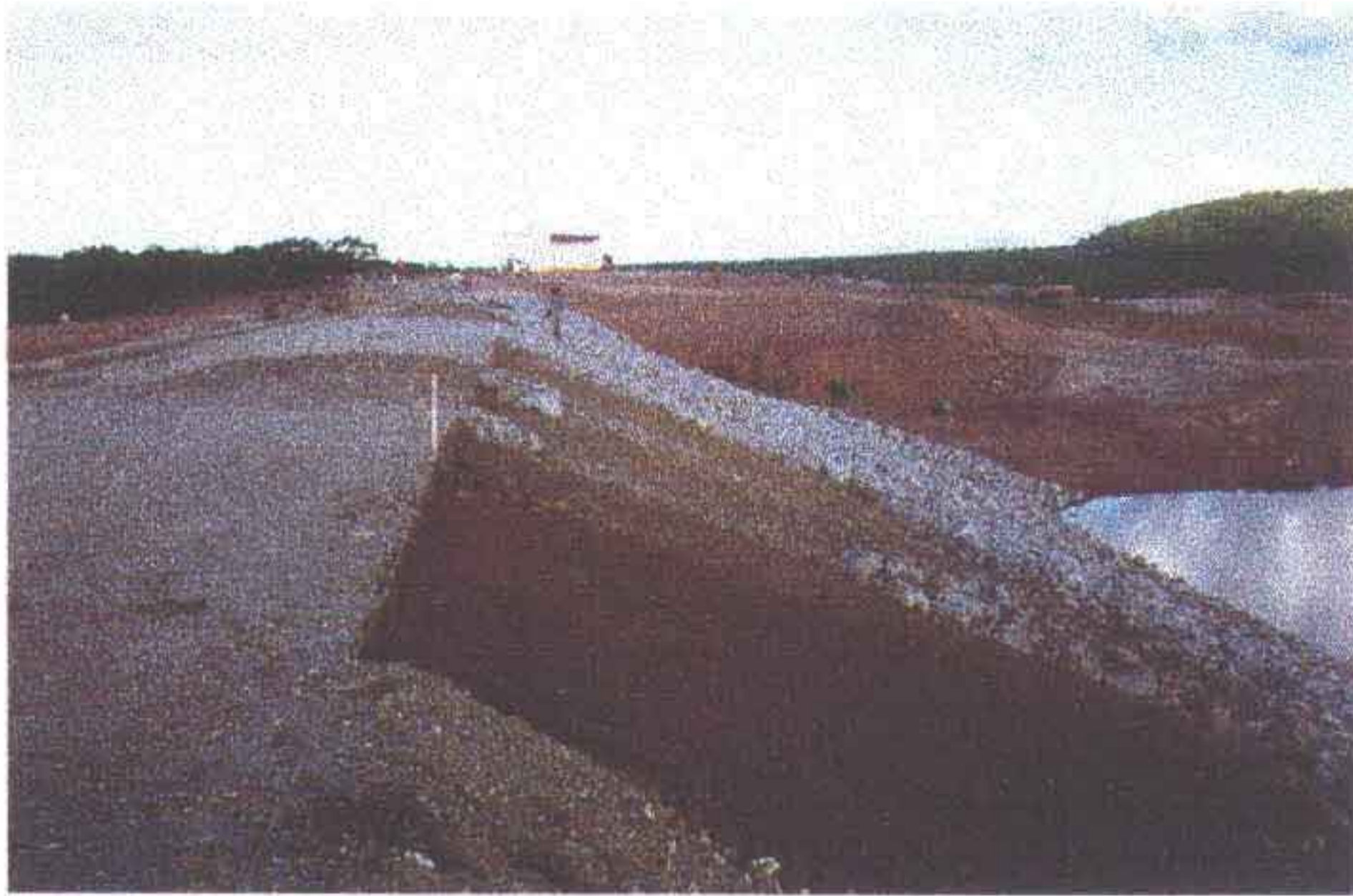
Foto 03 - Marcação de "off-set" para escavação no maciço para encontro do enrocamento com o coroamento.
