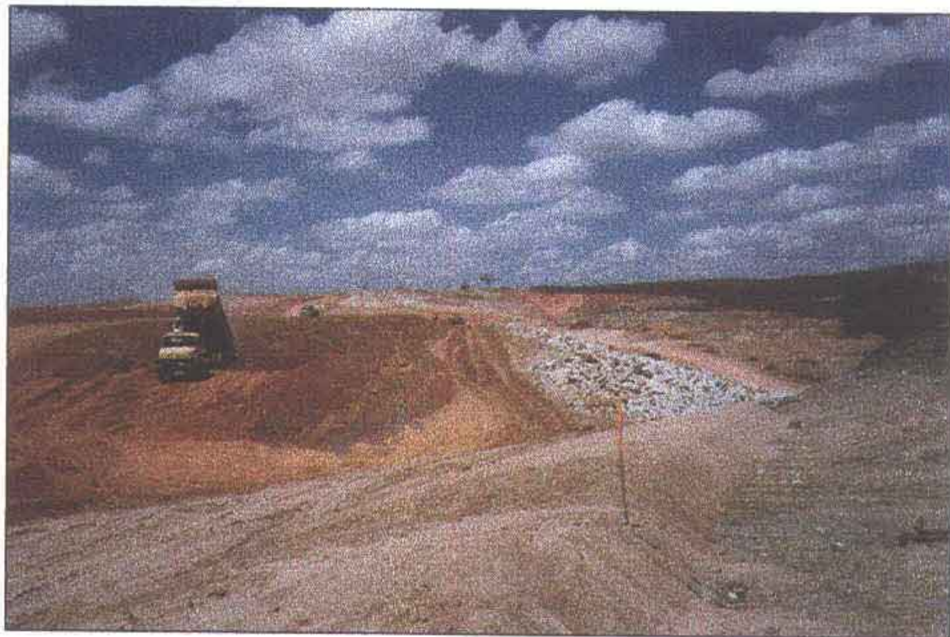
Trecho entre estaca 19 e 21. Lançamento de terra sobre o tapete filtrante horizontal. Na parte inferior observe-se porção de tapete horizontal.
