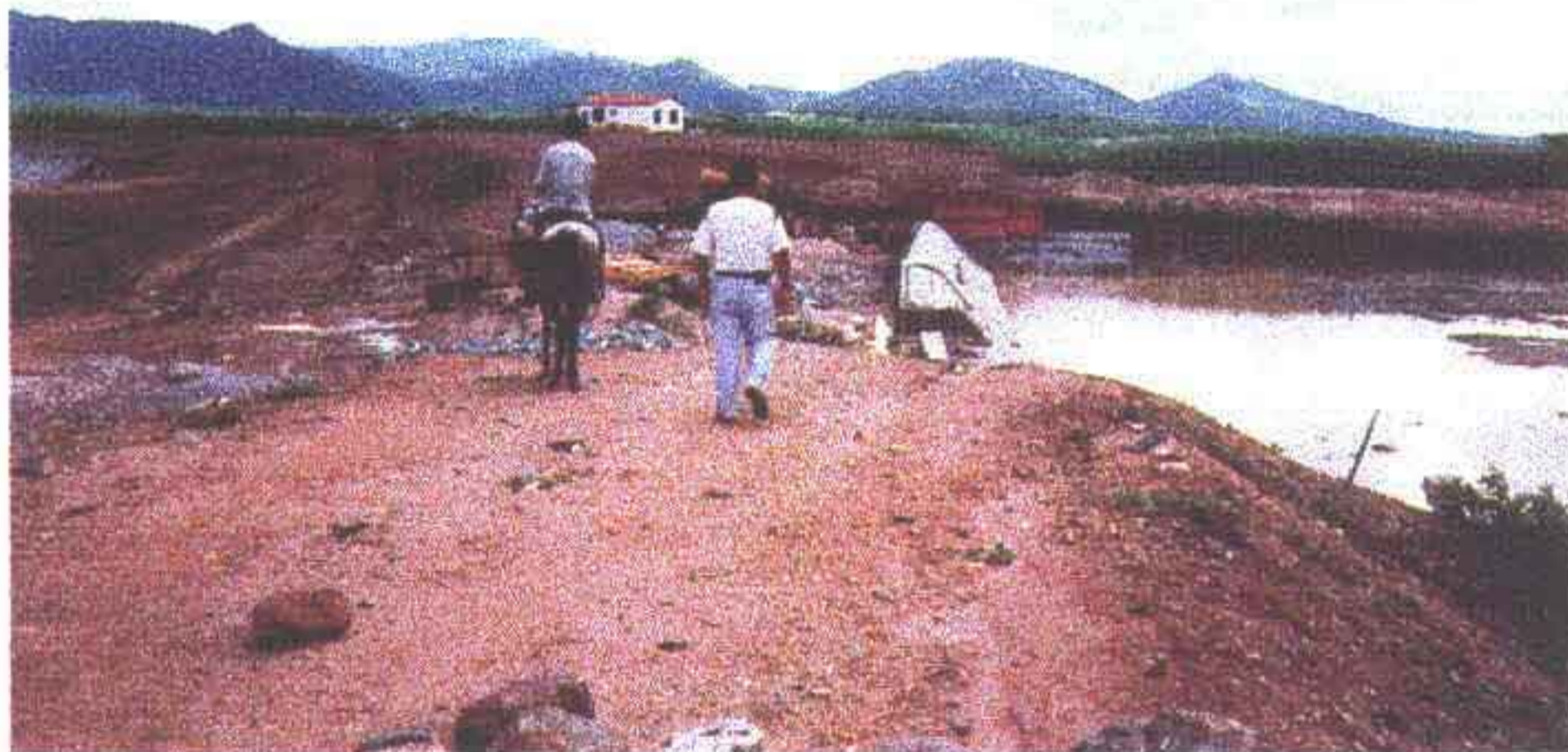
Foto 18 - Verifique o canal de aproximação do sangradouro.
