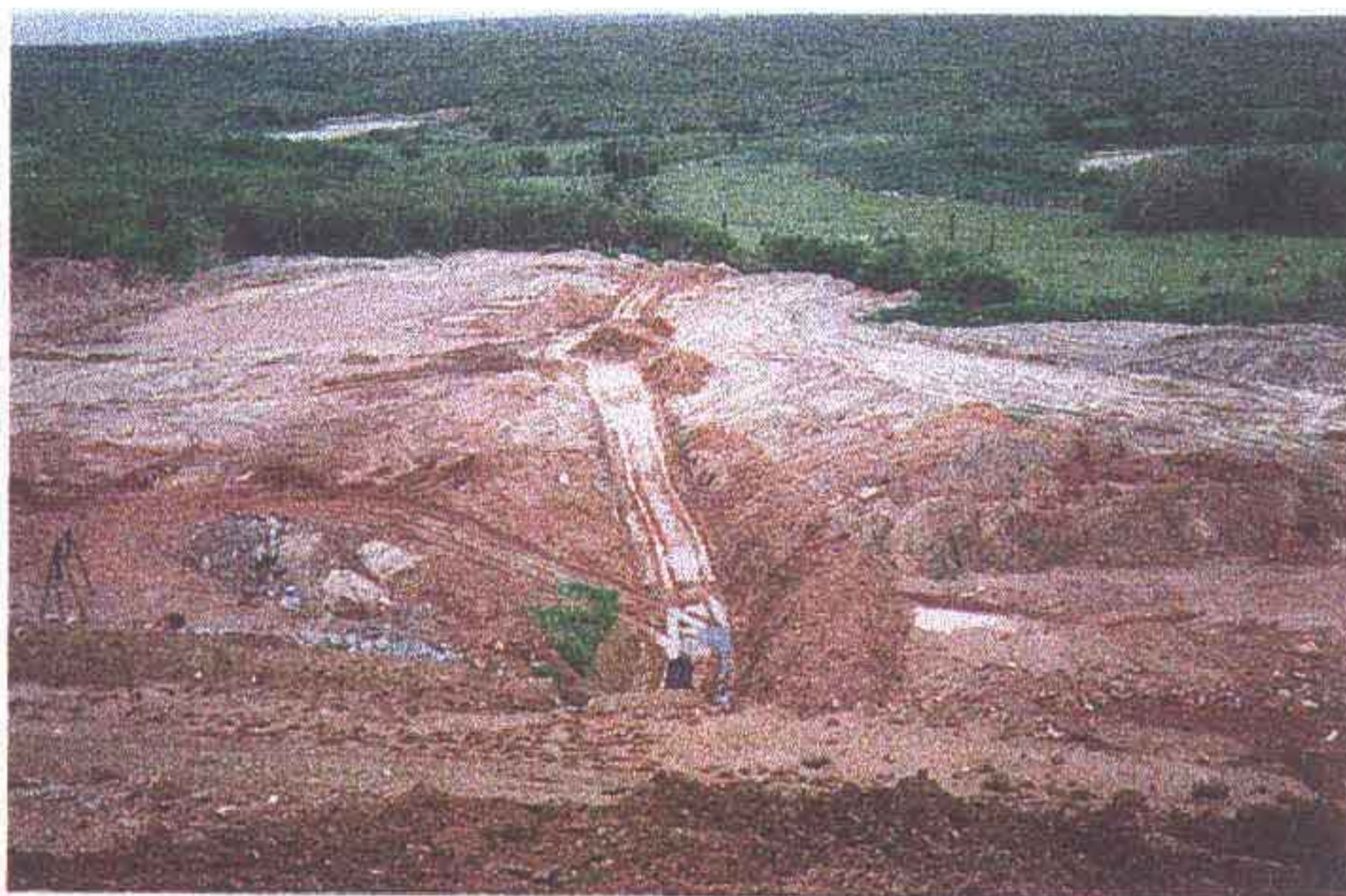
Foto 12 - Vista da boca de saída da tubulação da galeria, tomada a partir do coroamento.
