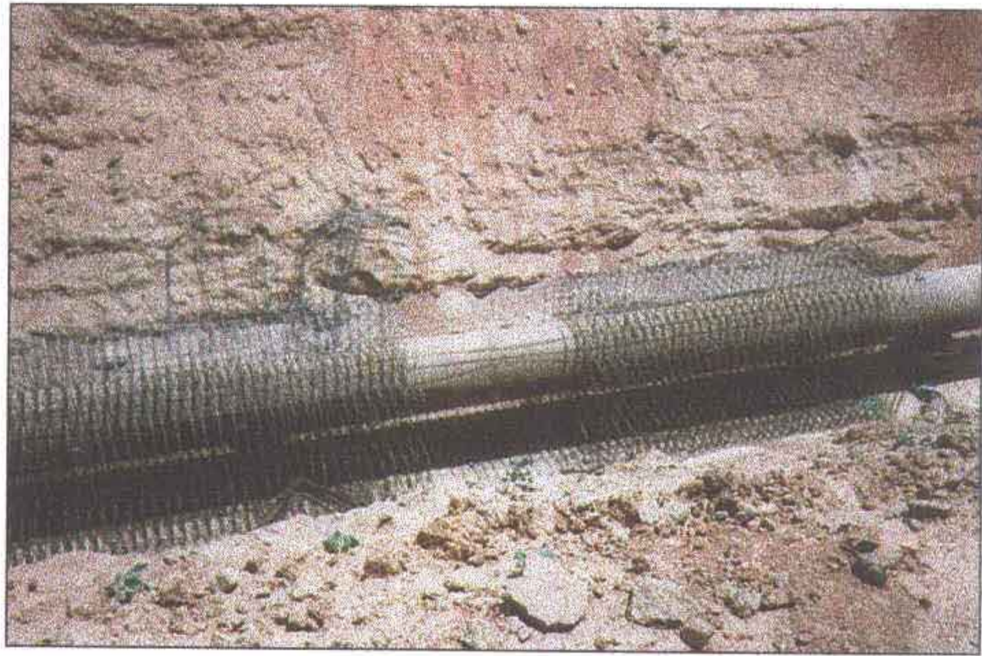
Ferragem de uma seção da galeria em fase de execução. Observe-se a uniformidade do afastamento dos ferros.
