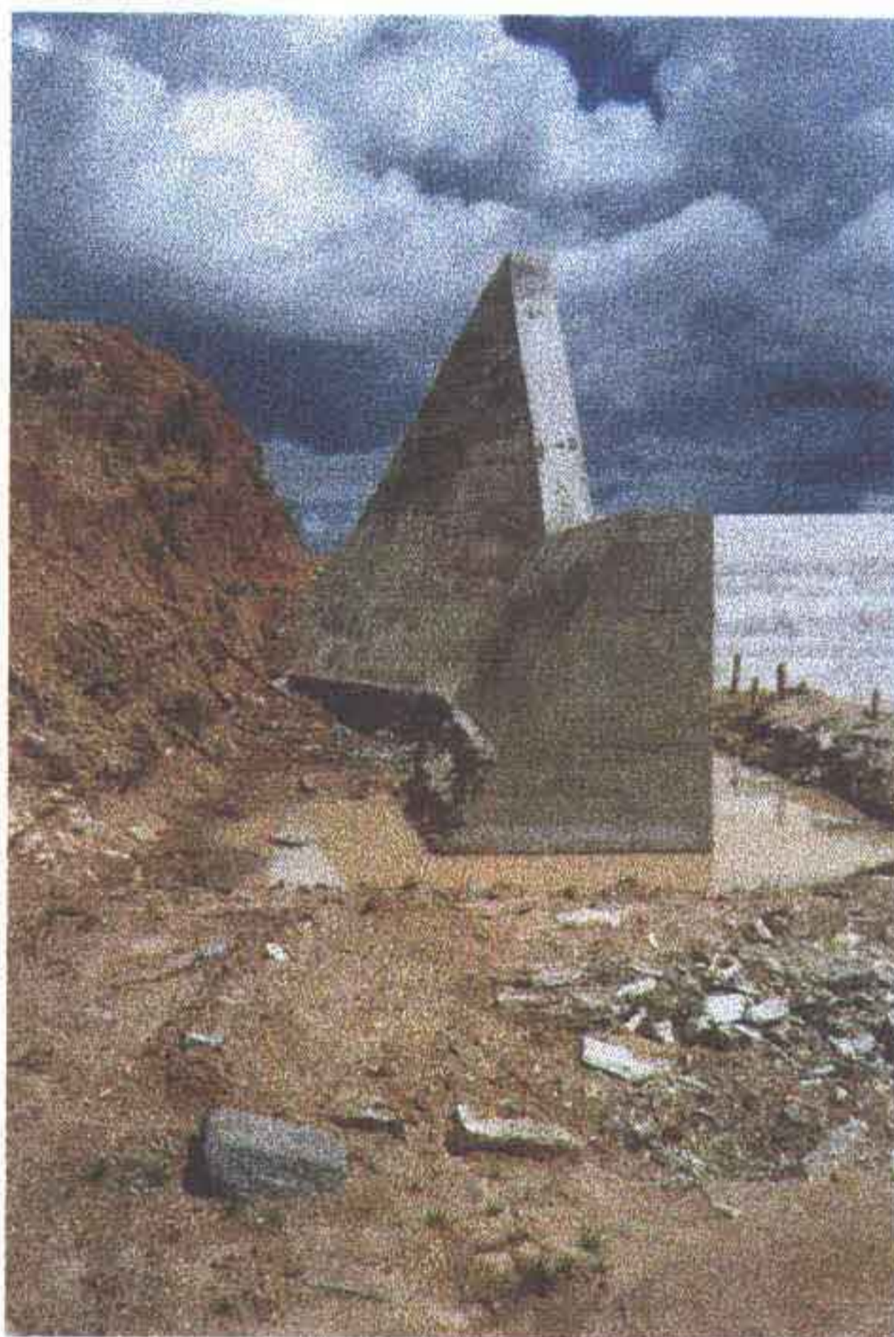
Foto 12 - Muro lateral da margem direita
