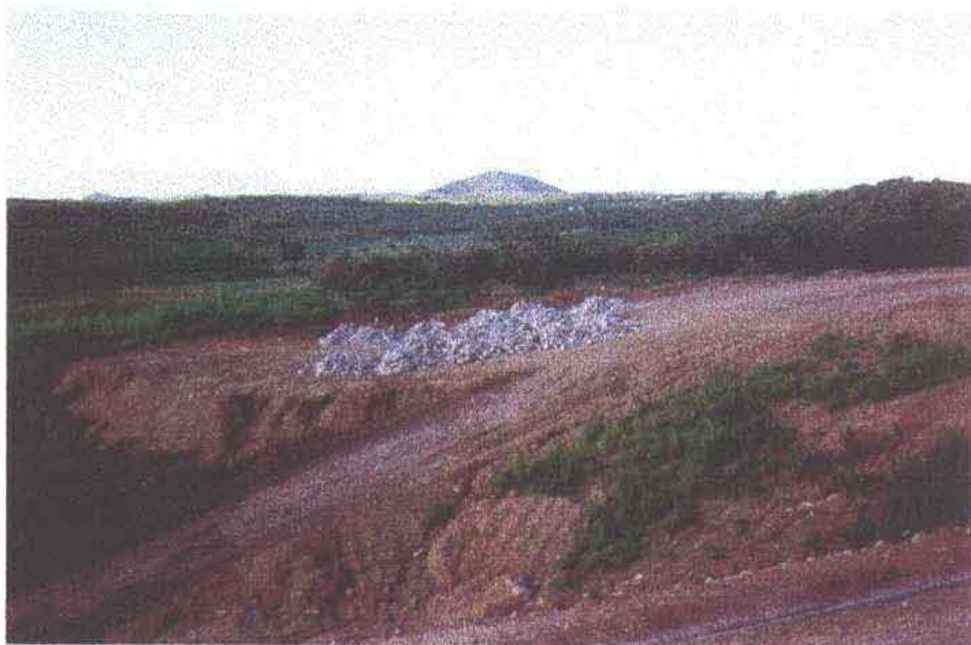
Foto 05 - Estoque de rocha para acabamento de "rock-fill" e "rip-rap".
