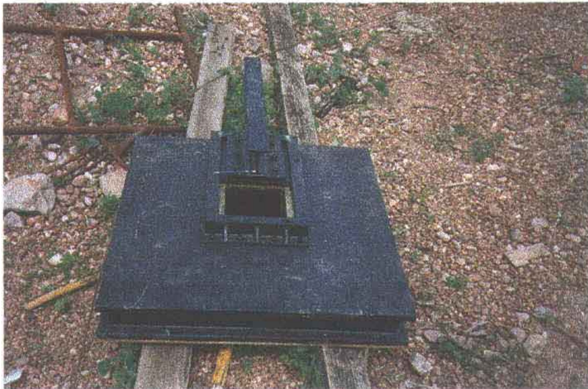
Foto 13 - Comporta da tomada d'água.
