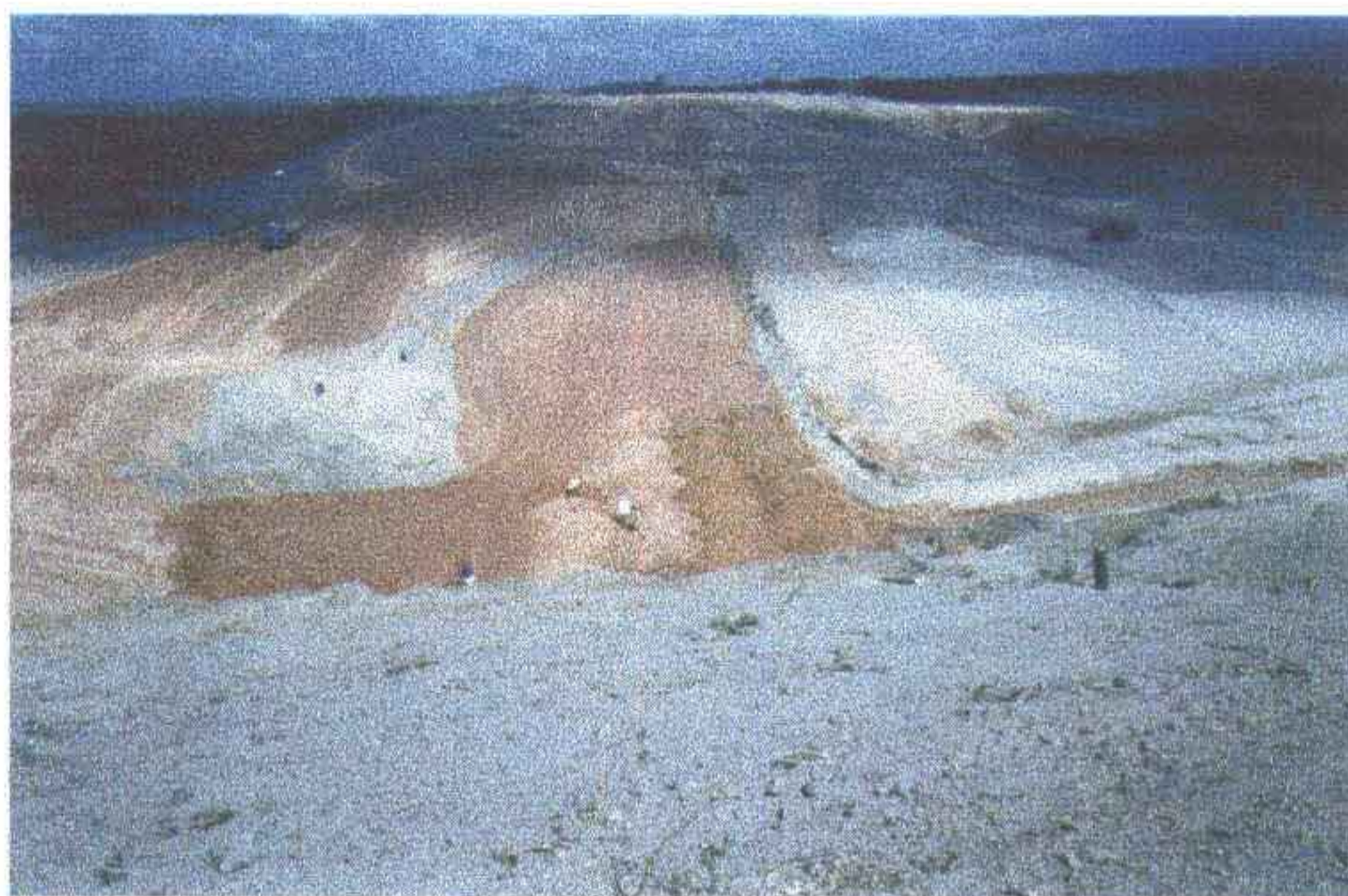
Foto 5 - Vista geral da obra, dando-se ênfase ao material lançado entre estacas 19 e 20.
