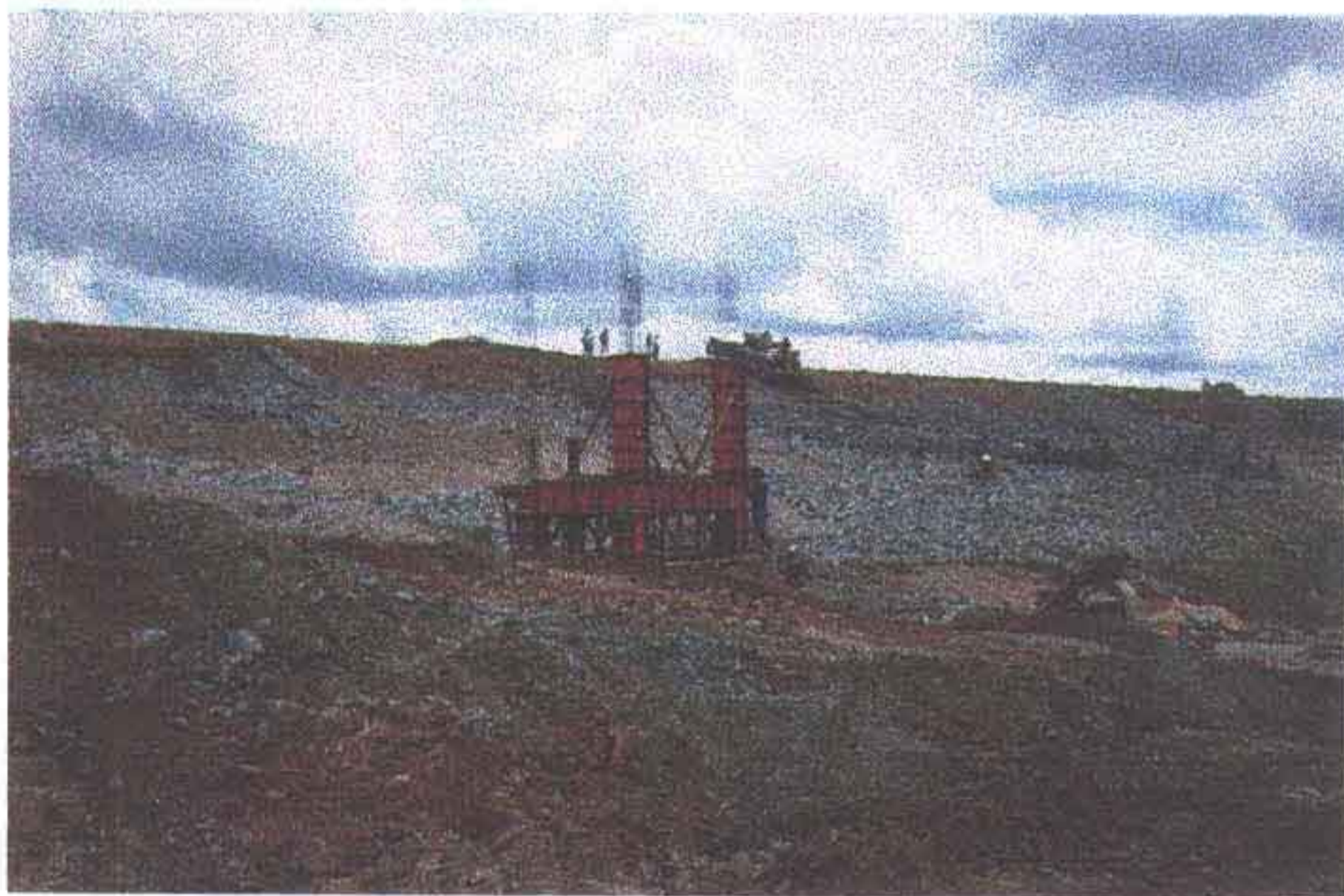
Foto 06 - Operação de espalhamento de bica-corrída com trator e acabamento braçal.
